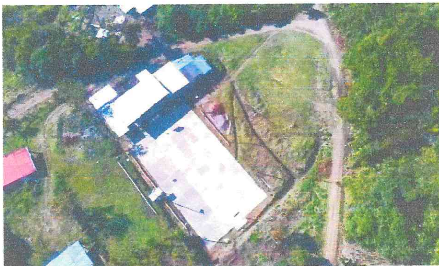
Vista de acceso al predio - Placa existente
