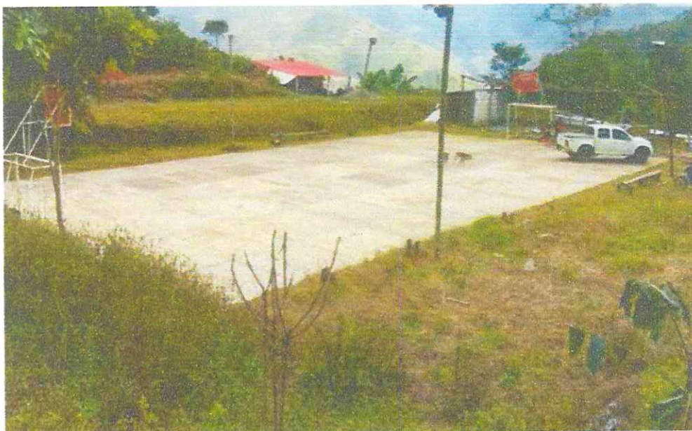
Localización específica del proyecto - Placa existente en concreto
