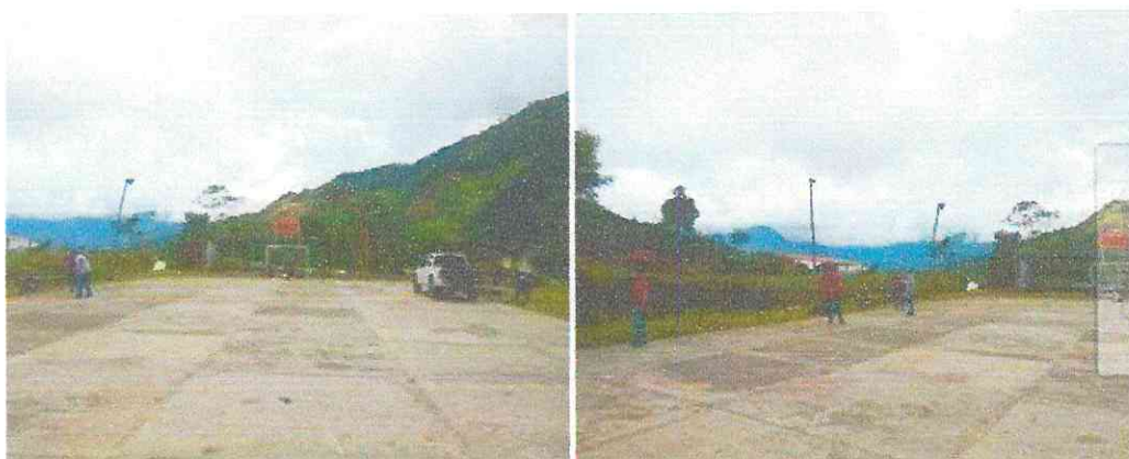
Condiciones físicas Placa existente en concreto
