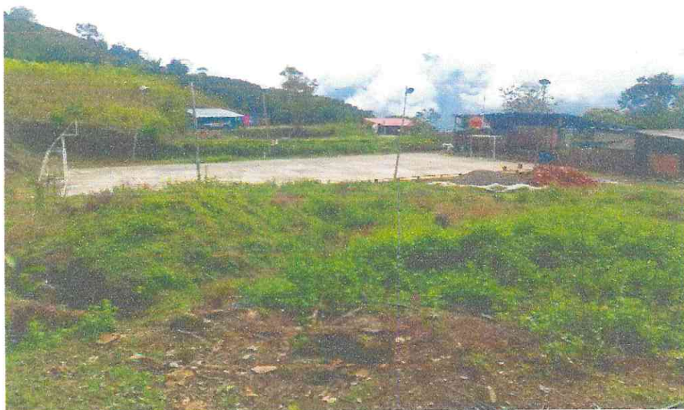
Vista general de la placa existente en concreto
