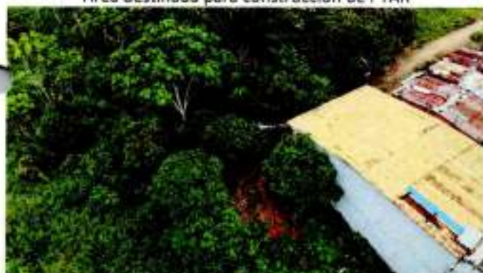
Área destinada para construcción de PTAR
