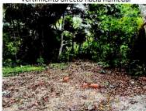
Lote para construcción de PTAR
