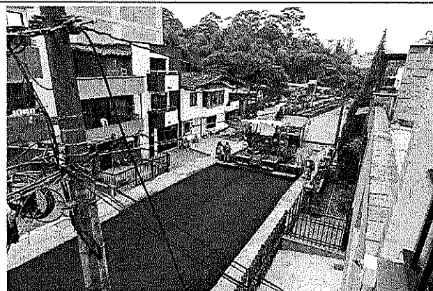
DESCRIPCIÓN. Disposición de mezcla asfáltica en caliente.
