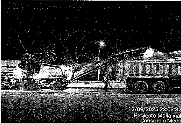
DESCRIPCIÓN. Fresado de pavimento preexistente.
