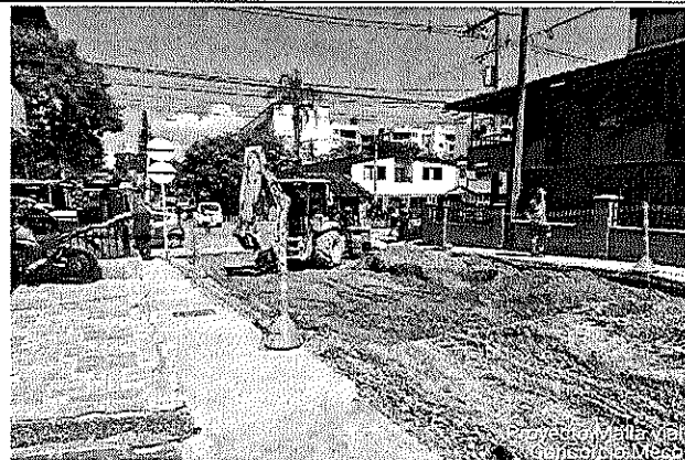
DESCRIPCIÓN. Conformación de base como sustrato de apoyo.
