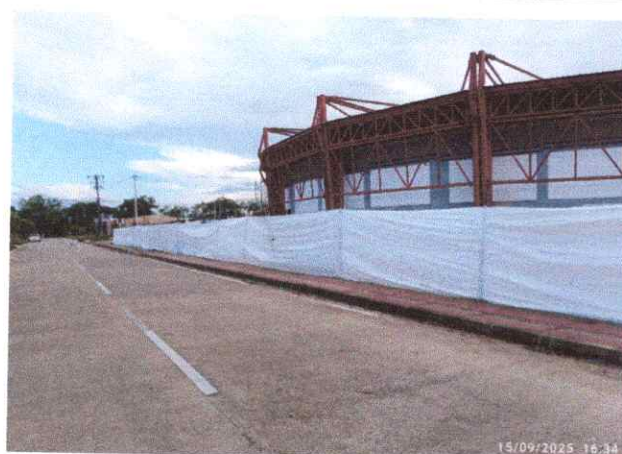
Imagen 6. Vista adecuación cerramiento provisional
