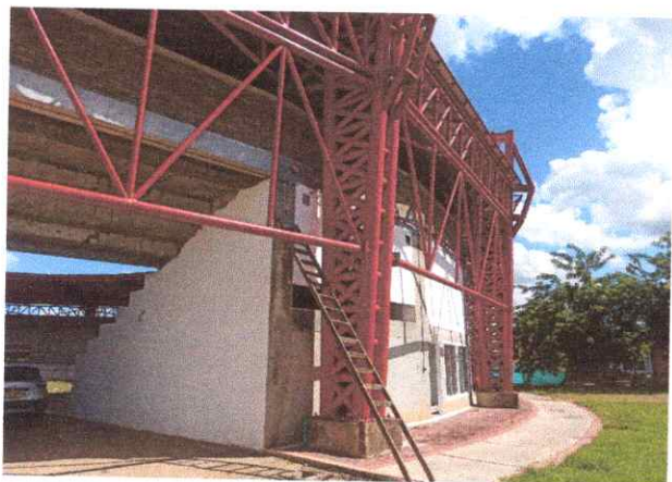
Imagen 5. Vista de Fachada y área acceso a escenario.
