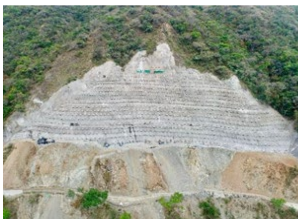
Foto 3-21 Cielo abierto 13 Calvario se realiza actividades de estabilización del talud
