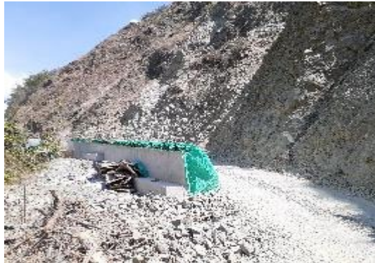
Foto 3-23 Muro 15 frente inactivo
