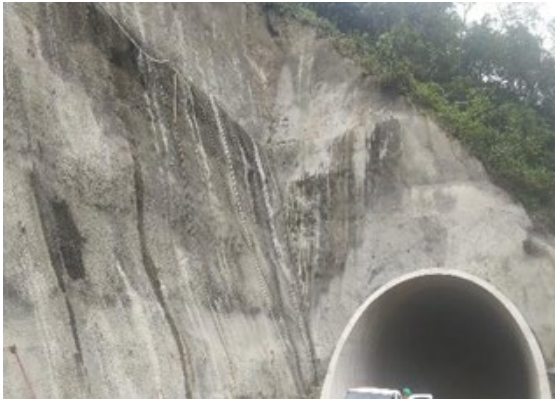
Foto 3-5353 Túnel 7 PS. Perforación e instalación de drenes de 15 metros.
