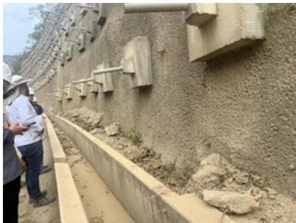
Foto 3-25 Canal Longitudinal en concreto frente inactivo
