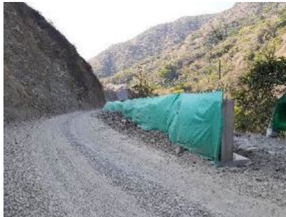
Foto 3-24 muro 15 frente inactivo
