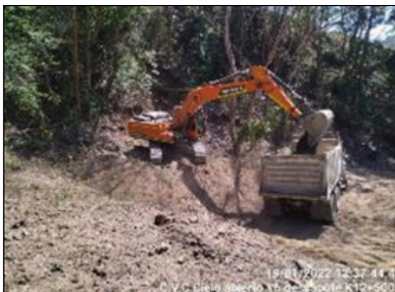
Foto 3-1 K12+356 -K13+664, estado inicial
