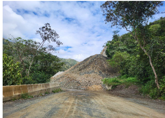
Foto 3-18 Cielo abierto 12, frente inactivo a rasante de vía
