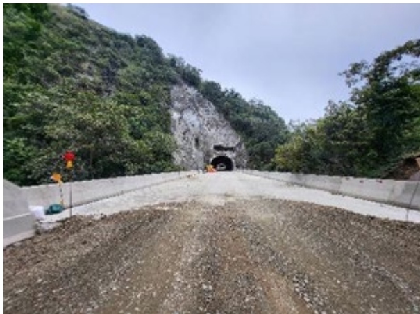
Foto 3-3738 Puente 2 ya se terminó al servicio de la obra
