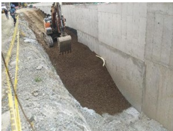
Foto 3-16 Muro 12 se inicia el lleno estructural y de terraplen con material de sitio, se realiza la instalación de geodren planar e instalación de geotextiles.
