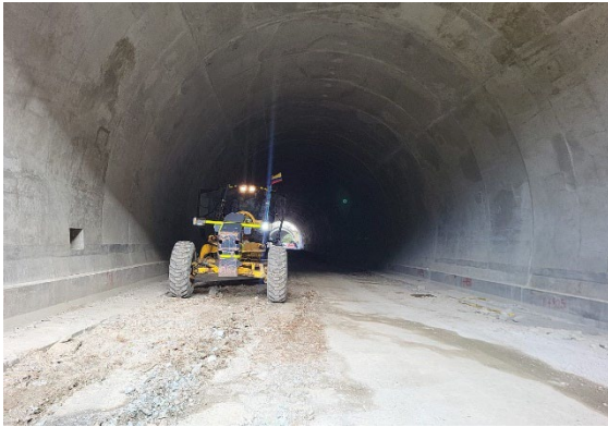
Foto 3-4546 Túnel 5. frente inactivo.
