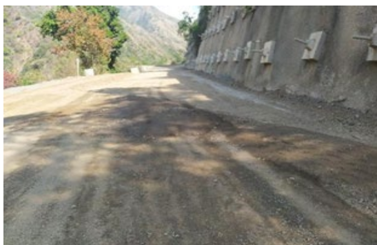
Foto 3-30 Túnel falso 3, frente inactivo este se encuentra a nivel de subrasante de la vía
