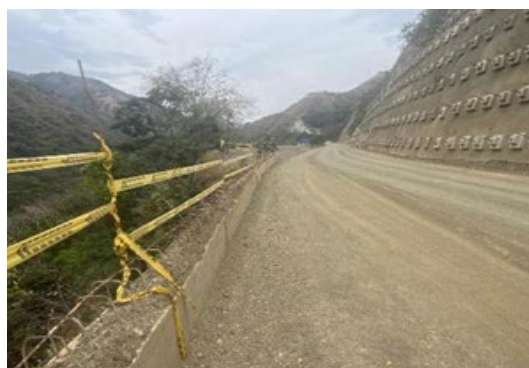
Foto 3-31 Túnel falso 3, frente inactivo este se encuentra a nivel de subrasante de la vía
