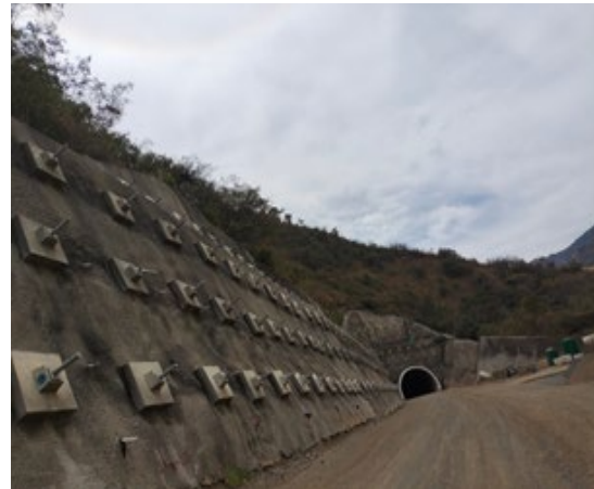
Foto 3-12 K15+246 – K15+506, estado actual
