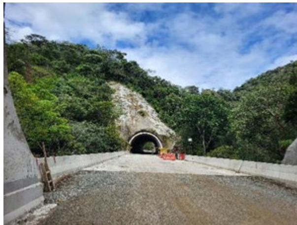
Foto 3-3839 Puente 2 ya se terminó al servicio de la obra
