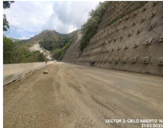
Foto 3-10 K13+330 –K14+670, estado actual
