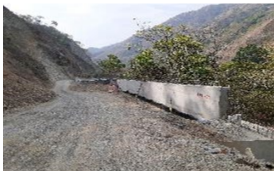
Foto 3-26 Muro 16 frente inactivo
