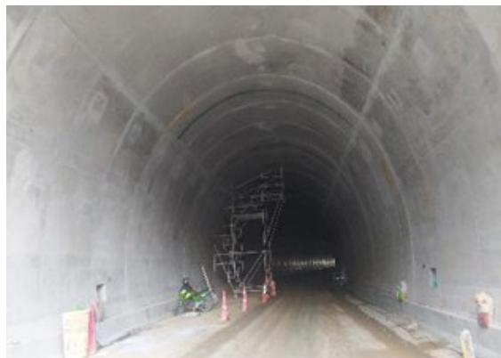
Foto 3-52 Túnel 7. resanes y acabados en los módulos de revestimiento
