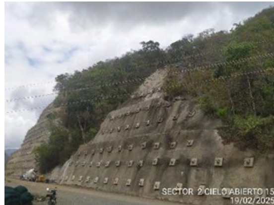
Foto 3-8 K 14+030 –K14+200, estado actual
