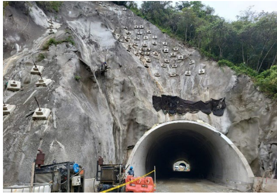
Foto 3-4647 Túnel 5 PS. Frente inactivo
