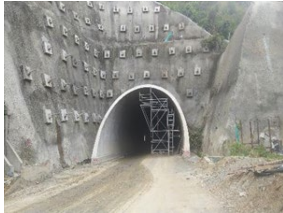
Foto 3-5656 Túnel 8. frente inactivo
