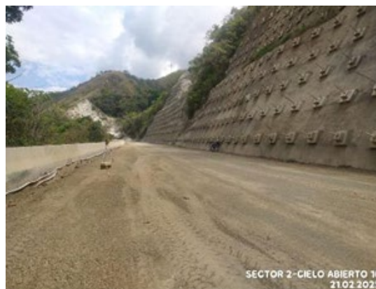
Foto 3-33 Cielo abierto 16, frente inactivo este se encuentra a nivel de subrasante de la vía
