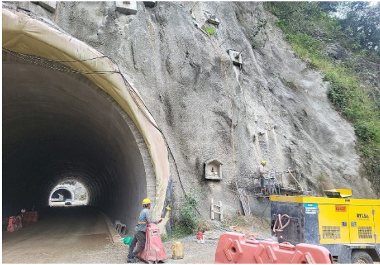
Foto 3-4949 Túnel 6 PS. Frente inactivo
