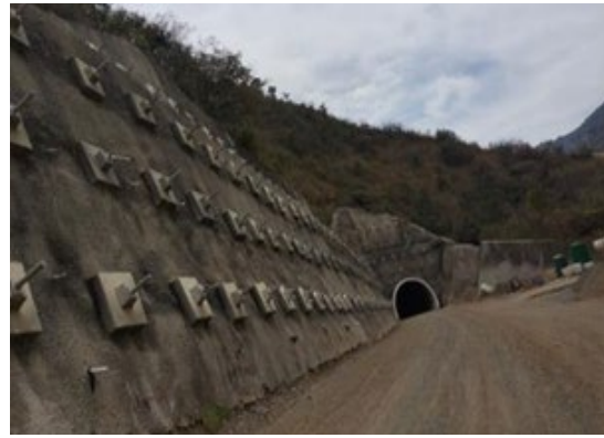
Foto 3-35 CA 17 frente inactivo a nivel de subrasante
