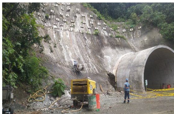
Foto 3-5858 Túnel 8 PE. Perforación para instalación de drenes horizontales
