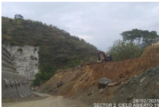
Foto 3-36 Cielo abierto 19, excavaciones de material común y transporte
