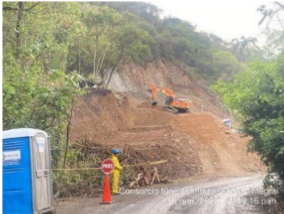
Foto 3-7 K14+030 –K14+200, estado inicial
