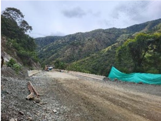
Foto 3-4142 Puente 4 en servicio de obra y comunidad, vista desde estribo 1.
