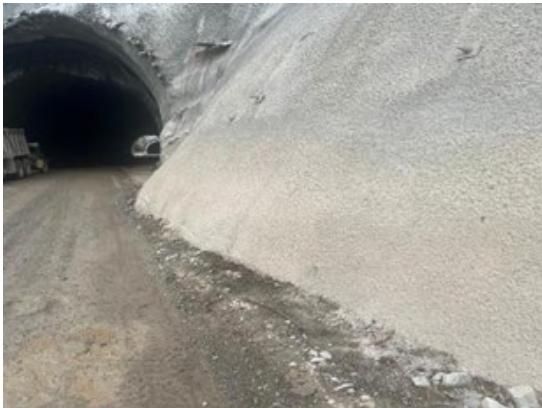
Foto 3-13 Cielo abierto 8, frente inactivo a nivel de subrasante
