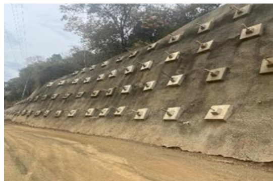
Foto 3-29 CA 15 frente inactivo a nivel de subrasante
