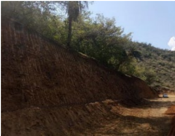
Foto 3-11 K15+246 – K15+506, estado inicial
