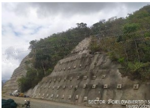
Foto 3-28 CA 15 frente inactivo a nivel de subrasante
