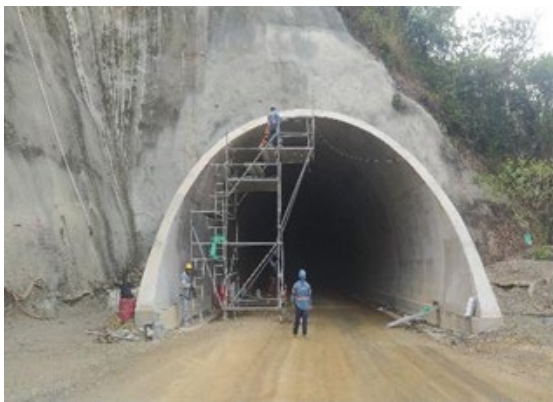
Foto 3-5151 Túnel 7. Resanes y acabados en los módulos de revestimiento.
