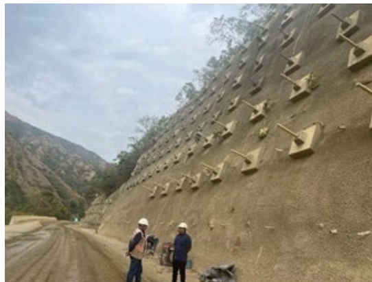
Foto 3-2 K12+356 -K13+664, estado actual
