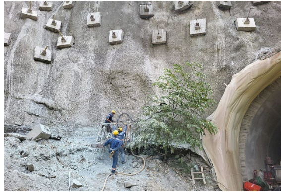
Foto 3-50 Túnel 6 PS. Frente inactivo
