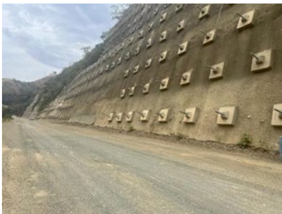
Foto 3-32 Cielo abierto 16, frente inactivo este se encuentra a nivel de subrasante de la vía
