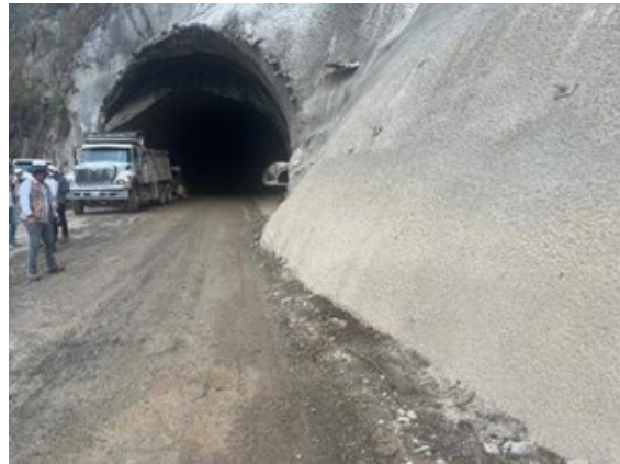
Foto 3-14 Cielo abierto 8 frente inactivo a nivel de subrasante.
