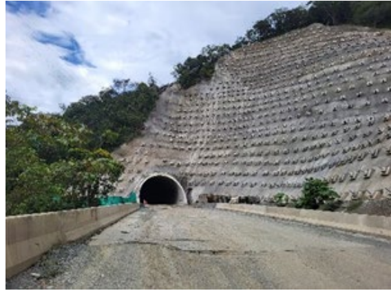
Foto 3-4243 Puente 4 en servicio de obra y comunidad, vista desde estribo 2.
