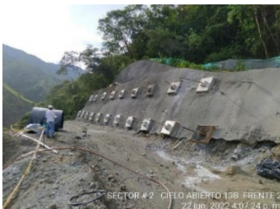
Foto 3-3 K12+356 -K13+664, estado inicial
