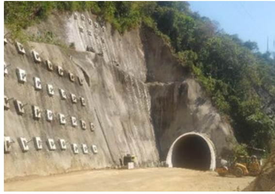
Foto 3-5454 Túnel 7 PS. Perforación e instalación de anclajes activos 20 metros en banco 1 fila 2.
