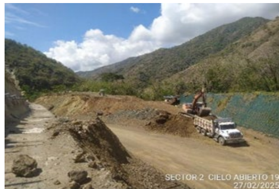
Foto 3-37 Cielo abierto 19, excavaciones de material común y transporte
