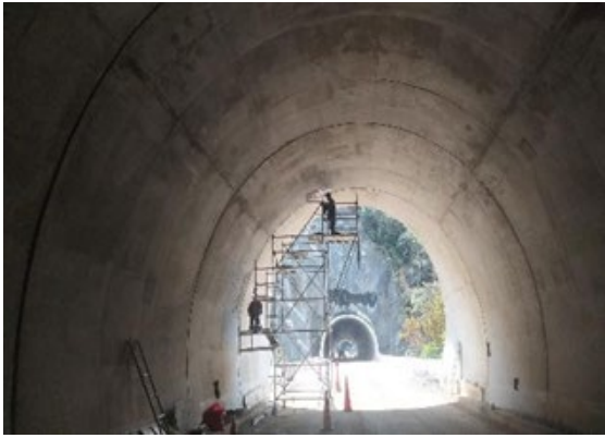
Foto 3-47 Túnel 6. Se realizo resanes y acabados en los módulos de revestimiento
