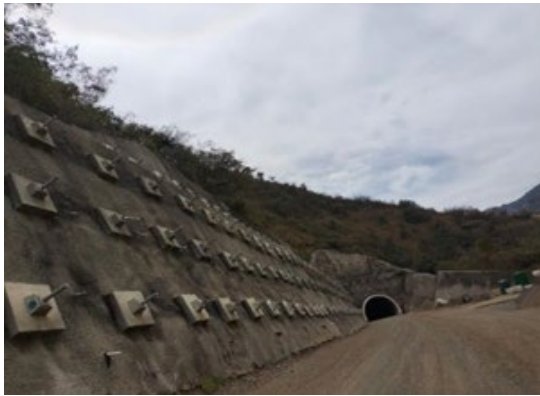
Foto 3-34 CA 17 frente inactivo a nivel de subrasante
