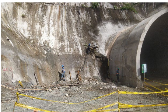
Foto 3-5757 Túnel 8 PE. Perforación para instalación de drenes horizontales
