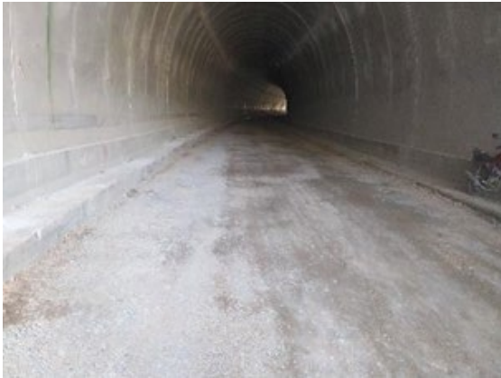
Foto 3-5555 Túnel 8. frente inactivo
