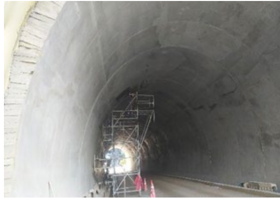
Foto 3-4848 Túnel 6 PE. Se realizó resanes y acabados en los módulos de revestimiento
