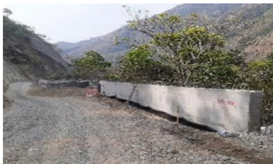
Foto 3-27 Muro 16 frente inactivo
