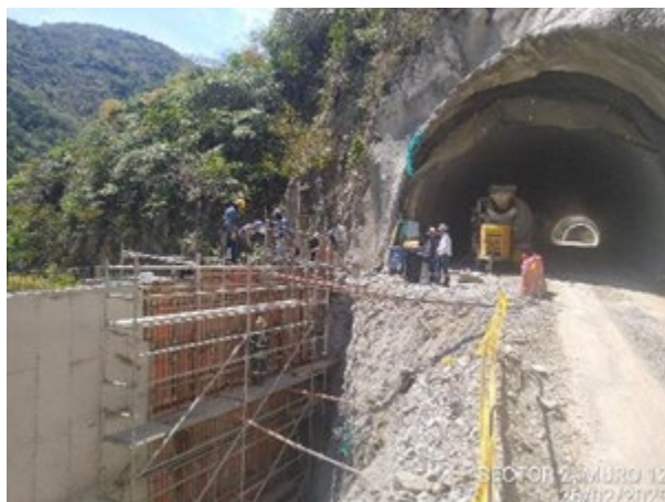
Foto 3-15 Muro 12 instalación de acero de refuerzo y hormigonado de las pilas No 13 y 14, instalación de acero de refuerzo y hormigonado de la viga cabezal y vastago del módulo 24.
