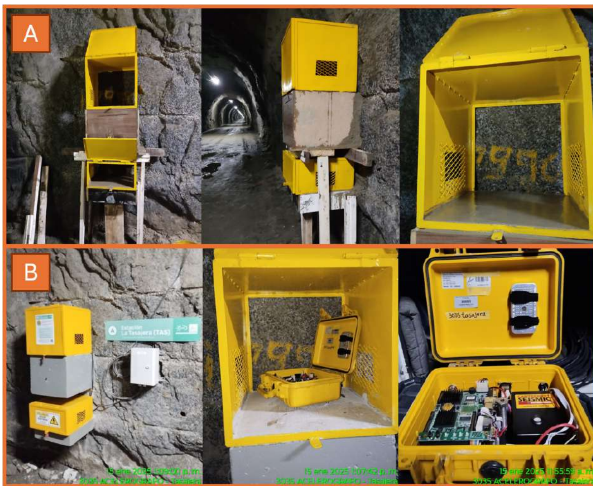
Figura 11.11: Adecuación del nuevo sitio y re-instalación de sensor de la Estación La Tasajera. (A) Construcción de obra civil (bloque de concreto y caja metálica) para disposición del acelerógrafo con sus componentes necesarios; (B) Reinstalación en sitio del sensor y puesta en servicio.
