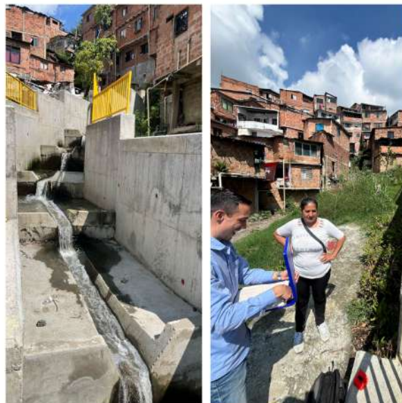
Figura 16.3: Recorrido técnico con equipo de Hidrología en SATC Aures El Chorro, distrito de Medellín.
