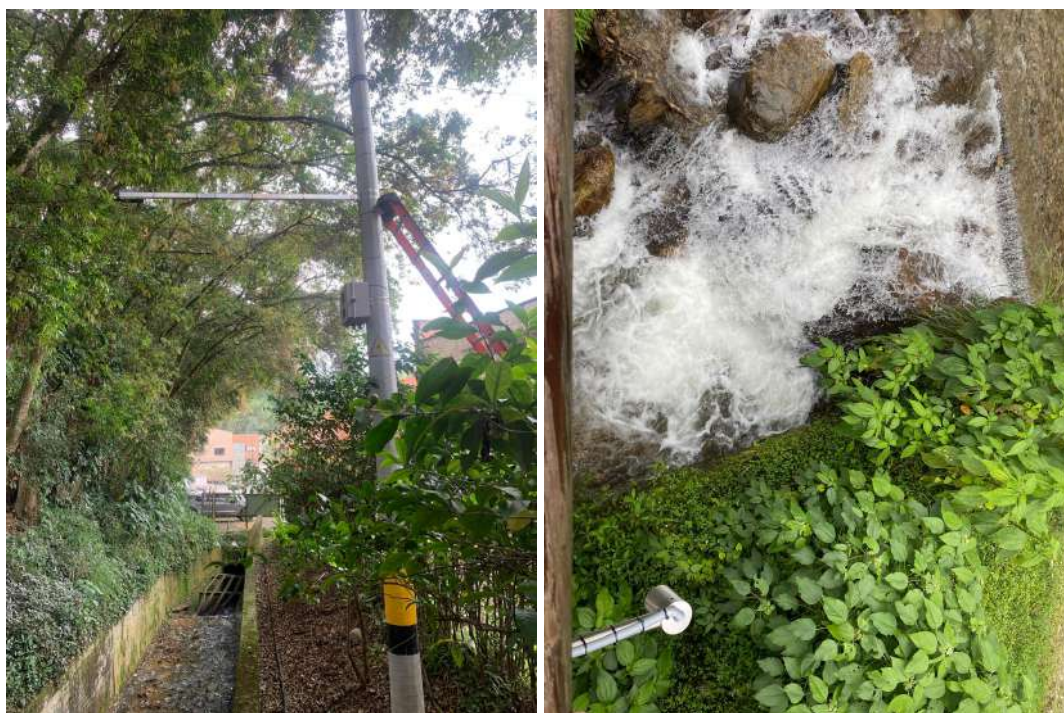
Figura 10.1: Estaciones instaladas en la red de nivel durante el mes de febrero 2025. Quebrada La Honda en Sabaneta (izquierda), quebrada La Ayurá - El Vallano en Envigado (derecha).
