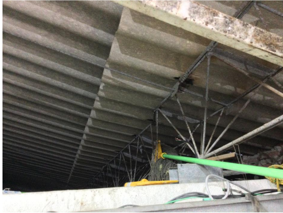
Bodega 10 modulo 1 - 2 Registro Fotográfico.
