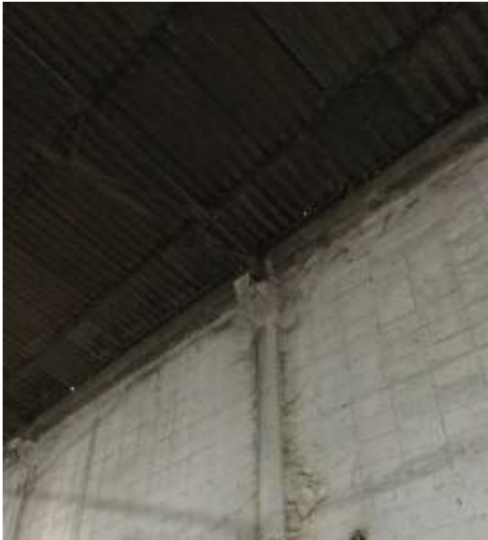
Bodega 8 modulo 9 Registro Fotográfico.
