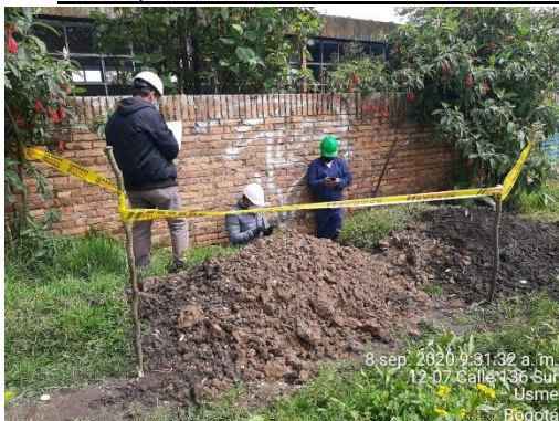
Fotografía N°3 y 4 – Registro fotográfico de los apiques realizados en la pata del muro, con el fin de determinar las dimensiones del concreto existente.
