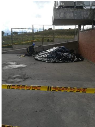
Fotografía N°86,87 – Acopio de residuos sobrantes de retiro de manto en primer sector de placa – se advierte a interventoría que se ha realizado trasiego de este material, hasta sitio de acopio.
