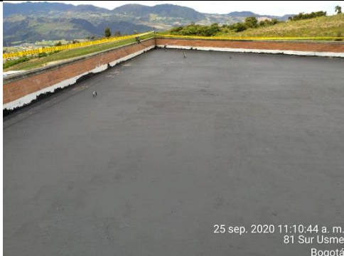
Fotografía N°82,83 – Aplicación general de emulsión previa instalación de manto en sector de placa
