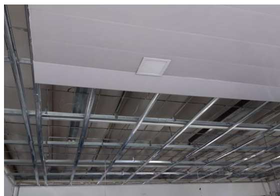
Fotografía N°48,49 - Ítem 1.3.1 Demolición Cielo Raso Falso
