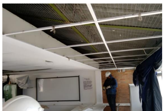
Fotografía N°50,51 - Ítem 1.3.1 Demolición Cielo Raso Falso
