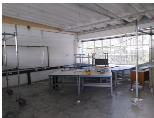
Fotografía N°48,49 - Ítem 1.3.1 Demolición Cielo Raso Falso
