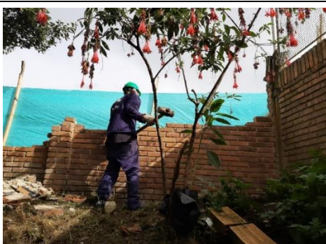
Fotografía N°11 y 12. – Ítem 1.3.10 Demolición de Muros Tolete E= 12 CM
