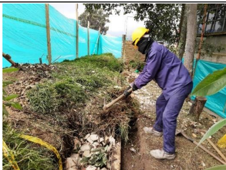
Fotografía N°5 y 6 – Ítem 1.1.5 Cerramiento Provisional H=2,00 M. en repisa y lona de verde.
