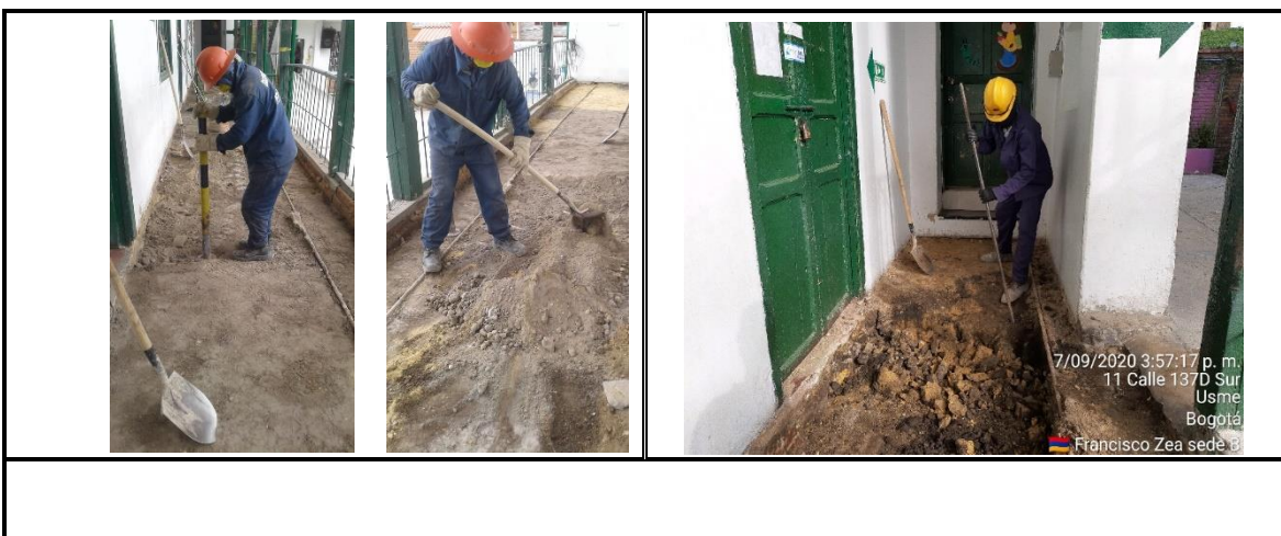
Fotografía N°31,32 - Ítem 1.3.47 Demolición del piso tablón existente y del sistema de soporte encontrado.
