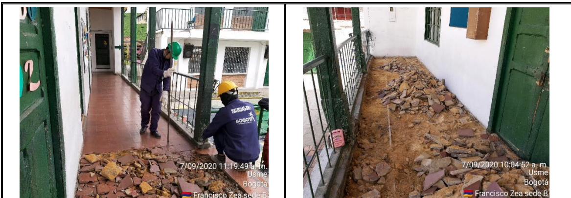
Fotografía N°29,30 - Ítem 1.3.15 Demolición Pisos en Tablón
