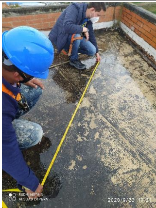
Fotografía N°74,75 – Toma de medidas generales en placa intervenida
