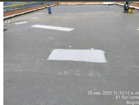
Fotografía N°80,81 – Aplicación de impermeabilizante acrílico de alta resistencia, el cual se solicita a interventoría que debe de pagarse, pues no es un ítems contractual.
