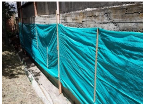
Fotografía N°5 y 6 – Ítem 1.1.5 Cerramiento Provisional H=2,00 M. en repisa y lona de verde.
