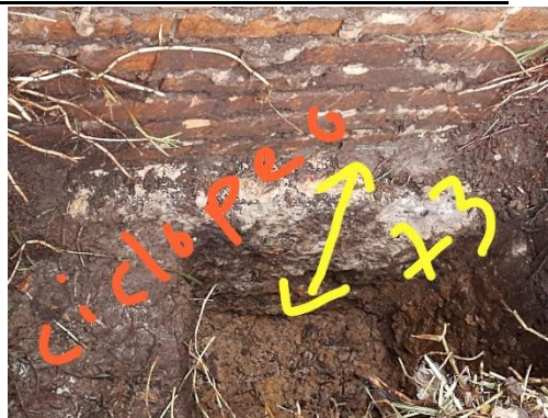
Fotografía N°3 y 4 – Registro fotográfico de los apiques realizados en la pata del muro, con el fin de determinar las dimensiones del concreto existente.
