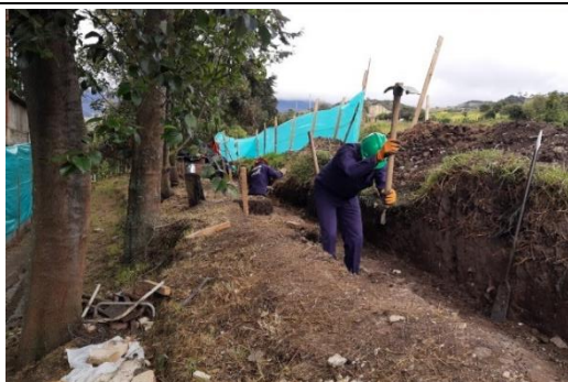
Fotografía N°13 y 14. – Ítem 2.1.6 Excavación Manual en Material Común
