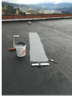
Fotografía N°78,79 – Tratamiento de grietas y resanes en la placa, con sikaflex 1 A e impermeabilizante acrílico de alta resistencia - el cual se presentara APU a interventoría para su aprobación..
