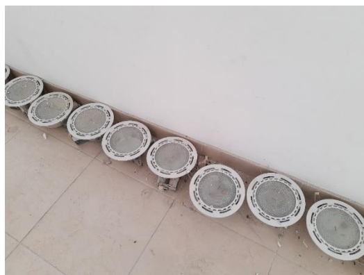
Fotografía N°52,53 - Ítem 1.3.49 Desmonte de Lámparas de 2x32.
