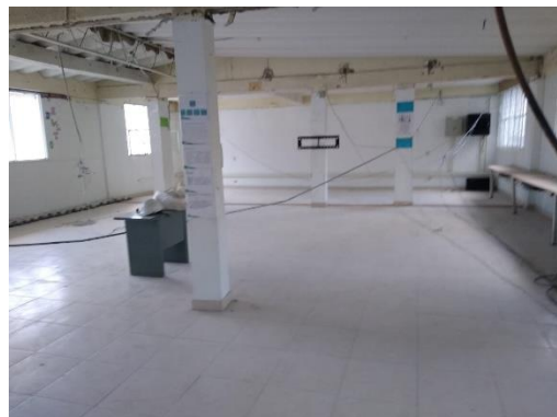
Fotografía N°50,51 - Ítem 1.3.1 Demolición Cielo Raso Falso
