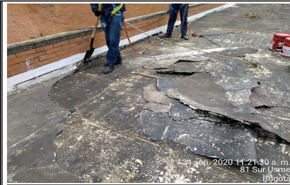
Fotografía N°70,71 – Retiro de manto existente en el perímetro (media caña).
