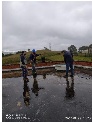
Fotografía N°76,77. – Unificación y revisión de medidas entre contratista e interventoría
