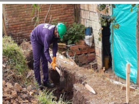
Fotografía N°13 y 14. – Ítem 2.1.6 Excavación Manual en Material Común
