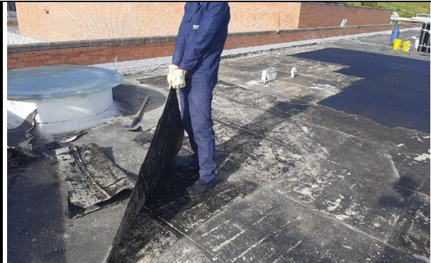
Fotografía N°72,73 – Desmonte del manto existente en placa cubiertas.
