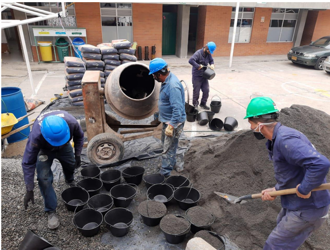
Imagen 1. Acopio de material
