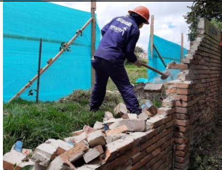
Fotografía N°11 y 12. – Ítem 1.3.10 Demolición de Muros Tolete E= 12 CM
