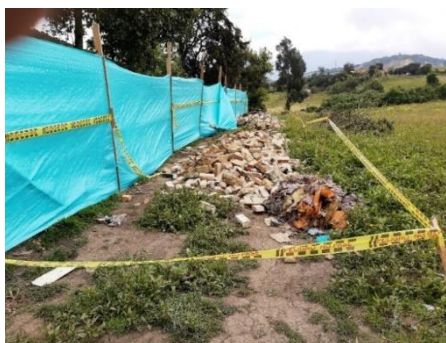
Fotografía N°5 y 6 – Ítem 1.1.5 Cerramiento Provisional H=2,00 M. en repisa y lona de verde.
