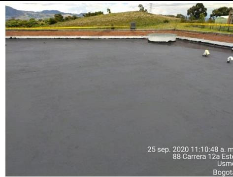
Fotografía N°84,85. – Aplicación general de emulsión previa instalación de manto en sector de placa
