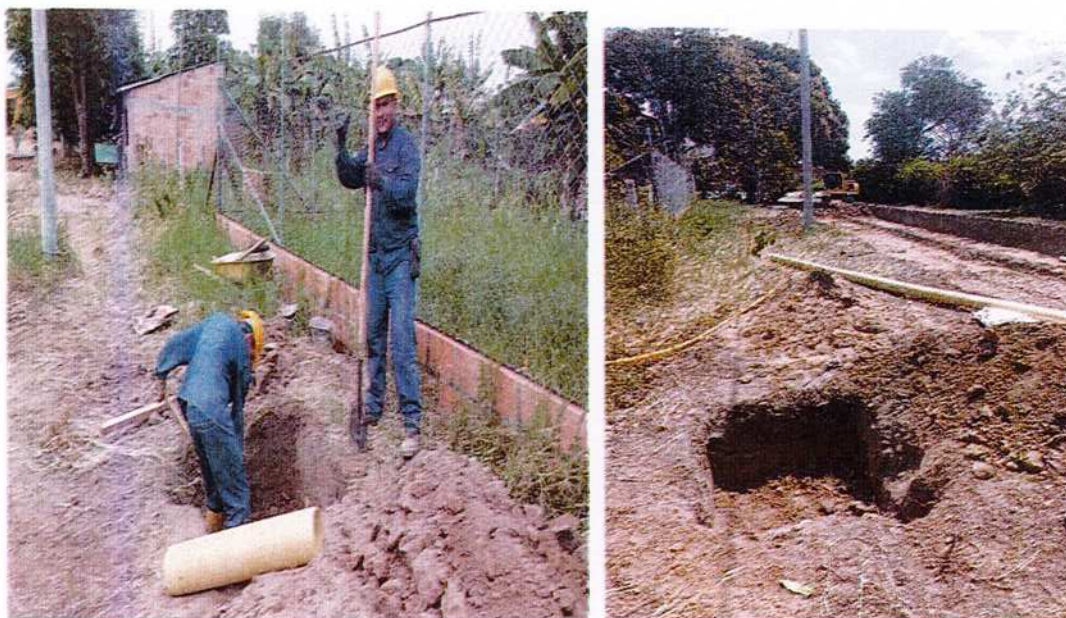
IMAGEN 24. EXCAVACIÓN A MANO EN MATERIAL COMÚN.
