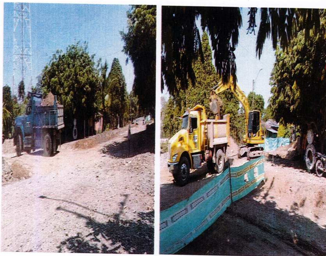
IMAGEN 36. CARGUE Y RETIRO MECÁNICO DE MATERIAL, CON ACARREO A 6 KMS.
