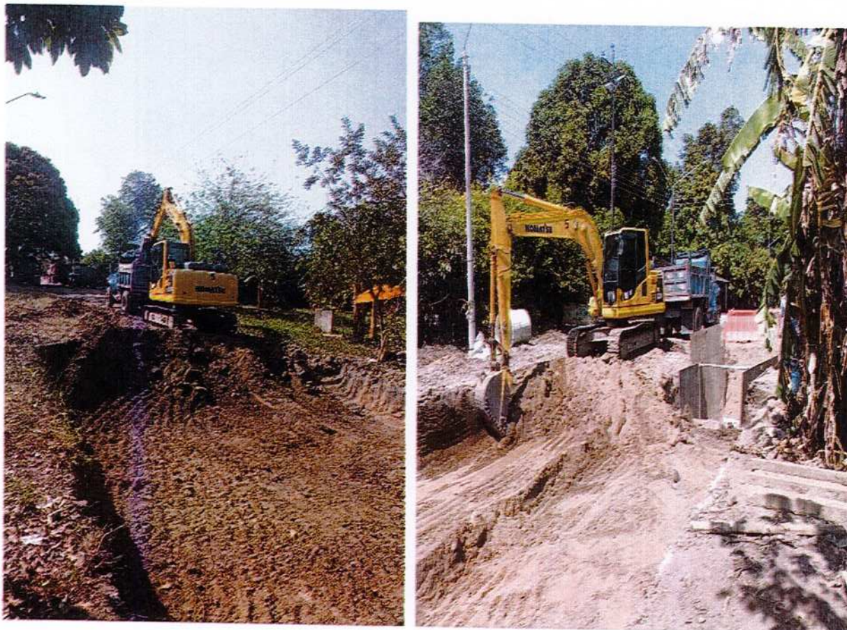
IMAGEN 41. EXCAVACIÓN DE CORTES, CANALES Y PRÉSTAMOS (ACARREO HASTA 5 KM).
