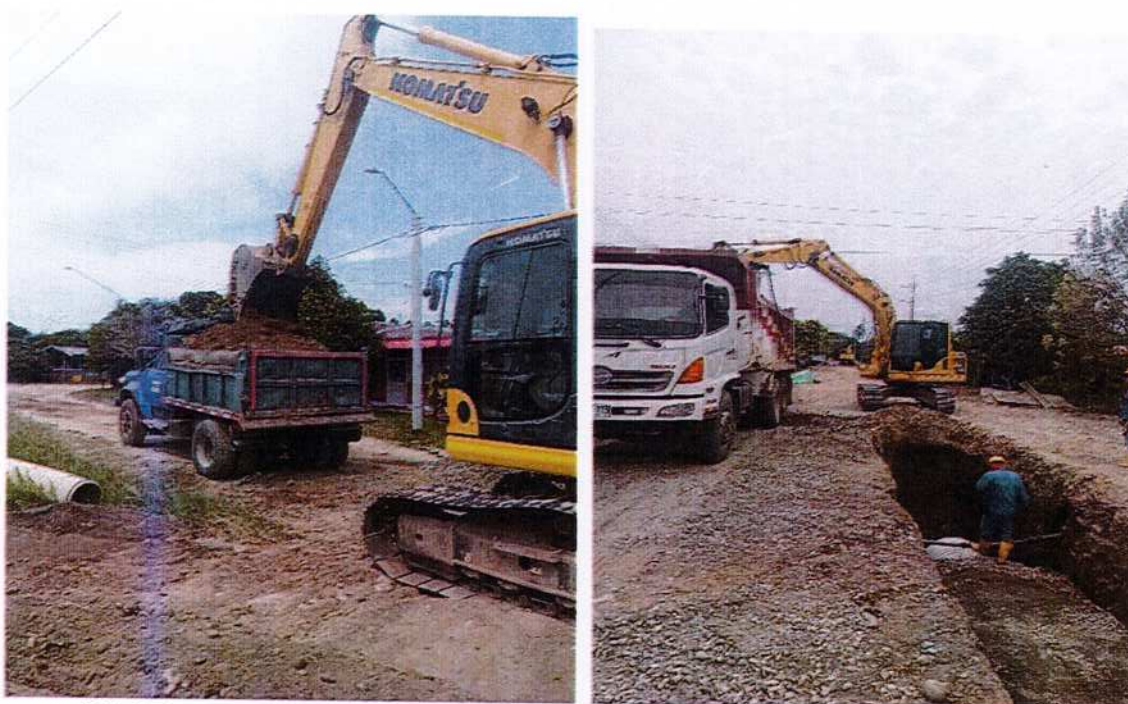
IMAGEN 14. CARGUE Y RETIRO MECÁNICO DE MATERIAL, CON ACARREO A 6 KMS.
