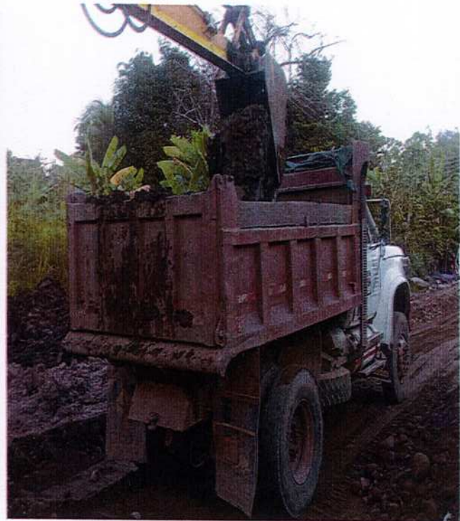
IMAGEN 18. CARGUE Y RETIRO MECÁNICO DE MATERIAL, CON ACARREO A 6 KMS.
