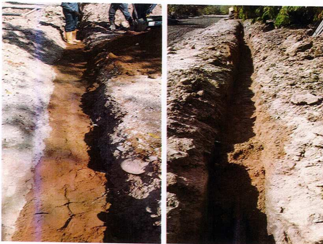
IMAGEN 32. RELLENO EN ARENA LAVADA APISONADA PARA ATRAQUE DE LA TUBERÍA CON TRANSPORTE.
