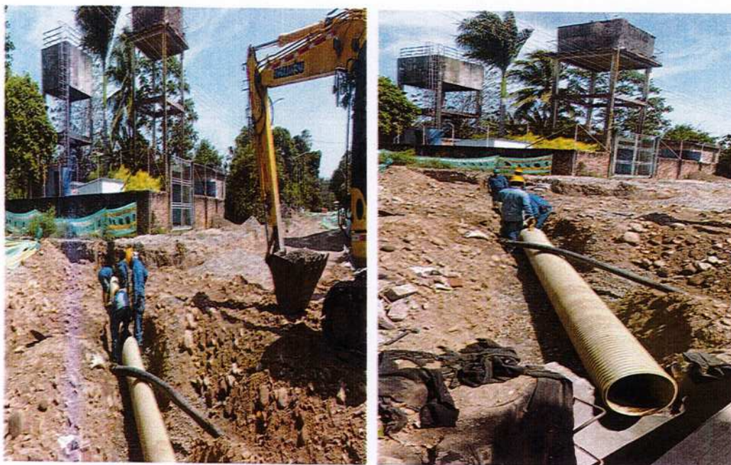
IMAGEN 10. TUBERÍA PVC ALCANTARILLADO 12". SUMINISTRO E INSTAL.
