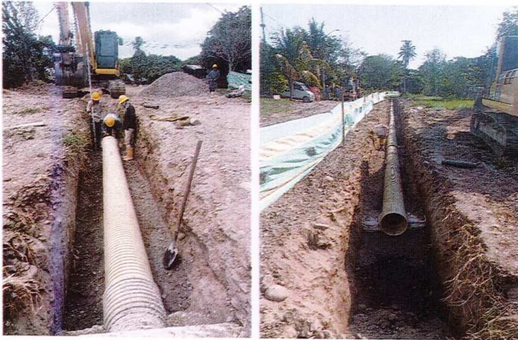
IMAGEN 11. TUBERÍA PVC ALCANTARILLADO 18". SUMINISTRO E INSTAL.
