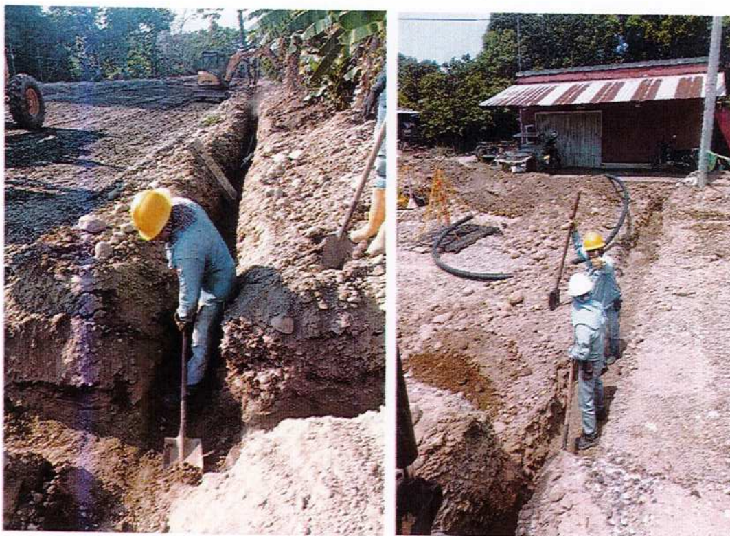
IMAGEN 31. EXCAVACIÓN MANUAL EN MATERIAL COMÚN DE 1 - 2 M. (ZANJAS ANGOSTAS).
