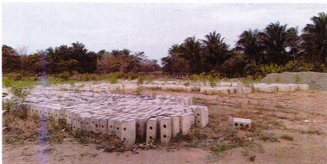
Fotografía 6.26. Acopio de sardineles en el campamento del proyecto.
