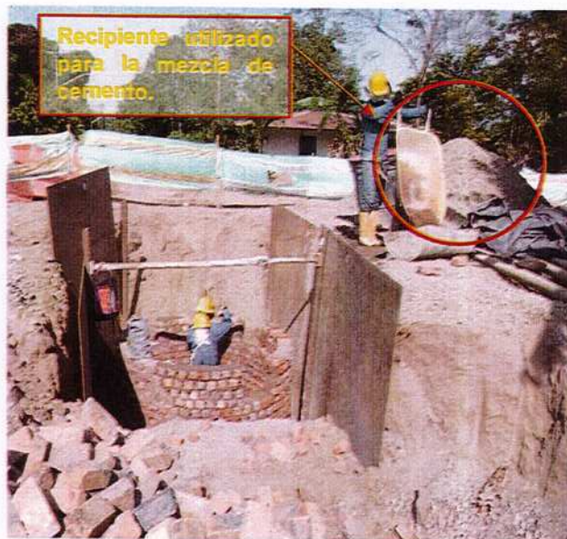
Fotografía 6.45 y 6.46. La mezcla de cemento para pañete se hace por medio de un recipiente con el cual se evita el contacto de la mezcla sobre el suelo natural.
