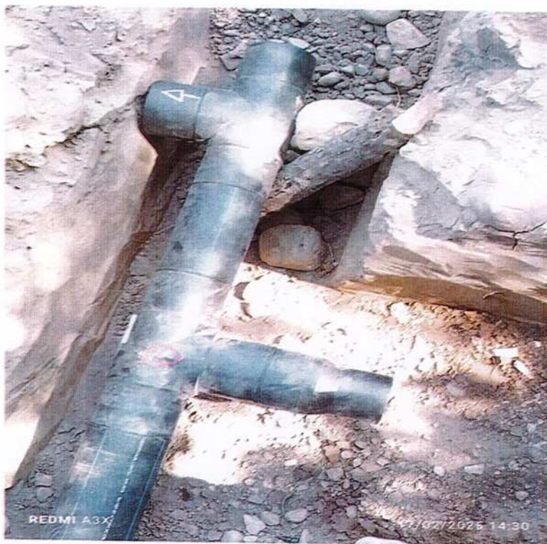
IMAGEN 39. UNIÓN REDUCIDA DE POLIETILENO PE 100 RDE 17 PN-10 DE 110 MM X 90 MM. O 4" X 3".
