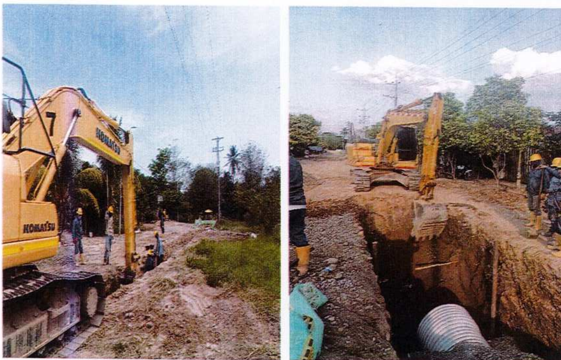
IMAGEN 7. EXCAVACIÓN MECÁNICA EN MATERIAL COMÚN 0 - 6 M (ÁREA RESTRINGIDA).
