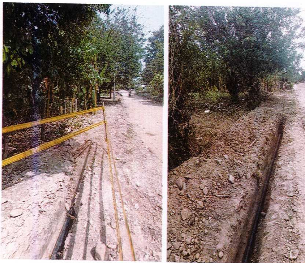
IMAGEN 35. RELLENO EN MATERIAL SELECCIONADO DE LA EXCAVACIÓN COMPACTADO.
