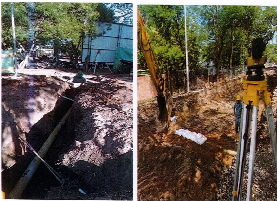
IMAGEN 25. RELLENO EN ARENA LAVADA APISONADA PARA ATRAQUE DE LA TUBERÍA CON TRANSPORTE.
