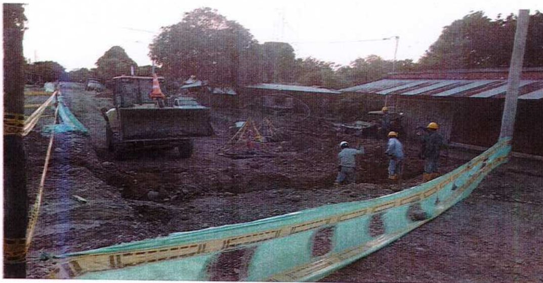
Fotografías 6.34. Aislamiento de zonas de trabajo con lona verde.
