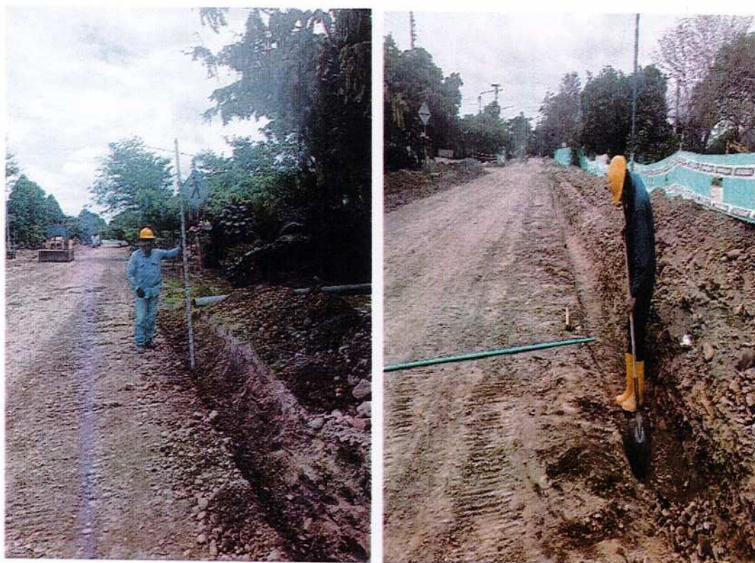
IMAGEN 43. EXCAVACIÓN A MANO EN MATERIAL COMÚN.
