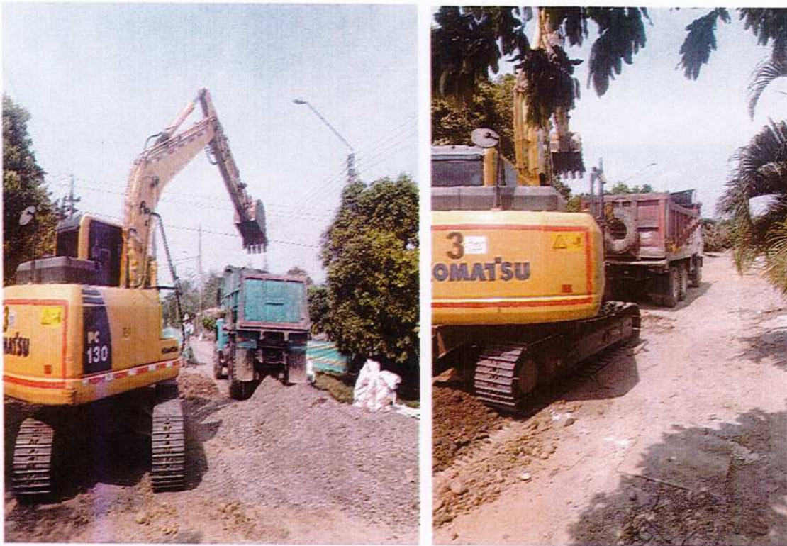
IMAGEN 20. CARGUE Y RETIRO MECÁNICO DE MATERIAL, CON ACARREO A 6 KMS.
