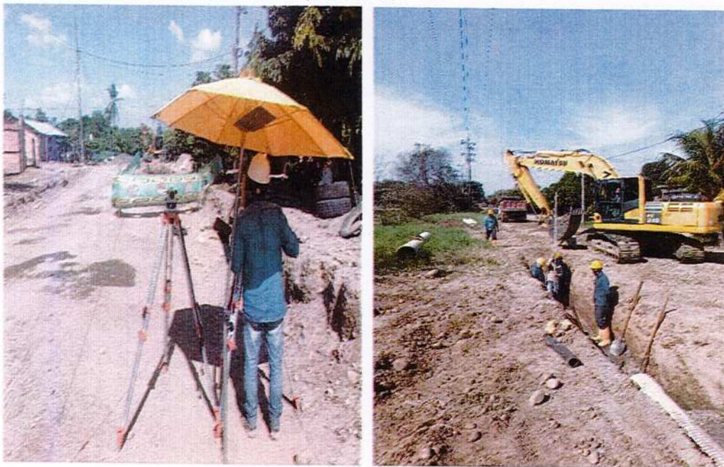
IMAGEN 6. REPLANTEO Y LOCALIZACIÓN DE TUBERÍAS DE ALCANTARILLADO.
