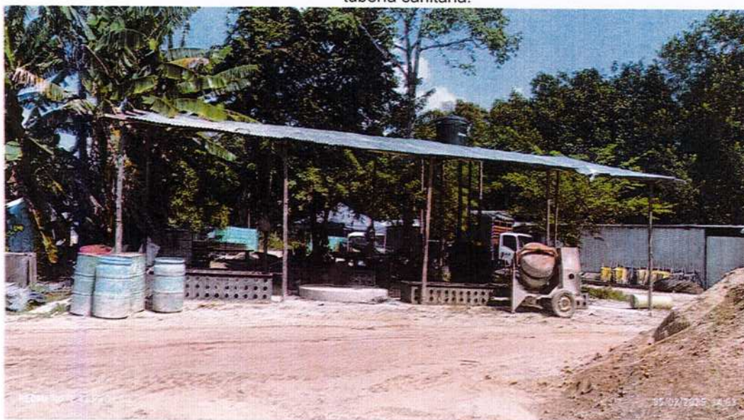
Fotografía 6.20. área destinada para la fabricación de sardineles.
