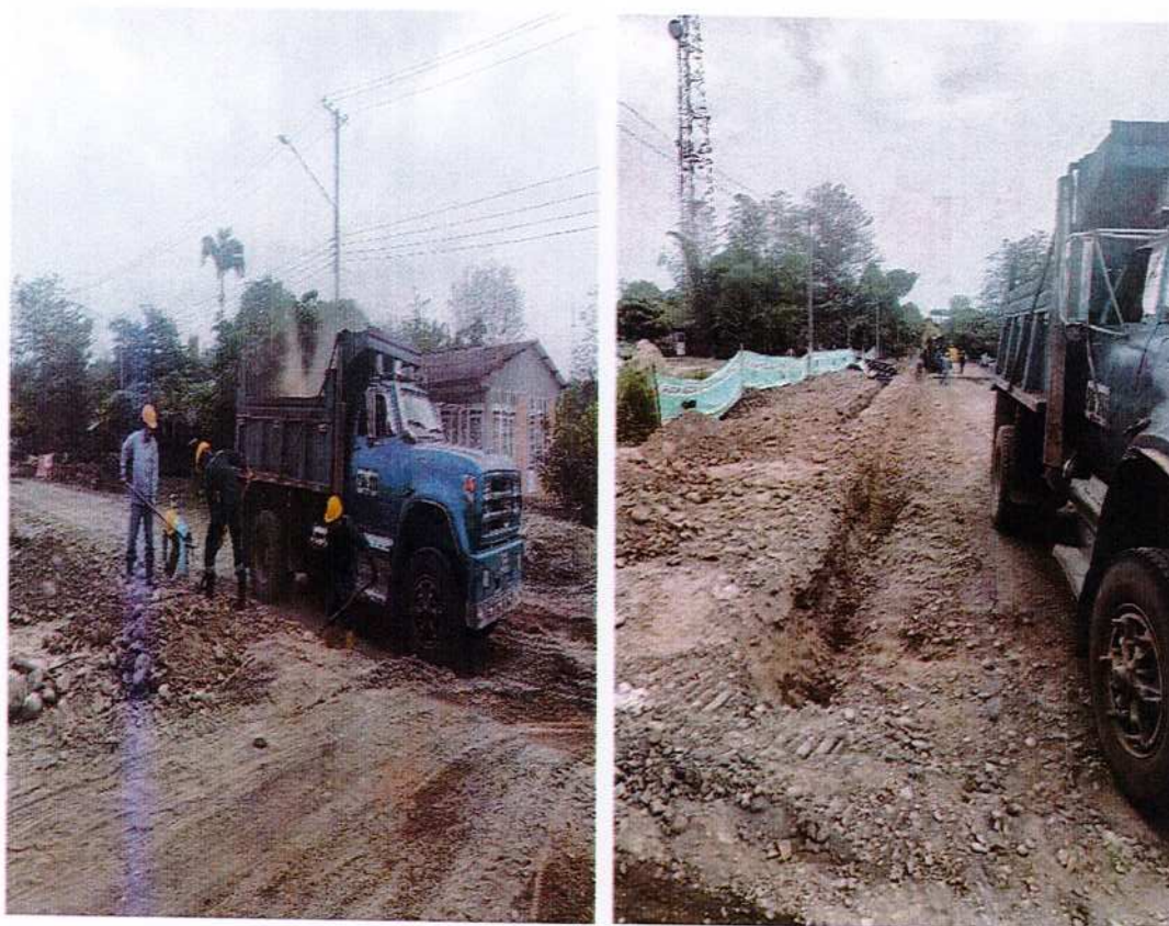
IMAGEN 50. CARGUE MANUAL Y RETIRO DE MATERIAL HASTA 6 KM.
