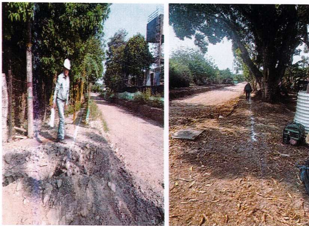
IMAGEN 30. REPLANTEO Y LOCALIZACIÓN DE TUBERÍAS DE ACUEDUCTO.
