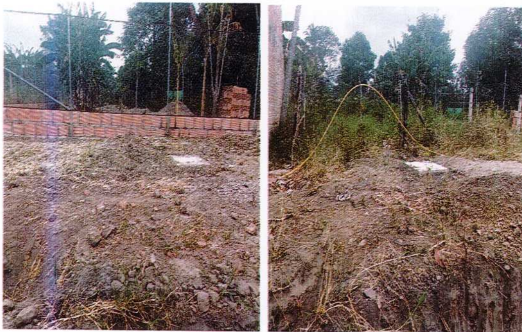
IMAGEN 27. RELLENO EN MATERIAL SELECCIONADO DE LA EXCAVACIÓN COMPACTADO.
