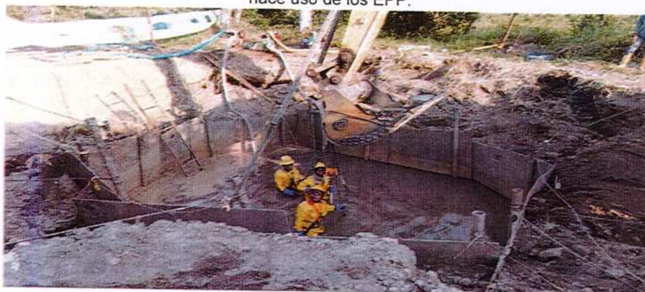
Fotografías 6.35 y 6.36. Evidencias de la instalación de la tubería sanitaria, actividades donde el personal hace uso de los EPP.
