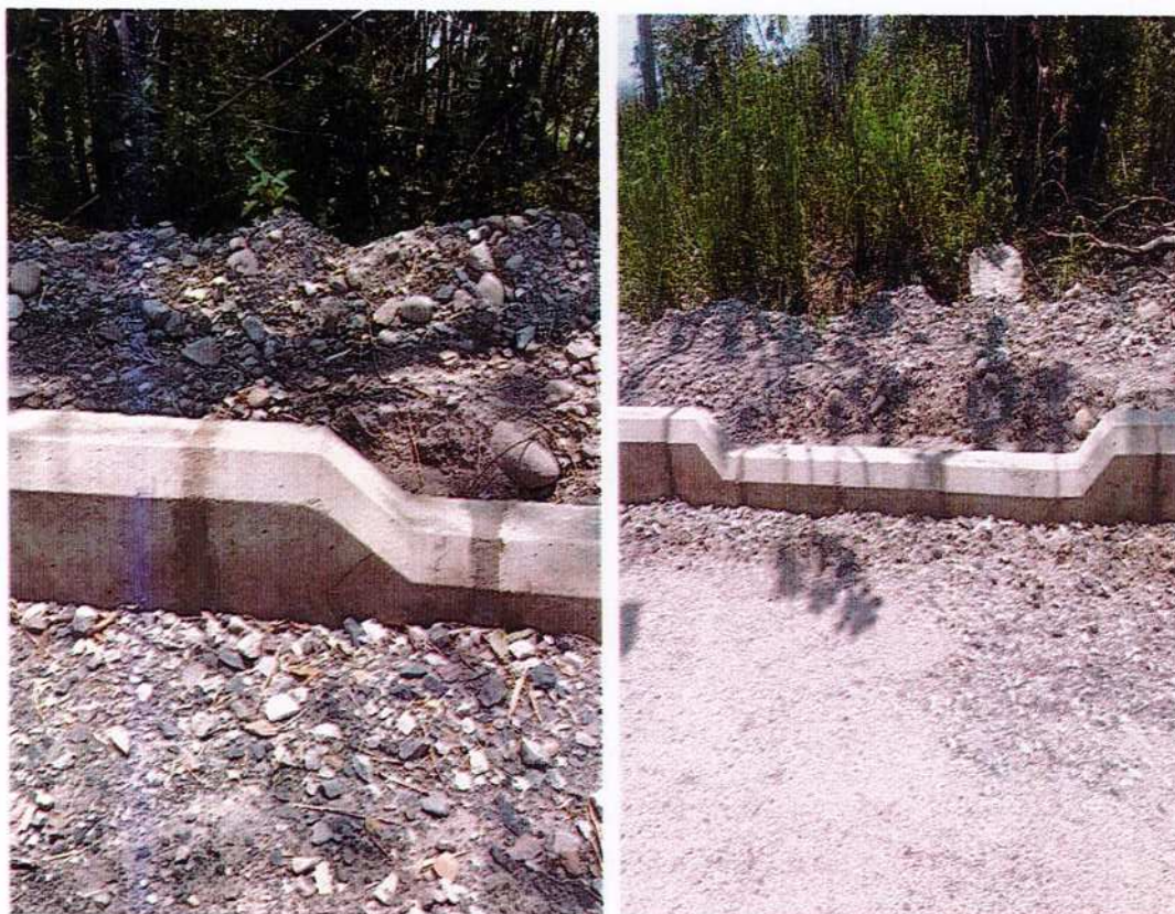
IMAGEN 48. SARDINEL ESPECIAL A-100 PARA RAMPA (0.6 X 0.20 X 0.5).
