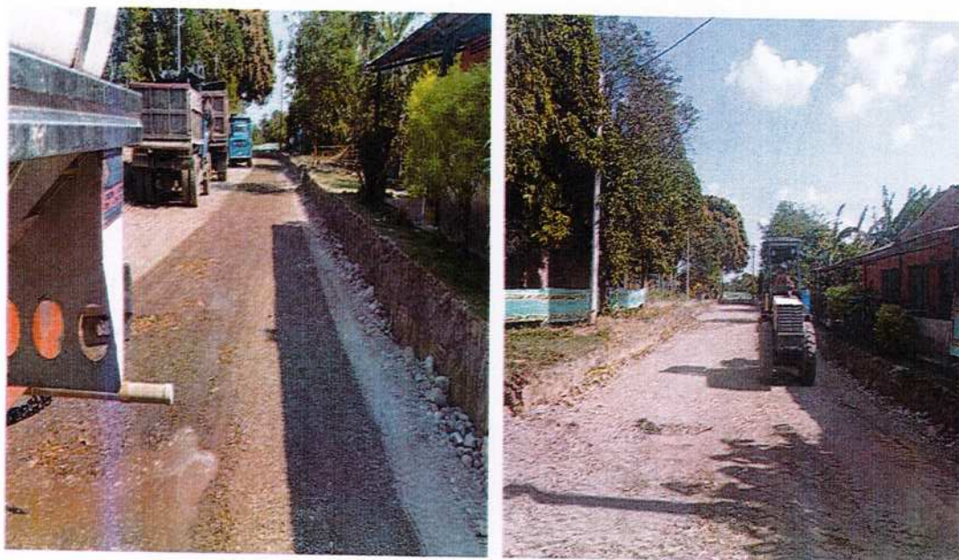
IMAGEN 42. MEJORAMIENTO DE LA SUBRASANTE CON MATERIAL CRUDO DE RÍO CLASIFICADO TMAX 3".
