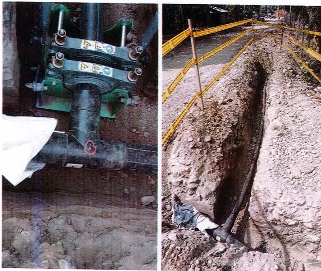
IMAGEN 38. TEE DE POLIETILENO PE 100 - RDE 17 PN 10 110 MM Ø=4".
