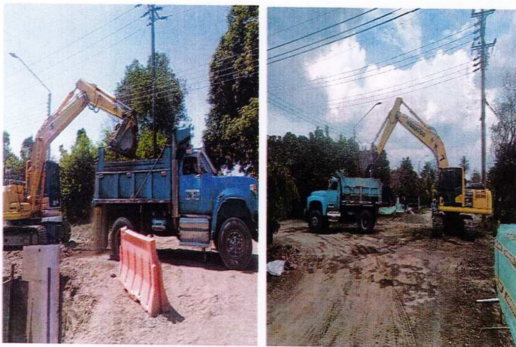
IMAGEN 29. CARGUE Y RETIRO MECÁNICO DE MATERIAL, CON ACARREO A 6 KMS.
