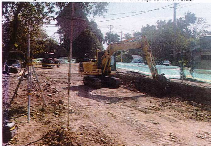
Fotografías 6.33. Aislamiento de zonas de trabajo con lona verde.
