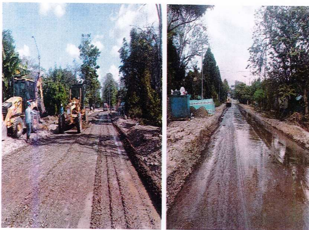
IMAGEN 46. SUB BASE GRANULAR TRITURADA.
