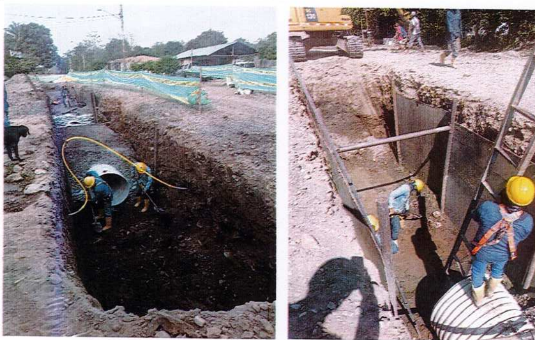
IMAGEN 8. EXCAVACIÓN A MANO EN MATERIAL COMÚN.
