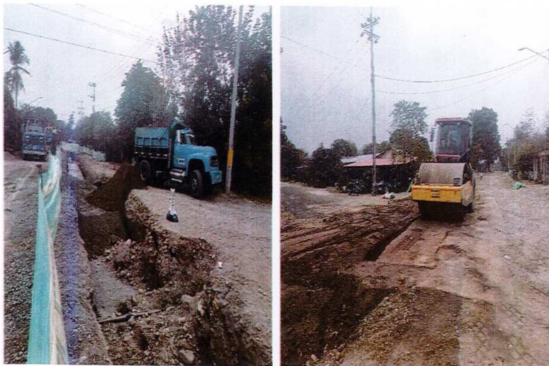
IMAGEN 13. RELLENO EN MATERIAL SELECCIONADO DE LA EXCAVACIÓN COMPACTADO.
