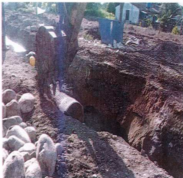
IMAGEN 16. EXCAVACIÓN MECÁNICA EN MATERIAL COMÚN 0 - 6 M (ÁREA RESTRINGIDA).
