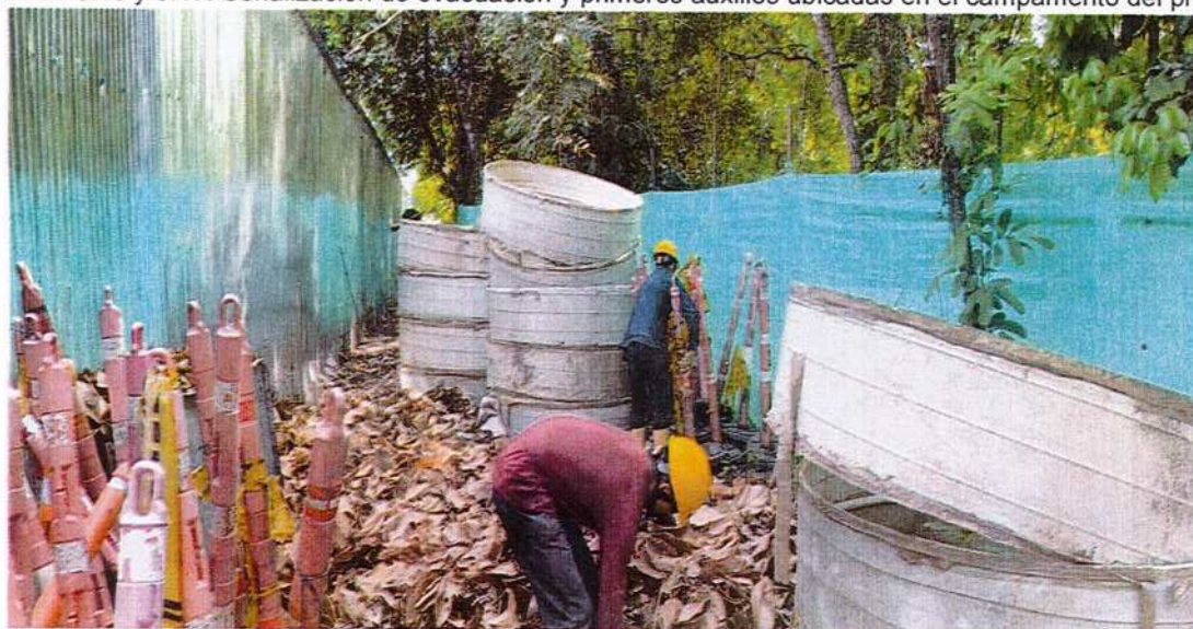
Fotografías 6.18. Limpieza del campamento. Obsérvese la señalización de evacuación instalada en el campamento.
