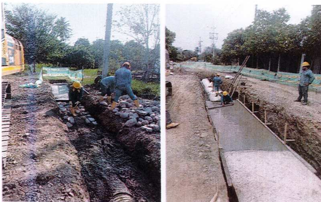
IMAGEN 15. CONCRETO CICLÓPEO DE RESISTENCIA 2500 PSI.
