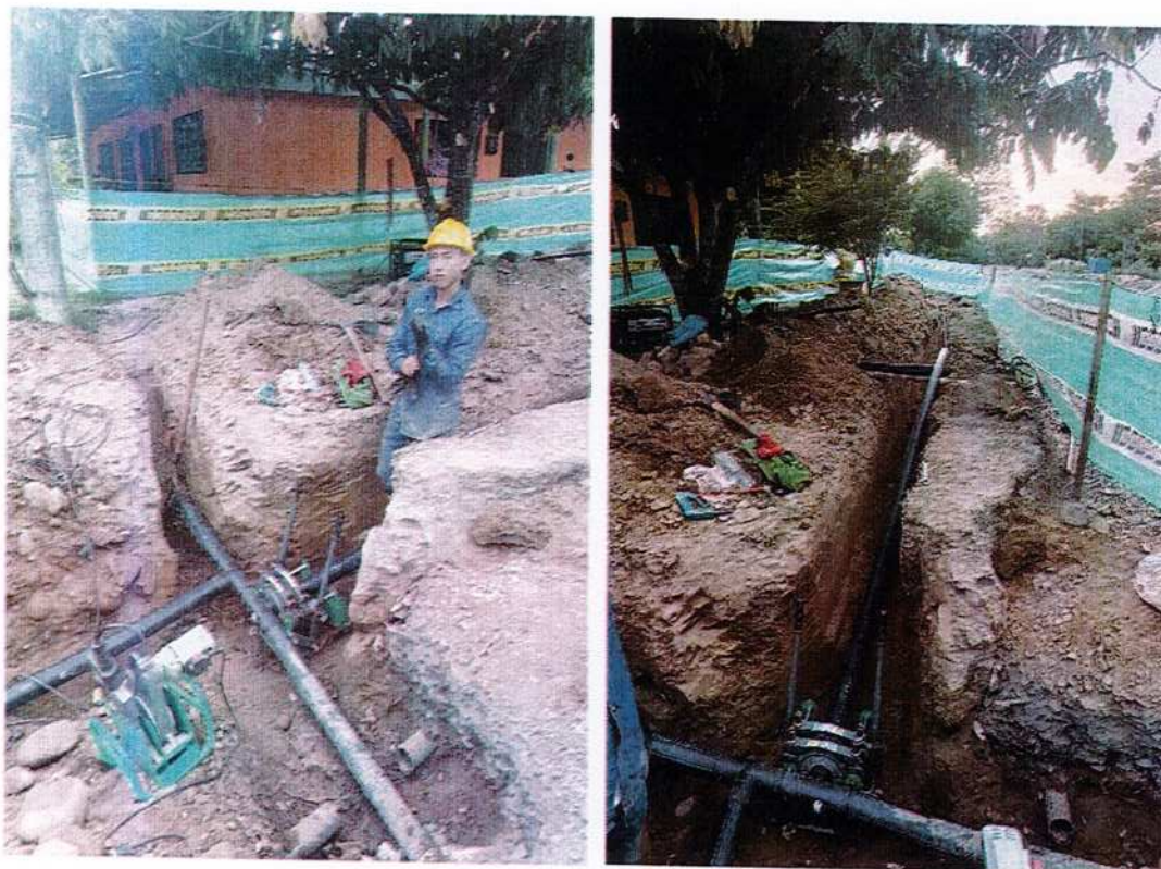
IMAGEN 37. TEE DE POLIETILENO PE 100 - RDE 17 PN 10 90 MM Ø=3".
