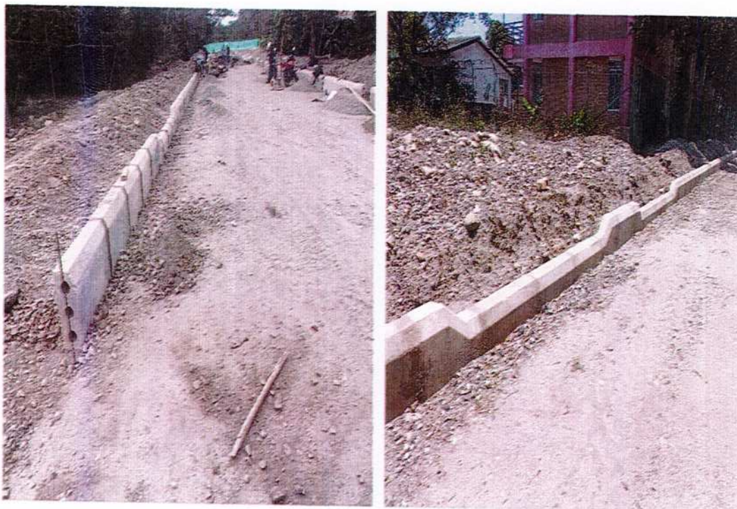
IMAGEN 45. SARDINEL PREFABRICADO (0.80 X 0.20 X 0.40) INCLUYE MORTERO DE PEGUE Y NIVELACIÓN DE 0.03 M.
