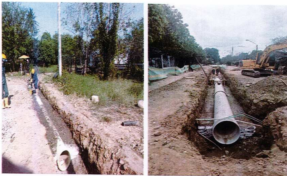
IMAGEN 9. RELLENO ZONA DE ATRAQUE DE TUBERÍA CON MATERIAL BASE GRANULAR TRITURADA (TAMAÑO MÁXIMO 1 1/2").
