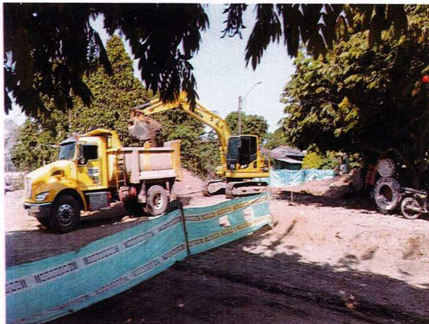
Fotografías 6.32. Aislamiento de zonas de trabajo con lona verde.
