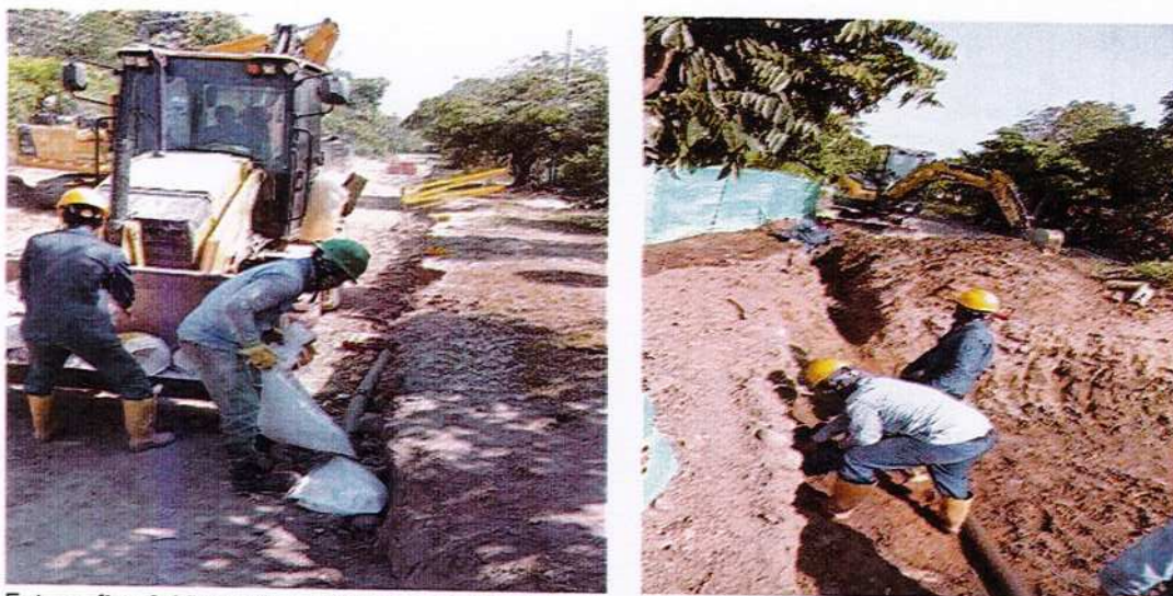
Fotografías 6.35 y 6.36. Evidencias de la instalación de la tubería sanitaria, actividades donde el personal hace uso de los EPP.
