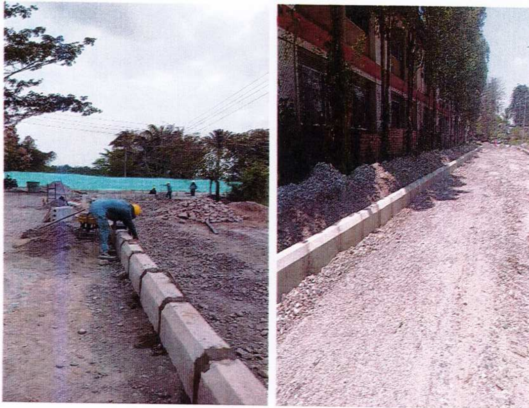
IMAGEN 44. SARDINEL PREFABRICADO A-10 (0.80 X 0.20 X 0.50) INCLUYE MORTERO DE PEGUE Y NIVELACIÓN DE 0.03 M.
