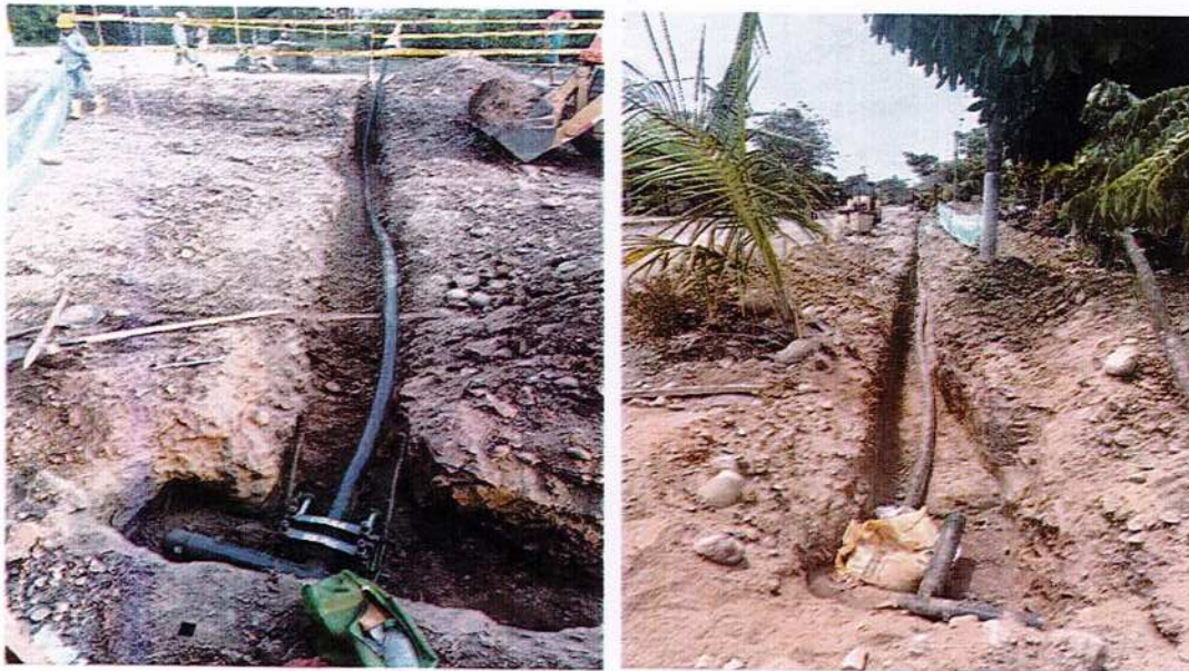
IMAGEN 40. TAPÓN DE POLIETILENO PE 100 - RDE 17 PN 10 90 MM Ø=3". SUMINISTRO E INSTAL.
