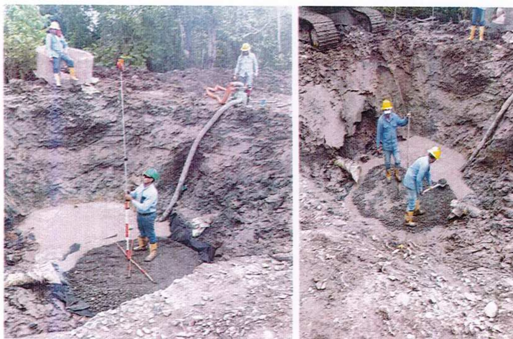
IMAGEN 23. SUB BASE GRANULAR TRITURADA.
