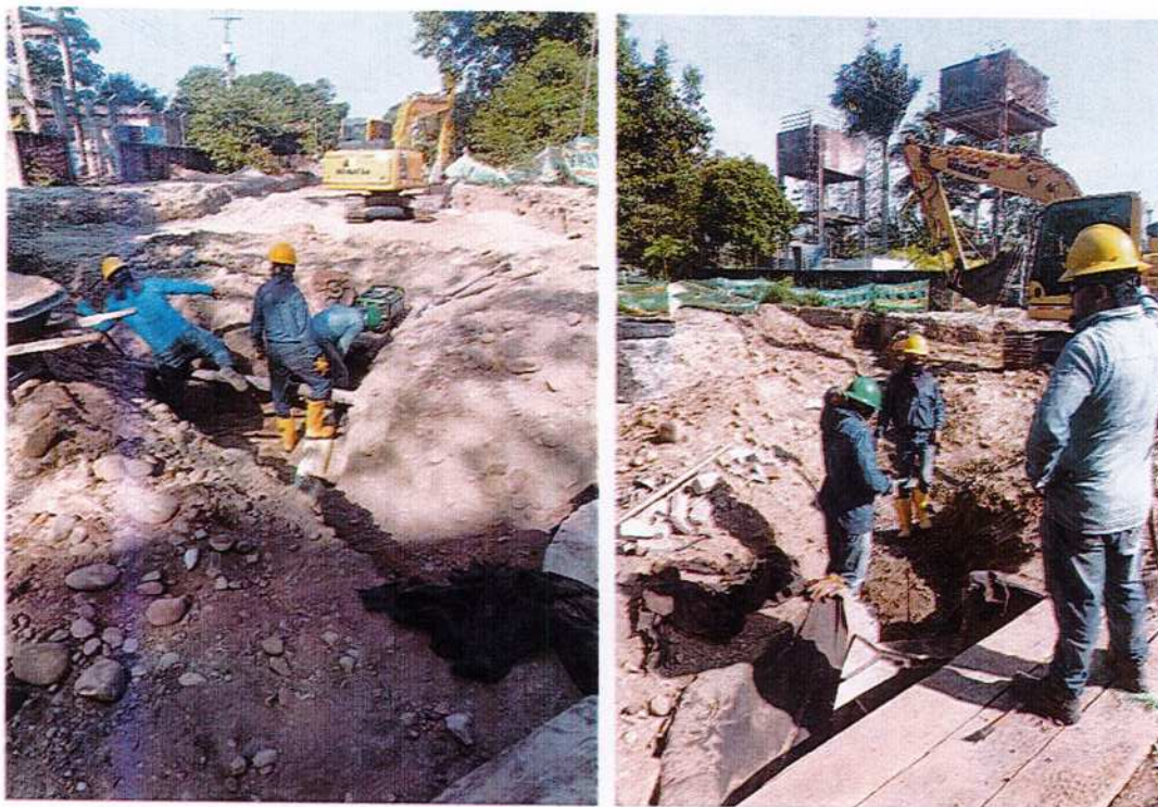
IMAGEN 19. EXCAVACIÓN A MANO EN MATERIAL COMÚN.
