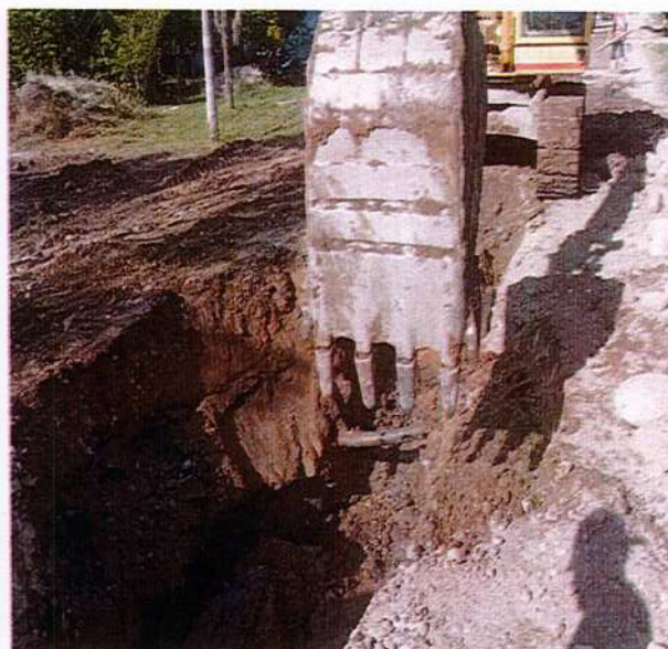
IMAGEN 16. EXCAVACIÓN MECÁNICA EN MATERIAL COMÚN 0 - 6 M (ÁREA RESTRINGIDA).
