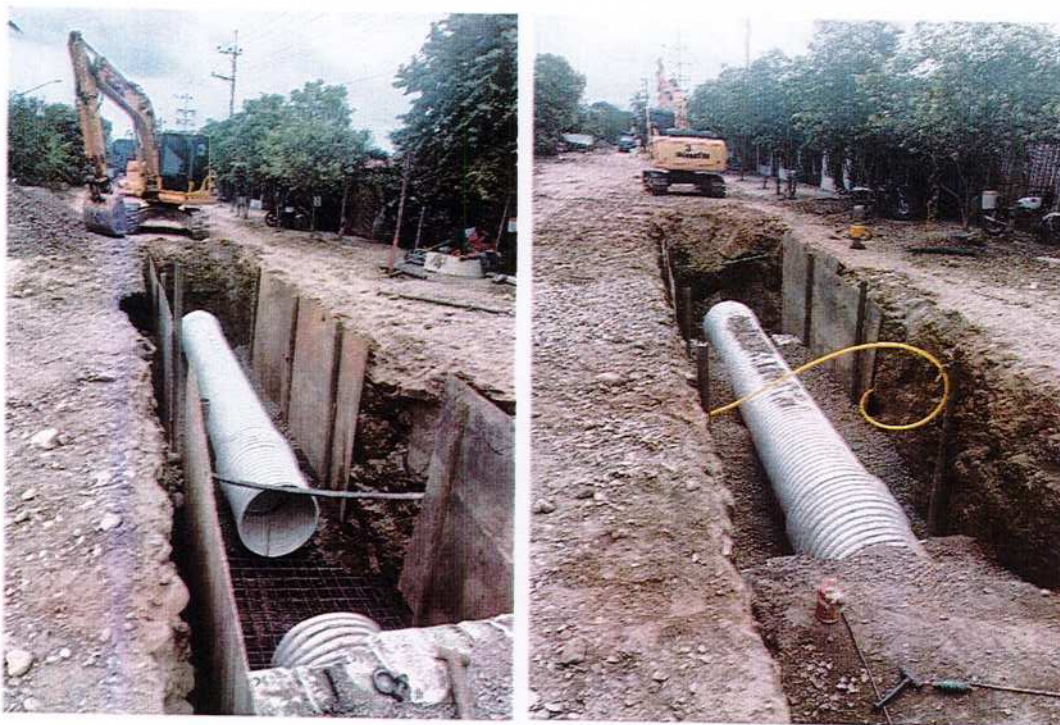
IMAGEN 12. TUBERÍA PVC ALCANTARILLADO 36". SUMINISTRO E INSTAL.
