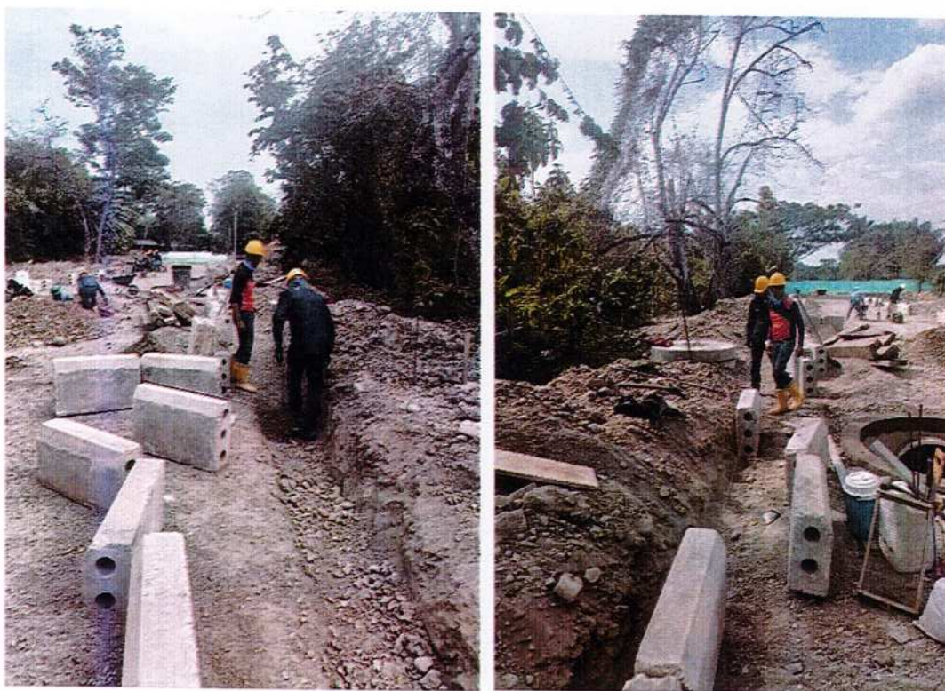
IMAGEN 49. RELLENO EN ARENA LAVADA APISONADA PARA SOLADO CON TRANSPORTE.
