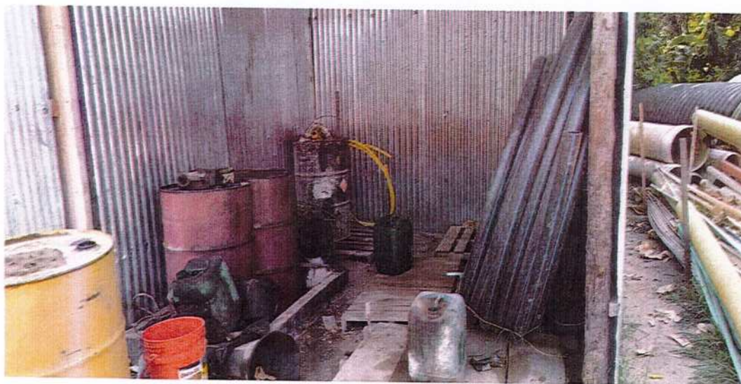
Fotografía 6.47. Caseta de almacenamiento de residuos sólidos ubicada en el campamento del proyecto.
