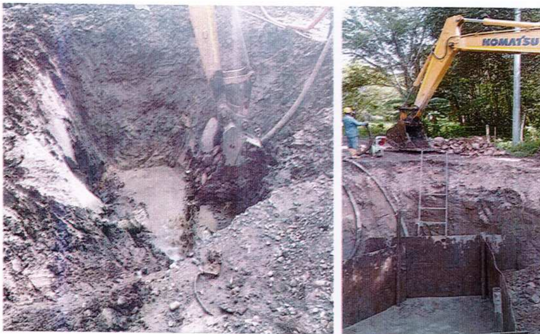
IMAGEN 21. MEJORAMIENTO DE LA SUBRASANTE CON MATERIAL TIPO PIEDRA COMÚN O BOLO, INCLUYE TRANSP.
