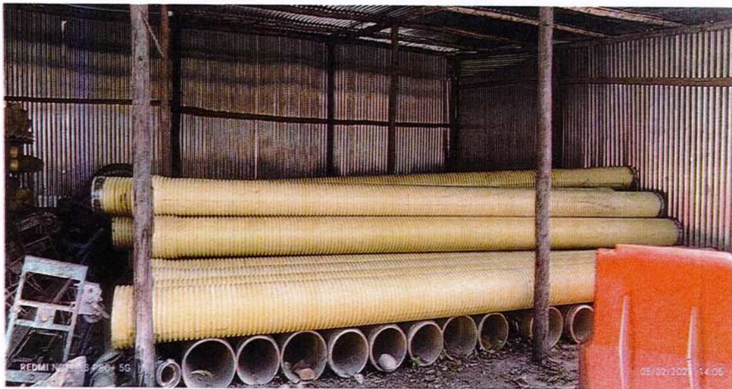
Fotografía 6.19. Áreas del campamento utilizadas como acopio de algunos elementos utilizados en obra. Acopio de tubería sanitaria.
