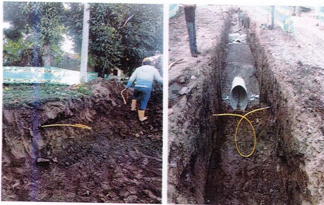
IMAGEN 51. REPARACIÓN TUBERÍA DE GAS POLIETILENO PE-80 DE 1/2".
