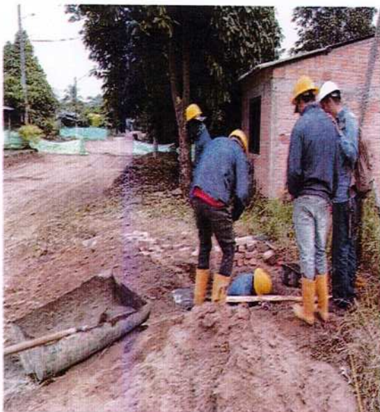
Fotografía 6.45 y 6.46. La mezcla de cemento para pañete se hace por medio de un recipiente con el cual se evita el contacto de la mezcla sobre el suelo natural.
