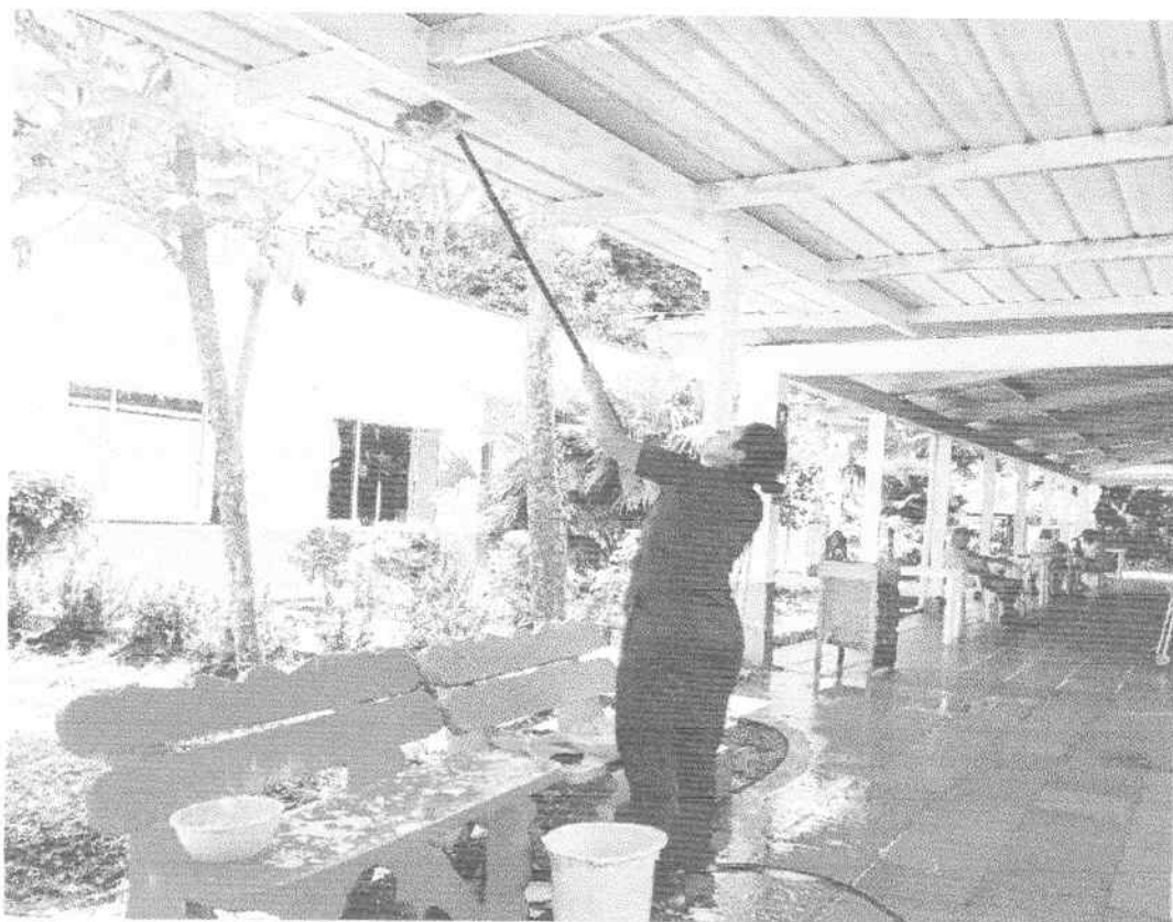
Limpieza de cubiertas, pasillos, paredes y columnas
