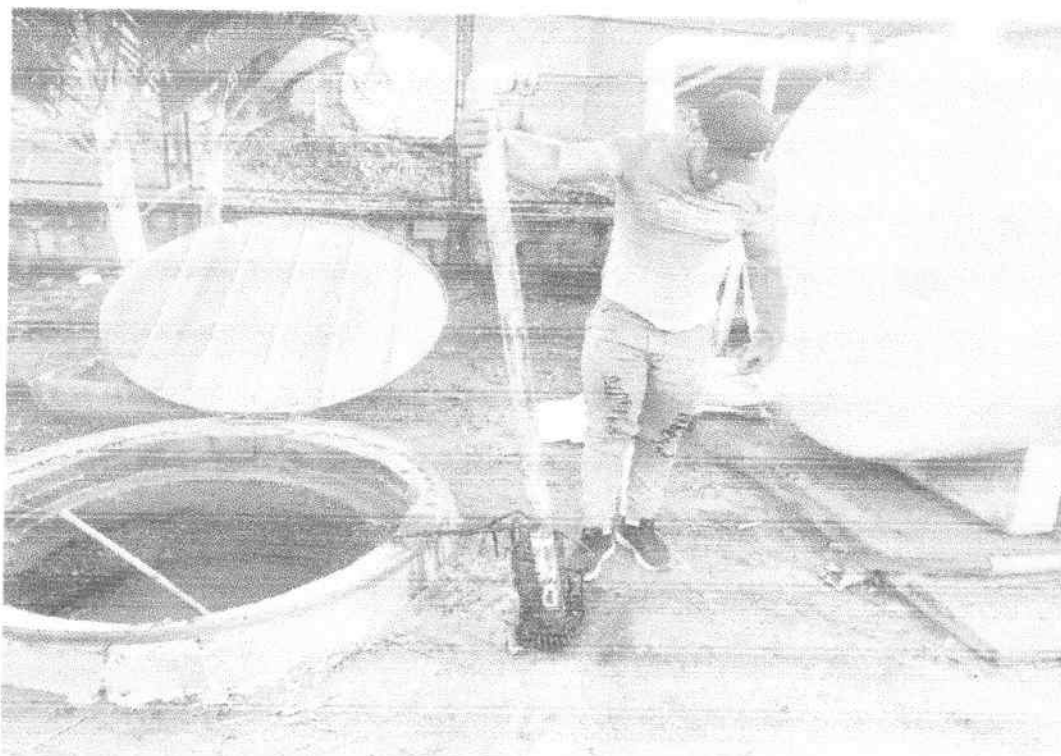
Revisión de la bomba sumergible
