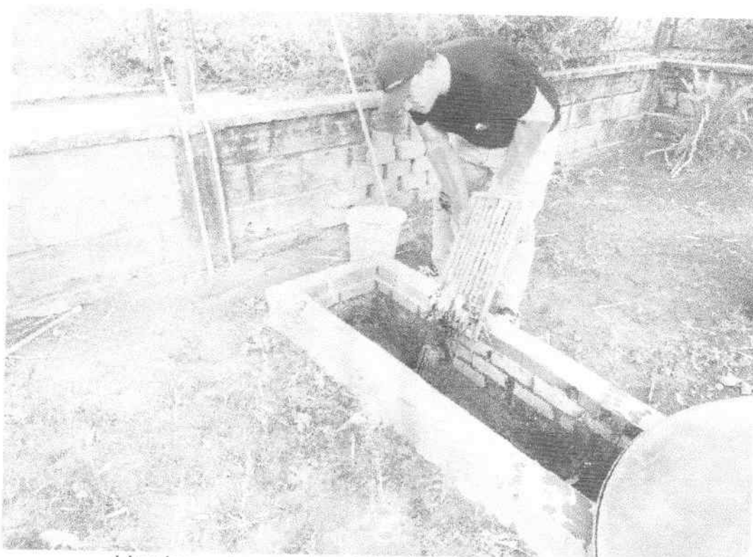
Limpieza y lavado de rejillas del sistema de cribado.
