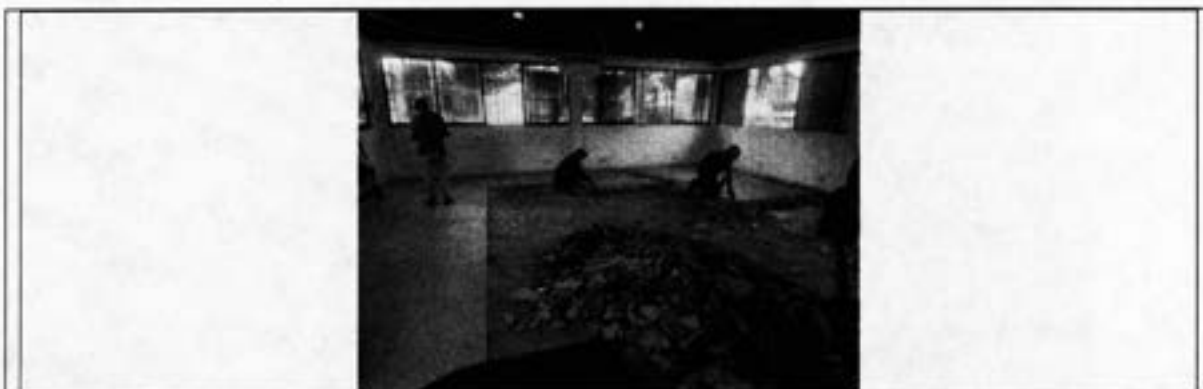
Adecuación baños niños y niñas
