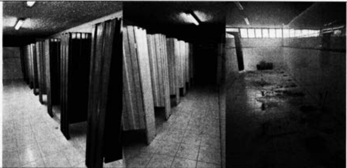
Desmante divisiones existentes
