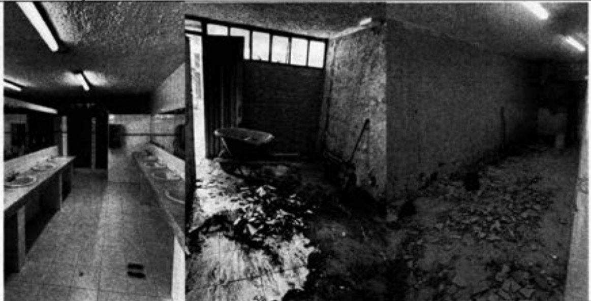
Demolición enchape de pisos (incluye guardaescoba, cargue y retiro de escombros).
