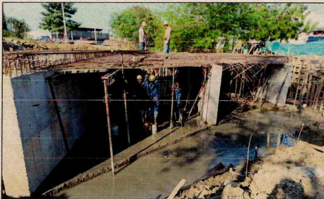
FOTO No.1 ACERO PARA LOSA SUPERIOR BOX DE LA CALLE 50
