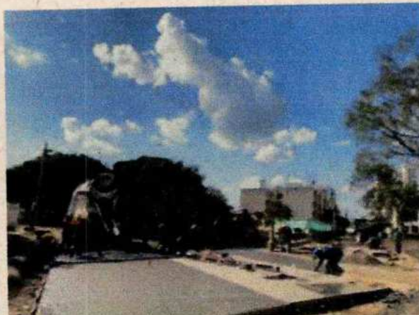
Fundida losa de aproximación box calle 48
