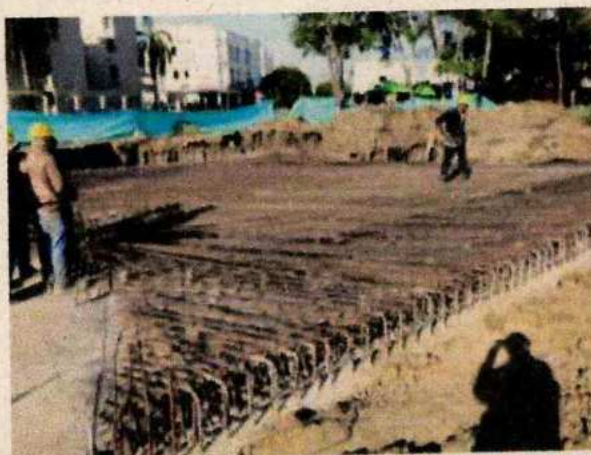
Acero de refuerzo en losa superior de box calle 50
