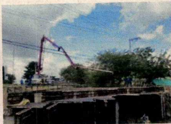
Vaciado de concreto en losa superior Box Calle 50
