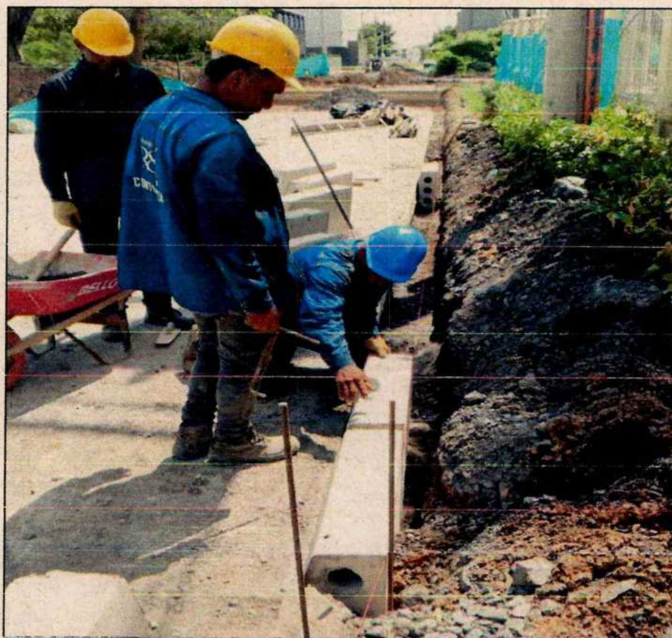
FOTO No. 5 INSTALACIÓN DE BORDILLOS
