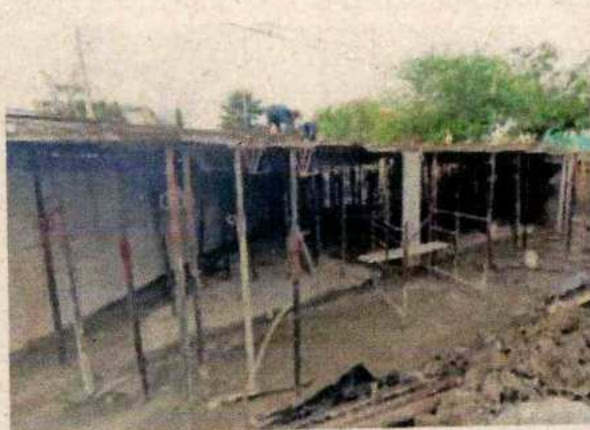
Vaciado de concreto en losa superior Box Calle 50
