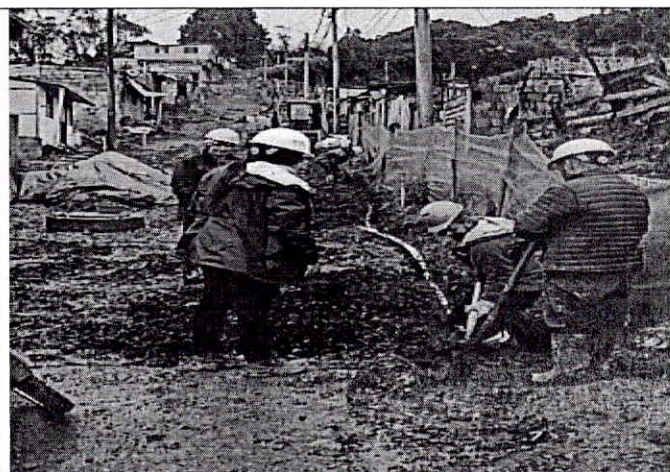
Excavaciones movimiento tubería CIV 3B
