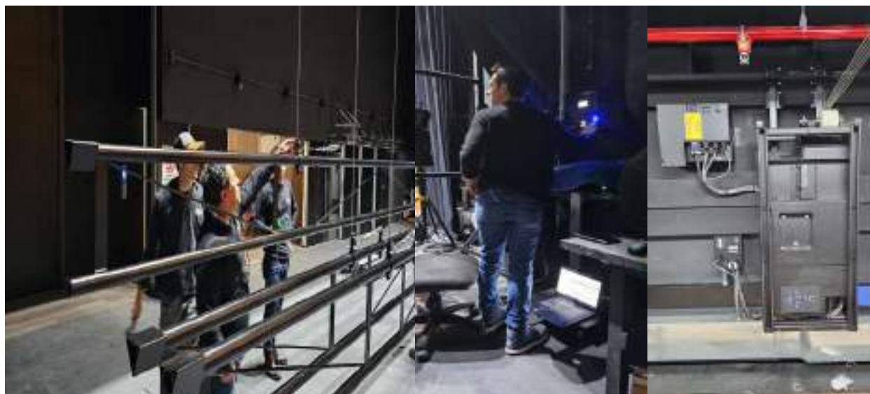
Imagen 5, 6 y 7. Instalación y pruebas ítem 1, calle motorizada.
