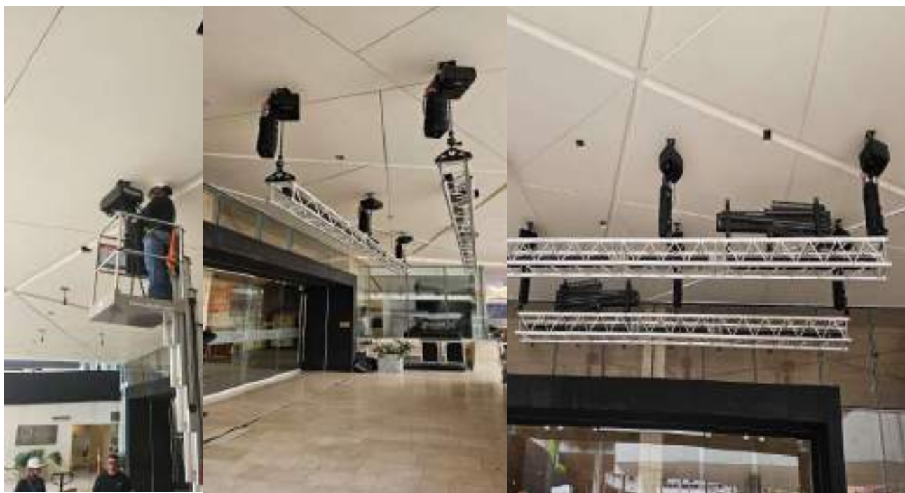
Imagen 18, 19, y 20. Instalación y prueba del ítem 8 truss motorizado
