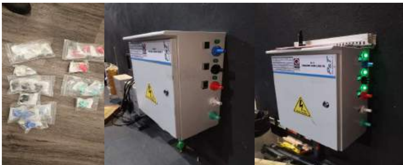
Imagen 13, 14 y 15. Entrega ítem 58 correspondiente a conectores cam-lock e instalación de los mismos.
