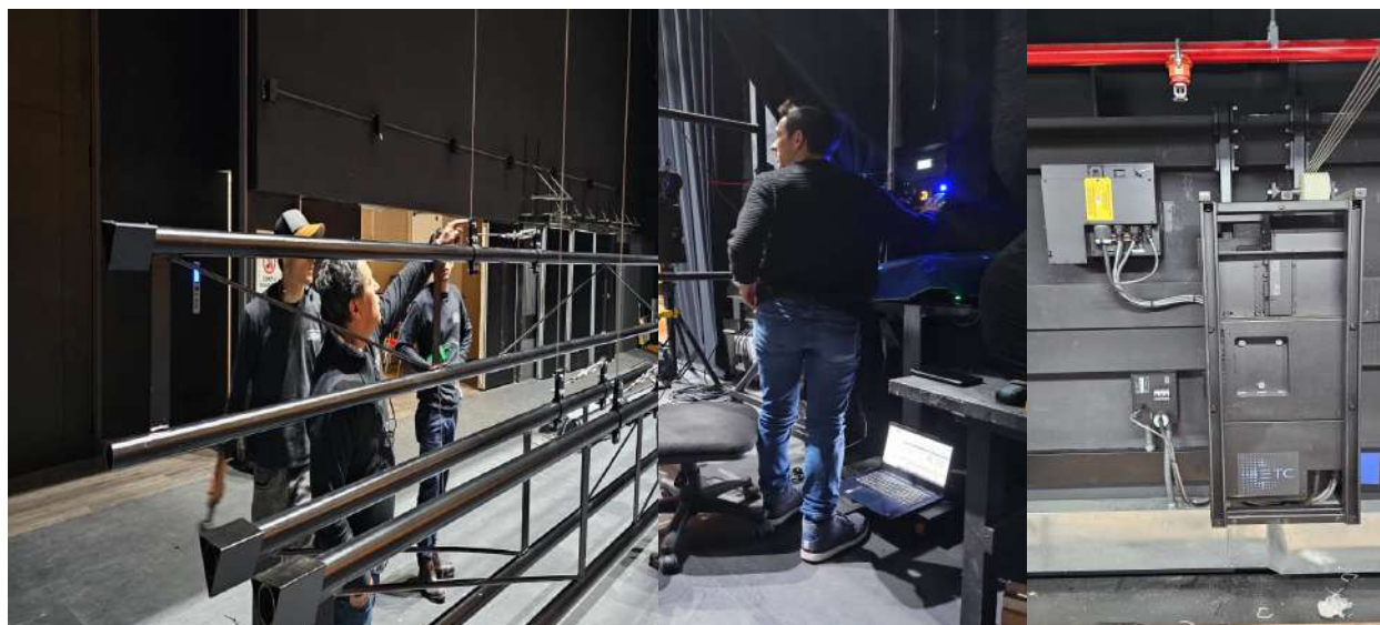
Imagen 5, 6 y 7. Instalación y pruebas ítem 1, calle motorizada.
