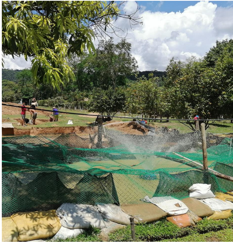
UP de AGORA en Villavicencio, proyecto de construcción de estanque piscícola para aprendizaje y autosostenimiento.
