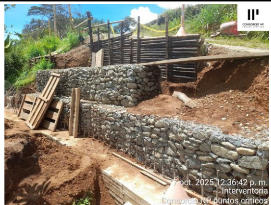
AVANCE CONSTRUCCIÓN DE MURO EN GAVIONES COSTADO IZQUIERDO
