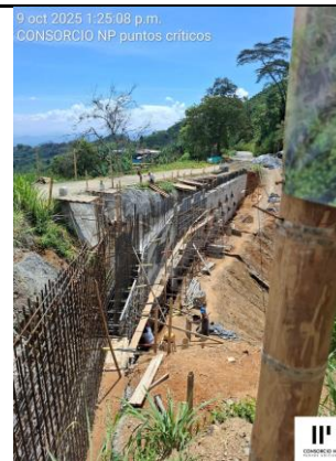
PANORÁMICA AVANCE DE LA PANTALLA EN CONCRETO COSTADO DERECHO
