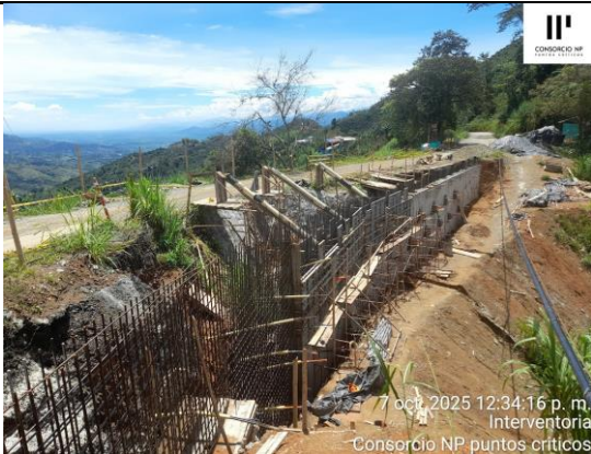
PANORÁMICA DE AVANCE FORMALETA Y VACIADO PANTALLA COSTADO DERECHO
