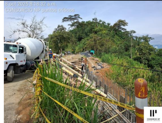
PANORÁMICA VACIADO TRAMO DE PANTALLA COSTADO DERECHO
