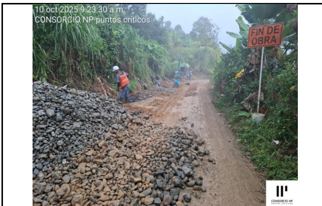
AVANCE ARMADO DE FILTRO FRANCÉS COSTADO DERECHO TRAMO DE VÍA QUE SERA PAVIMENTADA
