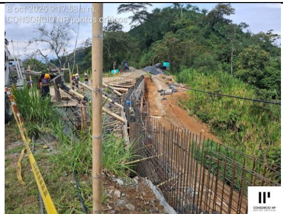
DETALLE AVANCE VACIADO TRAMO DE PANTALLA COSTADO DERECHO
