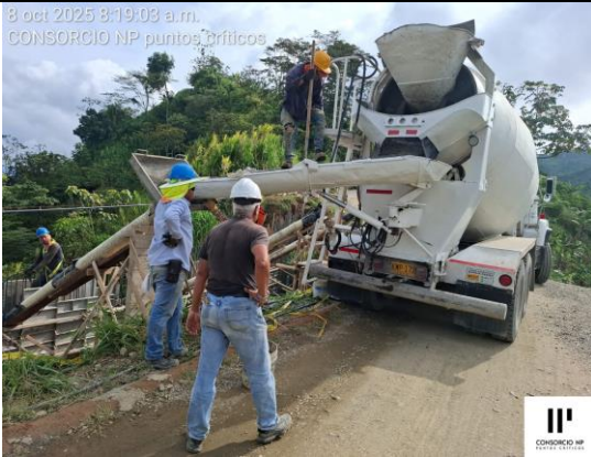
AVANCE VACIADO TRAMO DE PANTALLA COSTADO DERECHO
