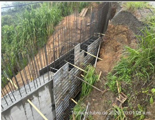
DETALLE AVANCE DE FORMALETA PANTALLA COSTADO DERECHO
