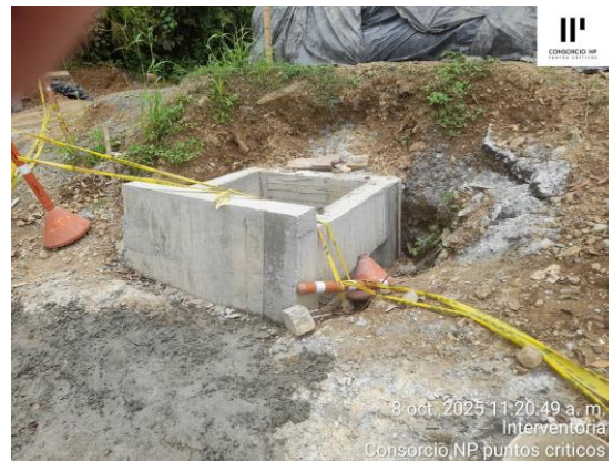
DETALLE ENTRADA POCETA SEGUNDA TRANSVERSAL DE 36"
