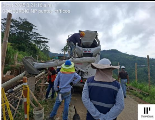
AVANCE VACIADO TRAMO DE PANTALLA COSTADO DERECHO
