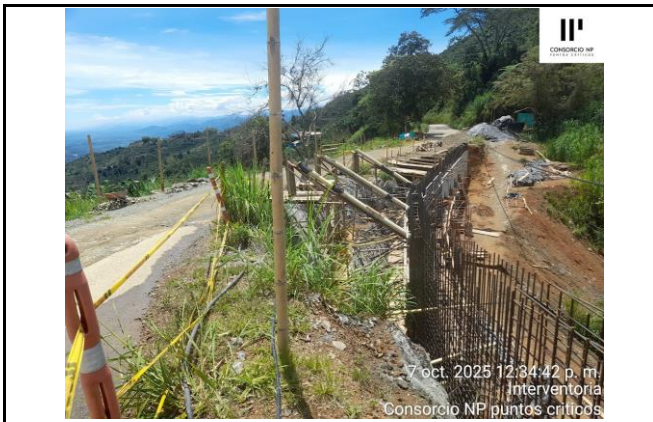
PANORÁMICA AVANCE DE OBRAS COSTADO DERECHO
