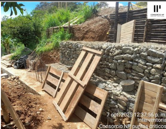
AVANCE CONSTRUCCIÓN DE MURO EN GAVIONES COSTADO IZQUIERDO
