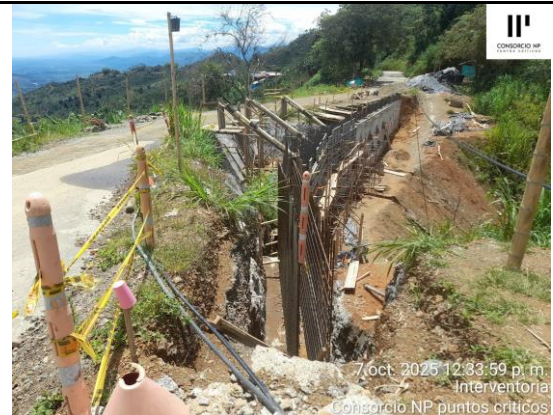
PANORÁMICA ENTABLE PARA VACIADO DE TRAMO DE PANTALLA COSTADO DERECHO
