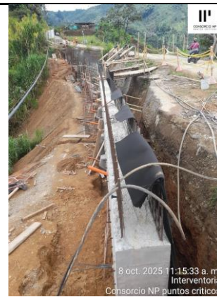
PANORÁMICA AVANCE OBRAS COSTADO DERECHO
