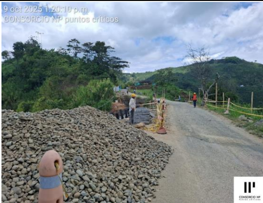
PANORÁMICA TRAMO DE VÍA EL CRUCERO ASÍA EN INTERVENCIÓN
