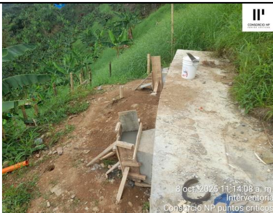
FORMALETEADO Y VACIADO COMPLEMENTO DE DATOS PARA TENSIONAMIENTO COSTADO IZQUIERDO
