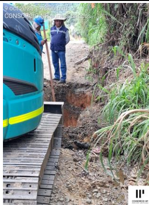
DETALLE INICIO EXCAVACIÓN PARA ARMADO DE FILTRO FRANCES COSTADO DERECHO TRAMO DE VÍA QUE SERA PAVIMENTADO
