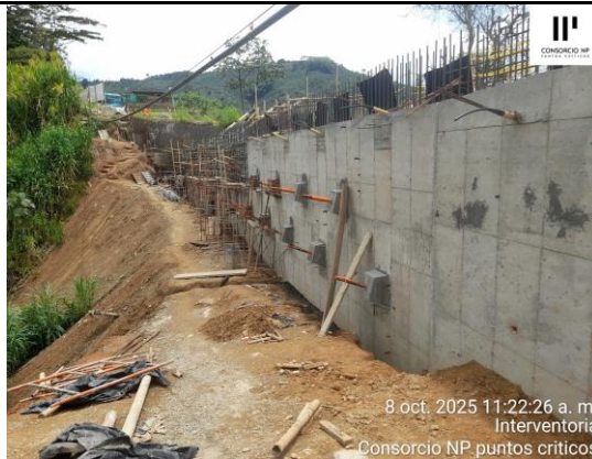
PANORÁMICA DADOS PARA ANCLAJE TERMINADOS COSTADO DERECHO
