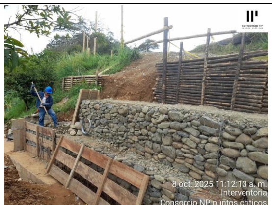
AVANCE CONSTRUCCIÓN MURO EN GAVIONES COSTADO IZQUIERDO
