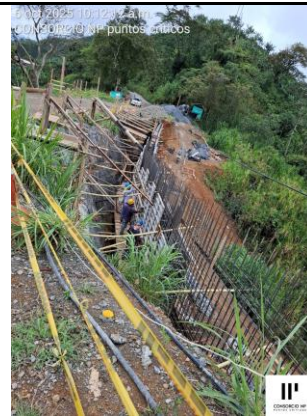
PANORÁMICA AVANCE PANTALLA ANCLADA COSTADO DERECHO
