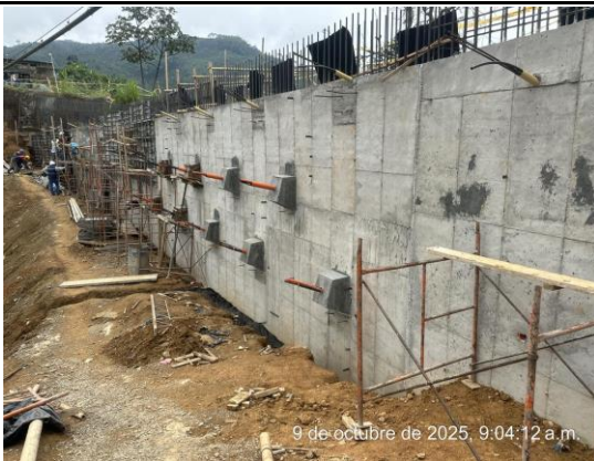
PANORÁMICA AVANCE DE LA PANTALLA EN CONCRETO COSTADO DERECHO
