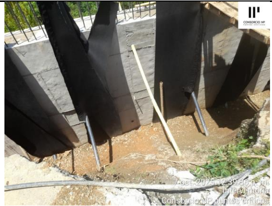
DETALLE AVANCE RELLENO COMPACTADO ESPALDÓN DE LA PANTALLA
