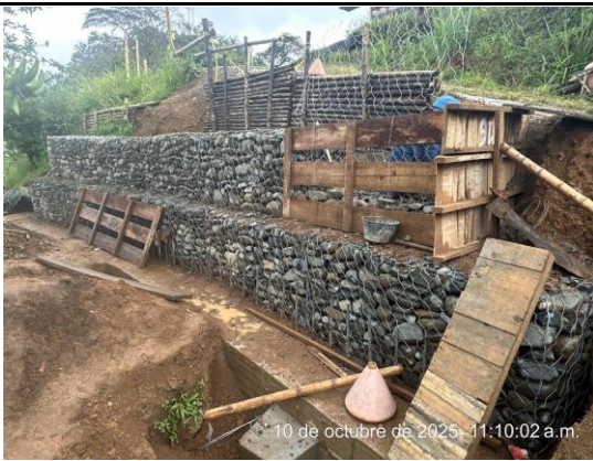
AVANCE CONSTRUCCIÓN MURO EN GAVIONES COSTADO IZQUIERDO
