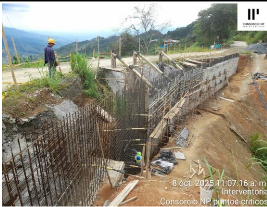
FINALIZACIÓN VACIADO TRAMO DE PANTALLA COSTADO DERECHO
