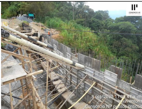
FINALIZACIÓN VACIADO Y ENRRACE DE CONCRETO TRAMO DE PANTALLA COSTADO DERECHO
