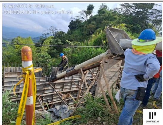
AVANCE VACIADO TRAMO DE PANTALLA COSTADO DERECHO
