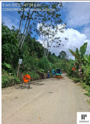
PANORÁMICA DEL INICIO DE EXCAVACIÓN PARA ARMADO DE FILTRO FRANCES COSTADO DERECHO TRAMO DE VÍA QUE SERA PAVIMENTADO
