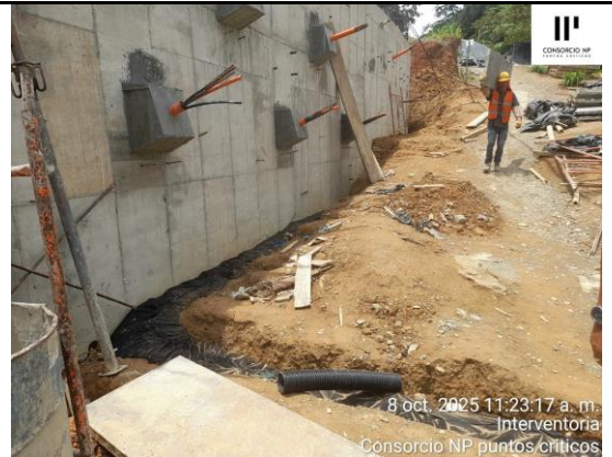
DETALLE DADOS PARA ANCLAJE TERMINADOS COSTADO DERECHO
