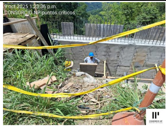
DESENCOFRADO ÚLTIMO TRAMO DE PANTALLA VACIADO
