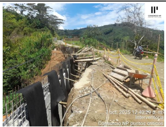
PANORÁMICA AVANCE DE OBRAS COSTADO DERECHO
