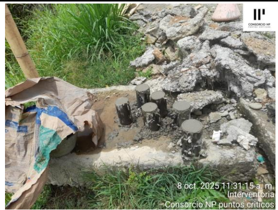
MUESTRAS DE CONCRETO PARA ENSAYO DE COMPRESIÓN
