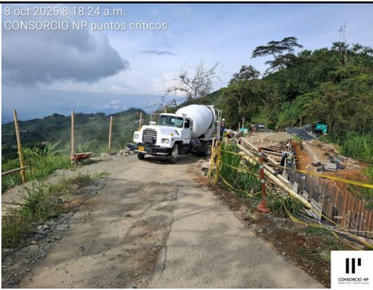
INICIO VACIADO TRAMO DE PANTALLA COSTADO DERECHO
