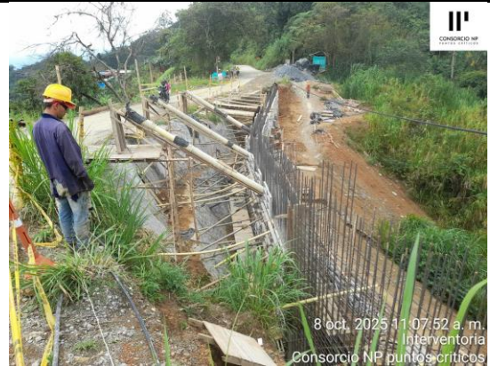
FINALIZACIÓN VACIADO TRAMO DE PANTALLA COSTADO DERECHO
