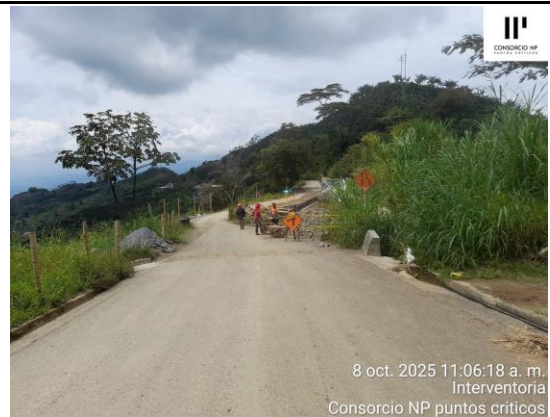
PANORÁMICA TRAMO DE VÍA EL CRUCERO ASIA EN INTERVENCIÓN
