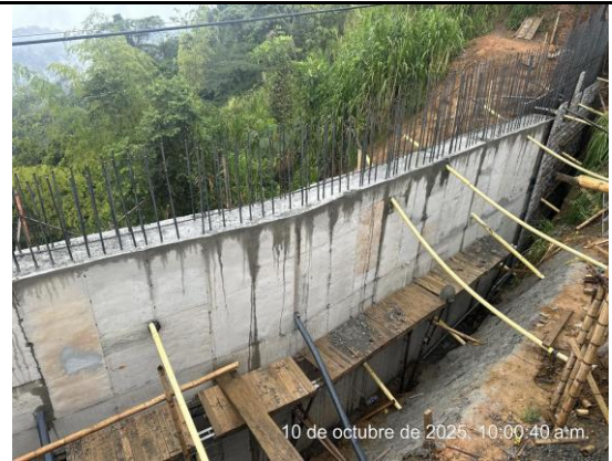
DETALLE ACABADO DE PANTALLA EN CONCRETO COSTADO DERECHO
