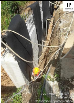
AVANCE RELLENO COMPACTADO ESPALDÓN DE LA PANTALLA
