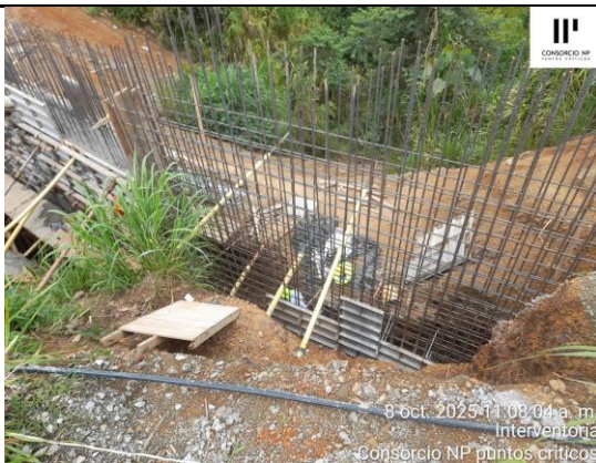
INICIO FORMALETEADO SIGUIENTE TRAMO DE PANTALLA COSTADO DERECHO
