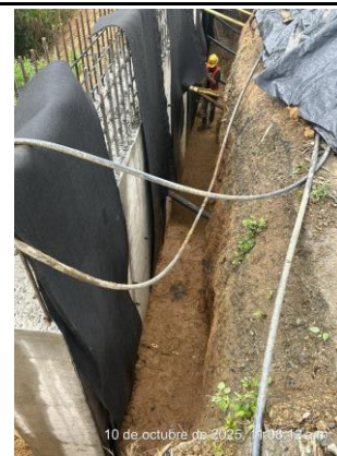
AVANCE RELLENOS COMPACTADOS ESPALDÓN DEL MURO COSTADO DERECHO
