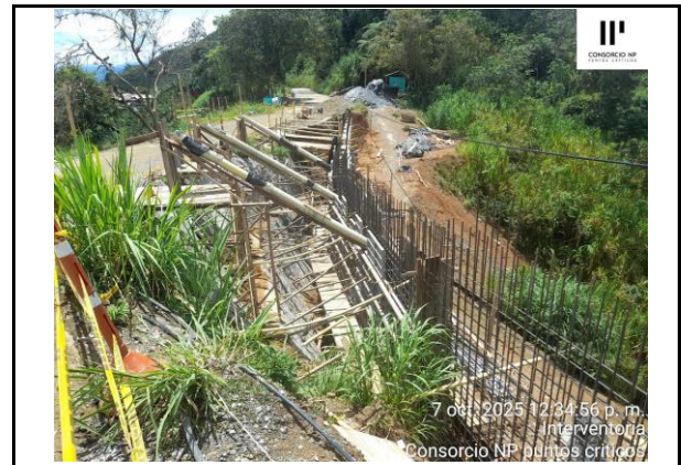
ENTABLE PARA VACIADO DE TRAMO DE PANTALLA COSTADO DERECHO
