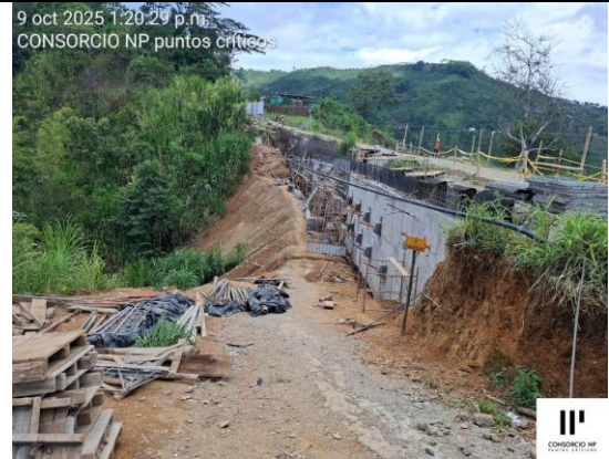
PANORÁMICA AVANCE DE LA PANTALLA EN CONCRETO COSTADO DERECHO
