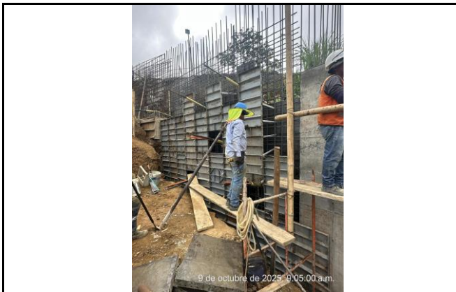
DETALLE AVANCE FORMATEADO SIGUIENTE TRAMO DE PANTALLA COSTADO DERECHO
