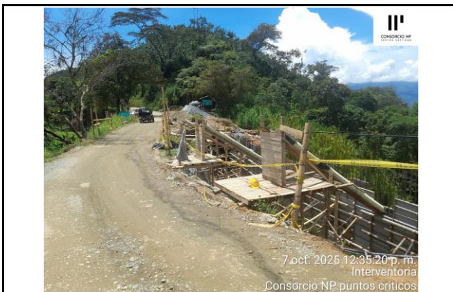
PANORÁMICA ENTABLE PARA VACIADO DE TRAMO DE PANTALLA COSTADO DERECHO
