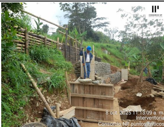
AVANCE CONSTRUCCIÓN MURO EN GAVIONES COSTADO IZQUIERDO
