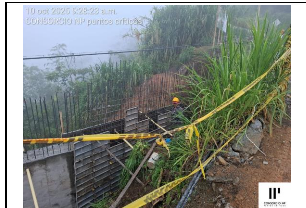
AVANCE FORMATEADO SIGUIENTE TRAMO DE PANTALLA COSTADO DERECHO
