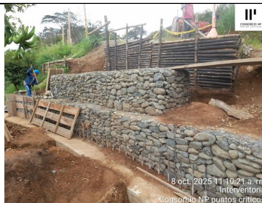
AVANCE CONSTRUCCIÓN MURO EN GAVIONES COSTADO IZQUIERDO
