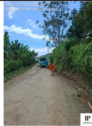
INICIO EXCAVACIÓN PARA ARMADO DE FILTRO FRANCES COSTADO DERECHO TRAMO DE VÍA QUE SERA PAVIMENTADO
