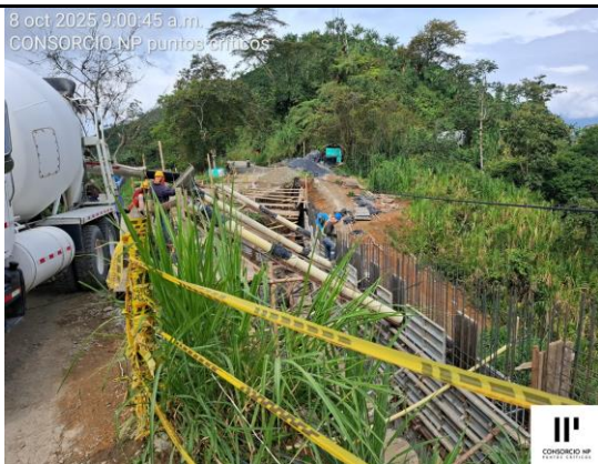
AVANCE VACIADO TRAMO DE PANTALLA COSTADO DERECHO
