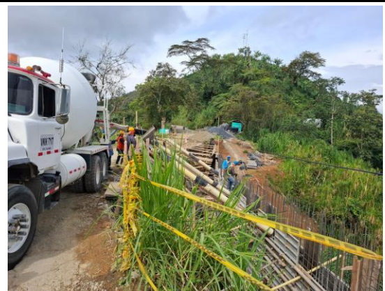
AVANCE VACIADO TRAMO DE PANTALLA COSTADO DERECHO
