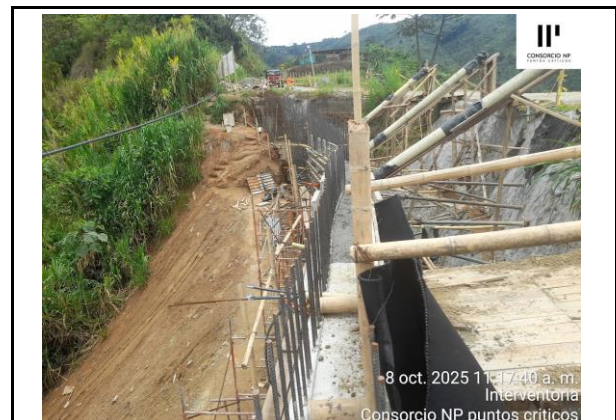
PANORÁMICA COSTADO DERECHO DONDE SE PUEDE APRECIAR EL ESPESOR DE LA PANTALLA
