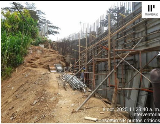
DETALLE FORMALETA Y ATRAQUE PARA VACIADO TRAMO DE PANTALLA COSTADO DERECHO
