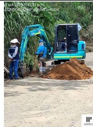
AVANCE EXCAVACIÓN PARA ARMADO DE FILTRO FRANCES COSTADO DERECHO TRAMO DE VÍA QUE SERA PAVIMENTADO
