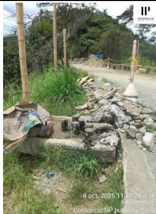
MUESTRAS DE CONCRETO PARA ENSAYO DE COMPRESIÓN
