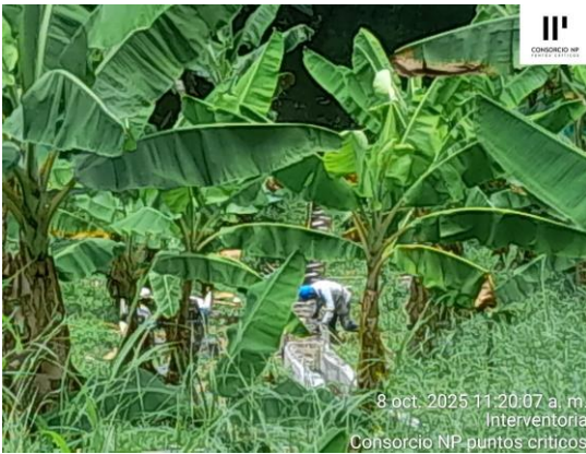
AVANCE VACIADO CANAL CON PANTALLAS DEFLECTORAS COSTADO IZQUIERDO
