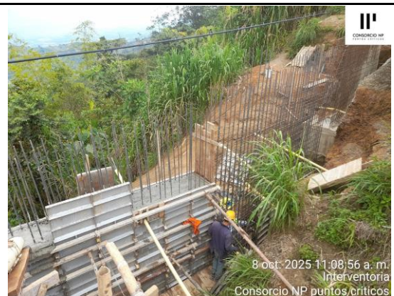
FINALIZACIÓN VACIADO Y ENRRACE DE CONCRETO TRAMO DE PANTALLA COSTADO DERECHO
