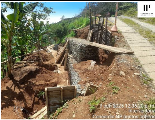
AVANCE CONSTRUCCIÓN DE MURO EN GAVIONES COSTADO IZQUIERDO
