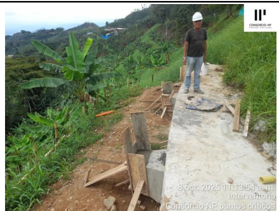
FORMALETEADO Y VACIADO COMPLEMENTO DE DATOS PARA TENSIONAMIENTO COSTADO IZQUIERDO
