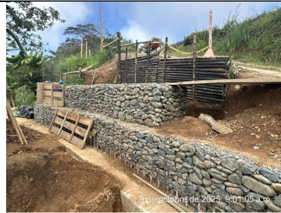
AVANCE CONSTRUCCIÓN MURO EN GAVIONES COSTADO IZQUIERDO
