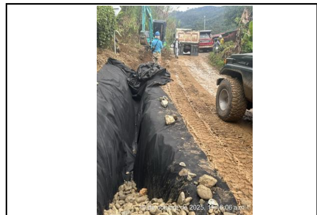
AVANCE ARMADO DE FILTRO FRANCÉS COSTADO DERECHO TRAMO DE VÍA QUE SERA PAVIMENTADA
