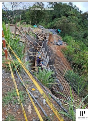
PANORÁMICA AVANCE PANTALLA ANCLADA COSTADO DERECHO
