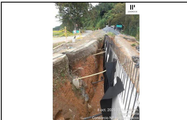
AVANCE RELLENO COMPACTADO ESPALDON DE PANTALLA COSTADO DERECHO
