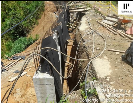
PANORÁMICA AVANCE RELLENO COMPACTADO ESPALDÓN DE LA PANTALLA
