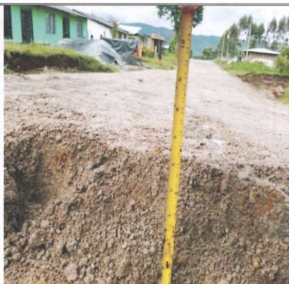
Foto No. 7. Altura de la Subbase Granular
