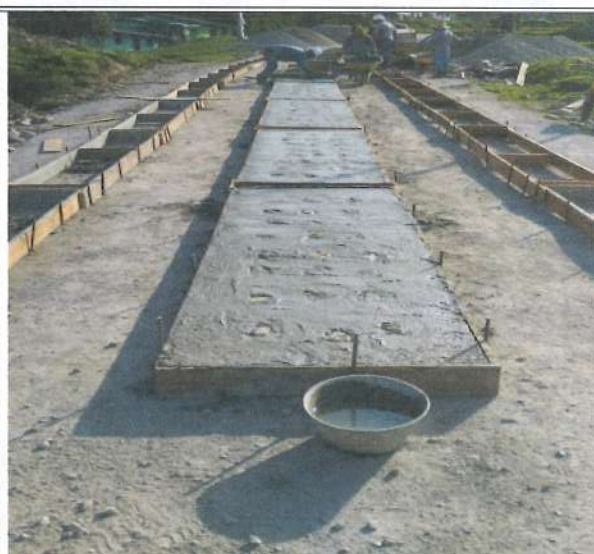
Foto No. 8. Suministro e instalación de concreto ciclopeo.
