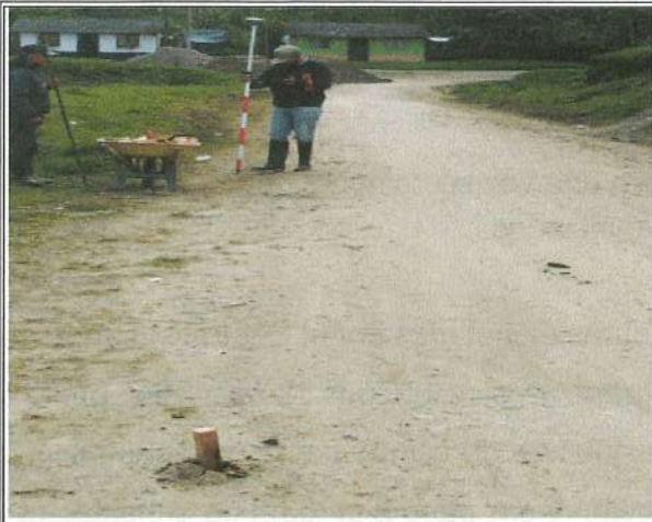
Foto No. 1. Localización, trazado y replanteo
