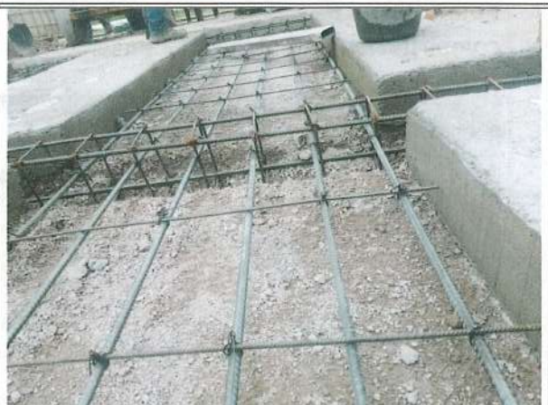
Foto No. 12. Corte, figurado, amarre e instalación de acero
