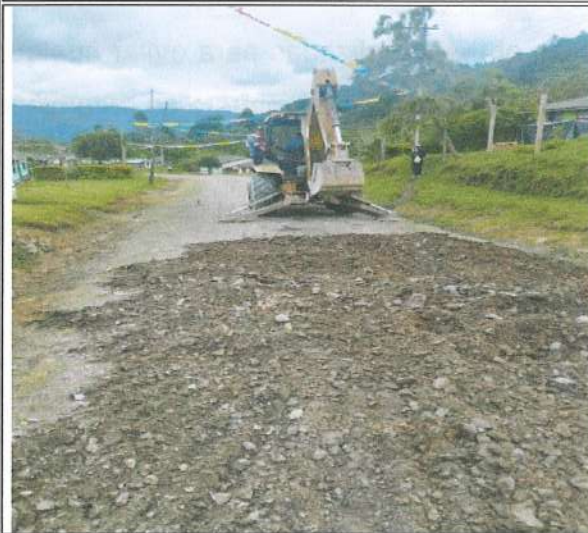
Foto No. 3. Excavación mecánica (cortes).
