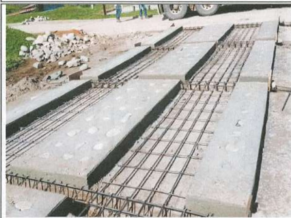
Foto No. 11. Corte, figurado, amarre e instalación de acero
