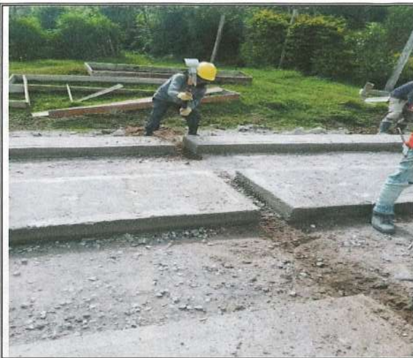
Foto No. 9. Excavación manual
