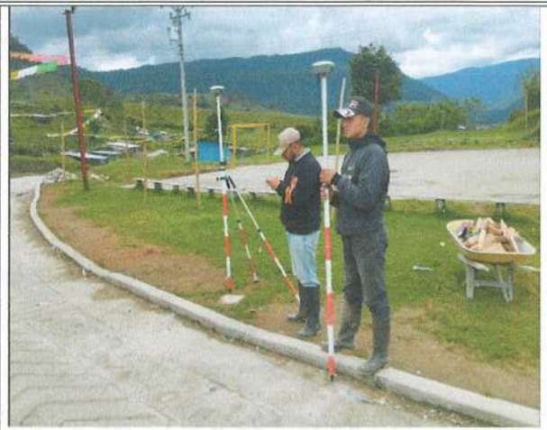
Foto No. 2. Localización, trazado y replanteo
