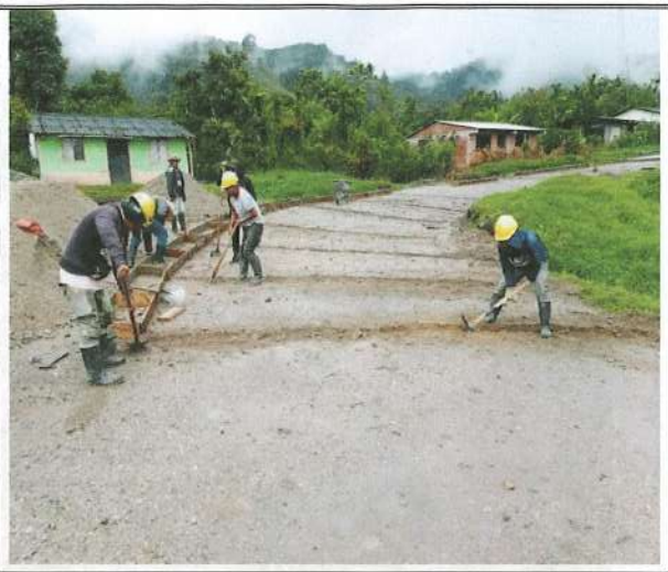
Foto No. 10. Excavación manual
