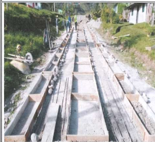
Foto No. 7. Instalación de formaletas.
