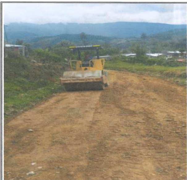
Foto No. 6. Suministro, extendida y compactación de Subbase Granular
