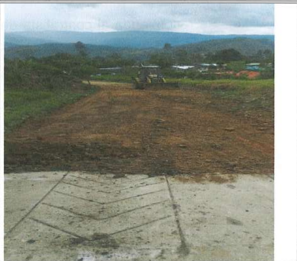
Foto No. 5. Suministro y compactación de subbase granular
