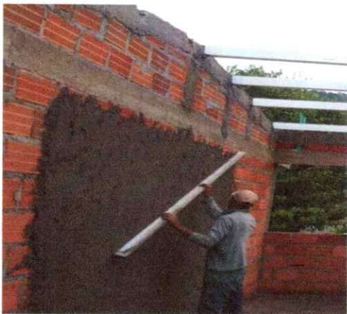
Pañete muros 1:4 ( incluye filos y ditalaciones)
