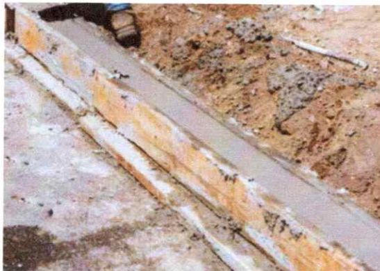
Bordillo fundido en sitio 10*15 3000 PSI ( Incluye acero )
