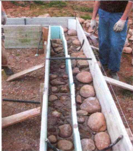
concreto ciclopedo para cimentación
