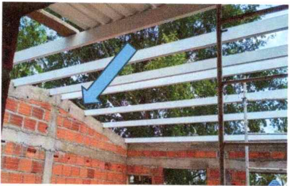
Viga cinta concreto 3.000 PSI estructura 0.25*0.10m
