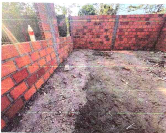
Relleno con material competente seleccionado
