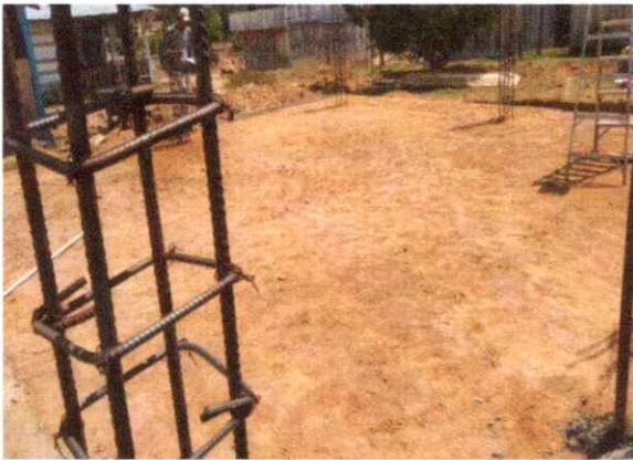
Relleno con material competente seleccionado
