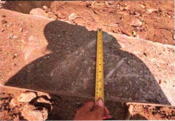
viga cimentación 3.000 PSI 0.30*0.20m
