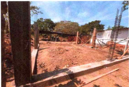
Zapatas concreto de 210 kg/cm3 (3.000 psi)
