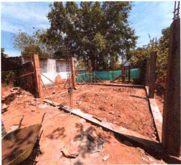
viga cimentación 3.000 PSI 0.30*0.20m
