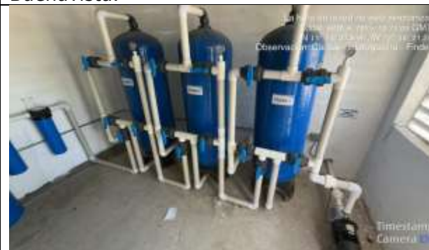
Fotografía 3. Sistema de potabilización de agua en la comunidad de Cactus
