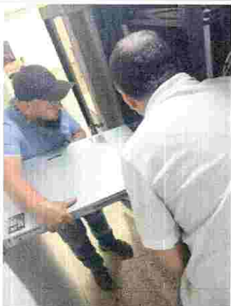
Inatalacion de servidores tipo rack
