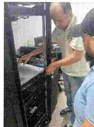
Desmonte de servidores en gabinete
