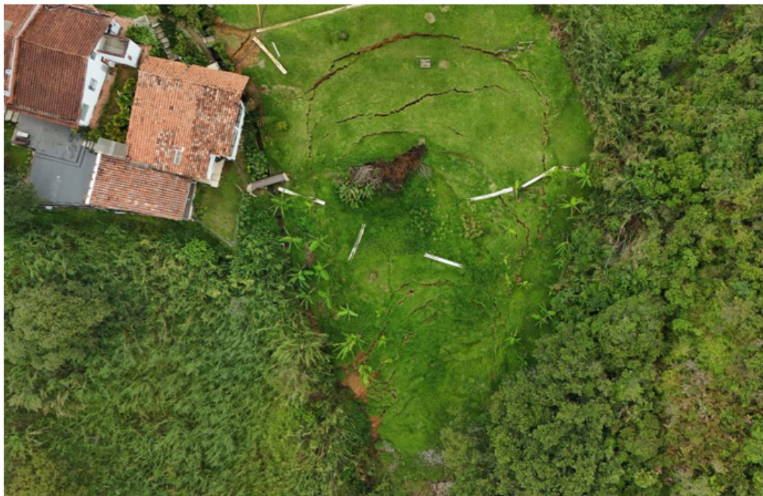
Ilustración 18. Movimiento en masa en la base del talud.
