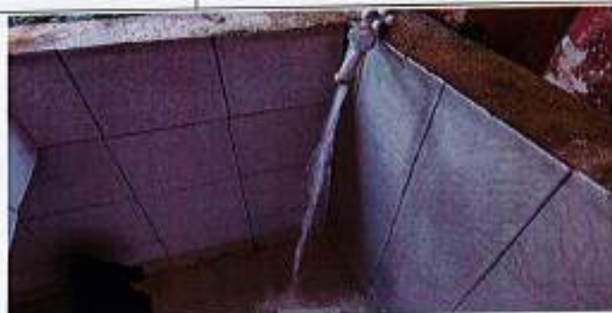
Fotografía No. 03 Abastecimiento de agua
