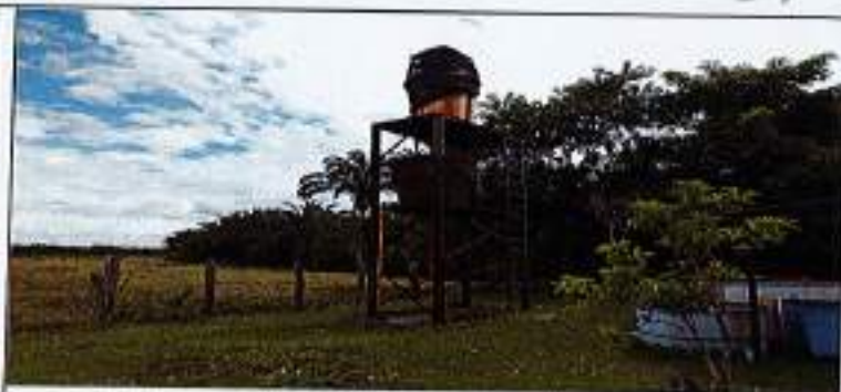
Fotografía No. 06 Abastecimiento de agua
