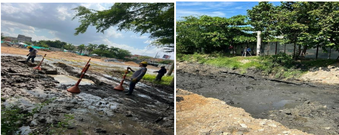
Ilustración 43. Señalización de excavación para retiro de agua
