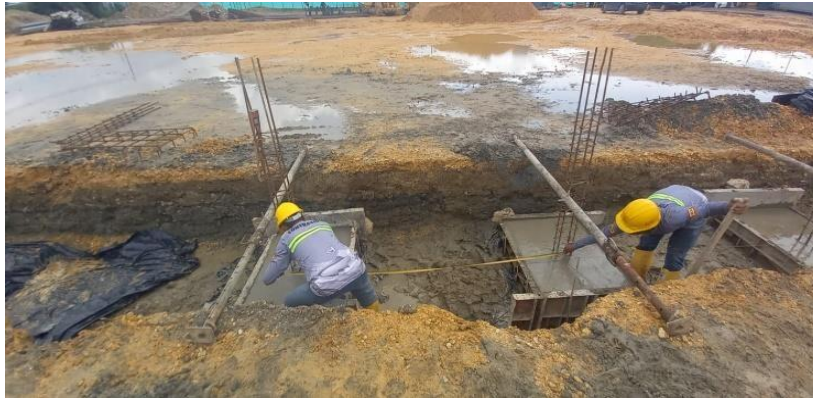
Ilustración 25. Fundida de concreto zapatas cerramiento
