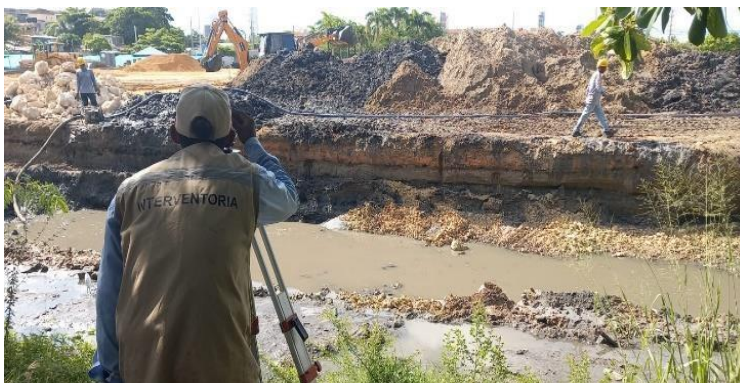
Ilustración 11. Localización y replanteo box coulvert
