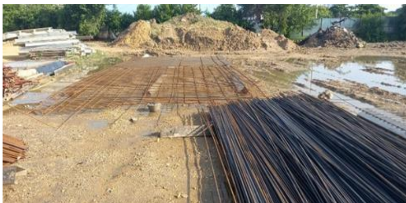
Ilustración 21. Figurado acero Box couvert
