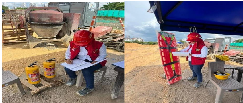
Ilustración 41 Inspección de extintores y camillas
