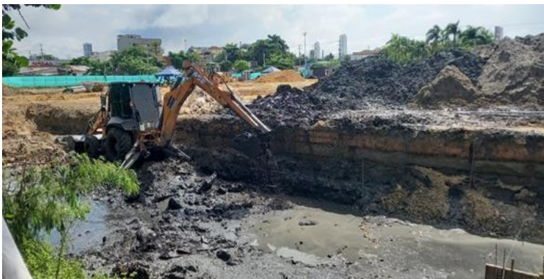
Ilustración 20. Excavación Box coulvert perimetral
