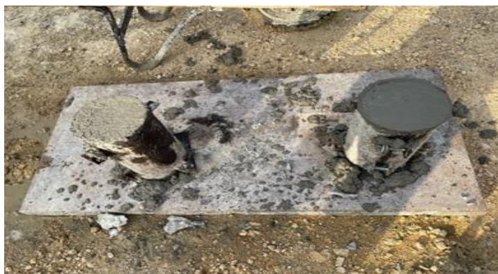
Ilustración 33. Toma de muestras concreto de zapatas.
