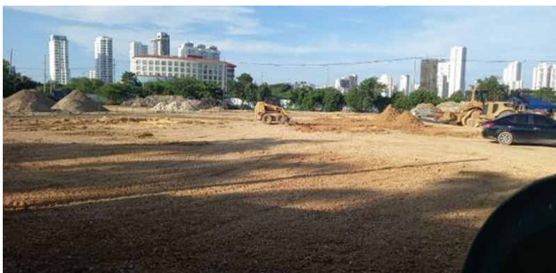
Ilustración 15. Relleno material seleccionado cancha futbol 11
