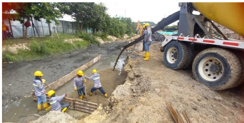
Ilustración 28. Fundida concreto ciclópeo box couvert
