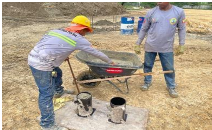
Ilustración 34. Toma de muestras concreto de vigas cimentación.
