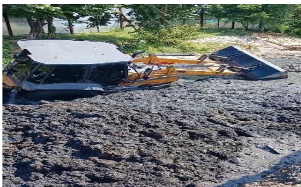
Ilustración 44 Cambio de maquina en excavación de canal
