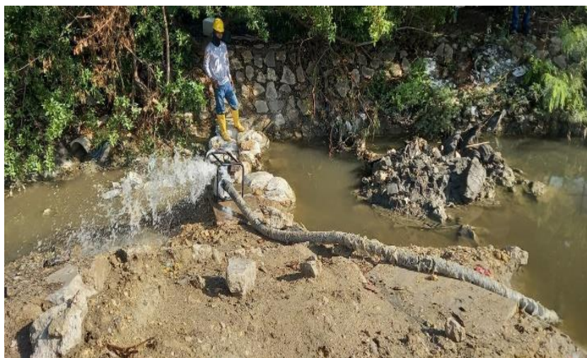
Ilustración 31. Manejo de aguas canal existente
