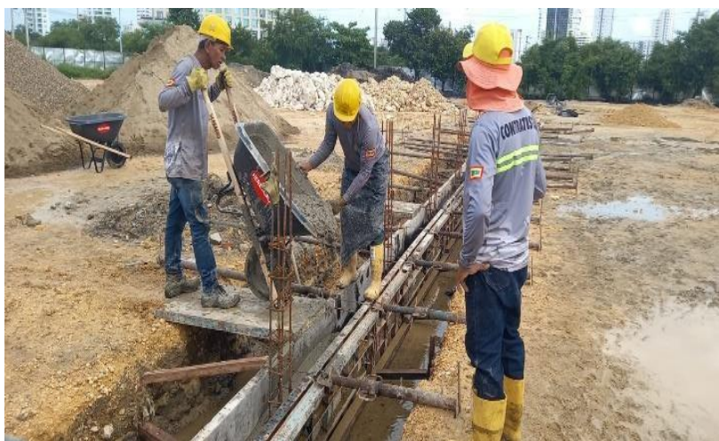
Ilustración 24. Fundida de concreto vigas, columnetas cerramiento
