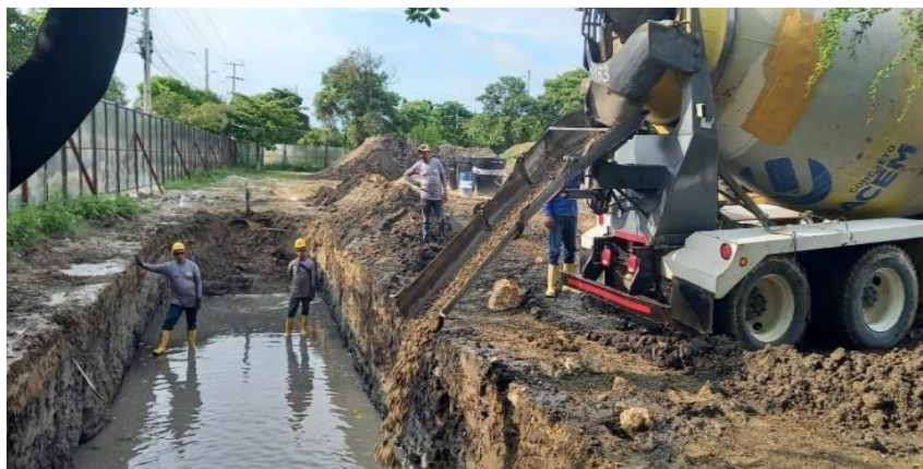
Ilustración 29. Fundida concreto ciclópeo canal perimetral
