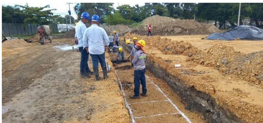
Ilustración 12. Trazado y replanteo zapatas muro de cerramiento cancha fútbol 11
