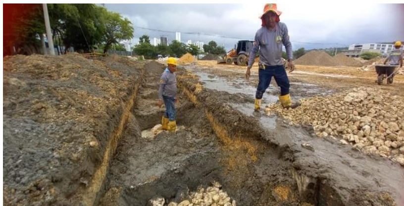
Ilustración 26. Concreto ciclópeo cimentación muro de cerramiento
