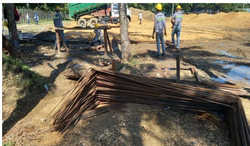
Ilustración 22. Figurado acero canal perimetral
