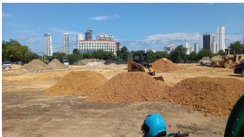
Ilustración 16. Relleno material seleccionado cancha futbol 11
