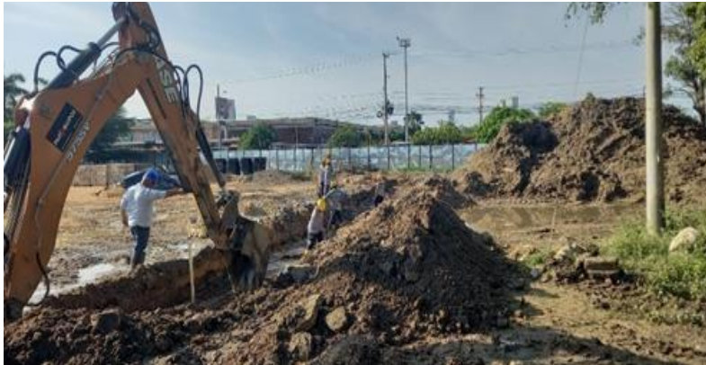
Ilustración 19. Excavación Cerramiento perimetral
