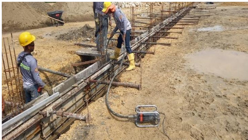
Ilustración 23. Acero refuerzo vigas, columnetas cerramiento
