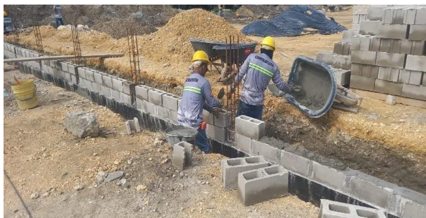
Ilustración 32. Levante en block No 6.
