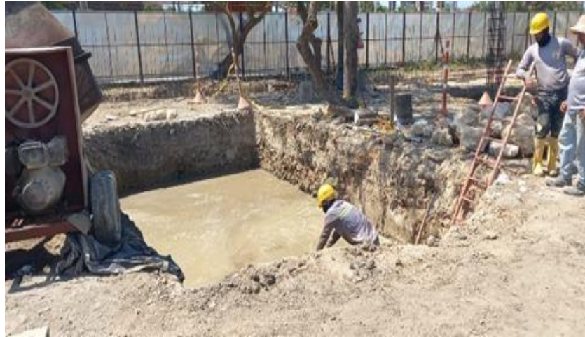
Ilustración 34. Fundida concreto ciclópeo zapata entrada principal
