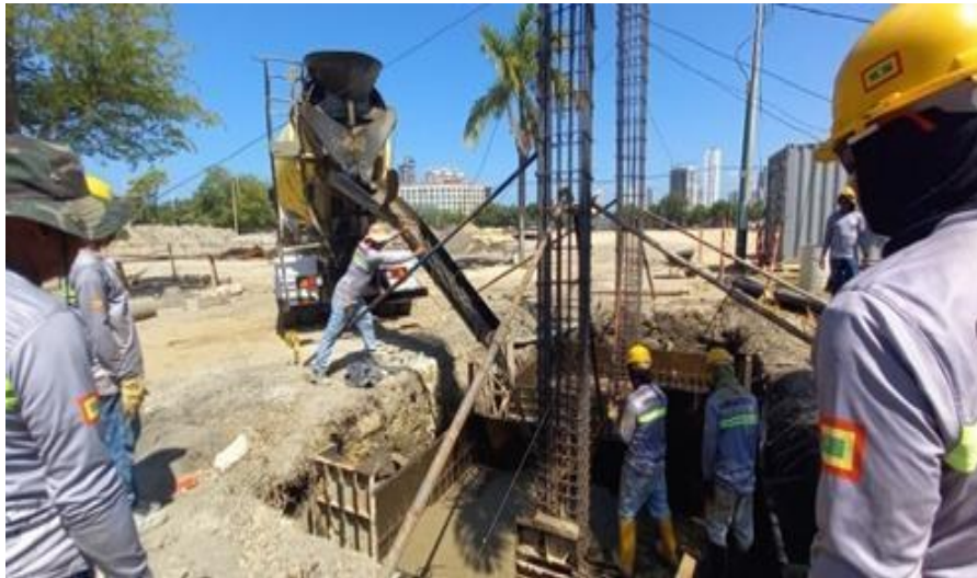
Ilustración 39 Fundida concreto 4000 psi zapatas entrada principal
