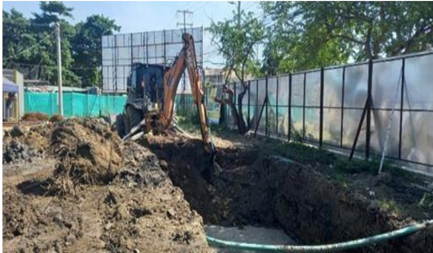
Ilustración 22. Excavación Canal perimetral
