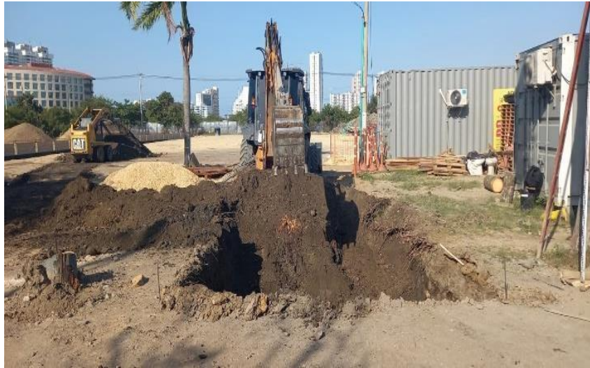
Ilustración 24. Excavación zapata entrada principal
