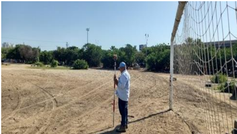
Ilustración 11. Localización y replanteo cancha de futbol
