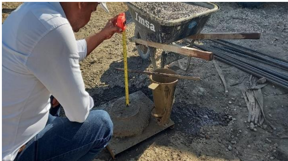
Ilustración 49. Prueba de Slump concreto muro canal perimetral.
