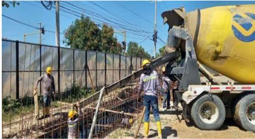
Ilustración 36. Fundida concreto 4000 psi muro canal perimetral
