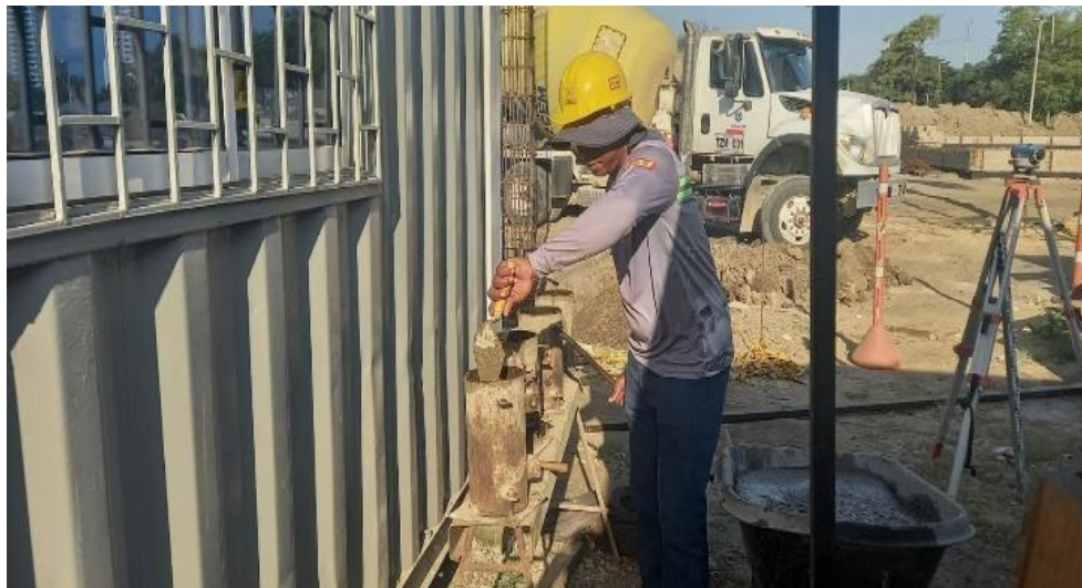
Ilustración 47. Toma de muestras concreto de zapatas entrada principal.
