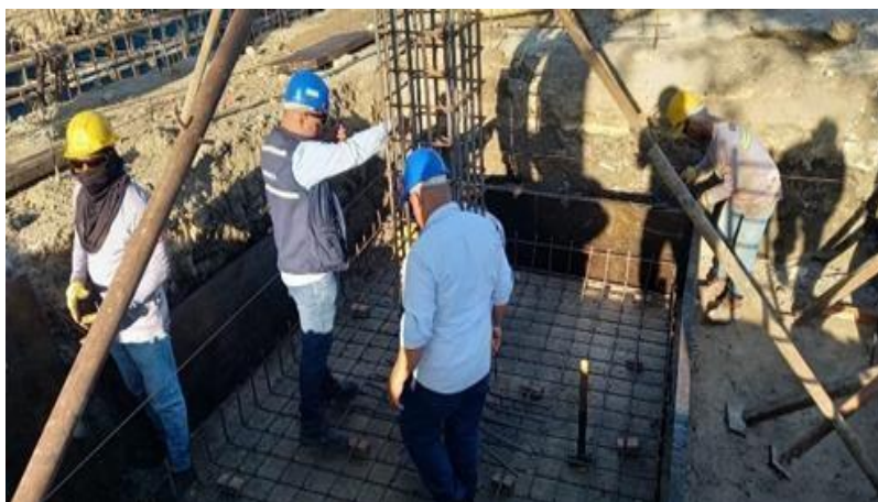
Ilustración 18. Localización y replanteo entrada principal
