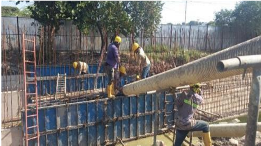
Ilustración 38. Fundida concreto 4000 psi muros box coulvert
