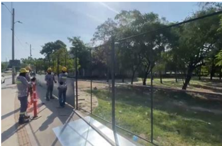
Ilustración 15. Instalación de lámina de zinc cerramiento perimetral
