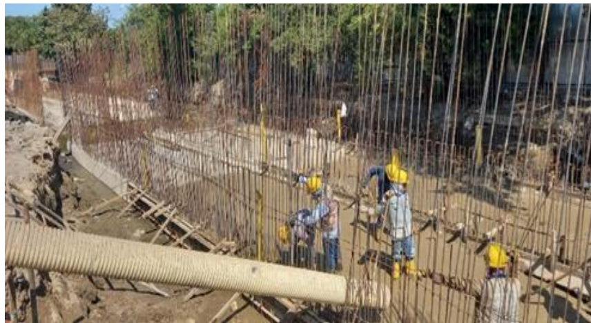
Ilustración 37. Fundida concreto 4000 psi fondo box coulvert
