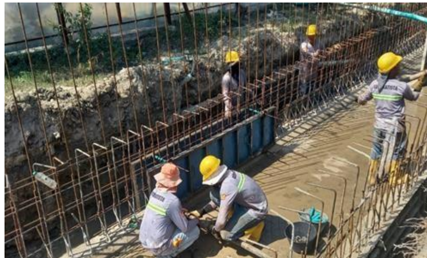
Ilustración 27. Figurado acero canal perimetral
