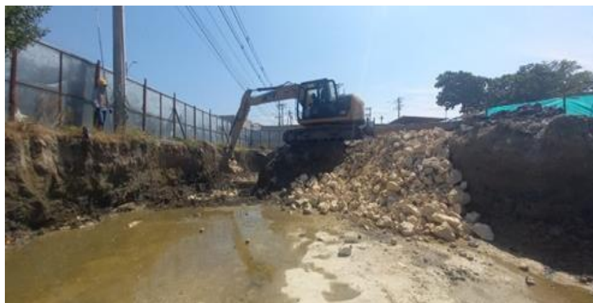
Ilustración 31. Fundida concreto ciclópeo box coulvert
