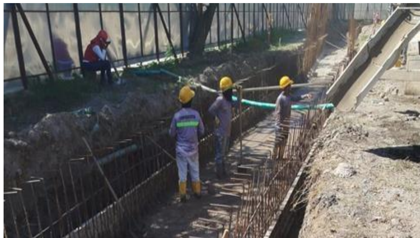
Ilustración 35. Fundida concreto 4000 psi fondo canal perimetral
