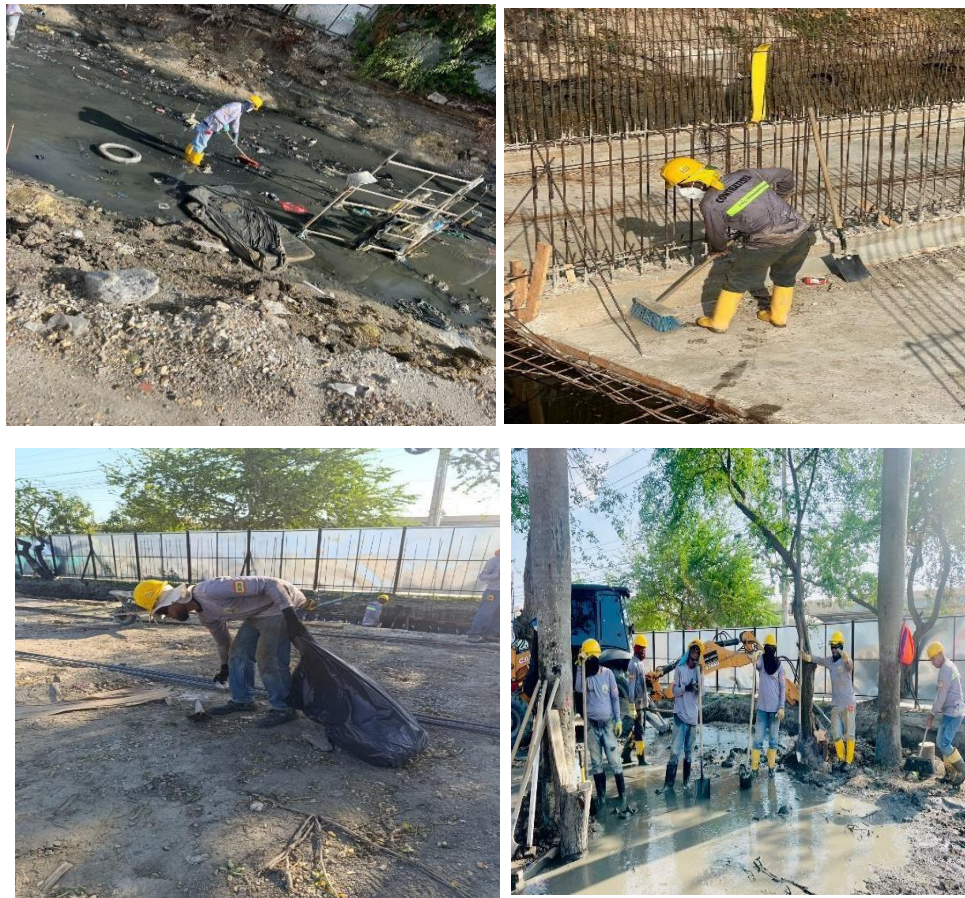
Ilustración 72. Limpieza áreas de trabajo
