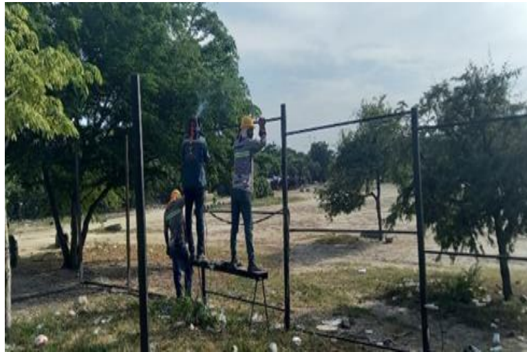
Ilustración 14. Instalación de estructura de cerramiento perimetral
