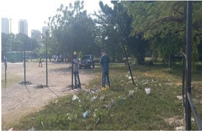
Ilustración 13. Instalación de estructura de cerramiento perimetral
