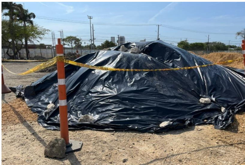
Ilustración 51. Protección de materiales con plástico negro
