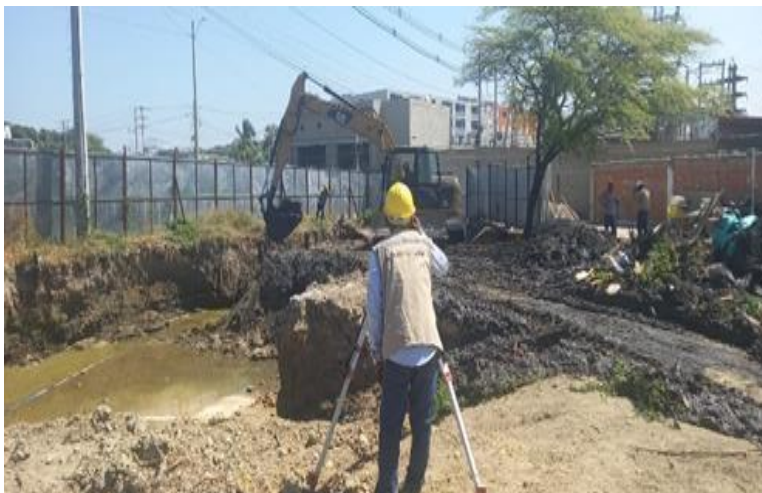
Ilustración 17. Localización y replanteo canal principal
