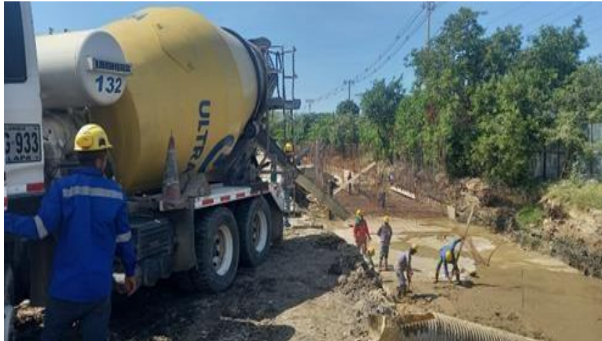
Ilustración 32. Fundida concreto ciclópeo box coulvert
