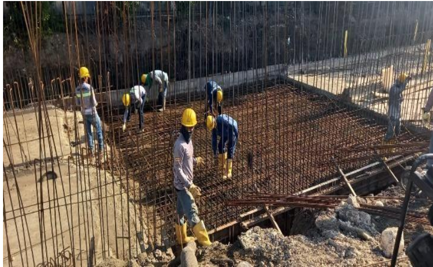
Ilustración 26. Figurado acero Box coulvert
