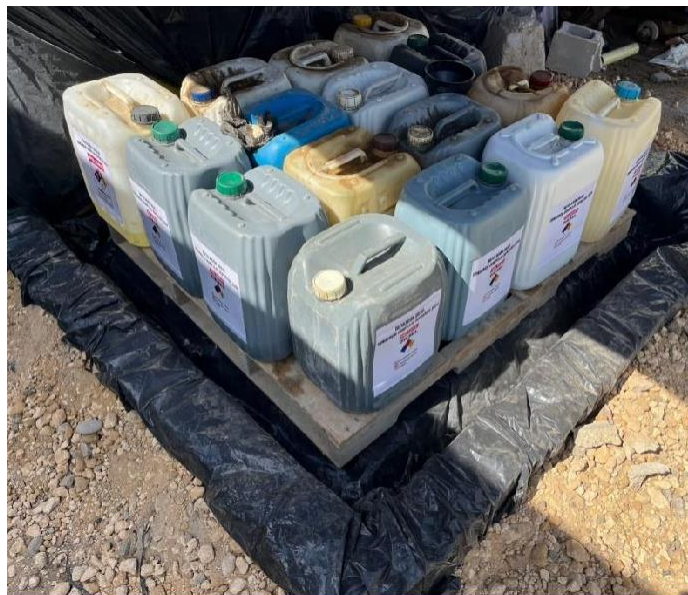
Ilustración 53. Almacenamiento de sustancias peligrosas.
