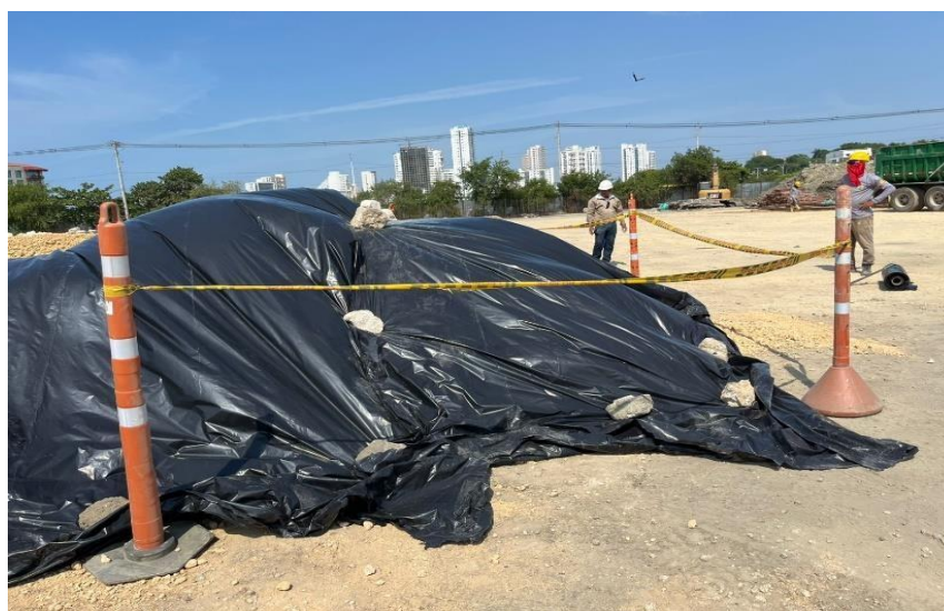
Ilustración 52 Protección de materiales con plástico negro.
