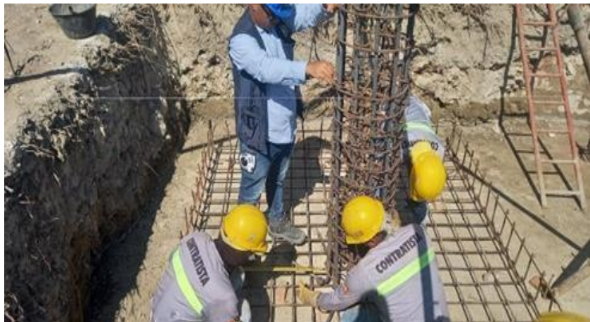
Ilustración 29. Acero refuerzo zapatas entrada principal
