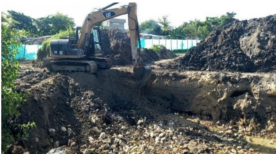
Ilustración 23. Excavación Box coulvert
