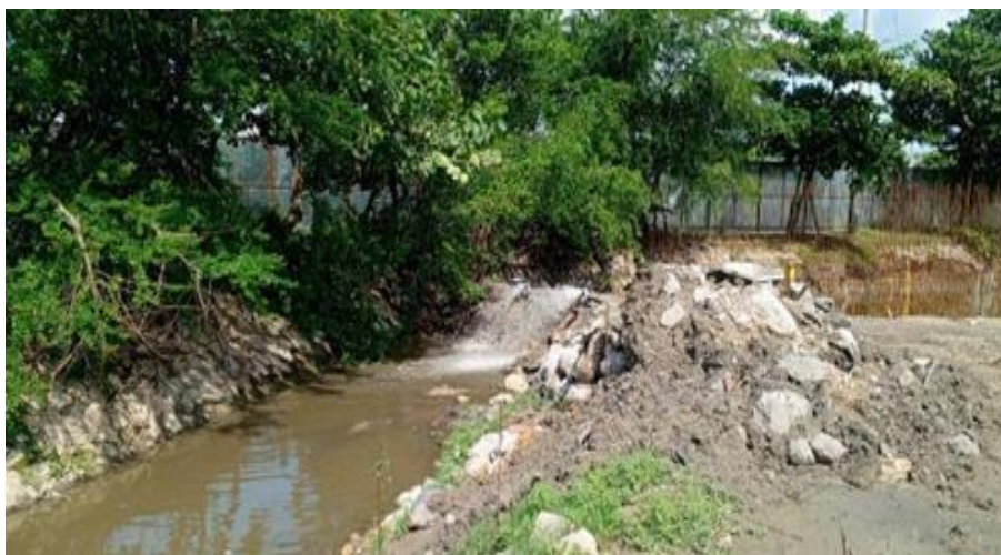
Ilustración 41. Manejo de aguas canal existente
