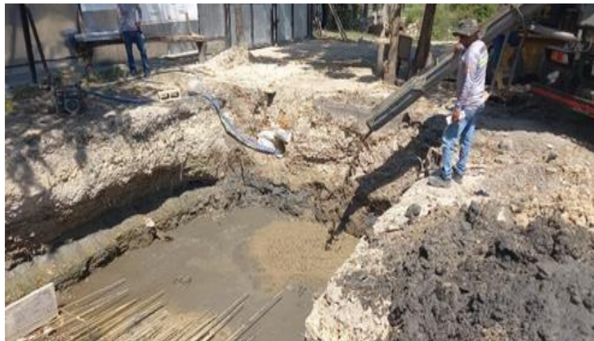
Ilustración 33. Fundida concreto ciclópeo canal perimetral
