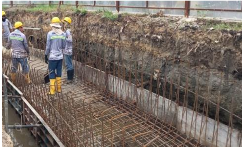
Ilustración 28. Figurado acero canal perimetral
