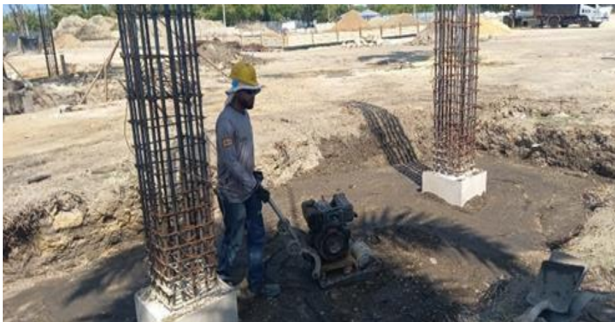
Ilustración 30. Acero refuerzo vigas confinamiento cerramiento
