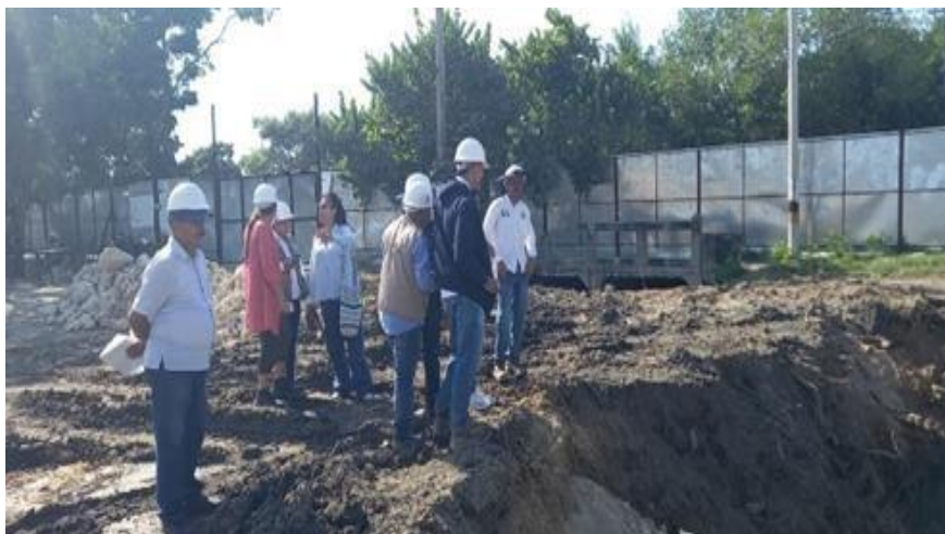
Ilustración 45. Recorrido con funcionarios de Cemarcaribe
