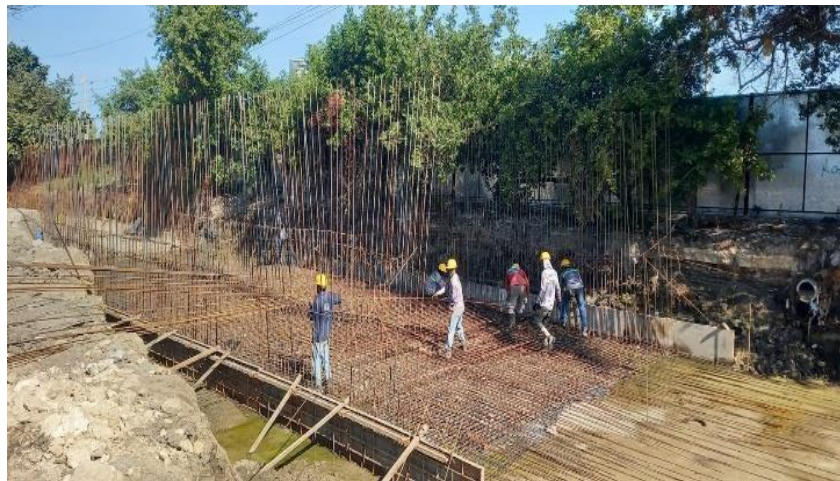
Ilustración 25. Figurado acero Box coulvert
