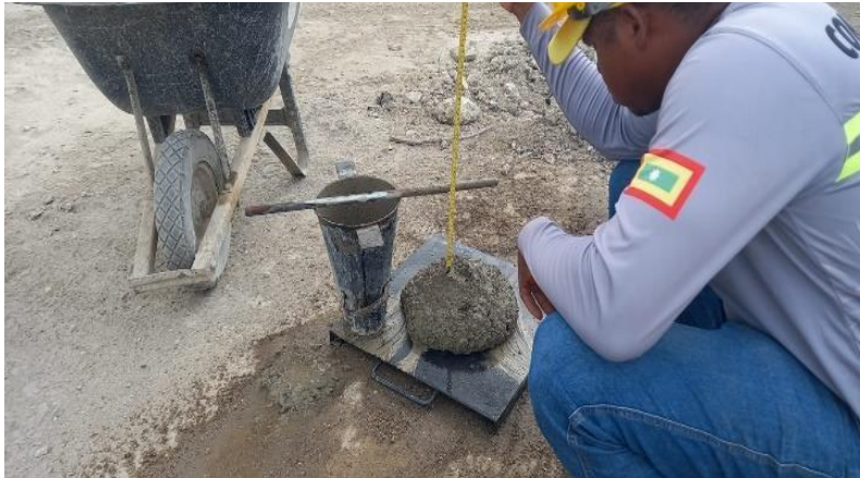
Ilustración 66. Prueba de Slump concreto placa superior canal perimetral.
