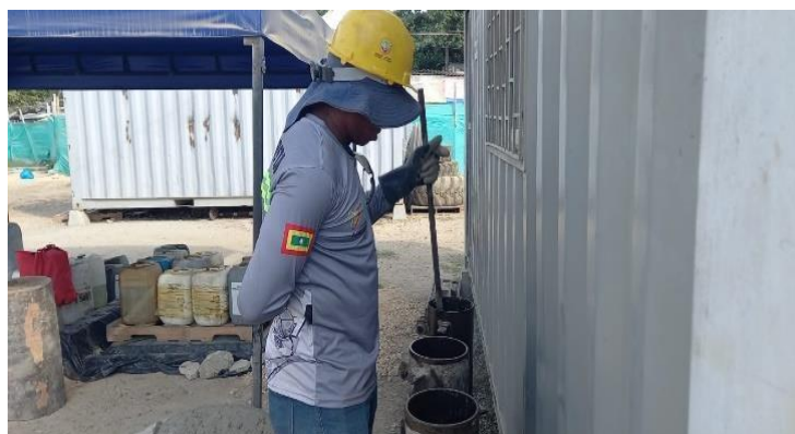
Ilustración 65. Toma de muestras concreto placa 2do nivel acceso No 2 canal perimetral.
