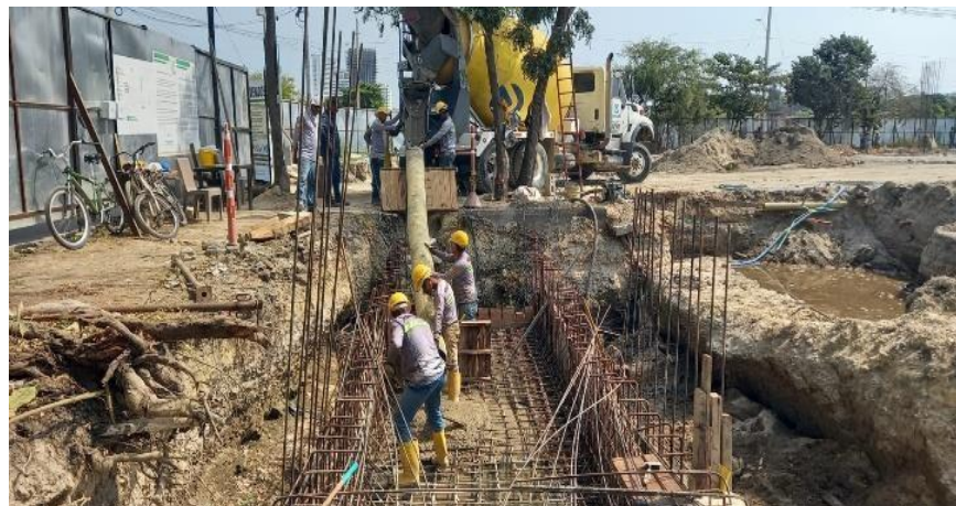
Ilustración 46. Fundida concreto 4000 psi placa fondo canal perimetral
