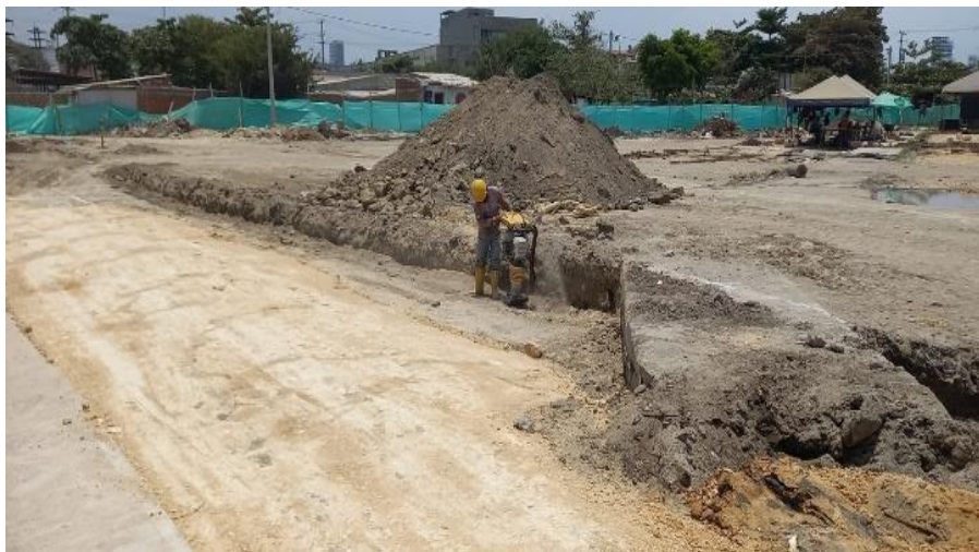
Ilustración 25. Relleno y compactación zona de parqueaderos y cerramiento
