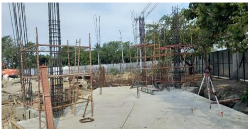
Ilustración 38. Acero refuerzo columnas acceso No 2 canal principal
