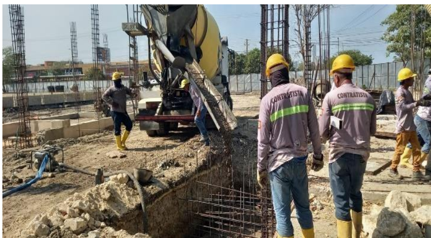
Ilustración 56. Fundida concreto 4000 psi zapatas acceso No 2 canal perimetral
