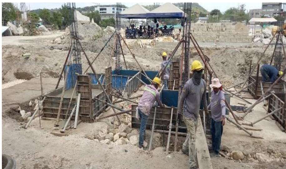
Ilustración 57. Fundida concreto 4000 psi zapatas baterías de baño modulo 2
