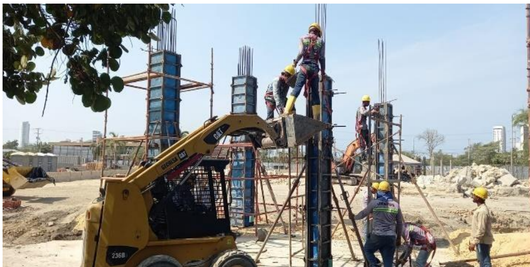
Ilustración 59. Fundida concreto 4000 psi columnas acceso No 2 box coulvert
