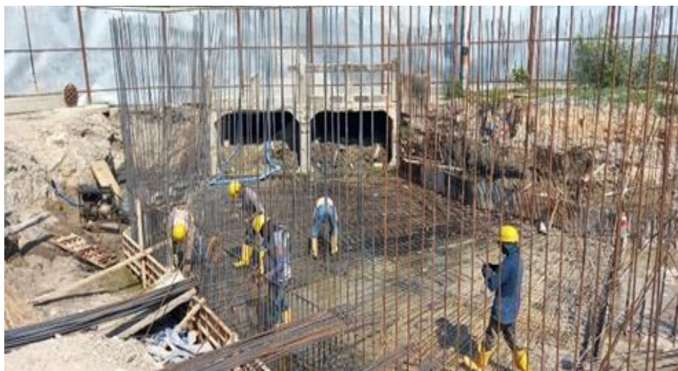
Ilustración 31. Figurado acero muros Box coulvert
