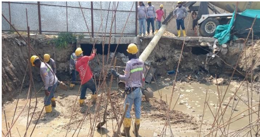
Ilustración 43. Fundida concreto ciclópeo box coulvert
