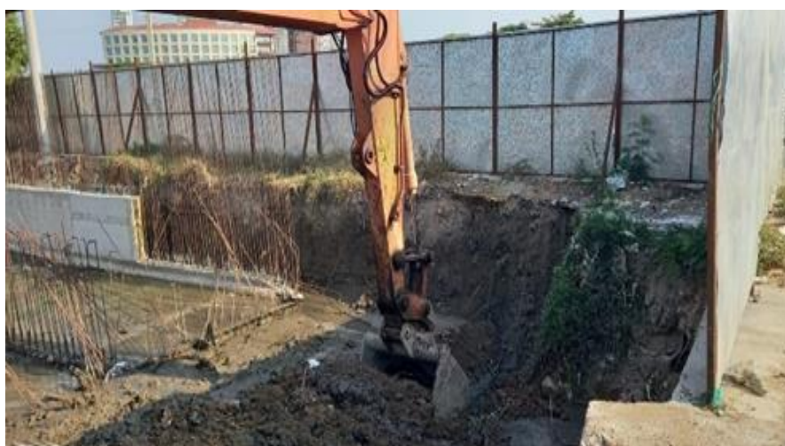
Ilustración 18. Excavación Canal principal
