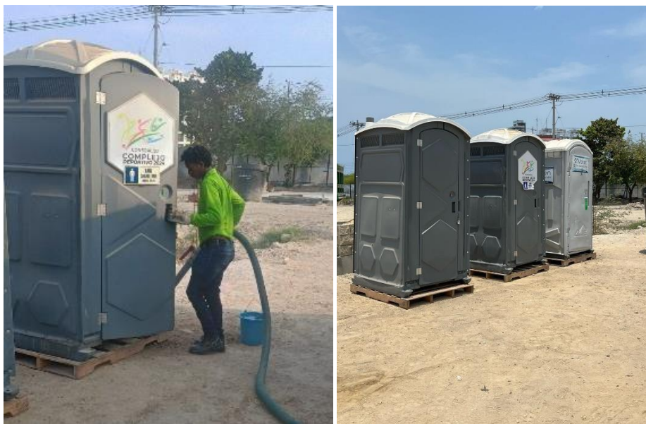
Ilustración 77. Mantenimiento de baños portátiles ecológicos.
