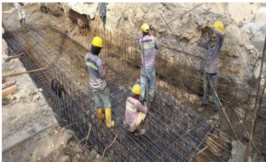
Ilustración 33. Figurado acero placa fondo canal perimetral
