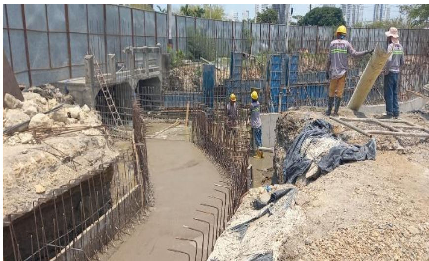
Ilustración 47. Fundida concreto 4000 psi placa fondo canal perimetral
