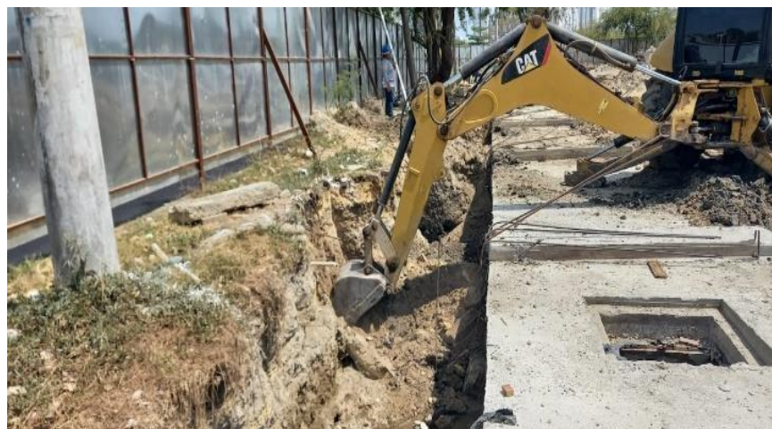
Ilustración 23. Excavación cimentación acceso No 2 canal perimetral
