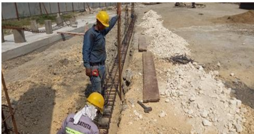
Ilustración 39. Acero de refuerzo vigas de cimentación cerramiento externo
