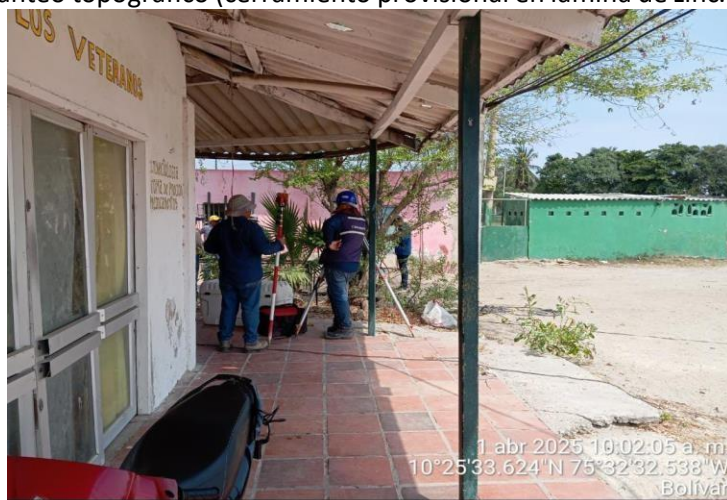
Ilustración 10. Localización y replanteo cerramiento provisional.
