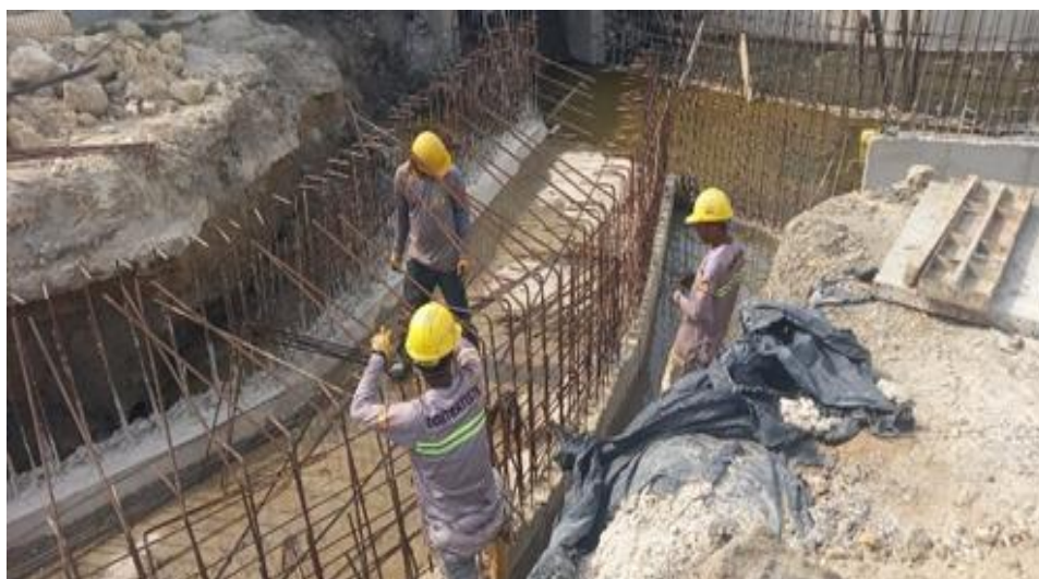
Ilustración 32. Figurado acero muro canal perimetral
