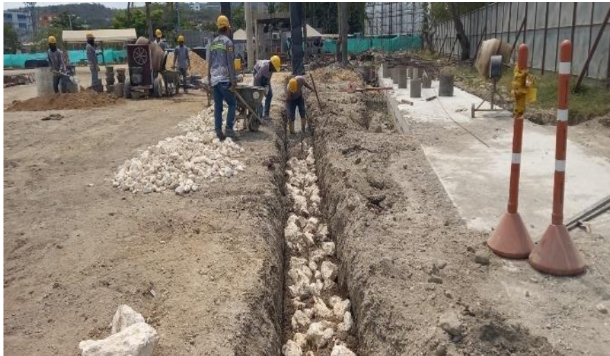
Ilustración 45. Conformación concreto ciclópeo cimentación cerramiento externo
