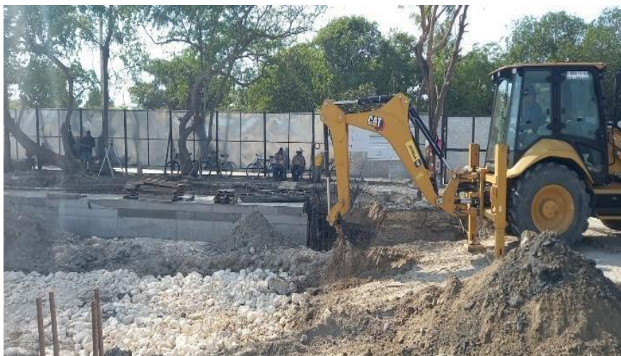
Ilustración 21. Excavación cimentación baterías sanitarias modulo 2
