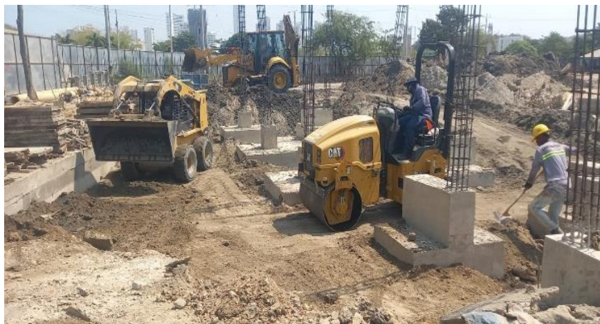
Ilustración 23. Relleno y compactación baños y camerinos
