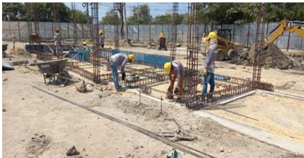
Ilustración 37. Acero refuerzo vigas de cimentación y columnas baños
