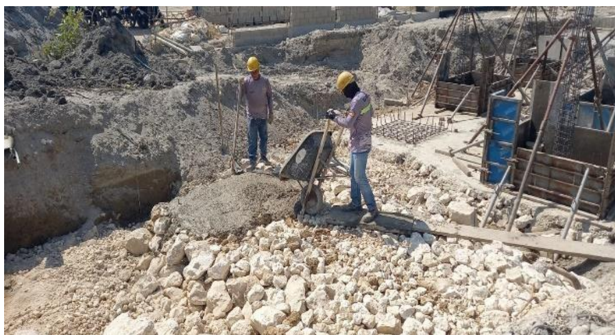
Ilustración 44. Fundida concreto ciclópeo zapatas baterías de baños
