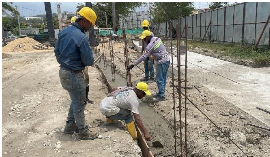
Ilustración 61. Fundida concreto 4000 psi viga de cimentación cerramiento perimetral
