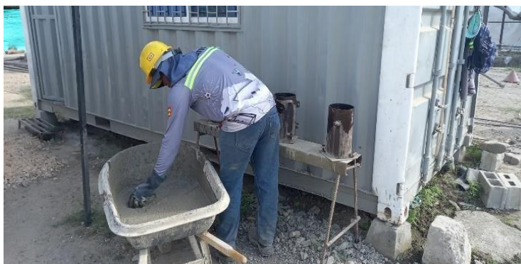
Ilustración 64. Toma de muestras concreto de columnas acceso principal
