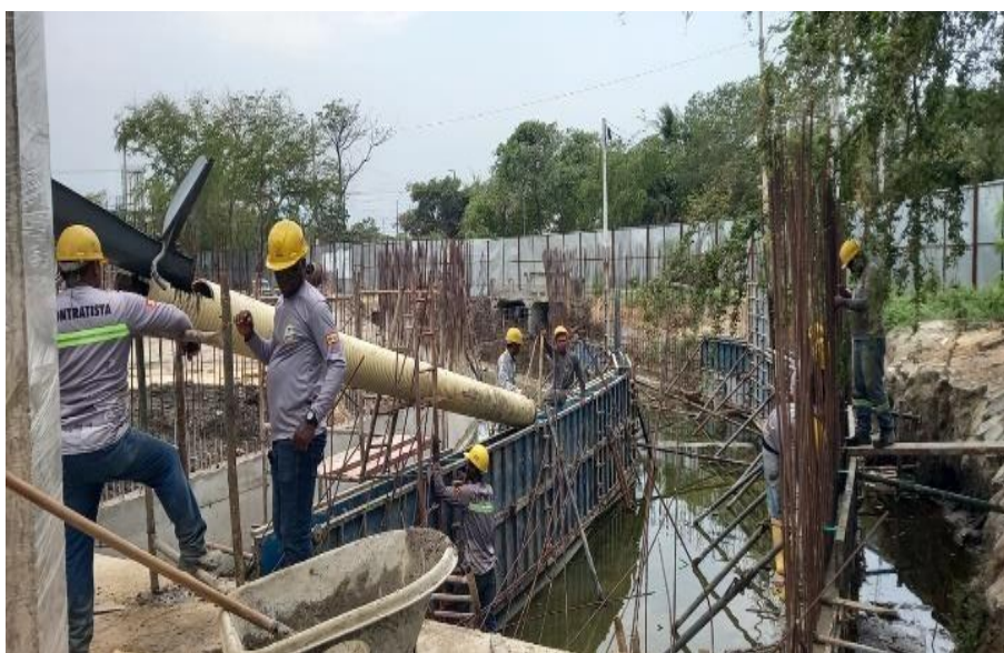
Ilustración 50. Fundida concreto 4000 psi muros box coulvert
