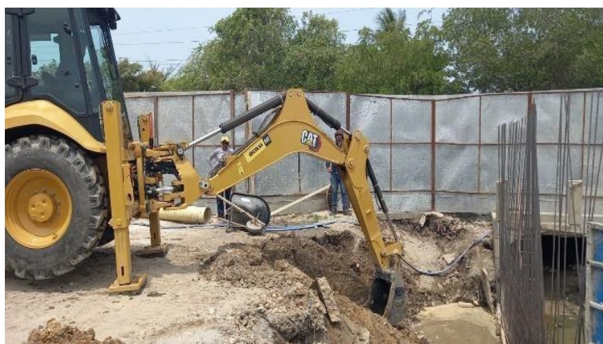
Ilustración 19. Excavación Canal perimetral
