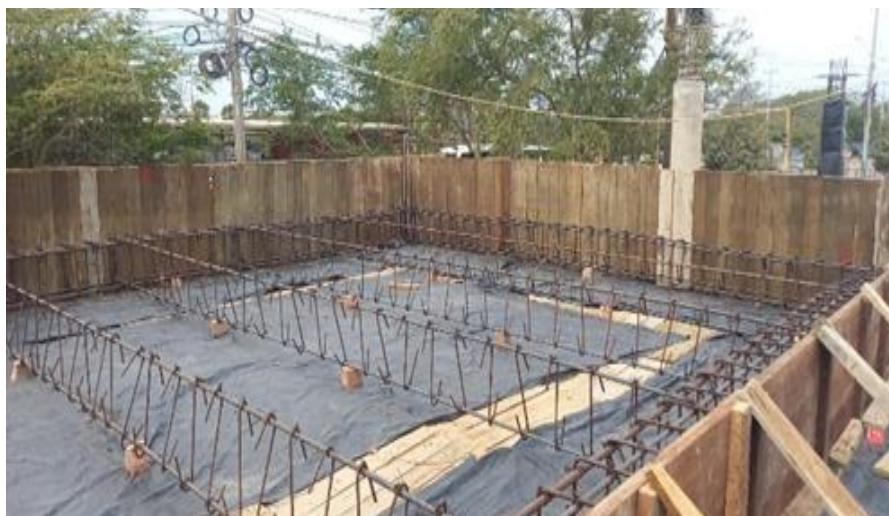
Ilustración 35. Acero refuerzo placa nivel 2 acceso principal
