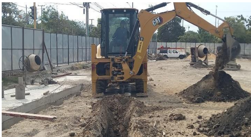
Ilustración 22. Excavación cimentación cerramiento externo
