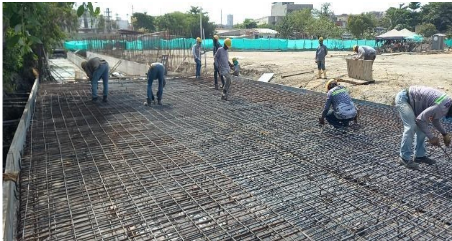
Ilustración 29. Figurado acero placa superior Box coulvert
