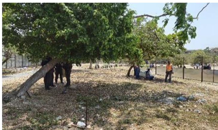
Ilustración 11. Localización y replanteo cerramiento provisional.
