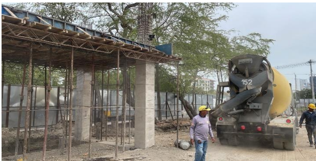
Ilustración 60. Fundida concreto 4000 psi placa 2do nivel acceso No 2 canal perimetral
