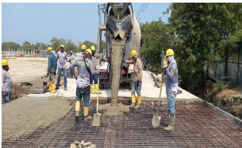
Ilustración 51. Fundida concreto 4000 psi placa superior box coulvert
