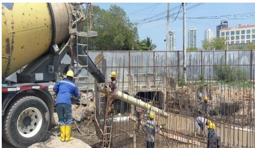
Ilustración 48. Fundida concreto 4000 psi placa fondo box coulvert
