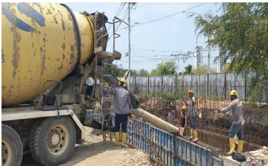
Ilustración 49. Fundida concreto 4000 psi muros box coulvert
