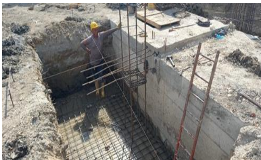
Ilustración 36. Acero refuerzo zapatas acceso No 2 canal perimetral
