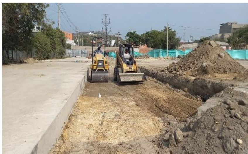
Ilustración 24. Relleno y compactación zona de parqueaderos
