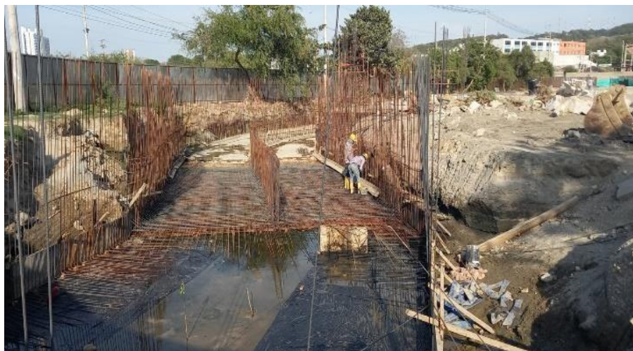
Ilustración 30. Figurado acero fondo Box coulvert
