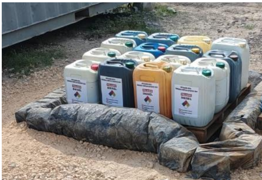
Ilustración 70. Almacenamiento de sustancias peligrosas.
