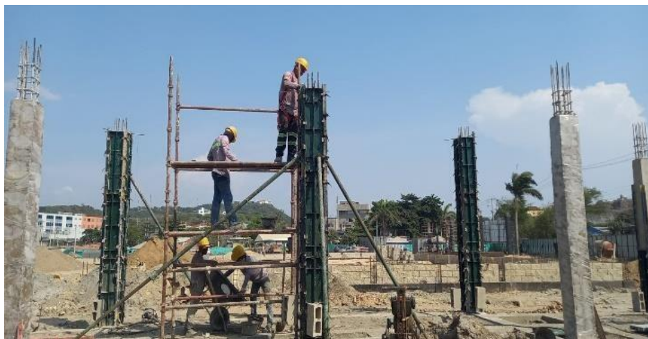
Ilustración 54. Fundida concreto 4000 psi columnas baterías de baños
