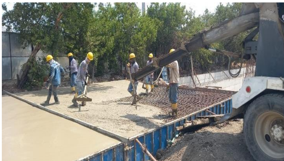
Ilustración 52. Fundida concreto 4000 psi placa superior box coulvert
