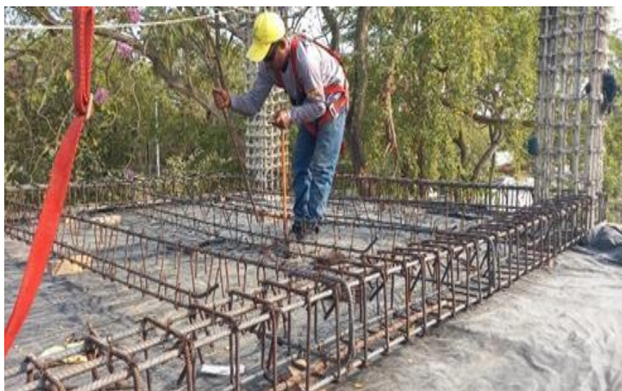
Ilustración 40. Acero de refuerzo placa nivel 2 acceso No 2 canal perimetral
