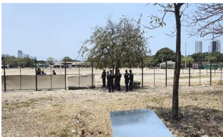
Ilustración 12. Cerramiento provisional en zinc.
