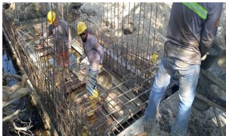
Ilustración 34. Figurado acero placa superior canal perimetral
