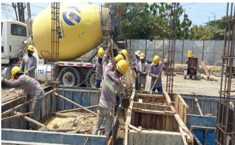
Ilustración 53. Fundida concreto 4000 psi vigas de cimentación baterías de baños
