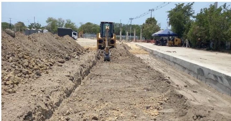
Ilustración 20. Excavación para conformación banca de pavimento parqueaderos
