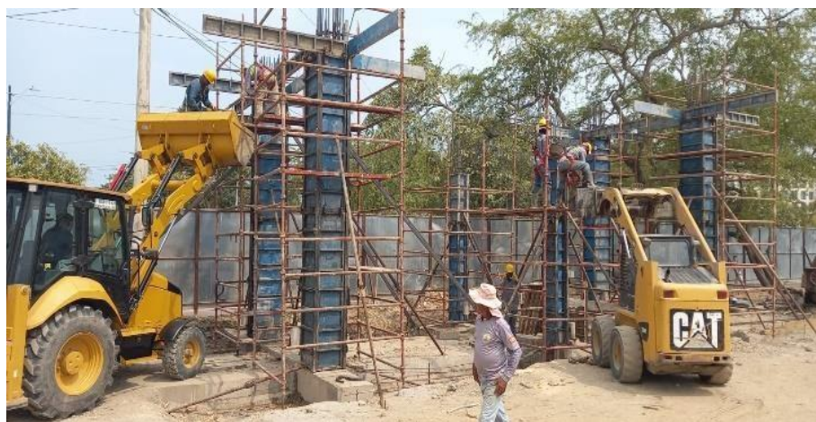
Ilustración 58. Fundida concreto 4000 psi columnas acceso No 2 canal perimetral
