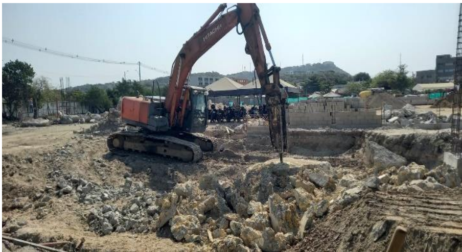
Ilustración 41. Demolición estructura de concreto
