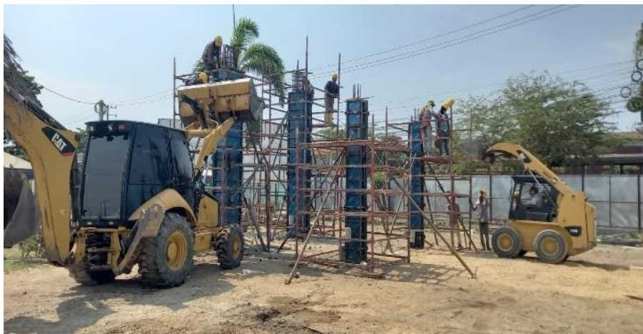
Ilustración 55. Fundida concreto 4000 psi columnas acceso principal
