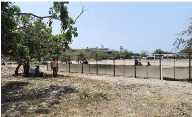
Ilustración 13. Cerramiento provisional en zinc.
