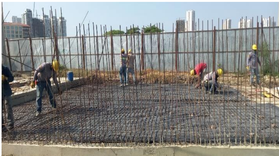
Ilustración 40. Figurado acero placa superior Box coulvert
