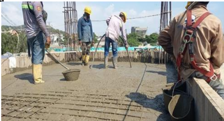
Ilustración 59. Fundida concreto 4000 psi placa 2do nivel acceso No 2 box coulvert
