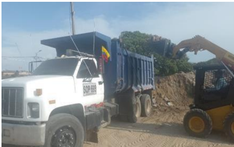
Ilustración 21. Retiro material de demolición graderías
