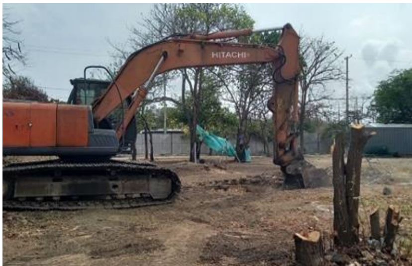
Ilustración 19. Excavación zapatas graderías de futbol
