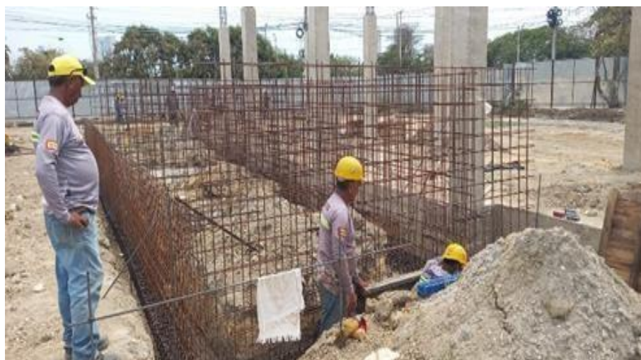
Ilustración 46. Acero de refuerzo escalinatas
