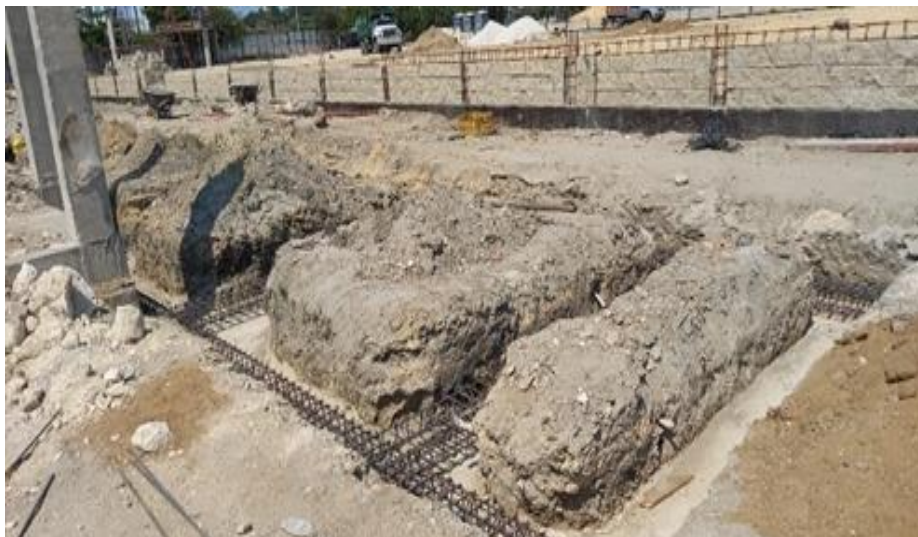
Ilustración 45. Acero refuerzo cimentación escalinatas
