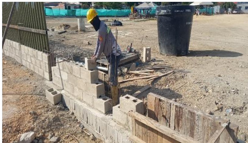
Ilustración 63. Levante en block No 8 muro de cerramiento perimetral
