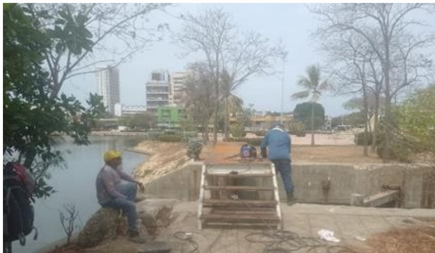
Ilustración 15 . Instalación puente peatonal
