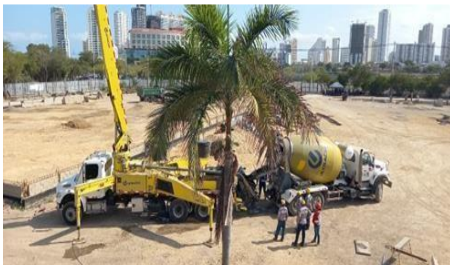
Ilustración 58. Fundida concreto 4000 psi placa 3er nivel acceso principal
