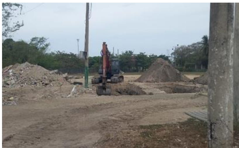
Ilustración 20 . Excavación zapatas graderías de futbol
