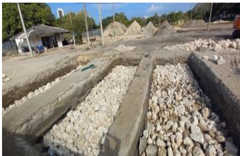
Ilustración 24. Conformación concreto ciclópeo cimentación graderías cancha de futbol
