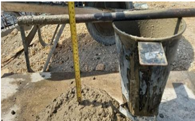
Ilustración 72. Prueba de Slump concreto placa 3er nivel acceso principal.
