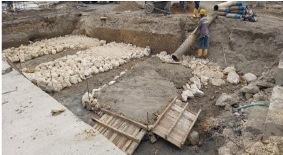
Ilustración 49. Fundida concreto ciclópeos baterías de baños
