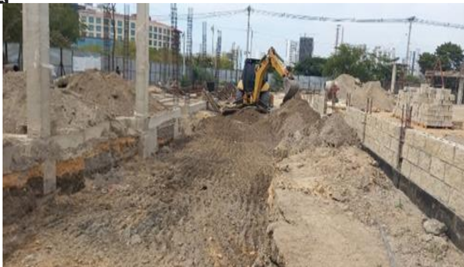
Ilustración 35. Excavación para cimentación escalinatas
