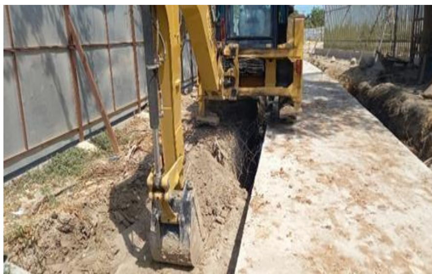
Ilustración 36. Excavación cimentación cerramiento externo
