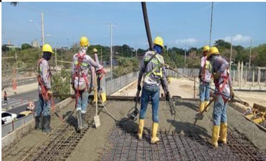
Ilustración 57. Fundida concreto 4000 psi placa 3er nivel acceso principal
