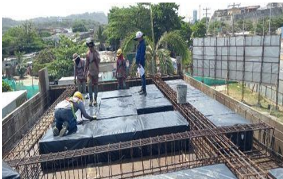
Ilustración 42. Acero refuerzo placa nivel 3 acceso principal
