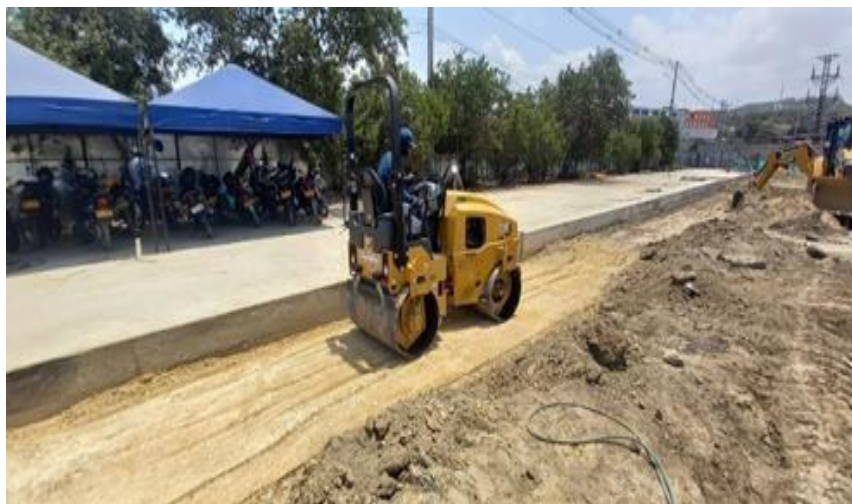
Ilustración 37. Relleno y compactación zona urbanismo y cerramiento
