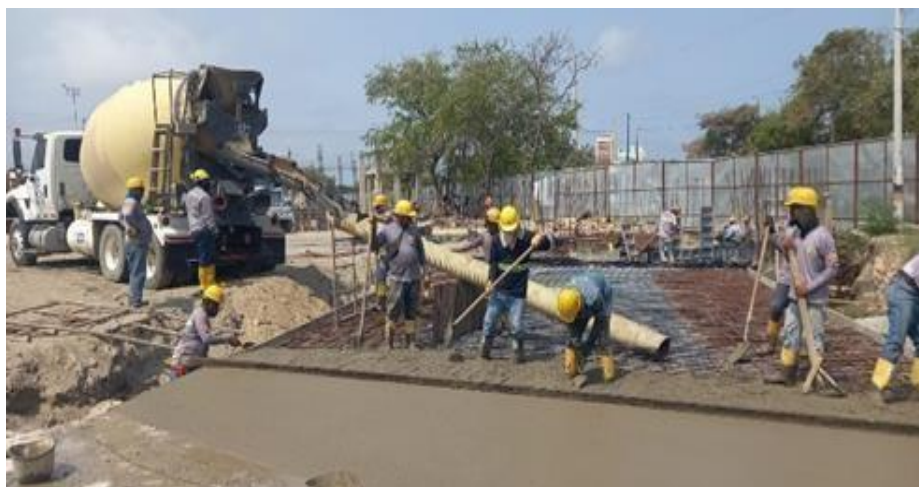
Ilustración 51. Fundida concreto 4000 psi placa superior box coulvert
