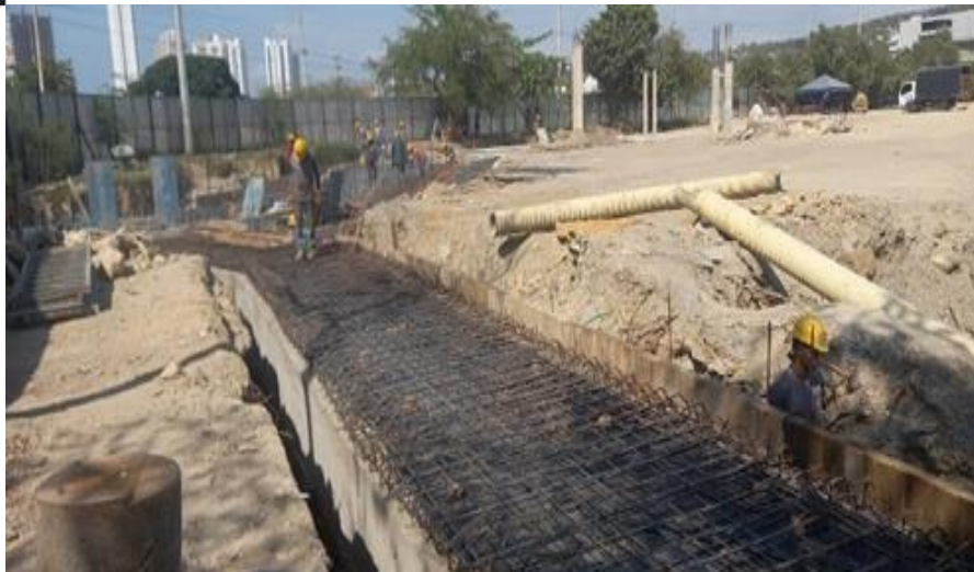
Ilustración 41. Figurado acero placa superior canal perimetral
