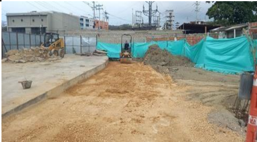
Ilustración 39. Relleno y compactación zona de parqueaderos y cerramiento
