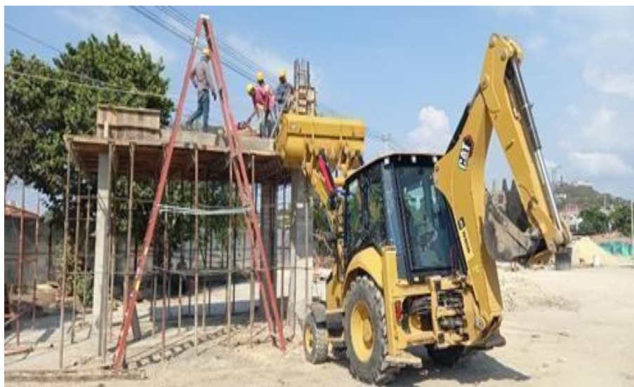
Ilustración 60. Fundida concreto 4000 psi placa 2do nivel acceso No 2 box coulvert
