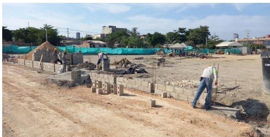
Ilustración 62. Levante en block No 8 muro de cerramiento perimetral
