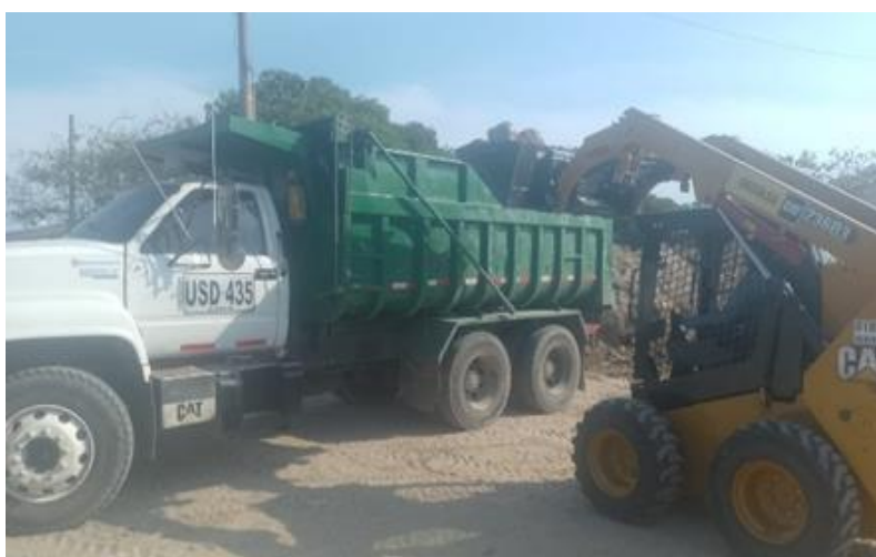
Ilustración 22. Retiro material de demolición graderías
