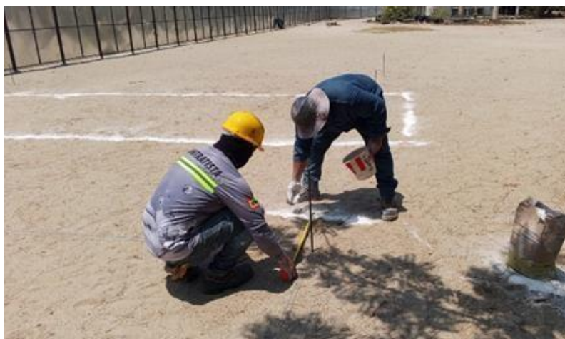
Ilustración 11. Localización y replanteo graderías cancha de fútbol.
