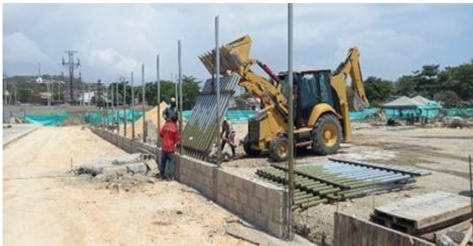
Ilustración 67. Instalación Módulos de tubería de cerramiento externo
