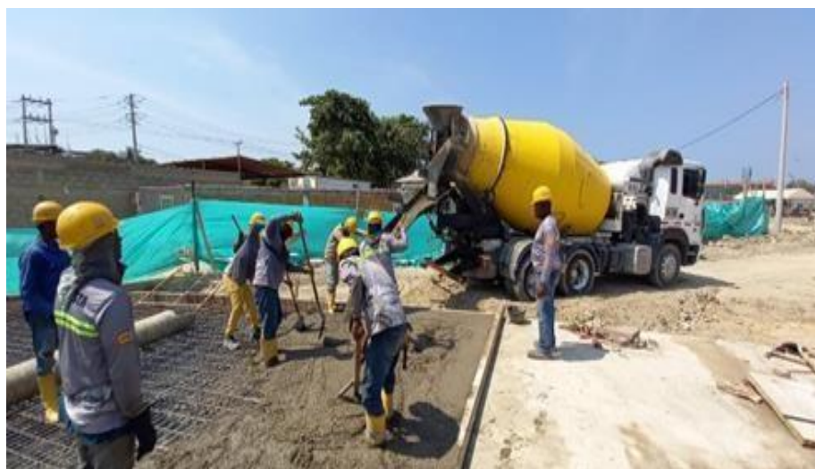
Ilustración 52. Fundida concreto 4000 psi placa superior box coulvert
