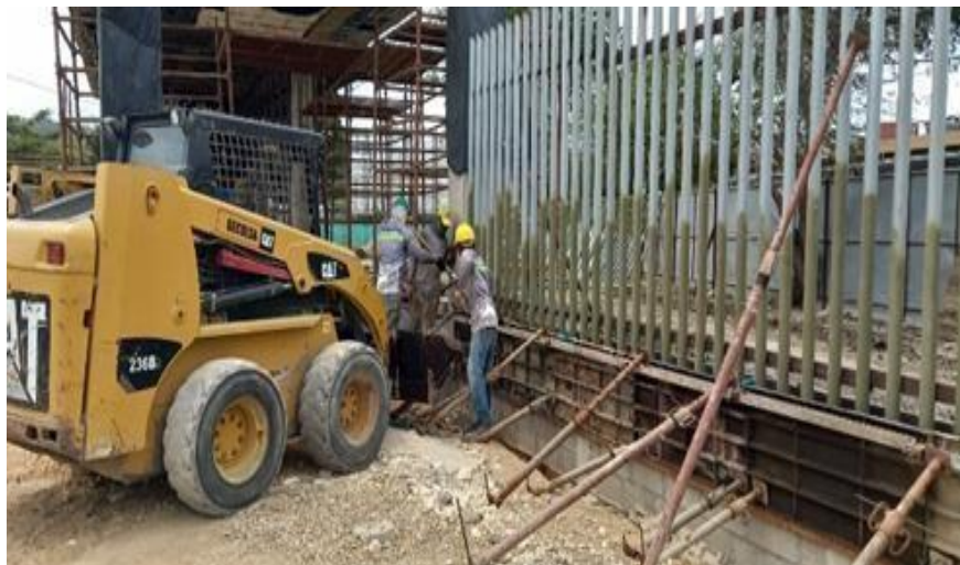
Ilustración 61. Fundida concreto 4000 psi viga de confinamiento muro de cerramiento externo
