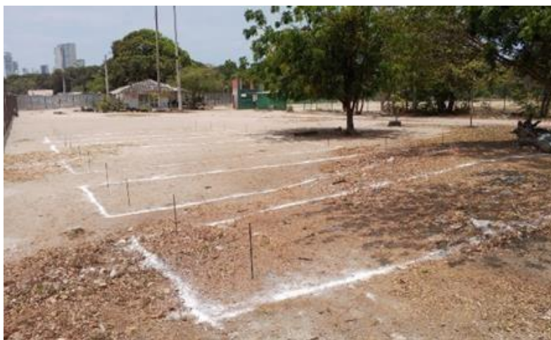
Ilustración 12 . Localización y replanteo graderías cancha de fútbol.
