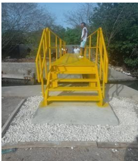
Ilustración 16. Instalación puente peatonal
