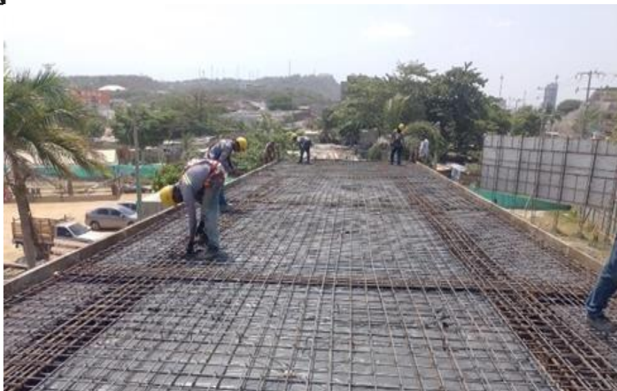
Ilustración 43. Acero refuerzo placa nivel 3 acceso principal
