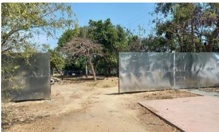
Ilustración 14. Cerramiento provisional en zinc.
