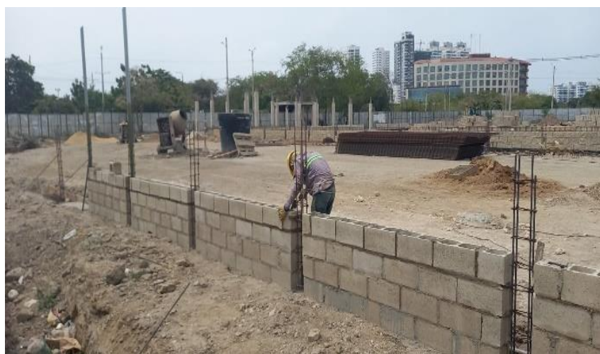
Ilustración 64. Levante en block No 8 muro de cerramiento perimetral
