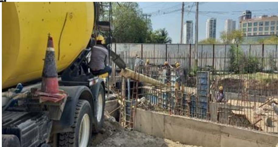
Ilustración 53. Fundida concreto 4000 psi muros box coulvert
