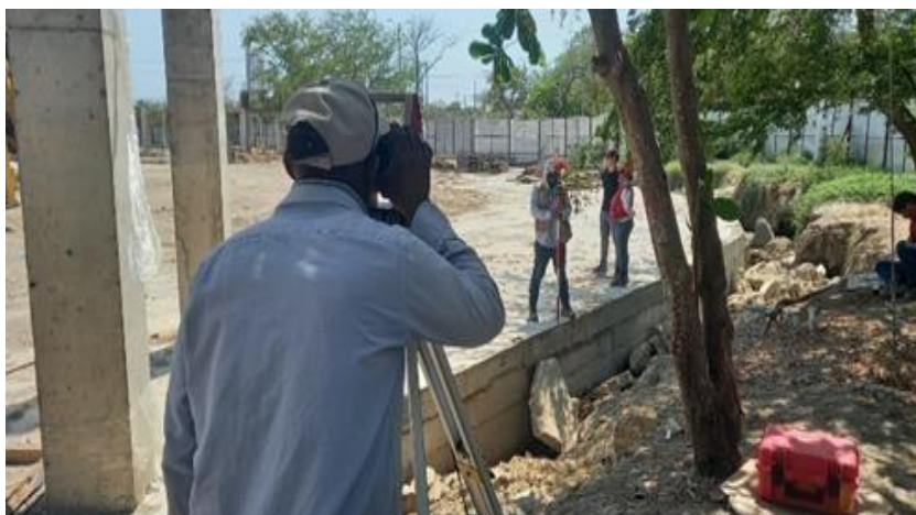
Ilustración 29. Localización y replanteo canal principal
