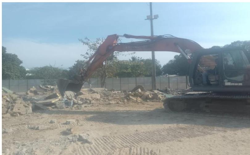
Ilustración 18. Demolición gradería cancha de softbol
