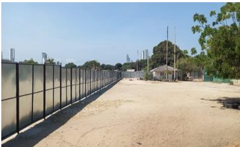
Ilustración 13. Cerramiento provisional en zinc.
