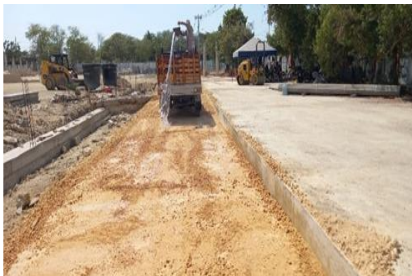
Ilustración 38. Relleno y compactación zona de parqueaderos
