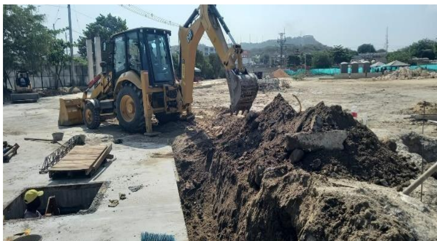
Ilustración 33. Excavación para relleno material seleccionado
