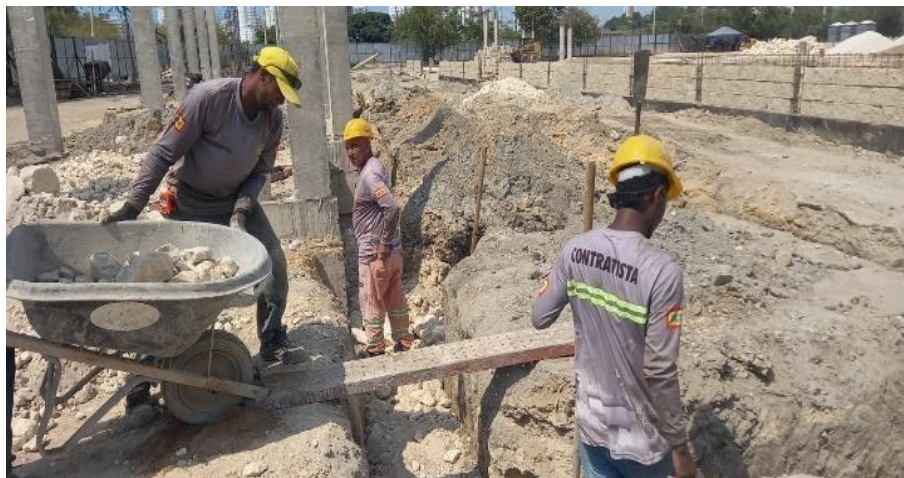
Ilustración 50. Fundida concreto ciclópeo graderías
