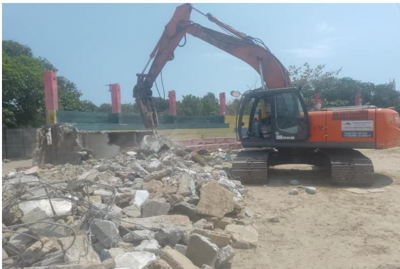
Ilustración 17. Demolición gradería cancha de softbol
