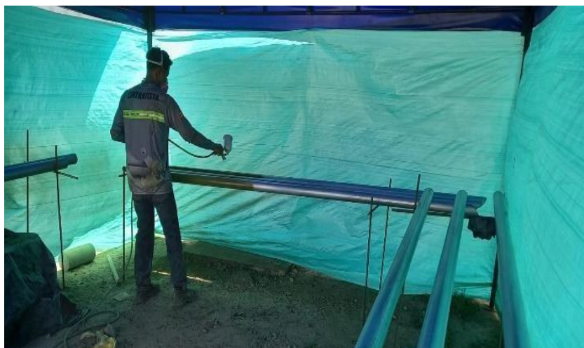
Ilustración 65. Pintura tubería de cerramiento externo
