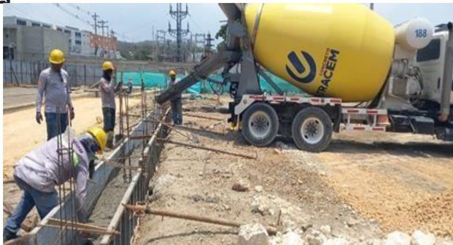
Ilustración 55. Fundida concreto 4000 psi vigas de cimiento cerramiento externo
