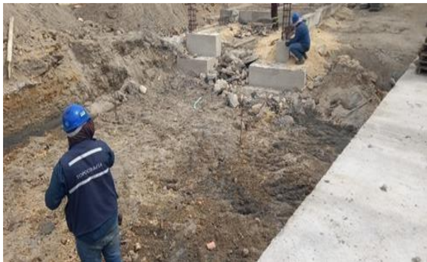
Ilustración 31. Localización y replanteo cerramiento externo
