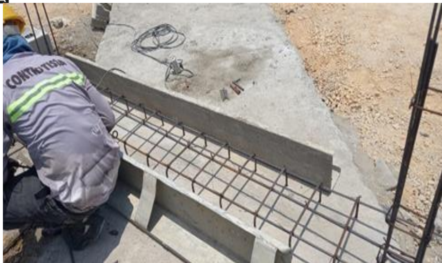
Ilustración 47. Acero de refuerzo viga cimentación muro de cerramiento
