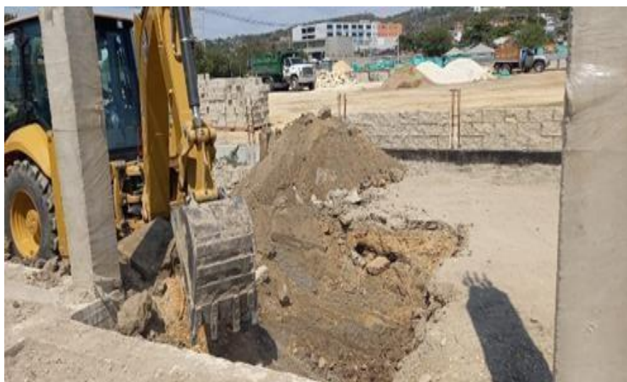
Ilustración 34. Excavación mecánica cimentación escalinatas
