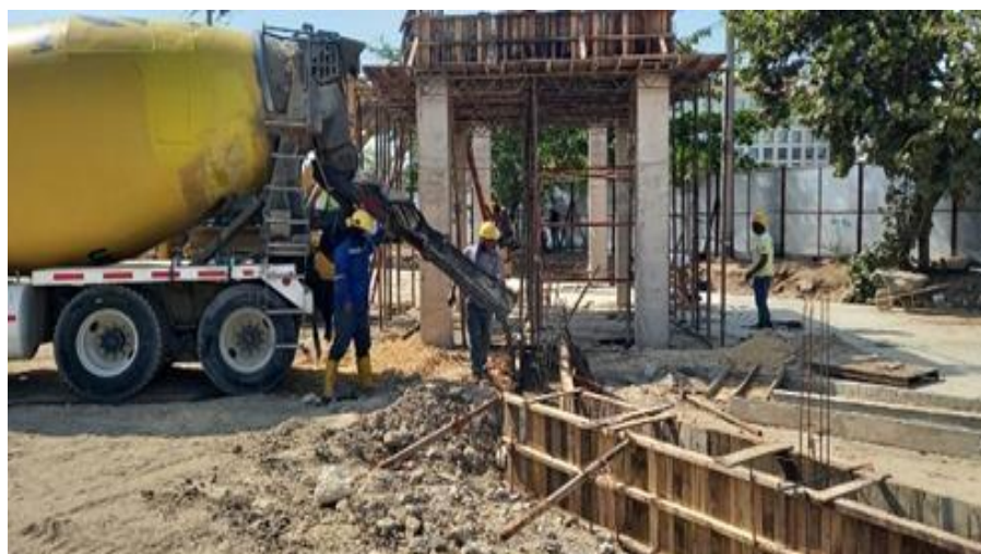
Ilustración 56. Fundida concreto 4000 psi vigas de cimiento cerramiento externo
