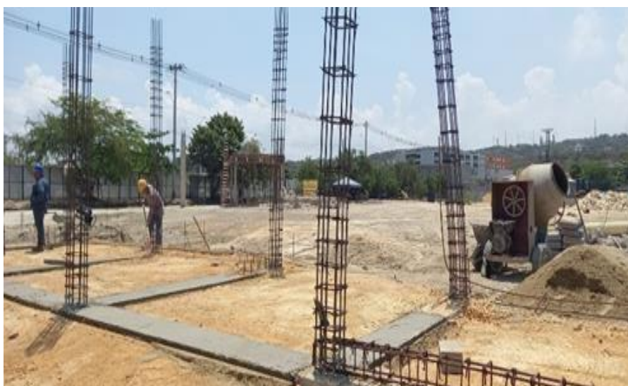
Ilustración 44. Acero refuerzo columnas baños
