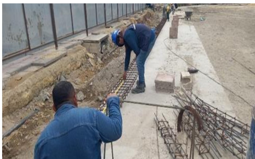
Ilustración 32. Localización y replanteo muro de cerramiento paralelo al canal.
