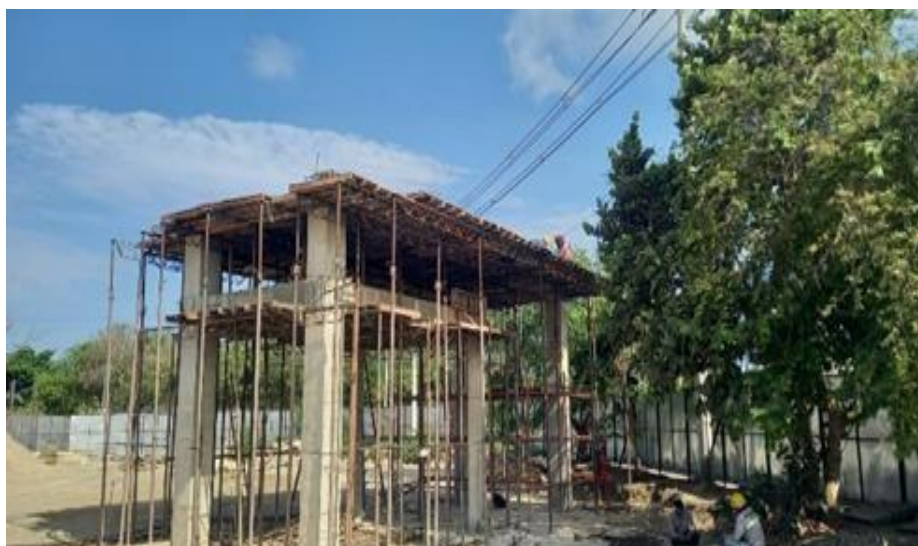
Ilustración 48. Acero de refuerzo placa 3er nivel acceso No 2 canal principal
