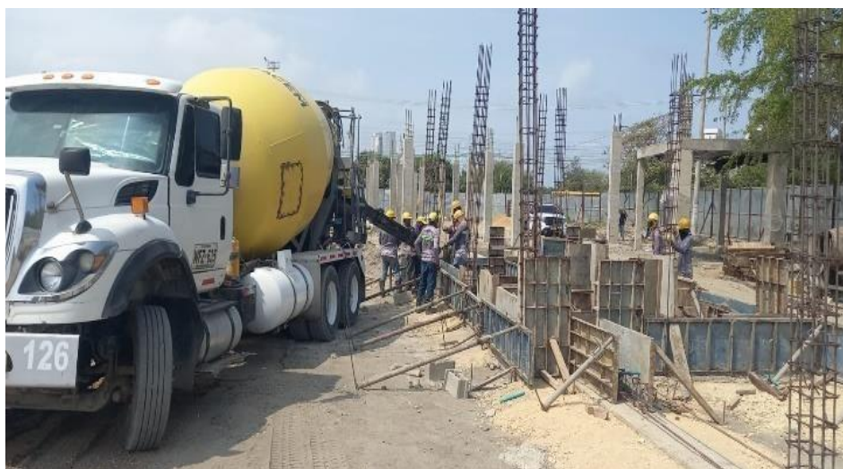
Ilustración 54. Fundida concreto 4000 psi vigas de cimentación baterías de baños
