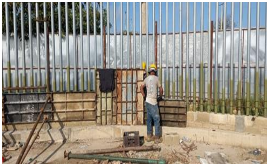
Ilustración 56. Fundida concreto 4000 psi vigas de muro de cerramiento externo
