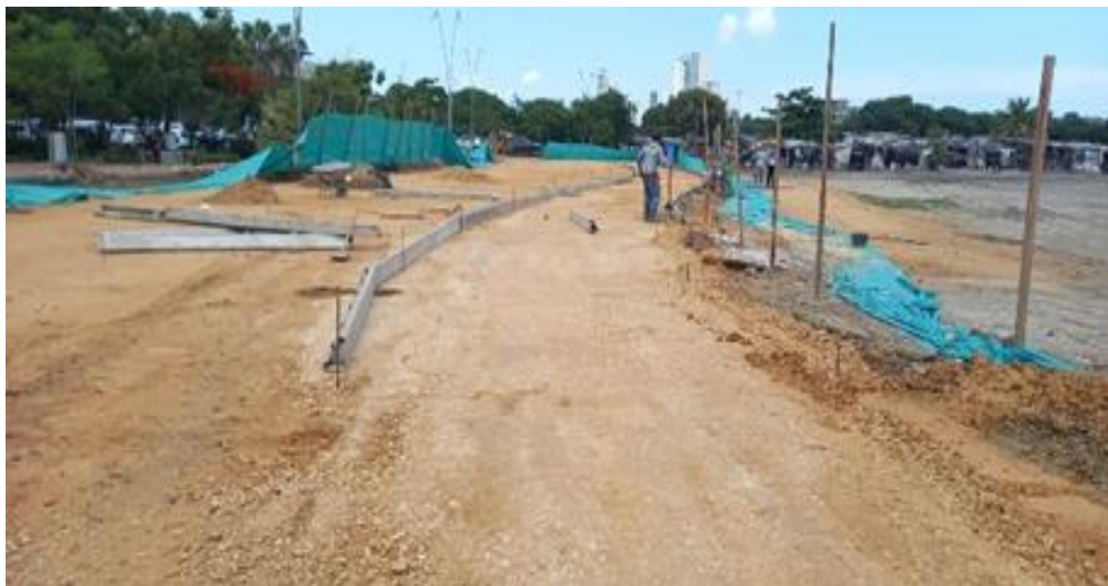
Ilustración 14. Localización y replanteo cerramiento parqueadero.
