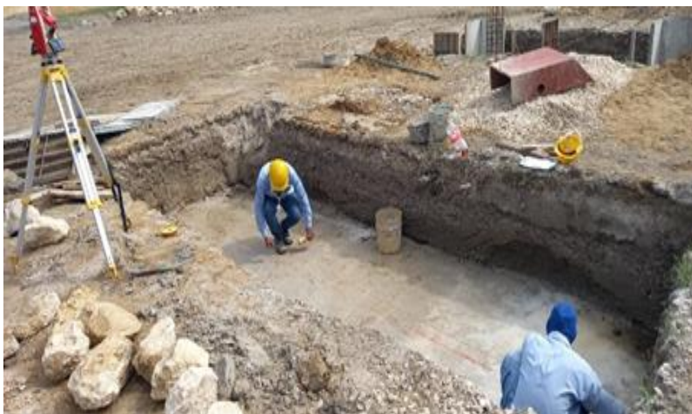
Ilustración 12. Localización y replanteo zapatas dugout derecho cancha de softbol.
