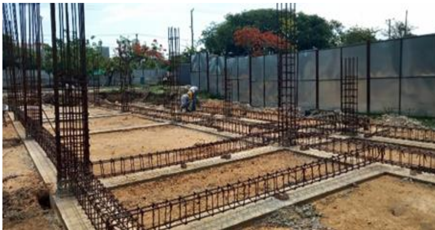
Ilustración 25. Figurado acero 60000 psi vigas de concreto y columnas cancha de fútbol
