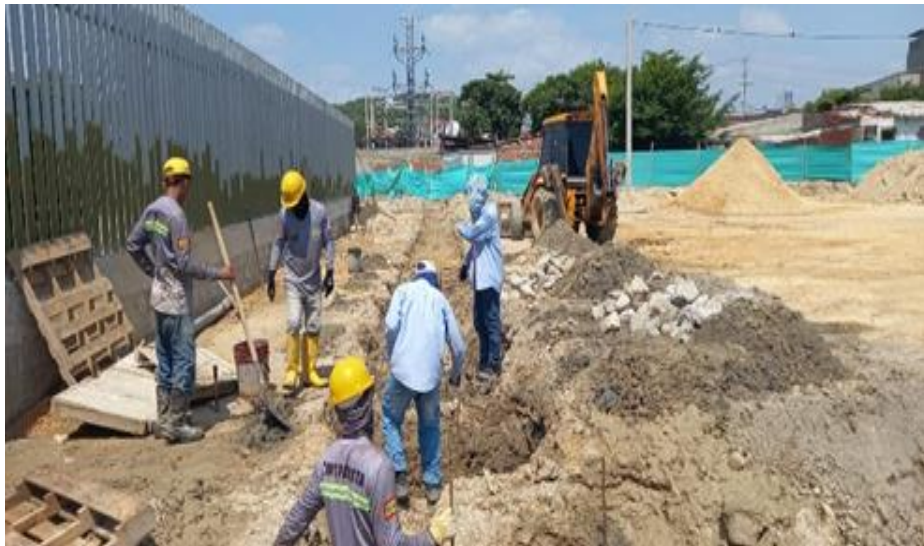
Ilustración 39. Localización y replanteo cerramiento cancha futbol 9
