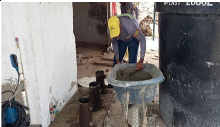
Ilustración 67. Toma de muestras concreto zapatas cancha de futbol
