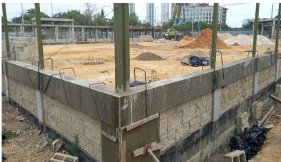
Ilustración 54. Fundida concreto 4000 psi viga de confinamiento cerramiento cancha futbol 11
