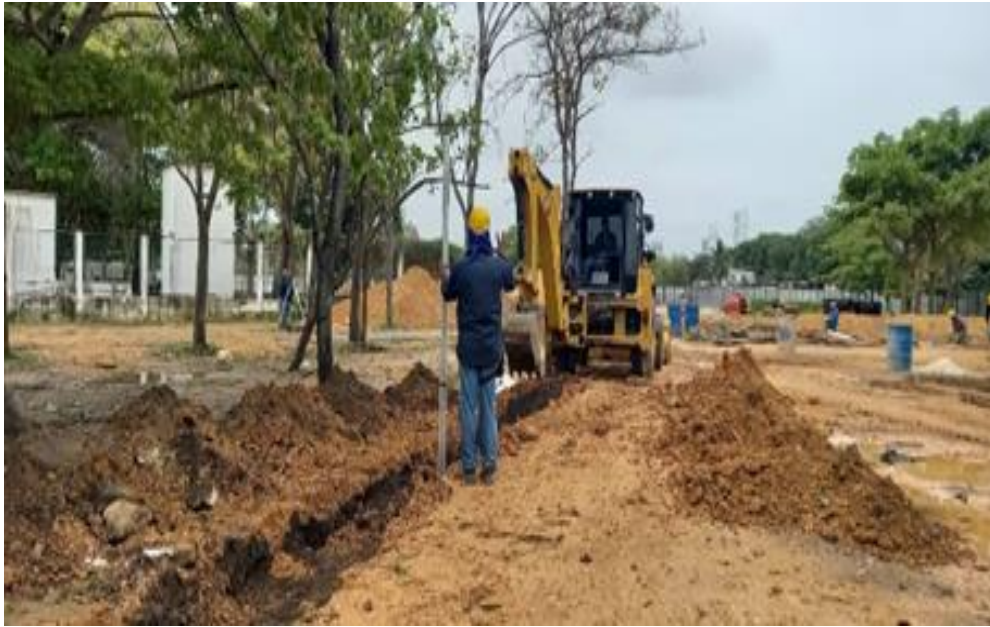
Ilustración 13. Localización y replanteo cerramiento cancha de múltiple.
