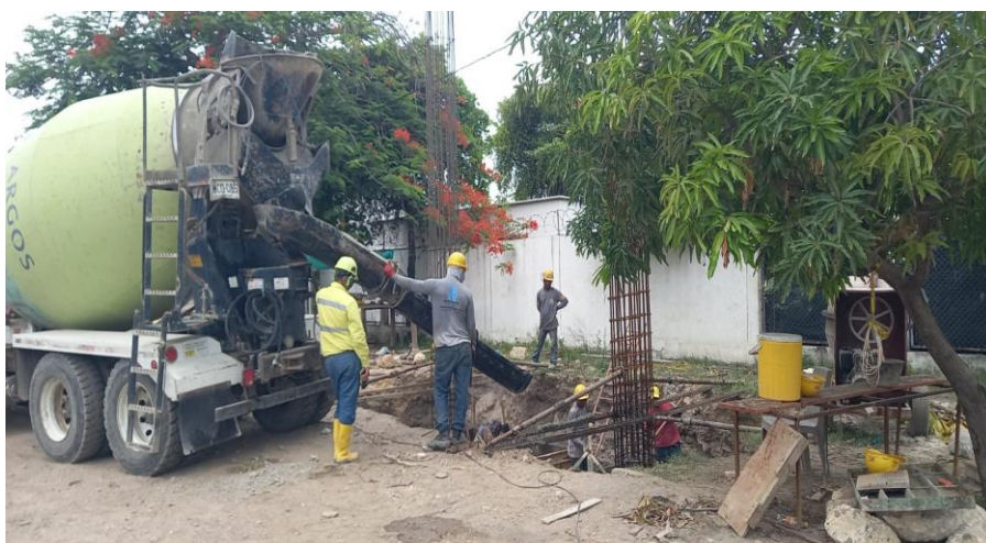
Ilustración 30. Fundida concreto 4000 psi zapatas acceso principal
