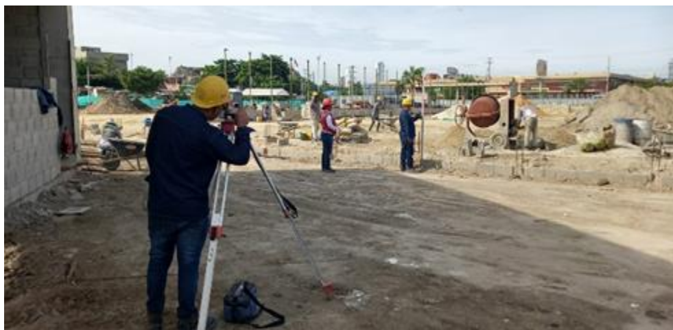
Ilustración 38. Localización y replanteo estructura cerramiento cancha futbol 11
