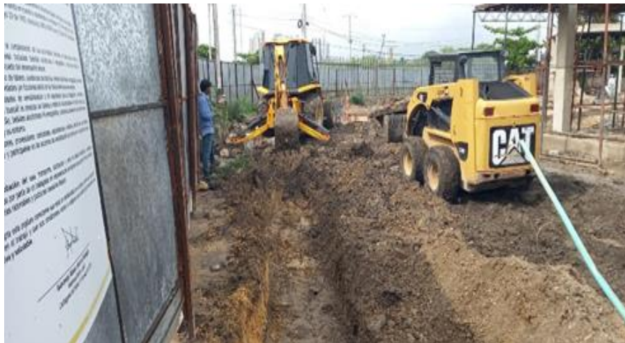
Ilustración 41. Excavación mecánica para cimentación cerramiento perimetral
