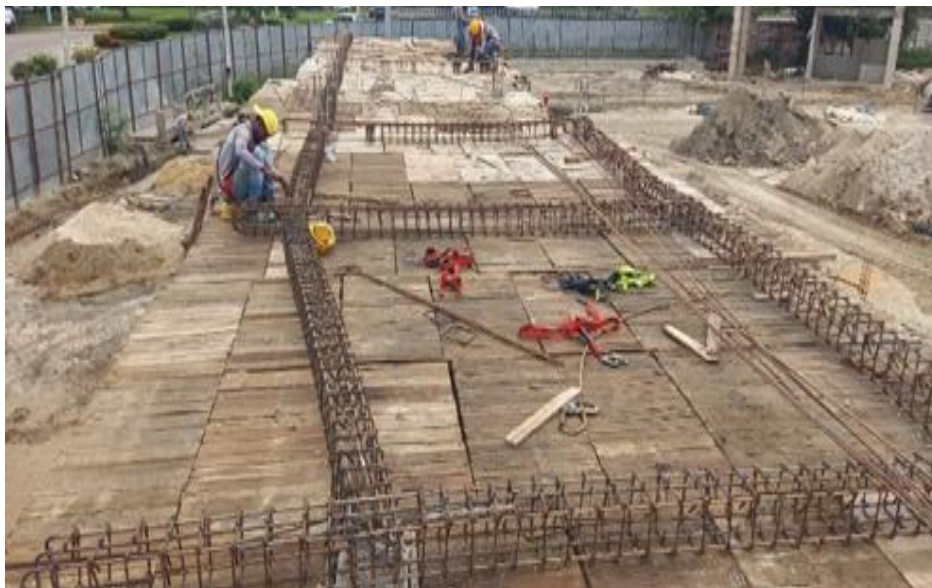
Ilustración 45. Figurado acero placa baños y camerinos
