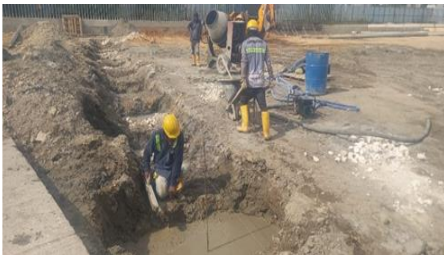
Ilustración 50. Fundida concreto ciclópeo cerramiento cancha futbol 9
