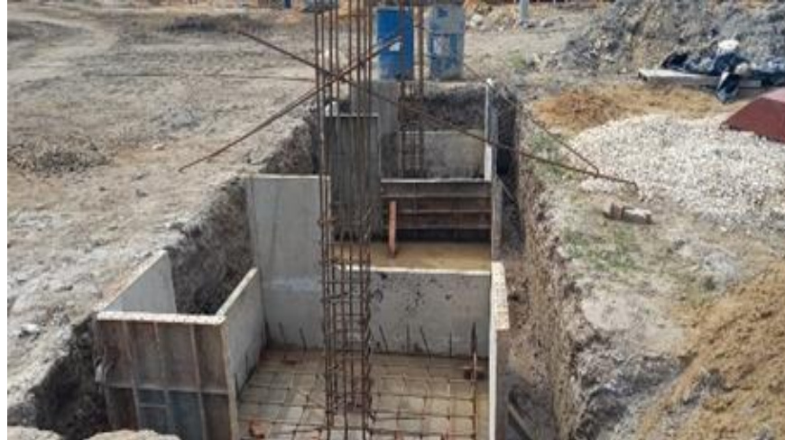
Ilustración 27. Figurado acero 60000 psi zapatas y columnas dugout
