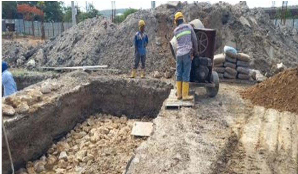
Ilustración 20. Conformación concreto ciclópeo cimentación dugout
