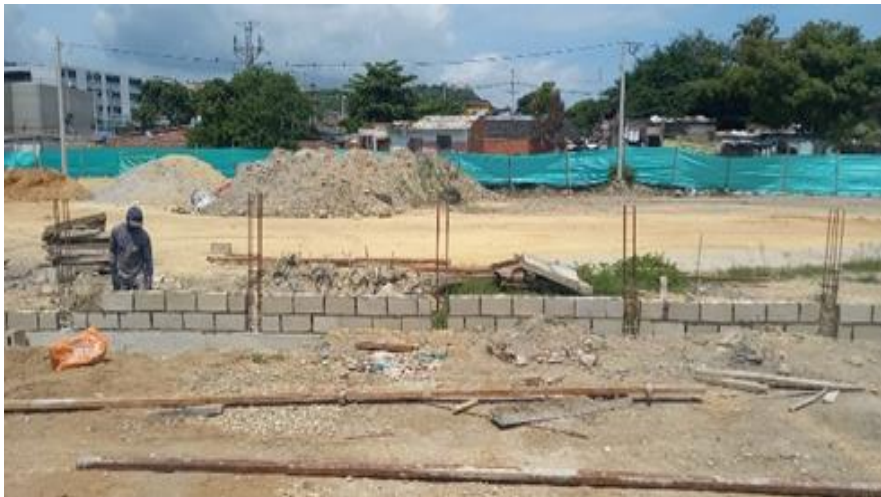
Ilustración 58. Levante en block No 6 muro de cerramiento cancha futbol 9
