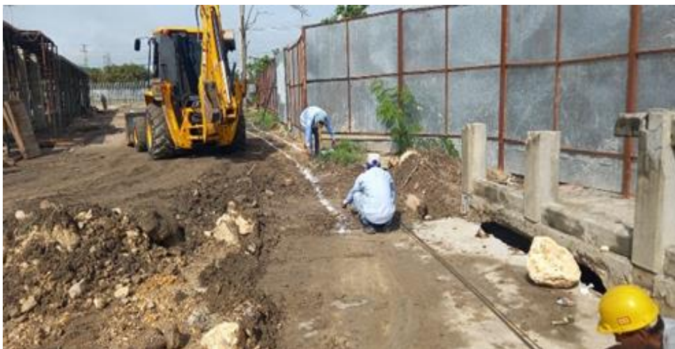
Ilustración 37. Localización y replanteo cerramiento externo.
