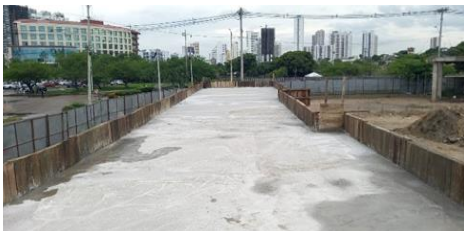
Ilustración 52. Fundida concreto 4000 psi placa batería de baños y camerinos
