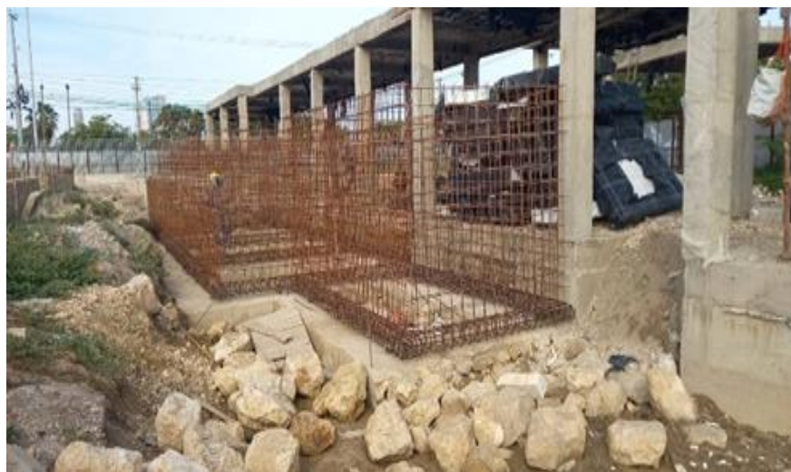
Ilustración 47. Acero refuerzo graderías cancha futbol 11
