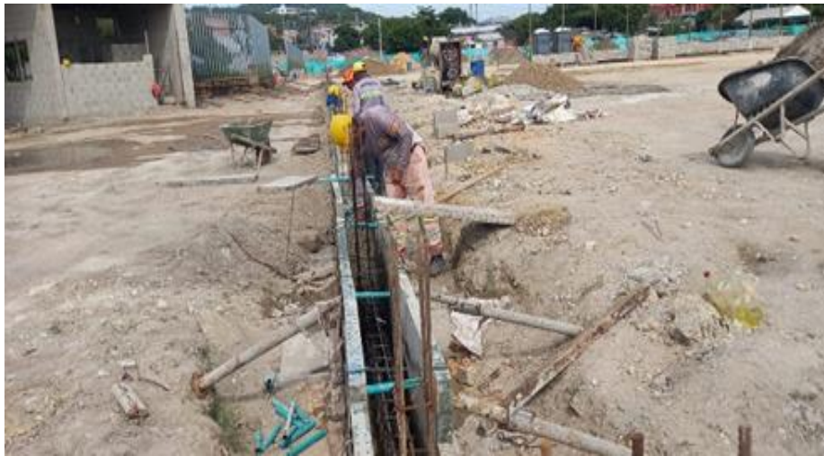
Ilustración 55. Fundida concreto 4000 psi vigas de cimiento cerramiento cancha futbol 9
