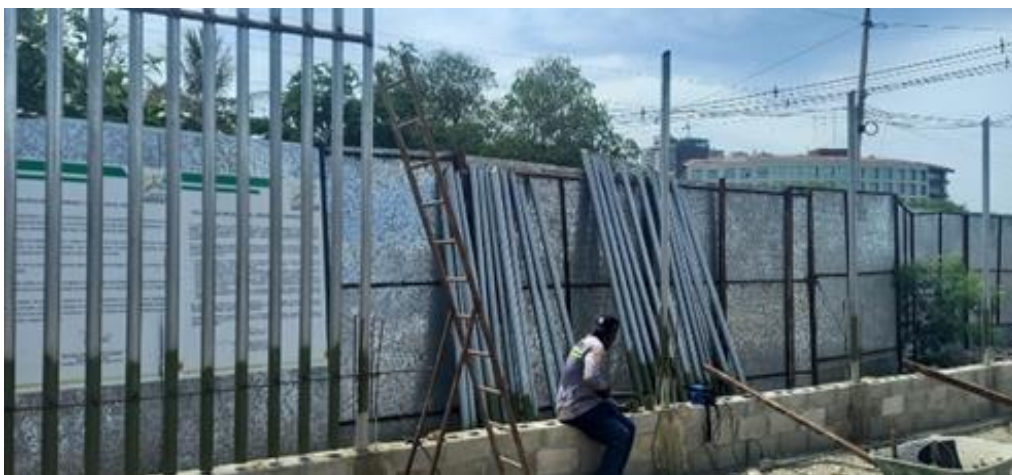
Ilustración 61. Instalación Módulos de tubería de cerramiento externo acceso principal
