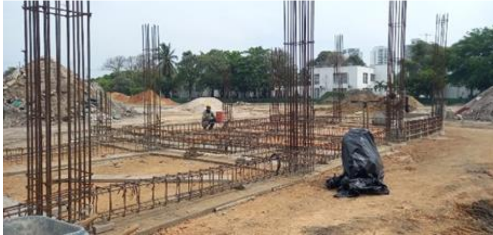
Ilustración 23. Figurado acero 60000 psi vigas de cimentación y columnas graderías de cancha de softbol
