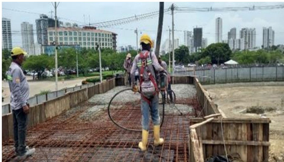
Ilustración 51. Fundida concreto 4000 psi placa batería de baños y camerinos
