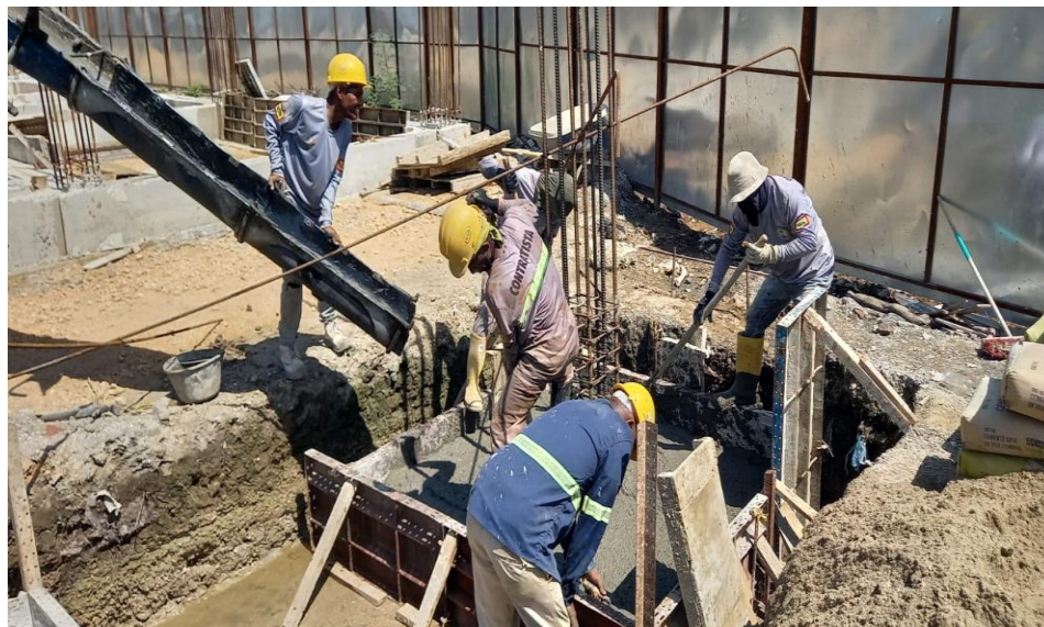
Ilustración 32. Fundida concreto 4000 psi zapatas dugout
