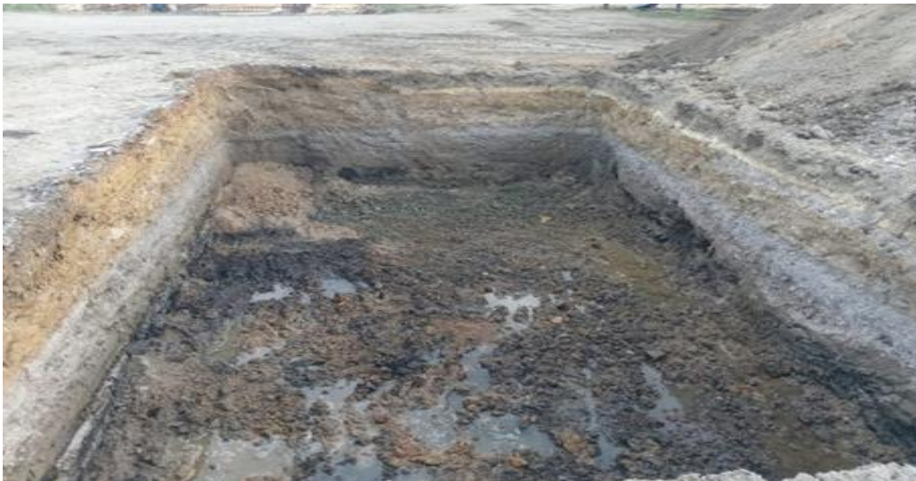
Ilustración 17. Excavación zapatas dugout
