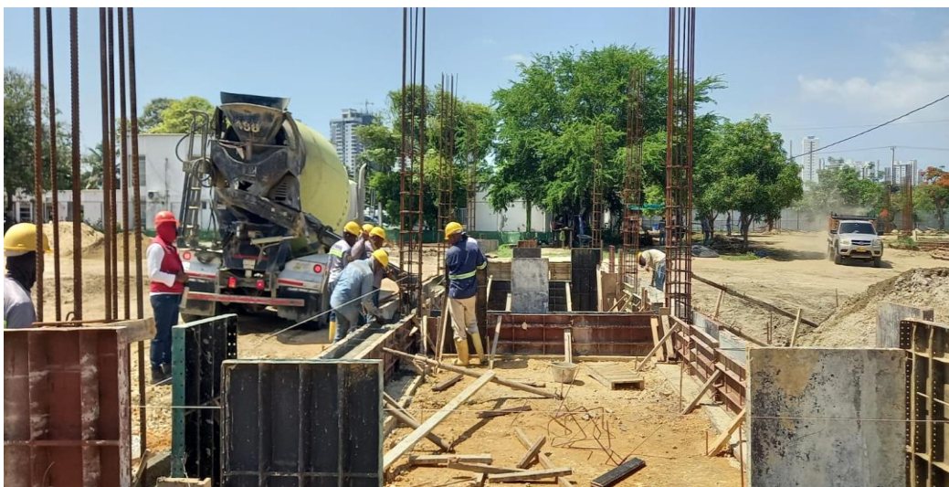
Ilustración 33. Fundida concreto 4000 psi vigas de cimentación dugout
