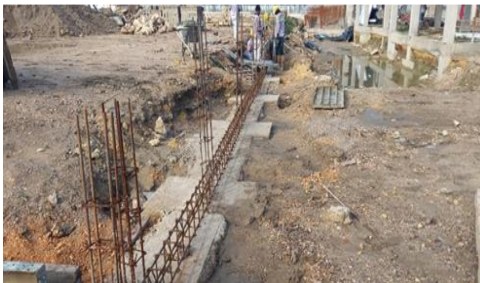
Ilustración 46. Acero refuerzo viga cimentación cerramiento perimetral
