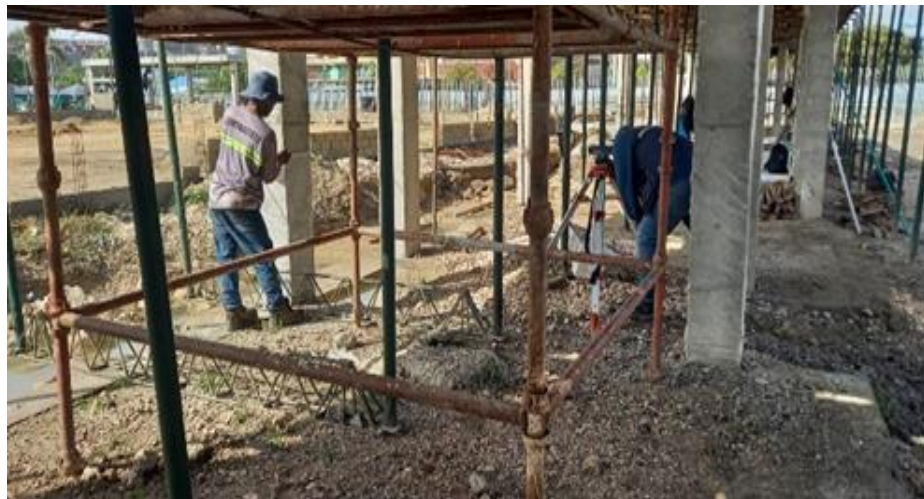
Ilustración 40. Localización y replanteo baterías sanitarias y camerinos.
