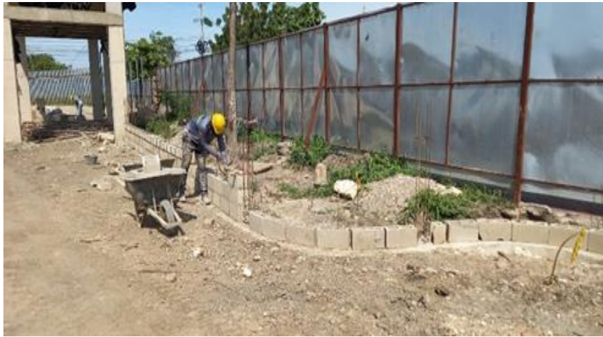
Ilustración 57. Levante en block No 8 muro de cerramiento perimetral
