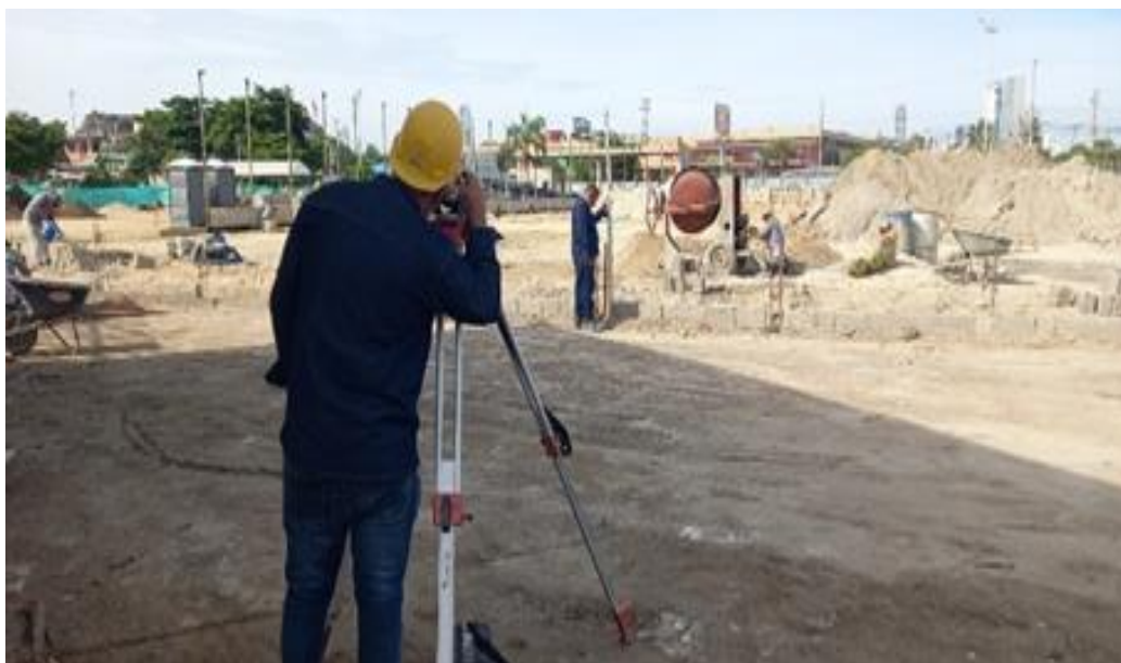
Ilustración 11. Localización y replanteo graderías cancha de futbol.
