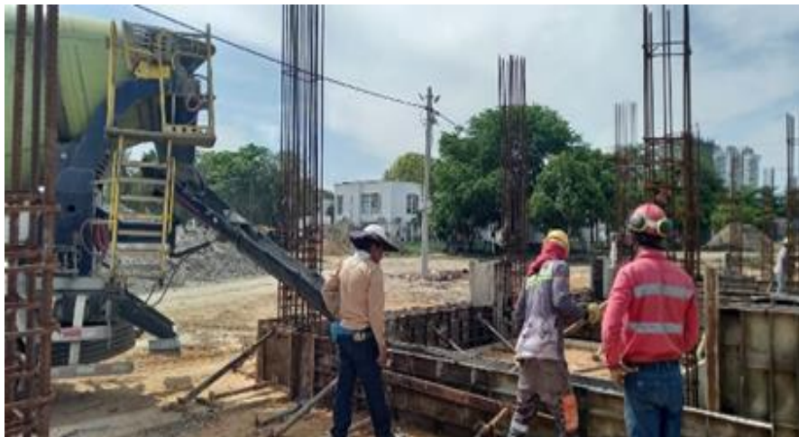
Ilustración 28. Fundida concreto 4000 psi vigas de cimentación graderías cancha de futbol
