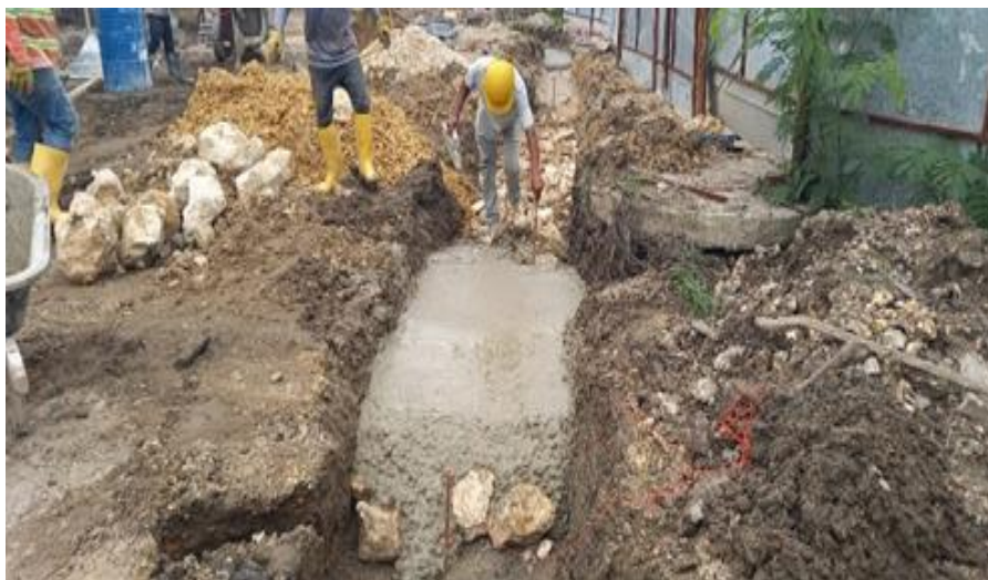
Ilustración 49. Fundida concreto ciclópeo cimentación cerramiento perimetral
