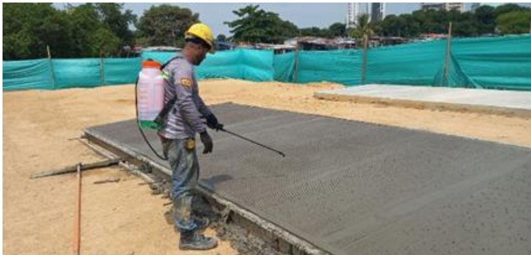
Ilustración 36. Fundida concreto para pavimento parqueaderos
