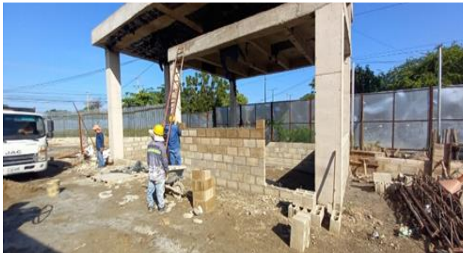
Ilustración 64. Levante en block No 4 garita acceso No 2. Espíritu del manglar
