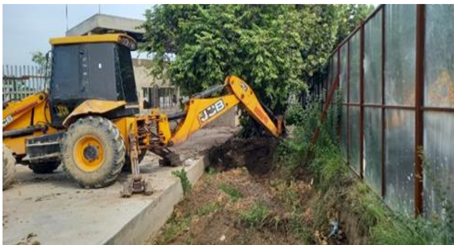
Ilustración 42. Excavación mecánica para conformación de zonas verdes
