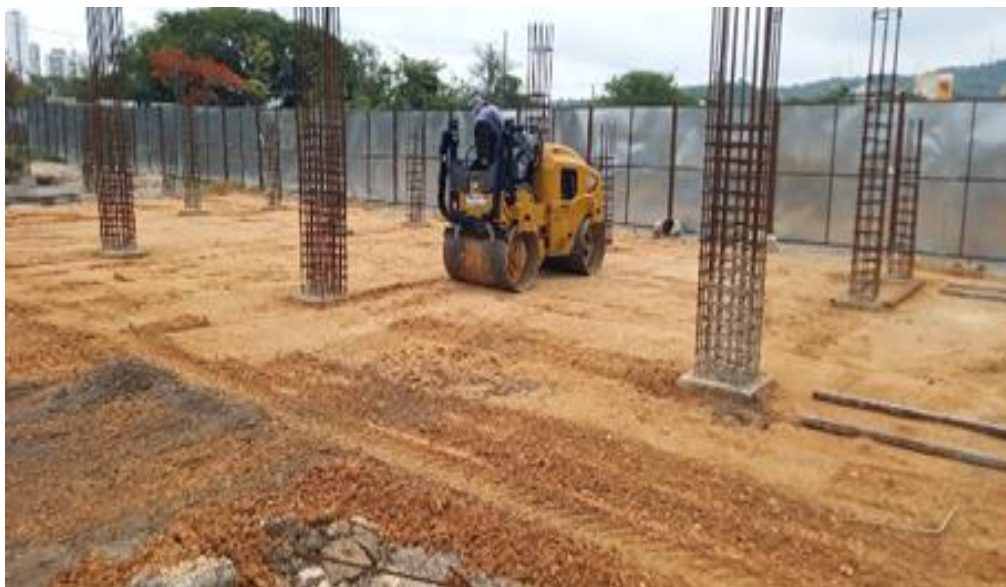
Ilustración 18. Relleno y compactación material seleccionado cancha zona de graderías.
