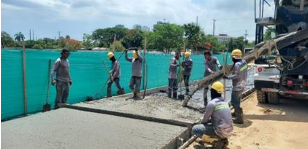
Ilustración 35. Fundida concreto para pavimento parqueaderos
