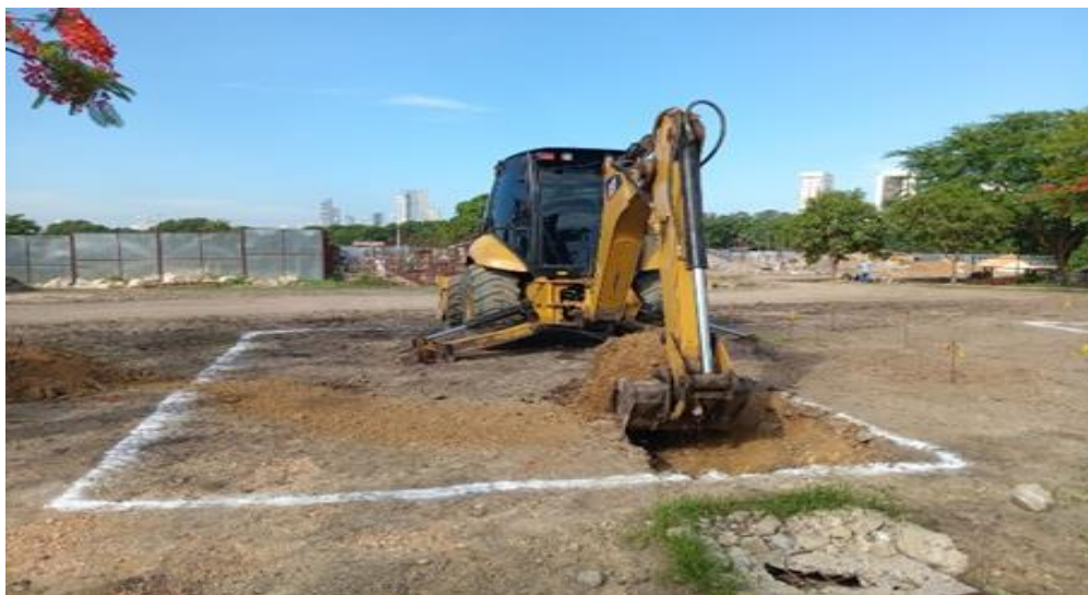
Ilustración 16. Excavación zapatas acceso principal
