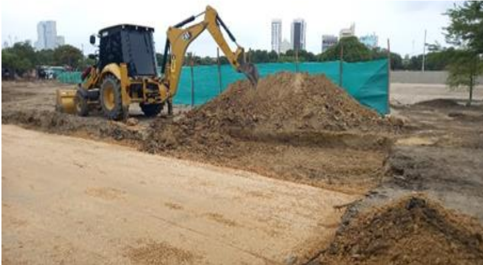
Ilustración 15 . Excavación para conformación banca para pavimento parqueaderos
