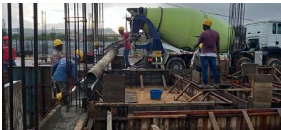
Ilustración 29. Fundida concreto 4000 psi vigas de cimentación graderías cancha de softbol
