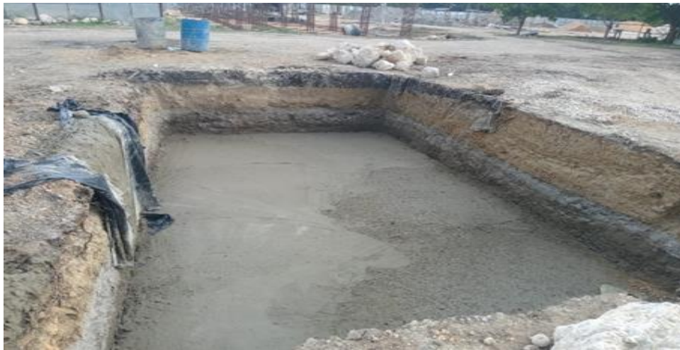
Ilustración 21. Fundida concreto ciclópeo cimentación graderías cancha de futbol
