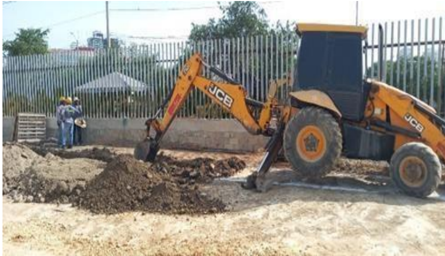
Ilustración 43. Excavación cancha futbol 9
