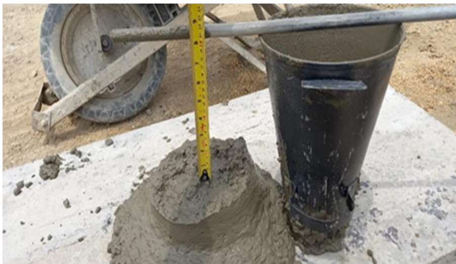
Ilustración 68 . Prueba de Slump concreto placa baños y camerinos
