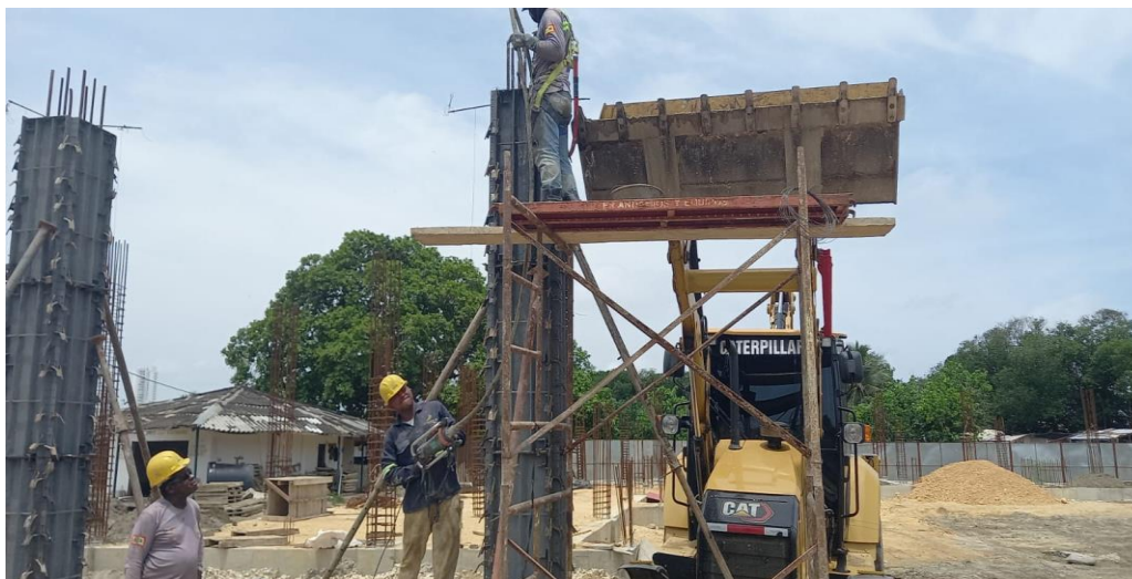
Ilustración 34. Fundida concreto 4000 psi columnas dugout
