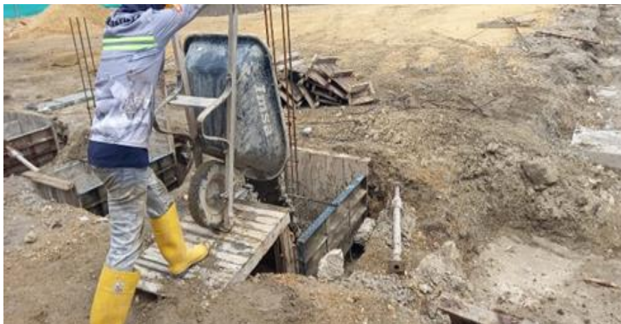
Ilustración 53. Fundida concreto 4000 psi zapatas de cimentación cancha futbol 9
