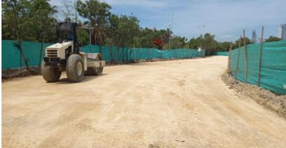
Ilustración 19. Relleno y compactación material seleccionado zona de parqueaderos.
