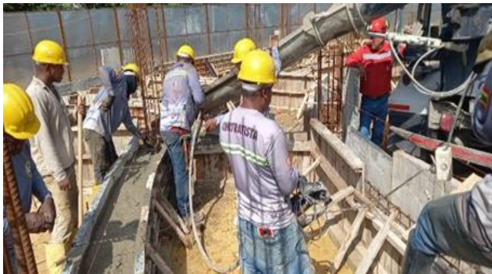
Ilustración 31. Fundida concreto 4000 psi vigas de cimentación graderías cancha de softbol
