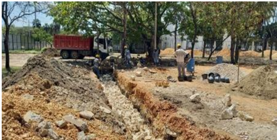
Ilustración 22. Conformación concreto ciclópeo cimentación cerramiento cancha múltiple
