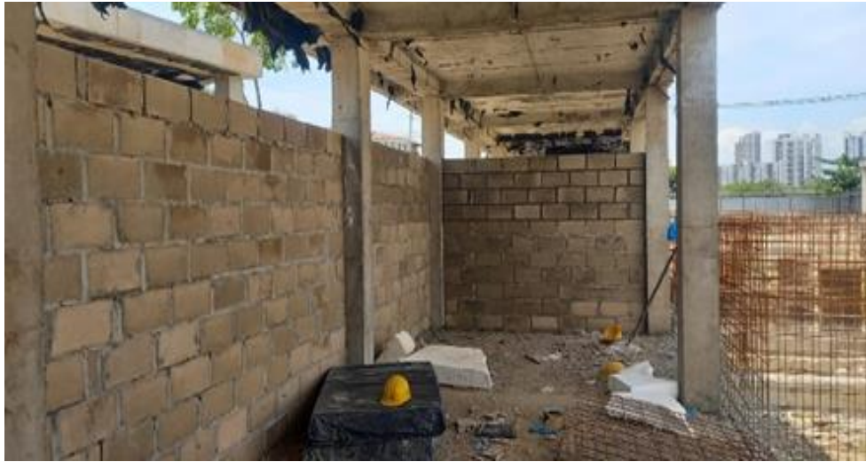
Ilustración 65. Levante en block No 4 baterías sanitarias y camerinos
