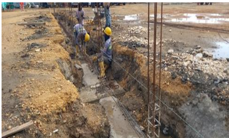
Ilustración 48. Acero refuerzo viga de cimentación cancha futbol 9
