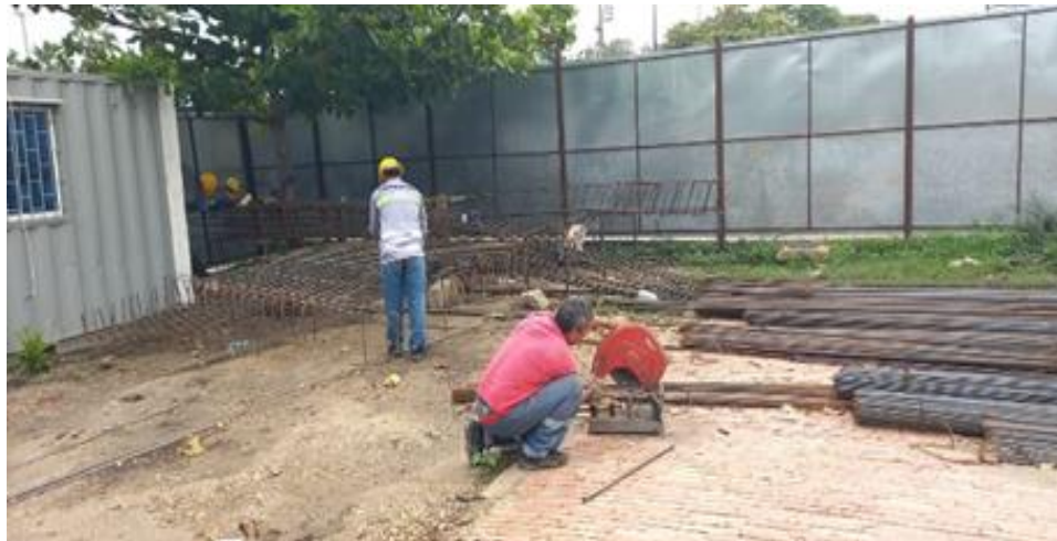
Ilustración 24. Figurado acero 60000 psi zapatas acceso principal
