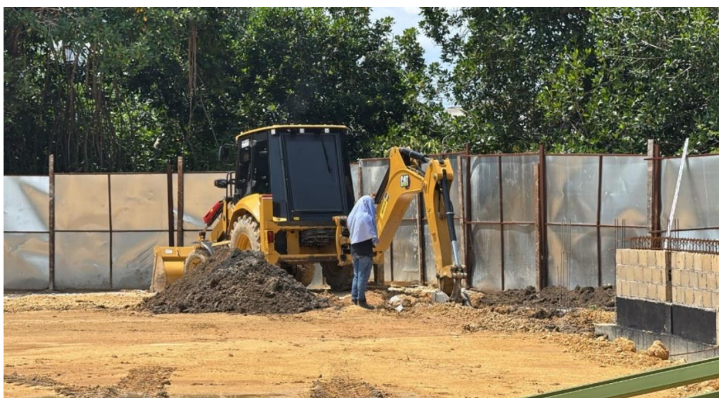
Ilustración 12. Excavación mecánica para cimentación cerramiento cancha de softbol
