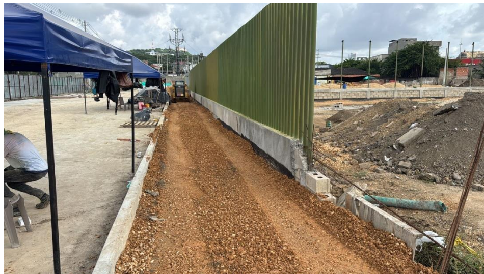
Ilustración 39. Relleno material seleccionado zona peatonal
