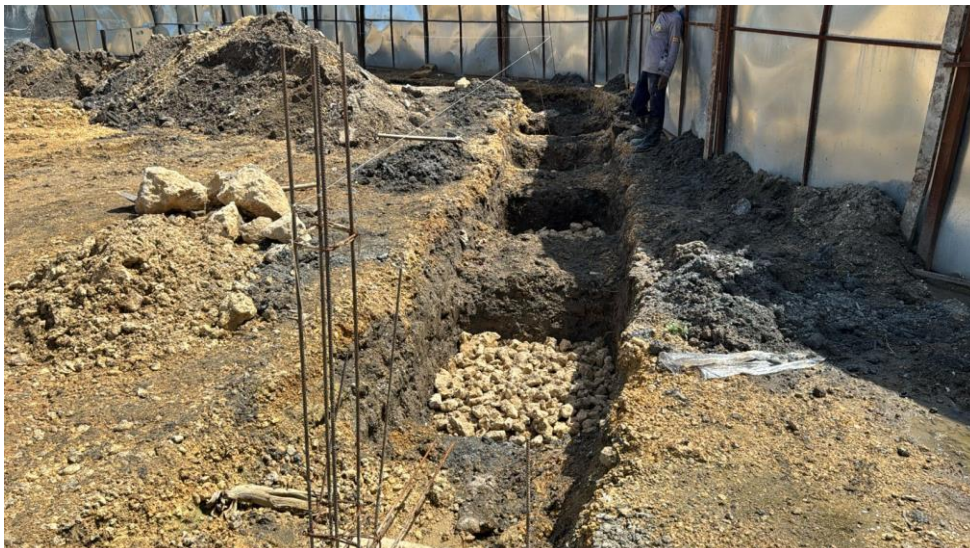
Ilustración 16. Conformación concreto ciclópeo cimentación cerramiento cancha de softbol
