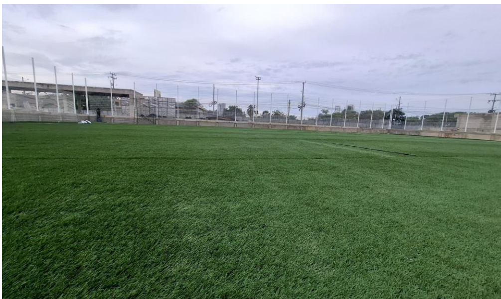
Ilustración 59. Instalación de grama sintética
