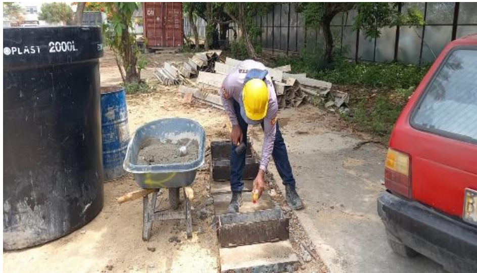
Ilustración 65. Toma de muestras de viguetas de concreto pavimento parqueadero ligas menores
