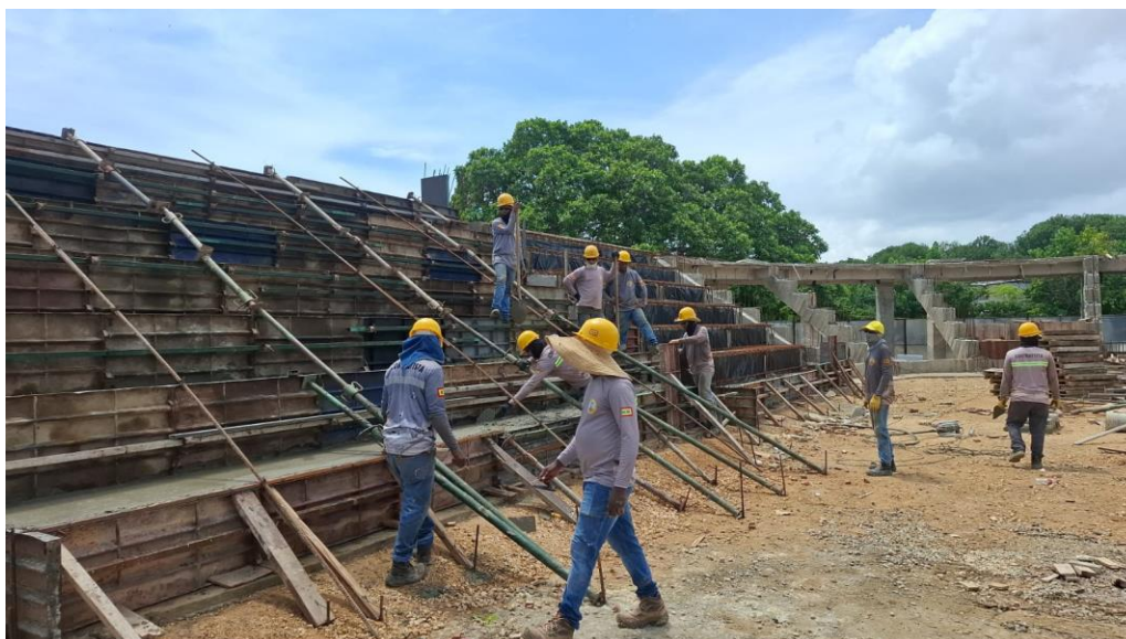
Ilustración 26. Fundida concreto 4000 psi escalones graderías de softbol
