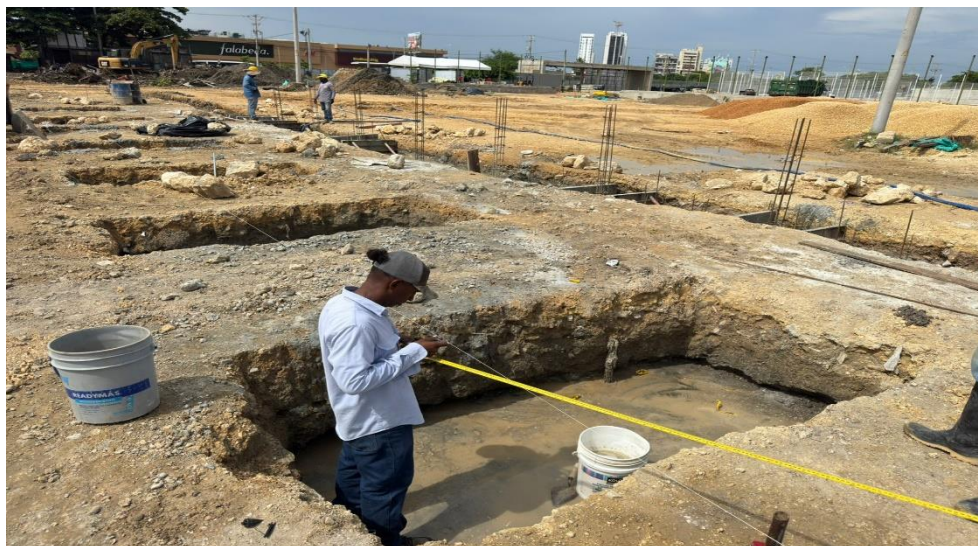
Ilustración 35. Localización y replanteo cimentación graderías cancha futbol 9.
