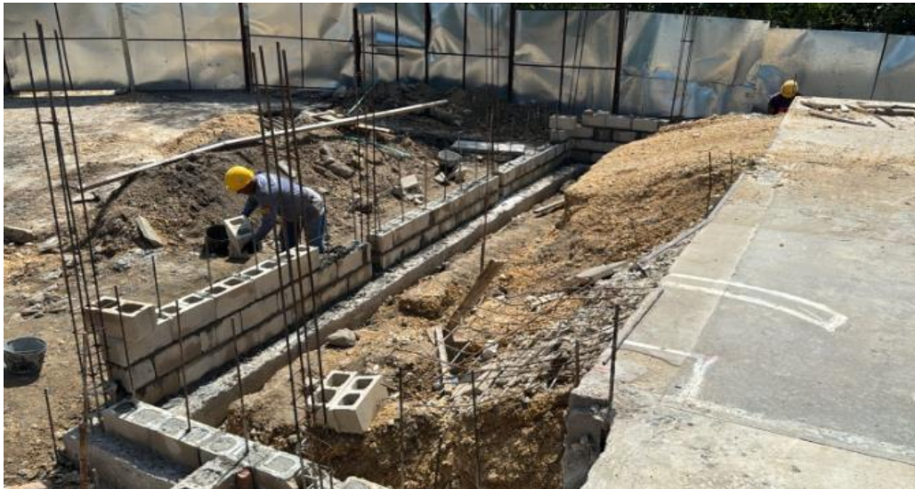
Ilustración 28. Levante en Block No 6 zona de skatepark
