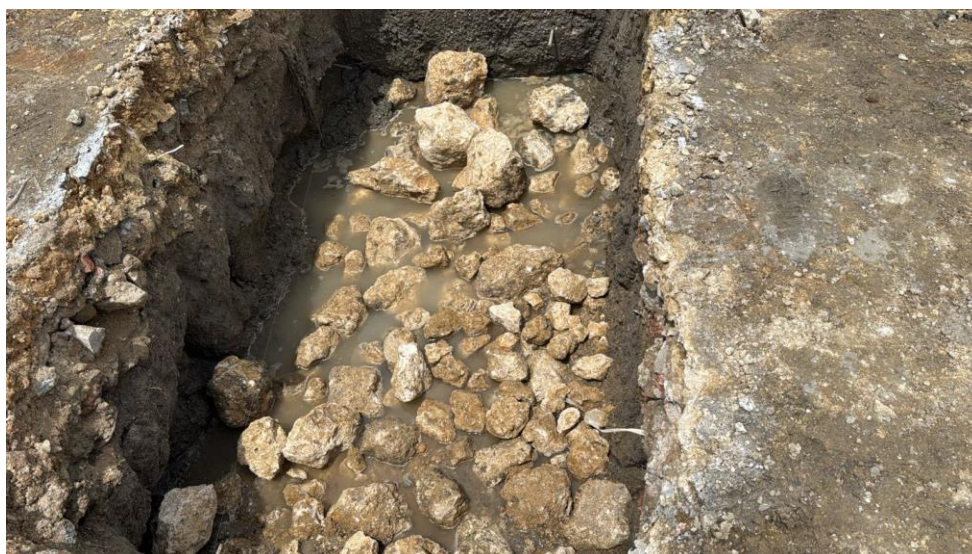
Ilustración 41. Conformación concreto ciclópeo cimentación cerramiento cancha futbol 9
