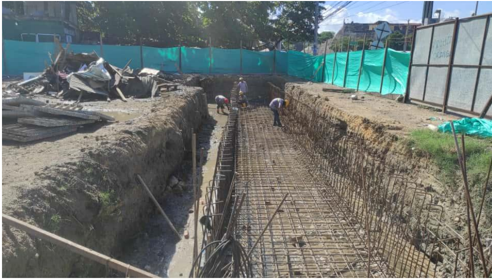
Ilustración 45. Figurado acero de refuerzo de 60.000 psi fondo canal perimetral
