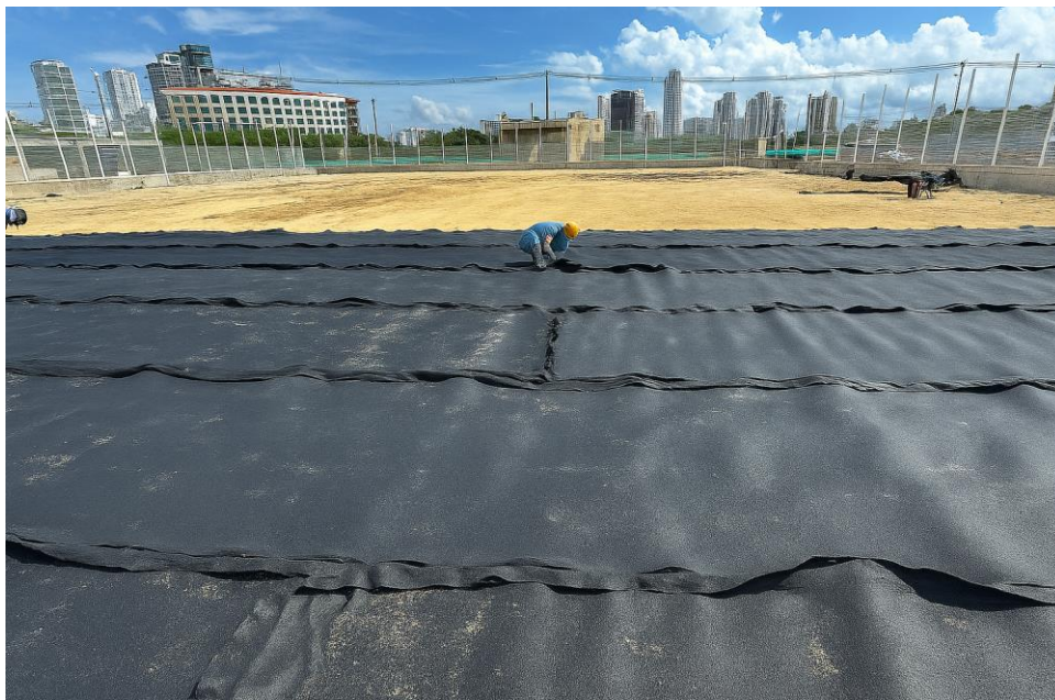
Ilustración 57. Instalación de geodren planar
