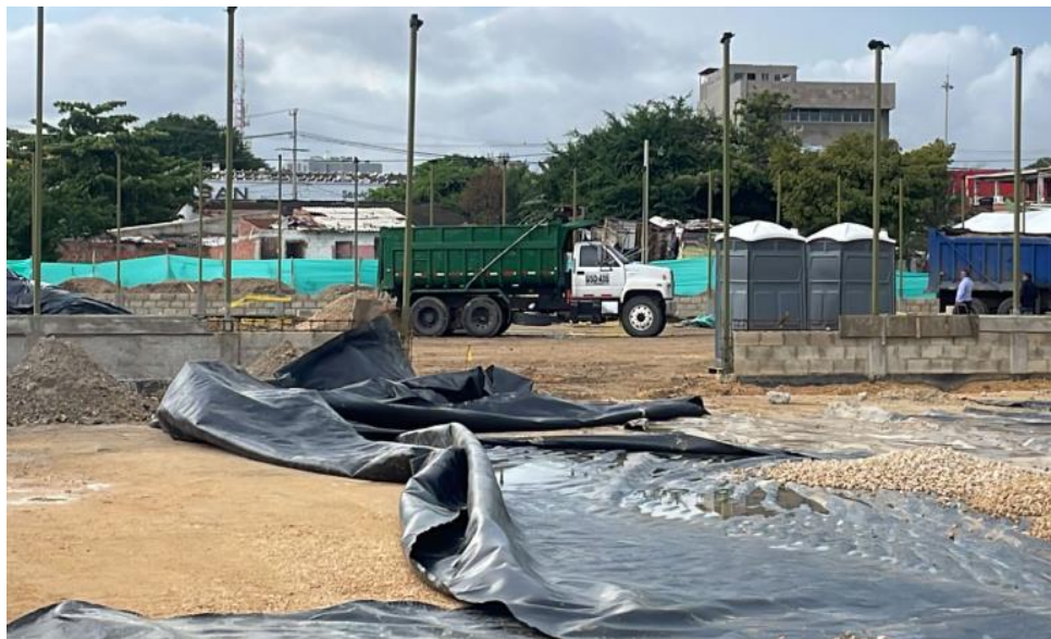
Ilustración 53. Instalación de geomembrana
