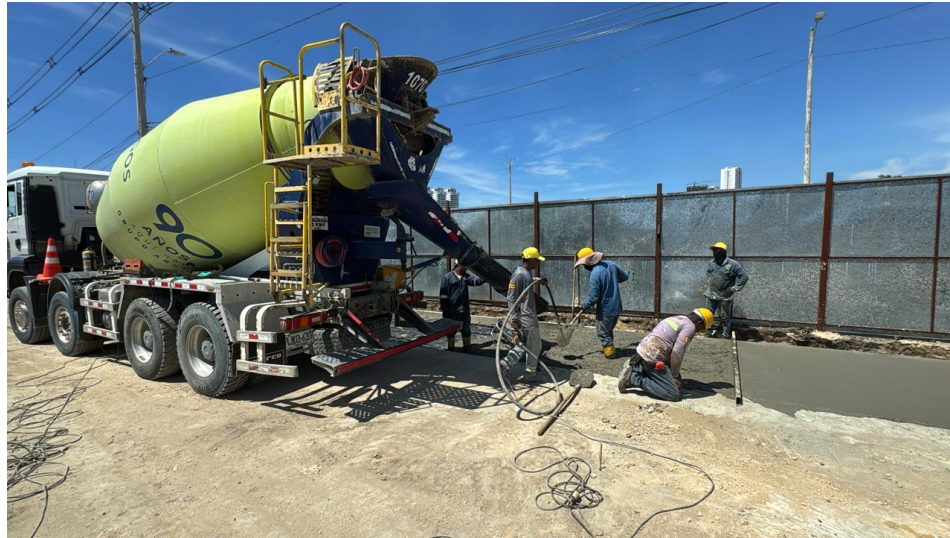
Ilustración 49. Fundida concreto 4000 psi placa de pavimento parqueaderos
