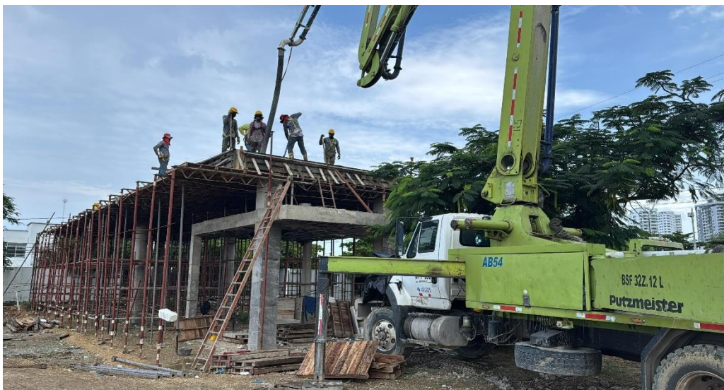
Ilustración 23. Fundida concreto 4000 psi placa 3er nivel acceso principal
