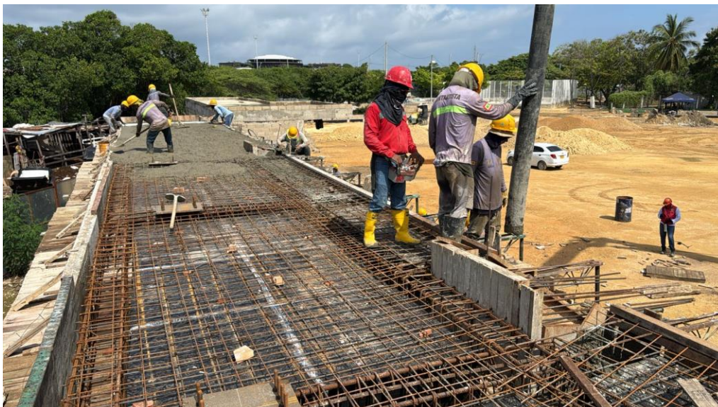
Ilustración 25. Fundida concreto 4000 psi placa graderías cancha de softbol
