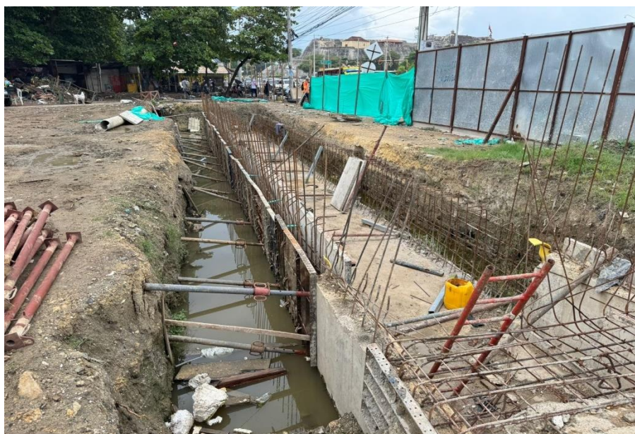
Ilustración 44. Figurado acero de refuerzo 60.000 psi muros canal perimetral
