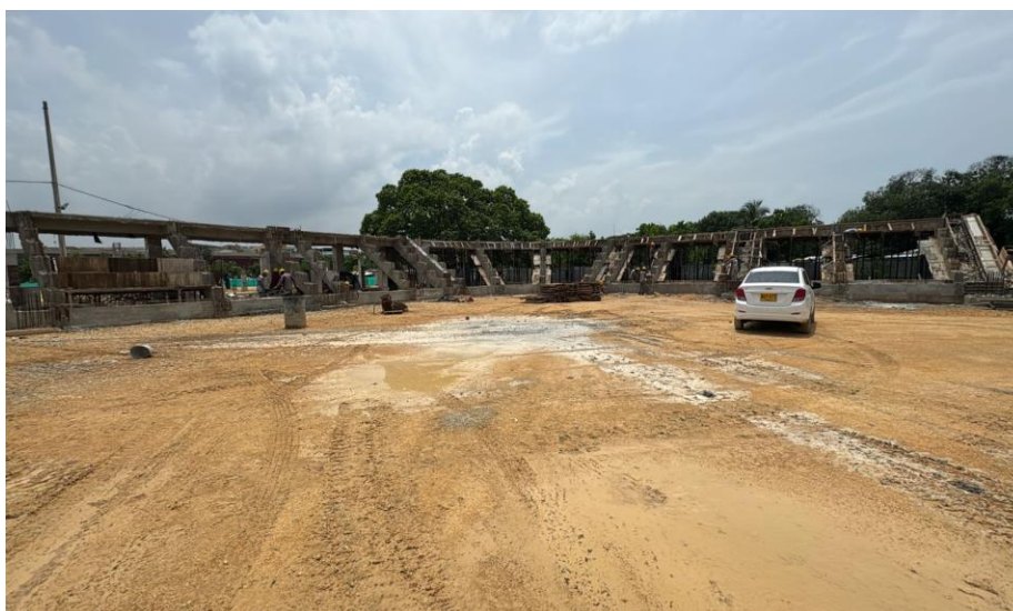
Ilustración 14. Relleno y compactación material seleccionado cancha de softbol.
