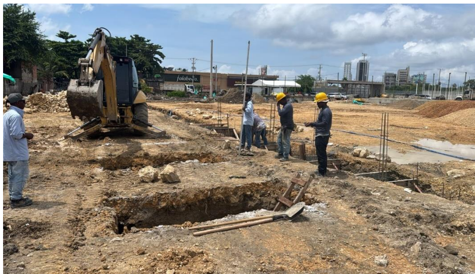
Ilustración 38. Excavación para cimentación graderías cancha futbol 9
