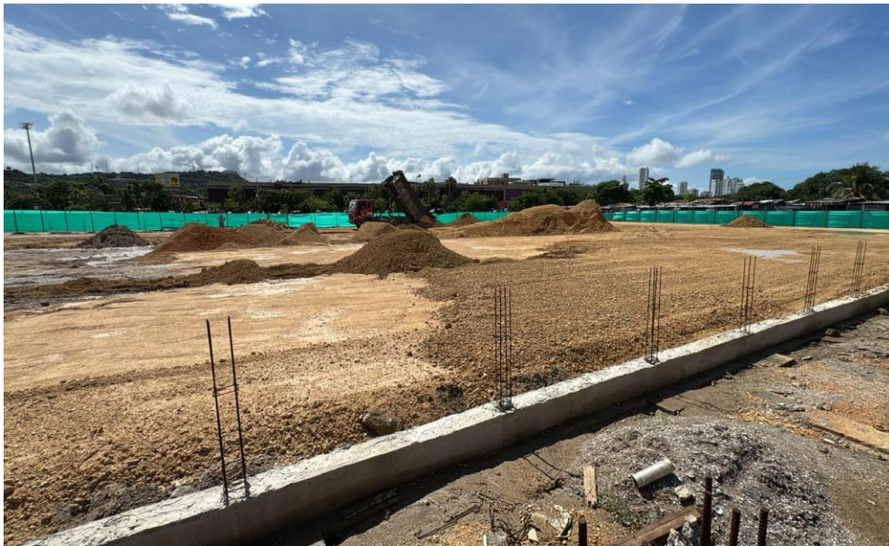
Ilustración 15. Relleno y compactación material seleccionado cancha de futbol
