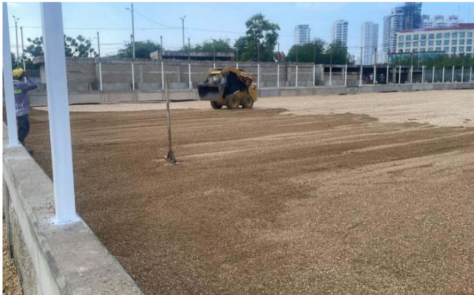
Ilustración 55. Instalación y nivelación de triturado
