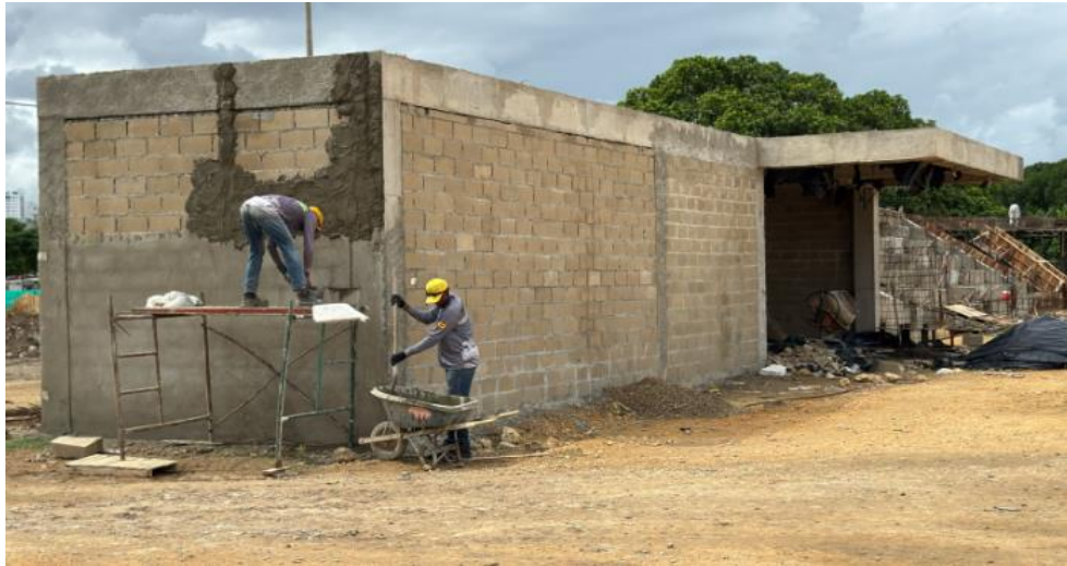
Ilustración 31. Pañete paredes dugout
