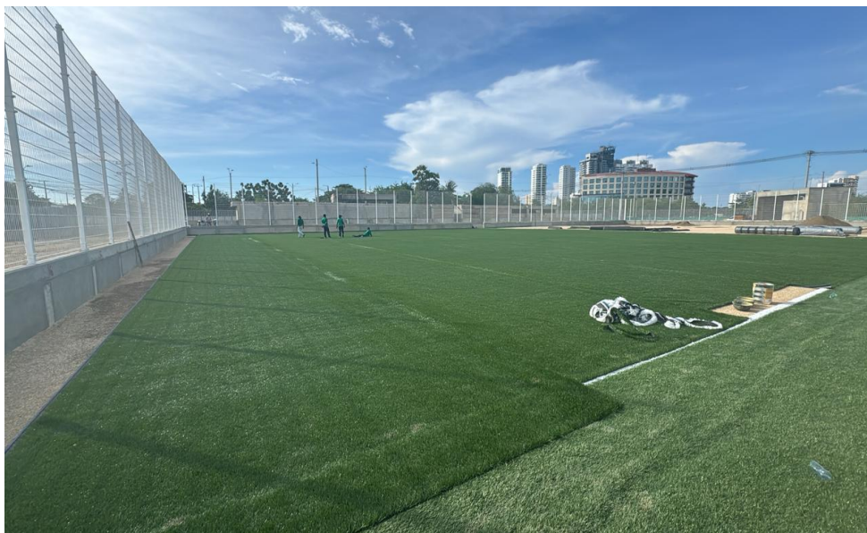
Ilustración 58. Instalación de grama sintética
