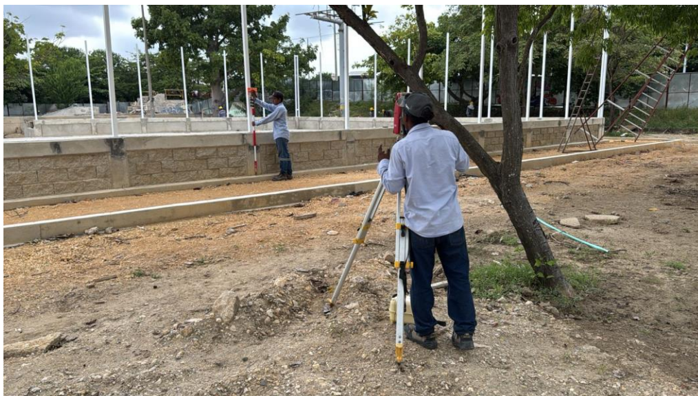
Ilustración 11. Localización y replanteo cancha múltiple
