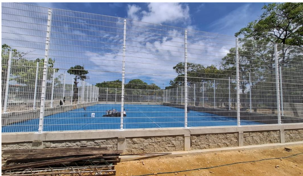
Ilustración 33. Instalación de malla de doble impacto para cerramiento cancha múltiple
