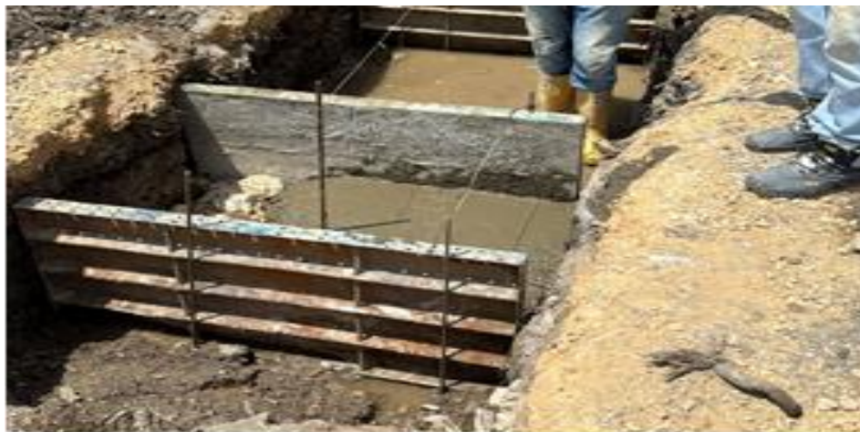
Ilustración 17. Fundida concreto ciclópeo cimentación cerramiento cancha de futbol
