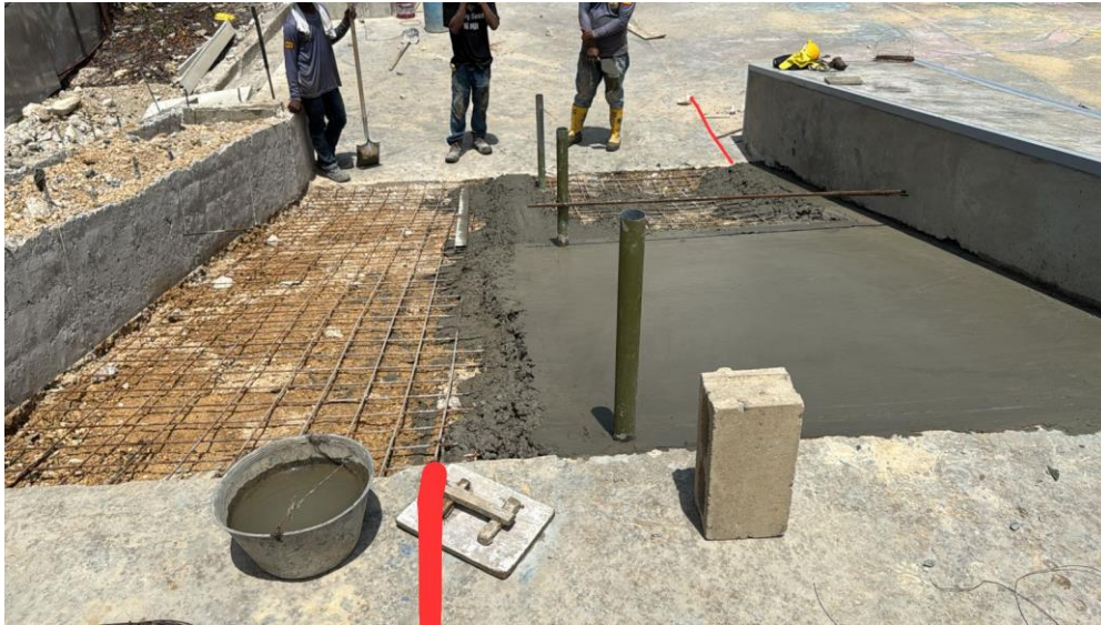
Ilustración 27. Fundida concreto 4000 psi rampa de skatepark
