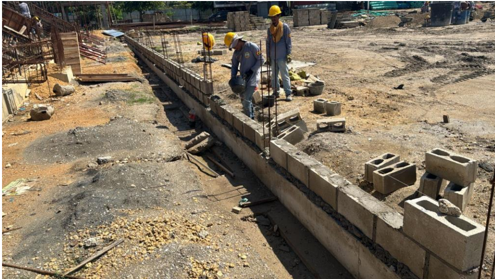
Ilustración 29. Levante en Block No 6 cerramiento cancha de futbol
