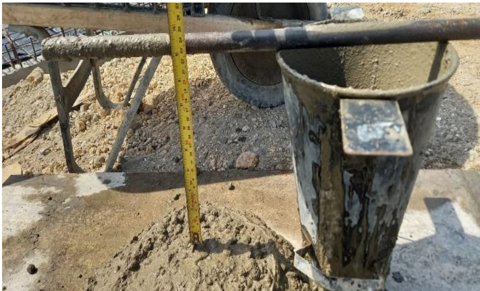
Ilustración 66. Toma de muestras de asentamiento concreto escalones graderías de softbol
