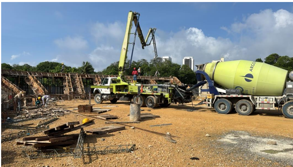
Ilustración 23. Fundida concreto 4000 psi placa 3er nivel acceso principal
