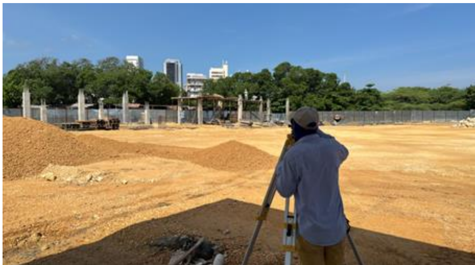
Ilustración 10. Localización y replanteo terreno cancha de softbol
