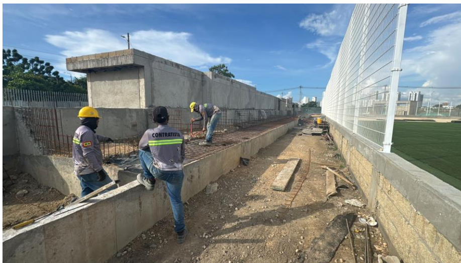
Ilustración 43. Figurado acero de refuerzo 60.000 psi muros escalinatas cancha futbol 11
