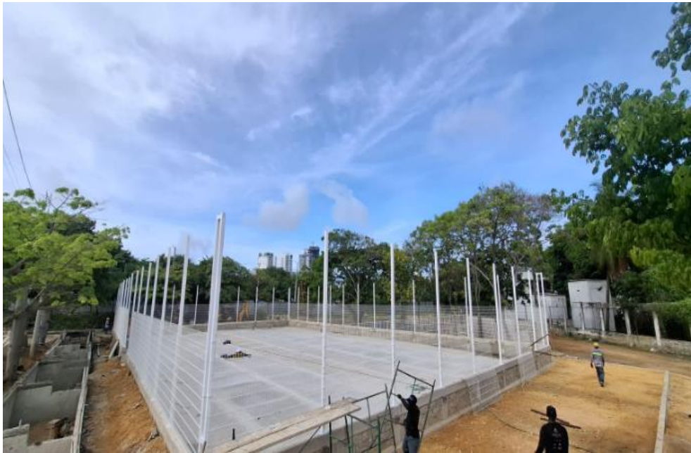
Ilustración 32. Instalación de malla de doble impacto para cerramiento cancha múltiple
