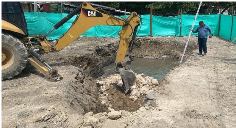
Ilustración 37. Excavación mecánica para faltante canal perimetral
