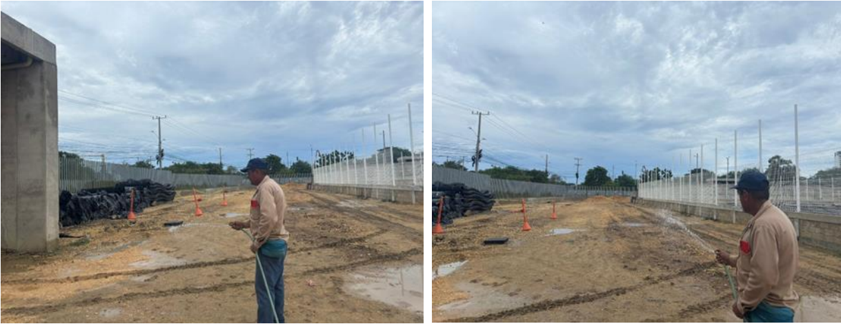
Ilustración 79. Riego de agua contra el polvo
