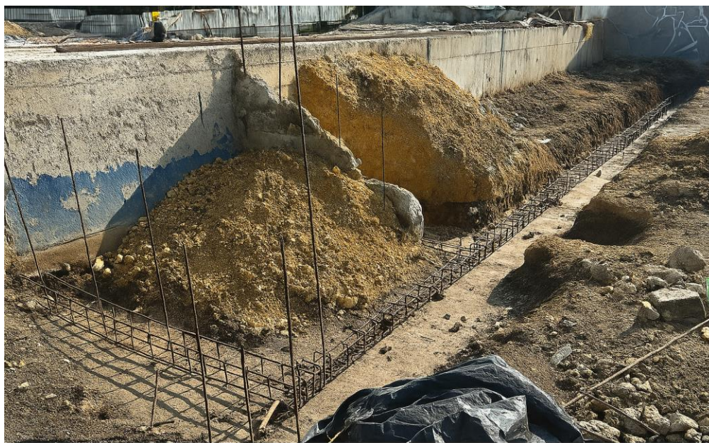
Ilustración 22. Figurado acero 60000 psi vigas cimentación escalinata cancha múltiple
