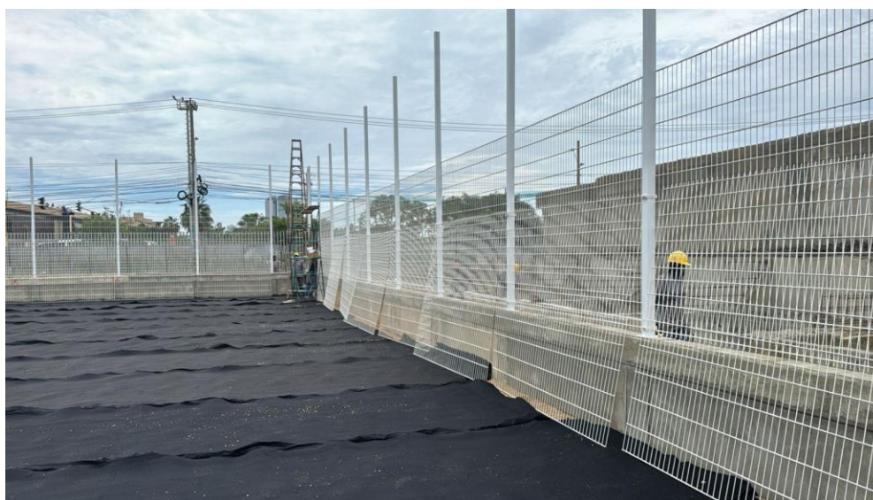
Ilustración 60. Instalación de malla de alto impacto para cerramiento
