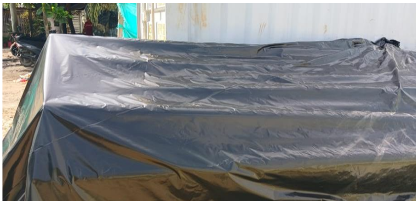
Ilustración 78. Carpado de materiales
