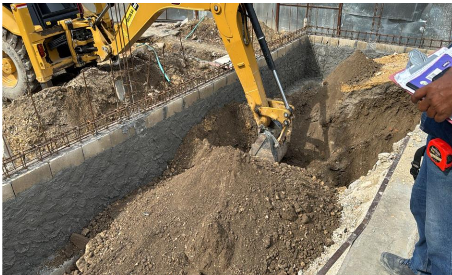
Ilustración 13. Excavación mecánica para rampa skatepark
