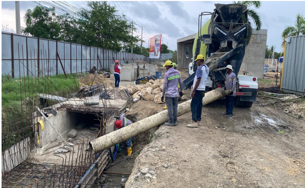
Ilustración 46. Fundida concreto 4000 psi fondo canal perimetral
