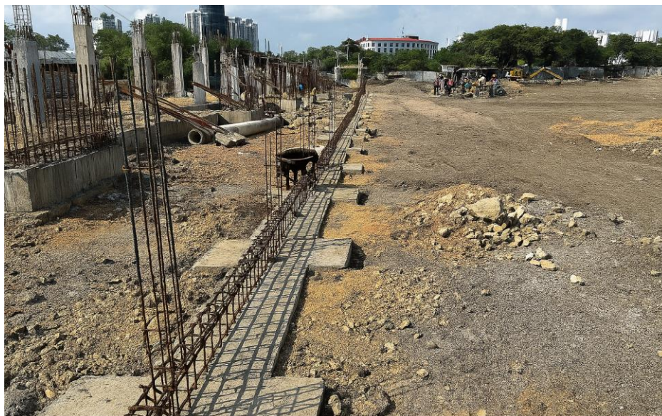
Ilustración 20. Figurado acero 60000 psi vigas cimentación cerramiento cancha de futbol
