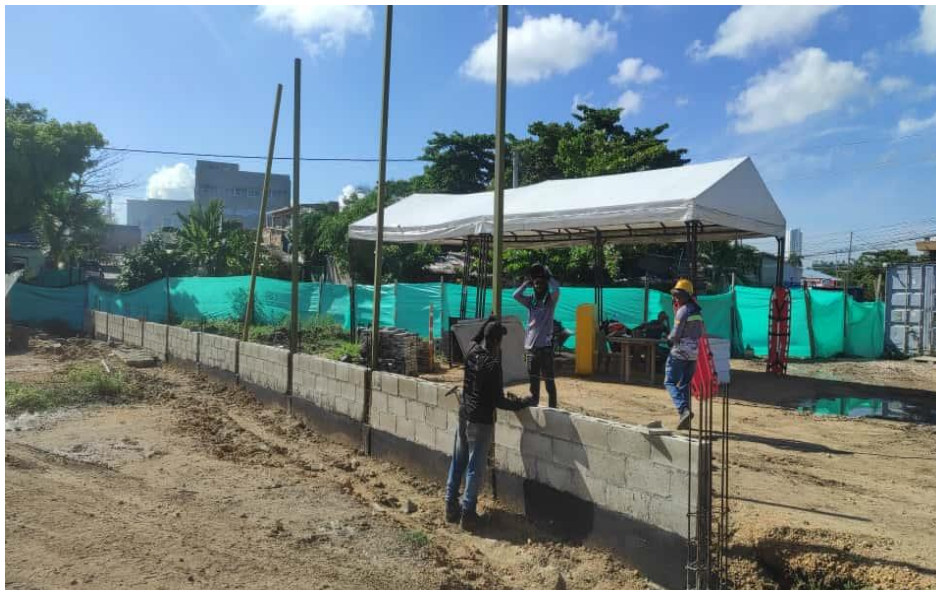
Ilustración 50. Levante en block No 6 muro de cerramiento cancha futbol 9
