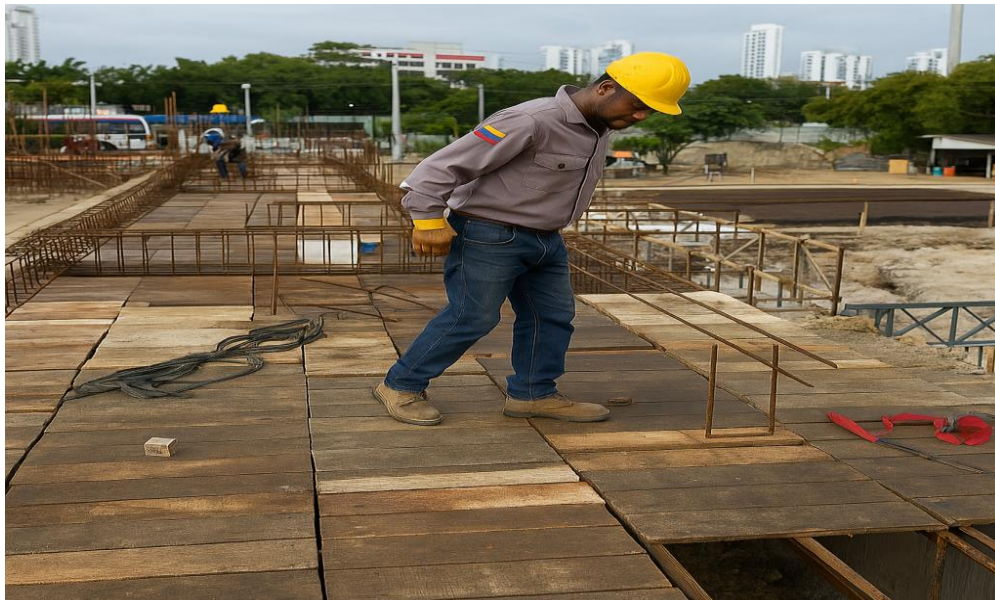
Ilustración 21. Figurado acero 60000 psi vigas y placa graderías cancha de futbol
