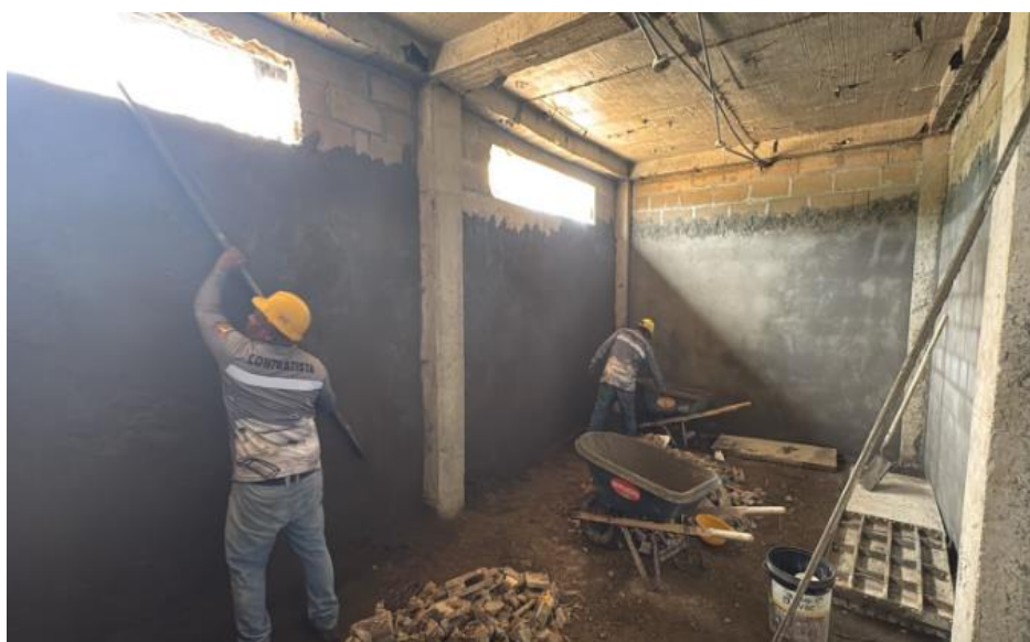
Ilustración 52. Pañete baterías de baños y camerinos
