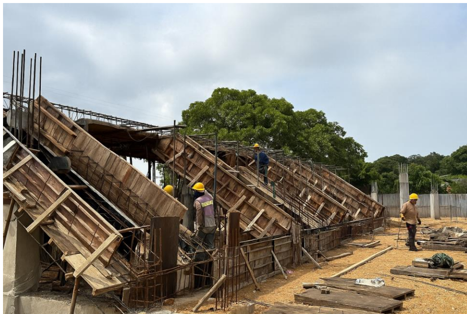
Ilustración 19. Figurado acero 60000 psi placa graderías de softbol
