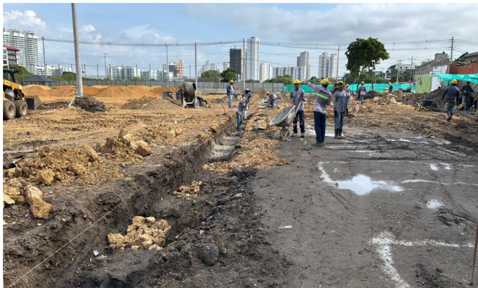
Ilustración 41. Conformación concreto ciclópeo cimentación cerramiento cancha futbol 9
