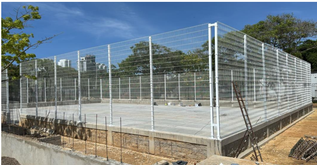
Ilustración 33. Instalación de malla de doble impacto para cerramiento cancha múltiple
