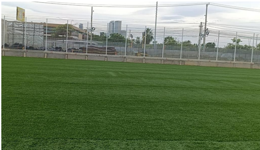
Ilustración 61. Instalación de malla de alto impacto para cerramiento
