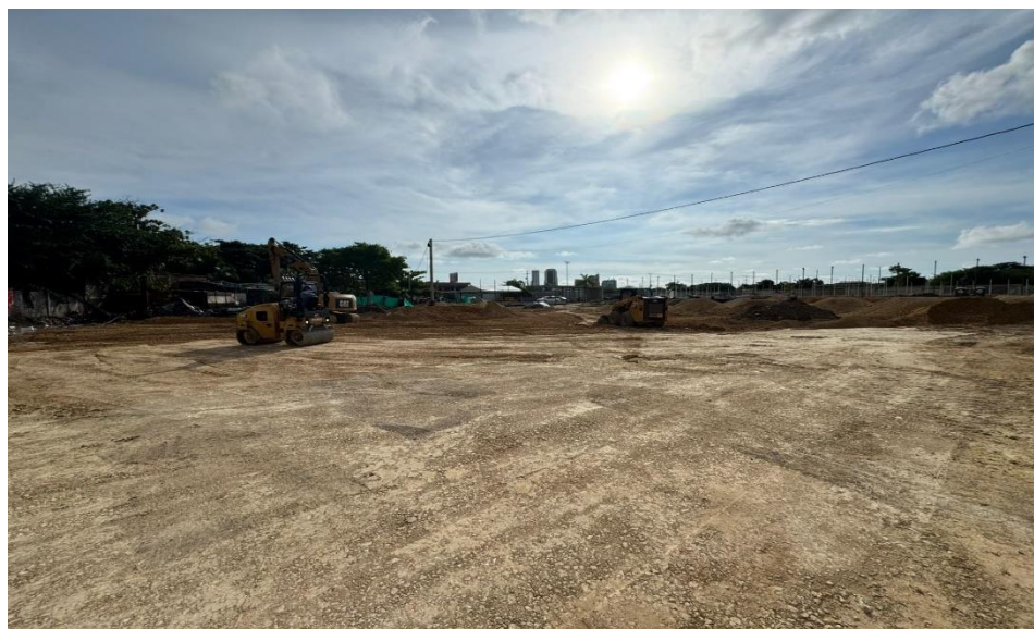
Ilustración 40. Relleno y compactación material seleccionado cancha futbol 9
