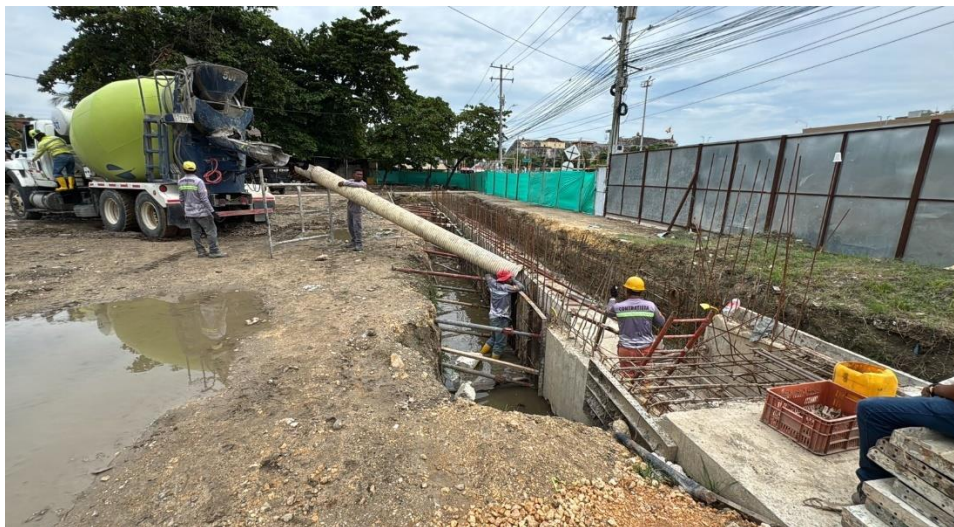
Ilustración 47. Fundida concreto 4000 psi muros canal perimetral
