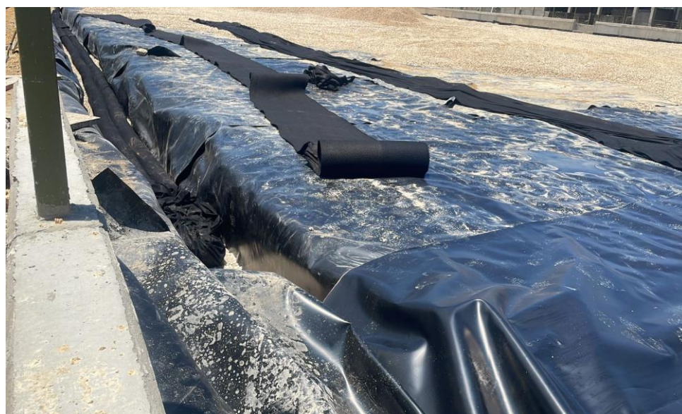
Ilustración 54. Instalación de tubería perforada y geotextil
