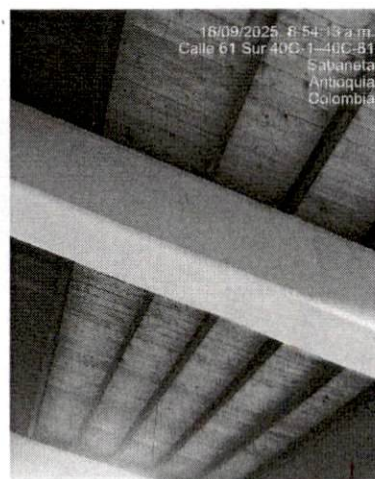
Instalación de tablilla
