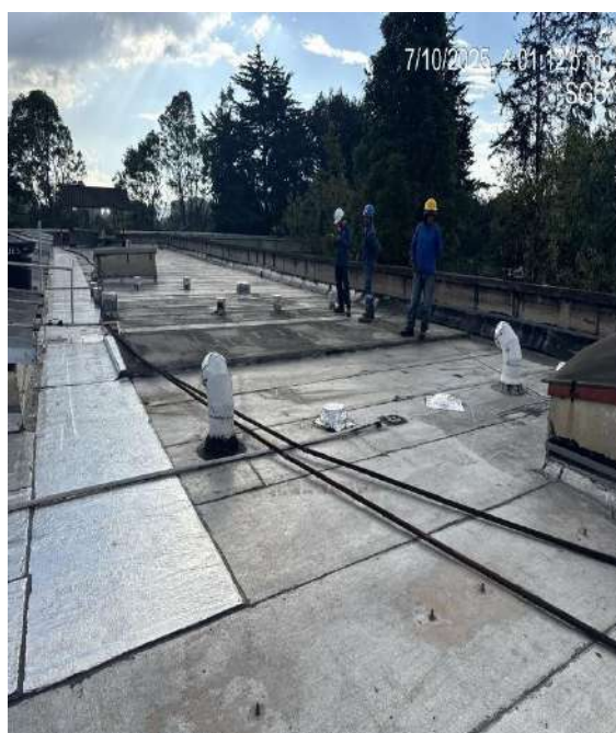
Instalación de manto para mejoramiento de pendientado en cubierta del bloque A
