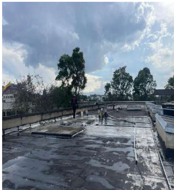
Instalación de manto para mejoramiento de pendientado en cubierta del bloque A
