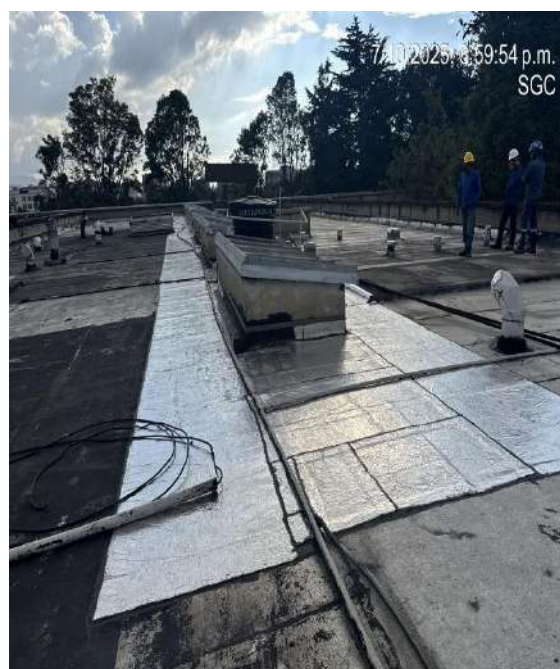
Instalación de manto para mejoramiento de pendientado en cubierta del bloque A
