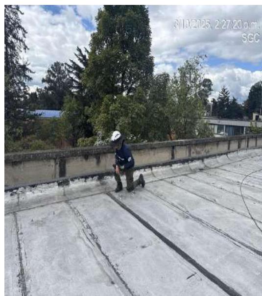
Instalación de manto para mejoramiento de pendientado en cubierta del bloque A
