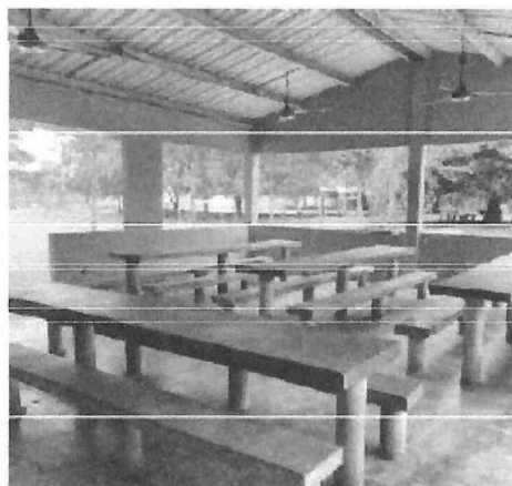
Ilustración 11. Área de comedor existente - Tierralta
