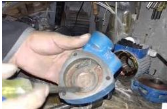
Mantenimiento de bomba y empaquetadura
