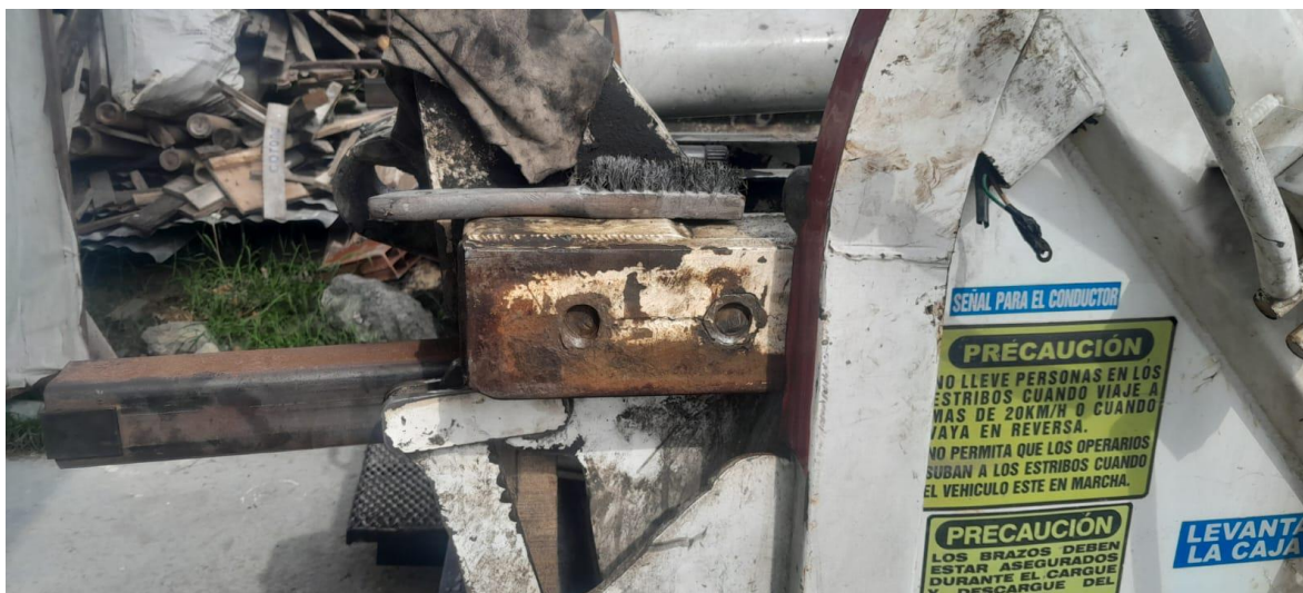
Desmante de sistema para reemplazo de piezas
