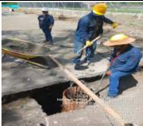
se realiza vaciado de pilotes
