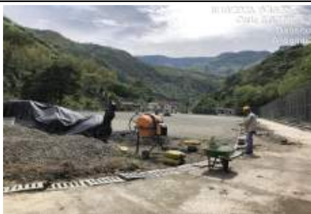
se realiza vaciado para caja de inspeccion
