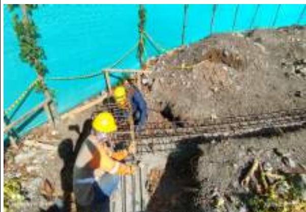
se realiza corte y figuracion de acero
