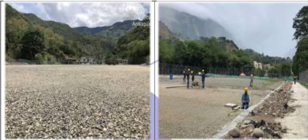
Se realiza nivelación de triturado existente.
