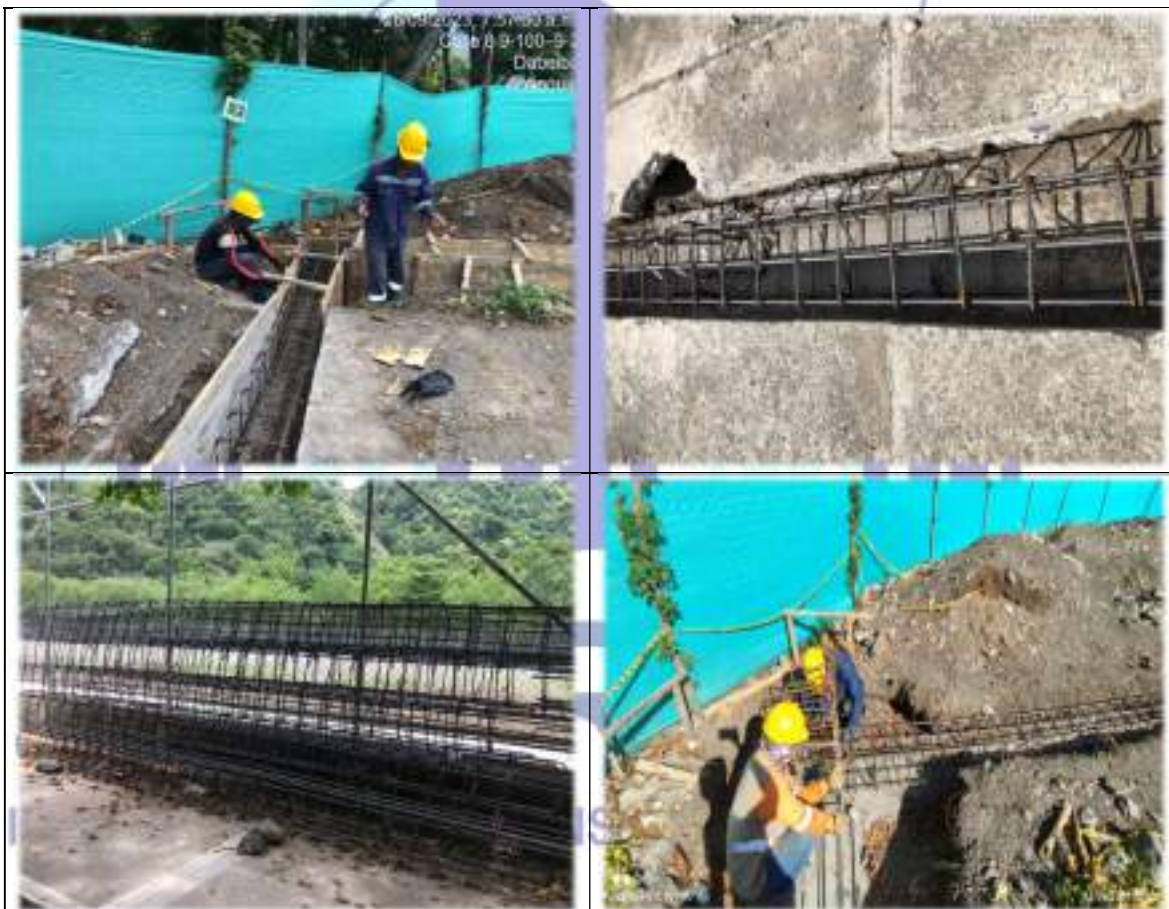
Se realiza corte, figuración e instalación de acero de estructural.
