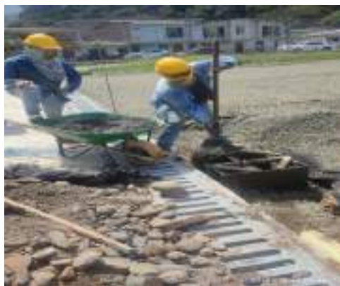
se realiza vaciado para caja de inspeccion
