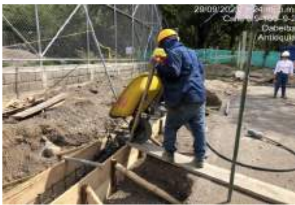
se realiza vaciado de viga de fundacion
