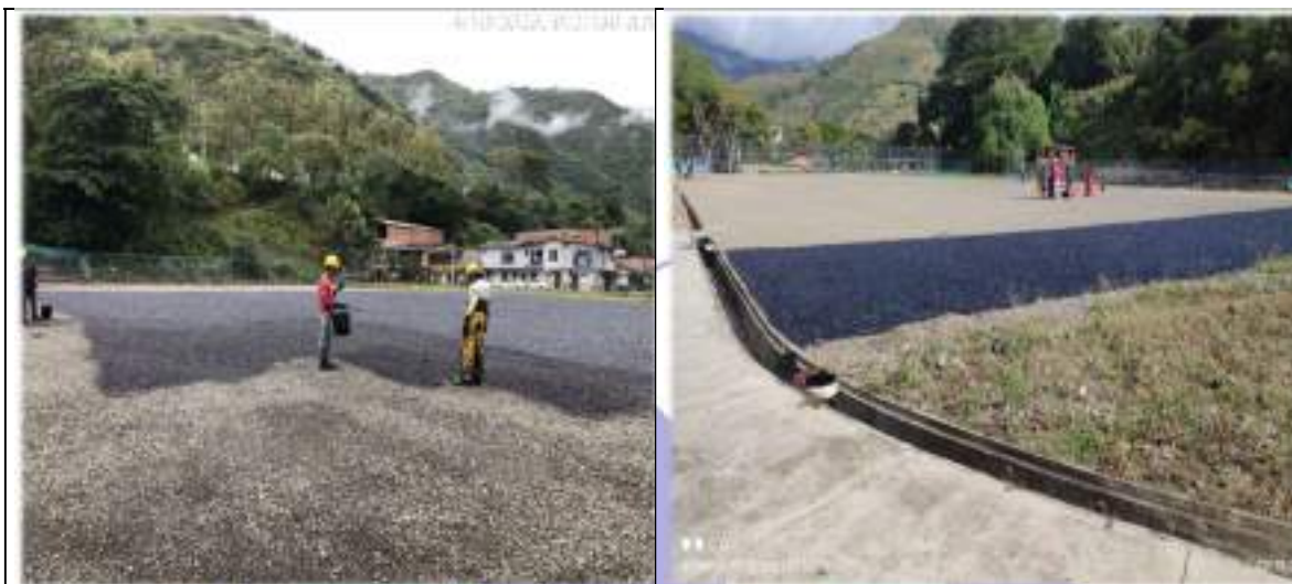
Se realiza imprimación sobre base granular.
