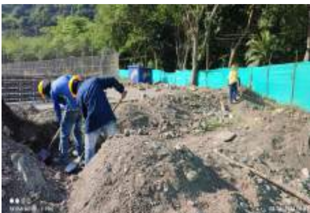
se realiza lleno y compatacion de zapatas
