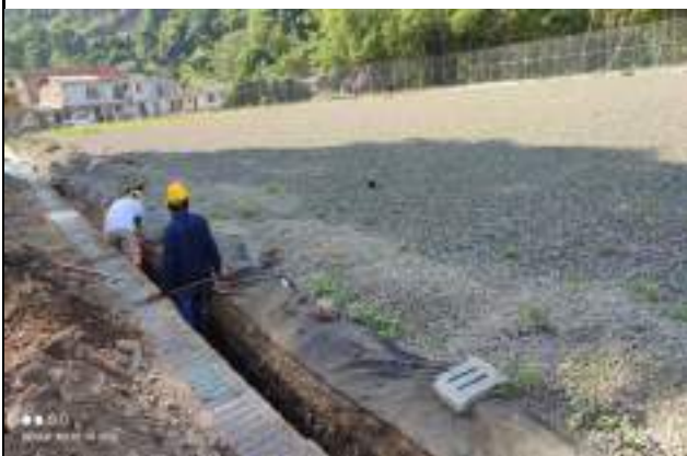
se realiza excavacion para la instalacion de tuberia de 6"
