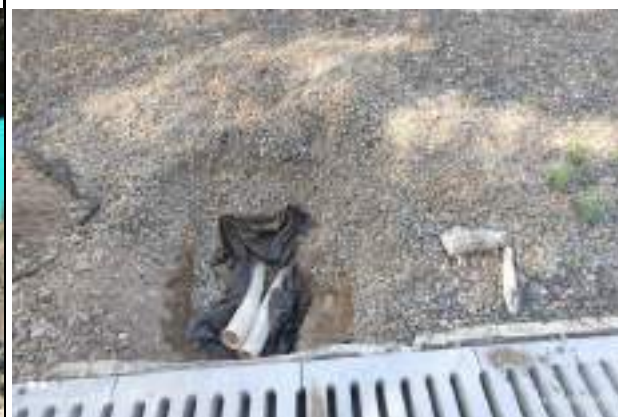
se realiza excavacion para la contruccion de caja de inspeccion
