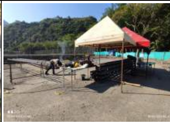
se realiza corte y figuracion de estructura metalica
