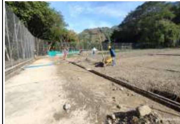
se realiza nivelacion de triturado
