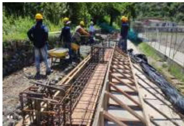
se realiza vaciado de graderias
