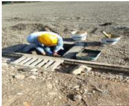
se realiza vaciado para caja de inspeccion
