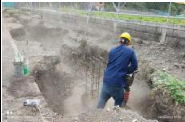
se realiza lleno y compactacion de zapatas
