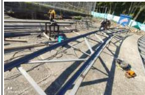
se realiza corte y figuracion de estructura metalica
