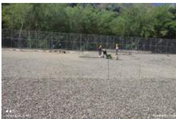
se realiza renivelacion de triturada
