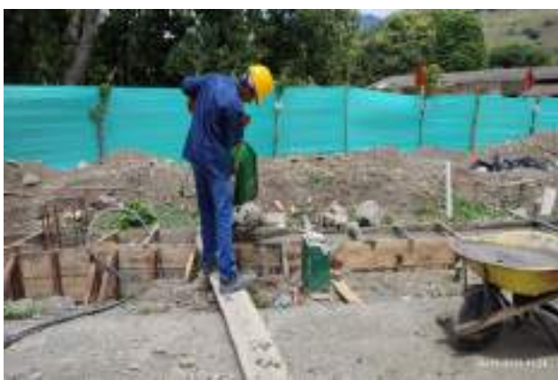
se realiza vaciado de viga de fundacion
