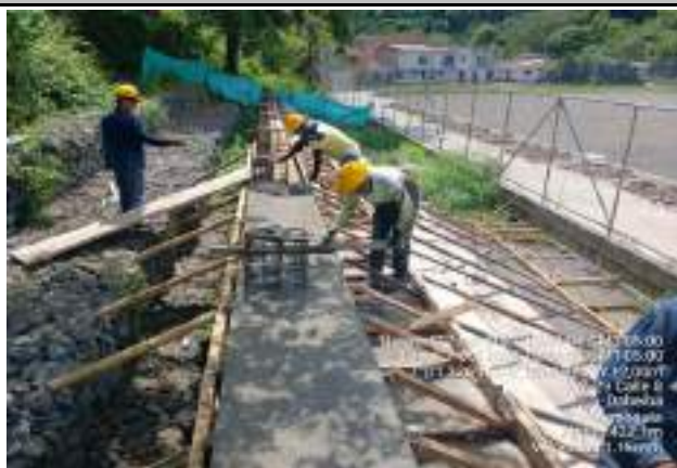
se realiza vaciado de graderia
