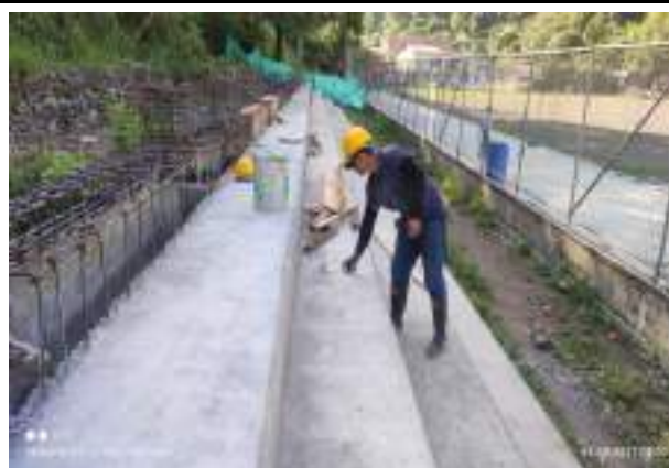
se realiza encofrado de graderia
