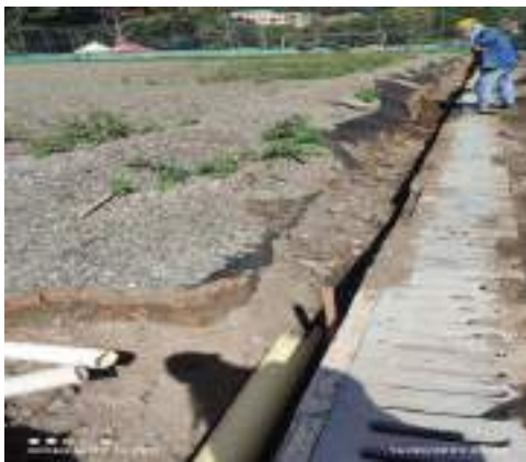
se realiza instalacion de tuberia de 6"
