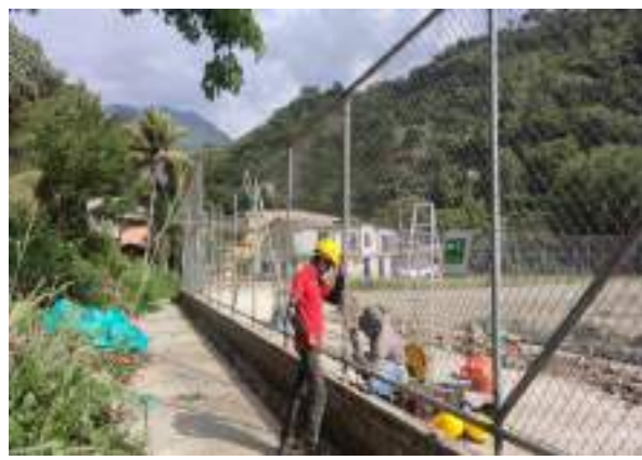
se realiza cerramiento de malla eslabonada
