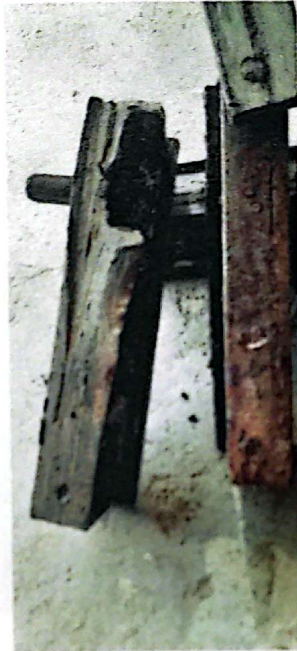
Daño de guías internas de compactador
