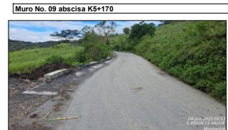
Carpeta asfáltica y cunetas terminadas en muro No. 9.
