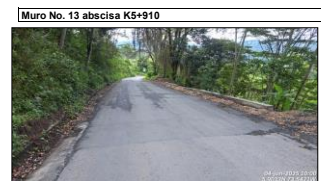
Carpeta asfáltica terminada en muro No. 13.
