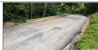
Instalación de mezcla asfáltica en muro No. 12.
