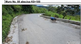
Carpeta asfáltica y cunetas terminadas en muro No. 8.
