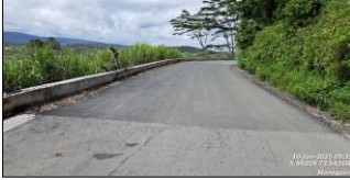
Carpeta asfáltica en muro No. 7A.
