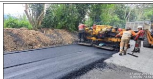
Instalación de mezcla asfáltica en muro No. 11.
