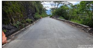
Carpeta asfáltica terminada en muro No. 1.
