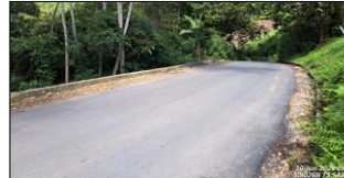
Carpeta asfáltica terminada en muro No. 12.
