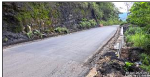
Carpeta asfáltica terminada en muro No. 1.
