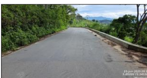
Carpeta asfáltica terminada en muro No. 3.
