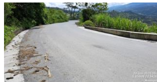
Carpeta asfáltica y cunetas terminadas en muro No. 8.
