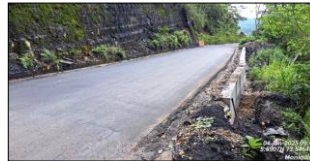
Carpeta asfáltica terminada en muro No. 1.
