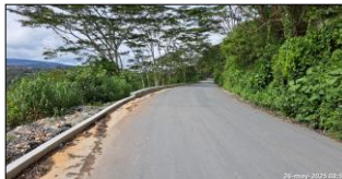
Carpeta asfáltica y cunetas terminadas en muro No. 4.
