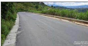
Carpeta asfáltica terminada en muro No. 4.
