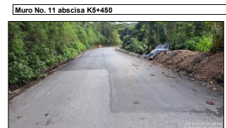
Carpeta asfáltica terminada en muro No. 11.
