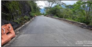
Carpeta asfáltica terminada en muro No. 1.
