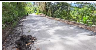
Carpeta asfáltica terminada en muro No. 13.
