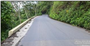
Carpeta asfáltica terminada en muro No. 2.
