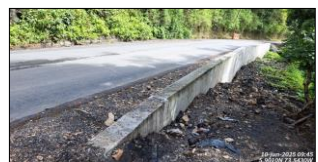
Carpeta asfáltica terminada en muro No. 11.
