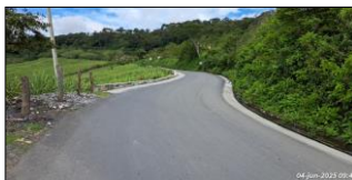
Carpeta asfáltica y cunetas terminadas en muro No. 6.
