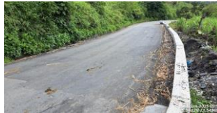
Carpeta asfáltica en muro No. 7A.
