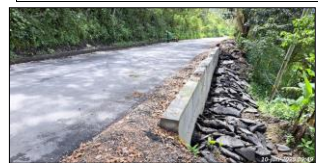
Carpeta asfáltica terminada en muro No. 13.
