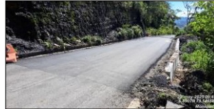
Instalación de mezcla asfáltica en muro No. 1.
