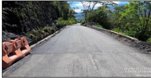
Instalación de mezcla asfáltica en muro No. 1.
