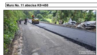
Instalación de mezcla asfáltica en muro No. 11.
