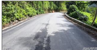
Carpeta asfáltica terminada en muro No. 11.
