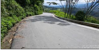
Carpeta asfáltica y cunetas terminadas en muro No. 7.
