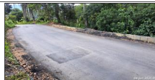
Carpeta asfáltica terminada en muro No. 12.
