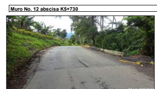
Carpeta asfáltica terminada en muro No. 12.
