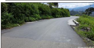
Carpeta asfáltica y cunetas terminadas en muro No. 6.
