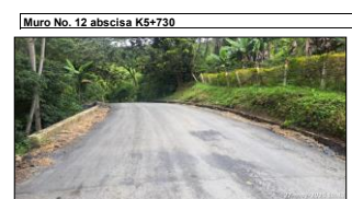
Instalación de mezcla asfáltica en muro No. 12.
