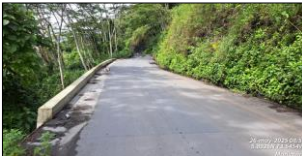
Carpeta asfáltica terminada en muro No. 2.
