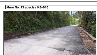
Instalación de mezcla asfáltica en muro No. 13.
