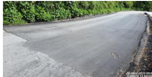
Instalación de mezcla asfáltica en muro No. 7A.
