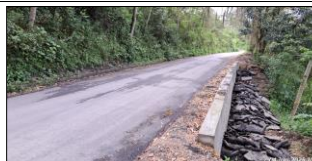
Carpeta asfáltica terminada en muro No. 13.
