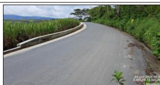
Carpeta asfáltica y cunetas terminadas en muro No. 5.
