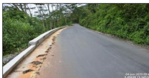
Carpeta asfáltica terminada en muro No. 3.
