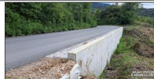
Carpeta asfáltica y cunetas terminadas en muro No. 10.
