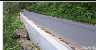
Carpeta asfáltica y cunetas terminadas en muro No. 3.
