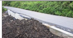
Carpeta asfáltica y cunetas terminadas en muro No. 9.
