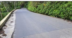
Carpeta asfáltica terminada en muro No. 2.
