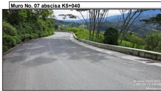
Carpeta asfáltica y cunetas terminadas en muro No. 7.
