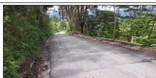
Instalación de mezcla asfáltica en muro No. 13.
