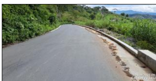
Carpeta asfáltica terminada en muro No. 4.
