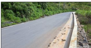
Carpeta asfáltica terminada en muro No. 4.
