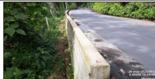
Carpeta asfáltica y cunetas terminadas en muro No. 2.
