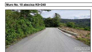
Carpeta asfáltica y cunetas terminadas en muro No. 10.
