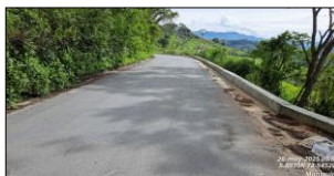
Carpeta asfáltica terminada en muro No. 3.
