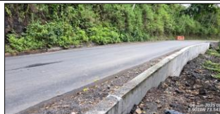
Carpeta asfáltica terminada en muro No. 11.
