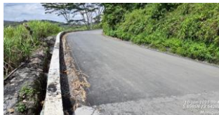
Carpeta asfáltica en muro No. 7A.
