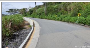
Carpeta asfáltica y cunetas terminadas en muro No. 5.
