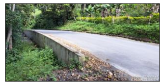
Carpeta asfáltica terminada en muro No. 12.
