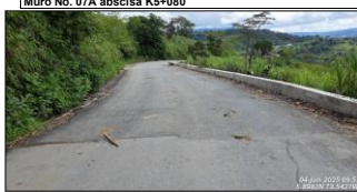
Carpeta asfáltica en muro No. 7A.
