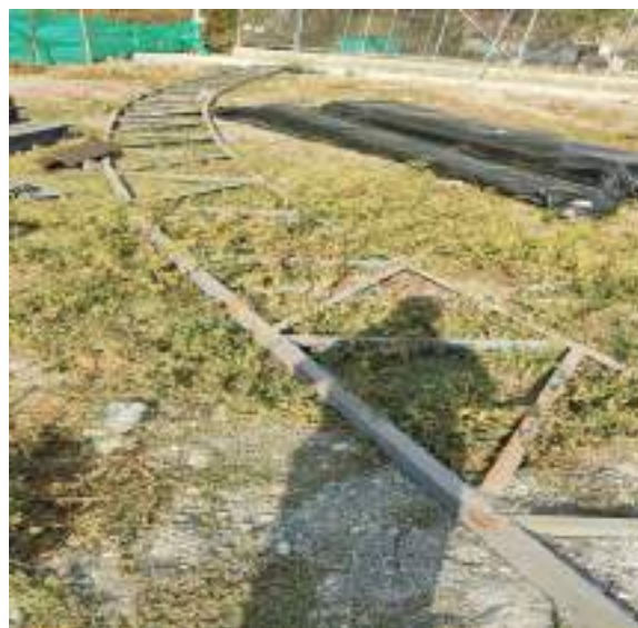
Figura 5. Arco dañado.
