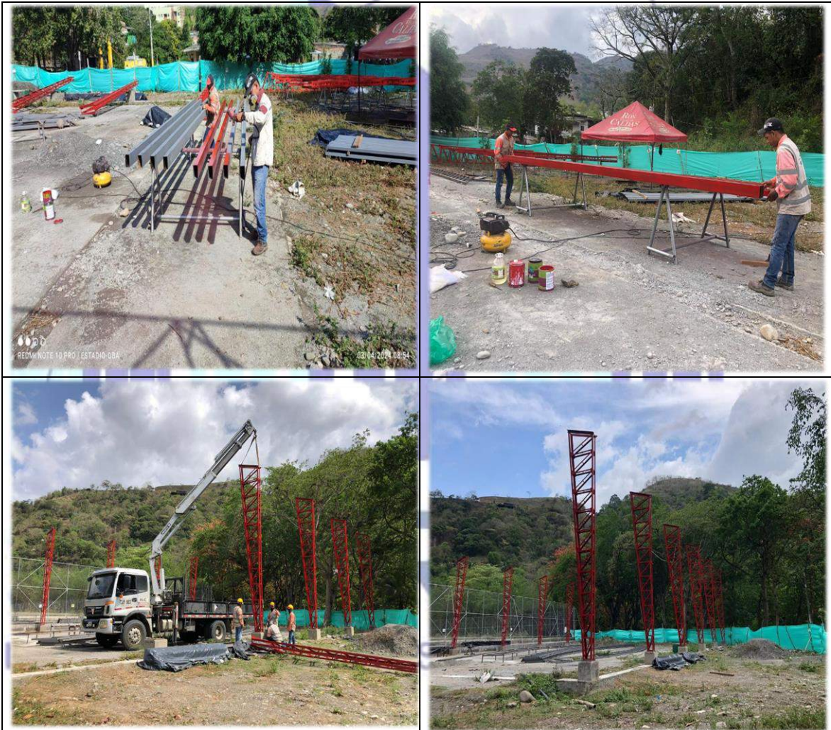
Se realiza el izaje de columnas de cubierta placa polideportiva.
