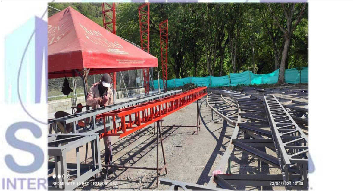
Se realiza aplicación de pintura en elementos de estructura metálica placa polideportiva.
