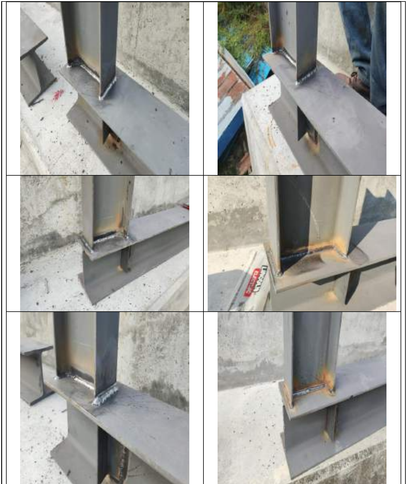
Figura 7. Reparaciones de los defectos.
