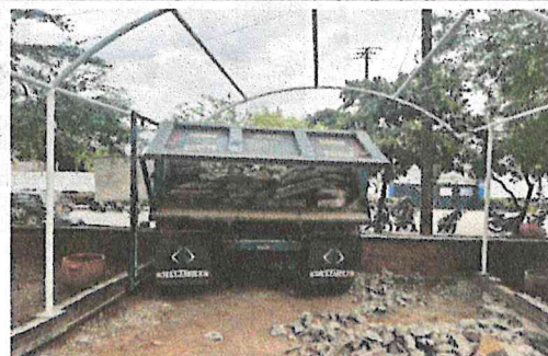
Demolicion placas macizas de e< 0.10 m, incluye retiro
