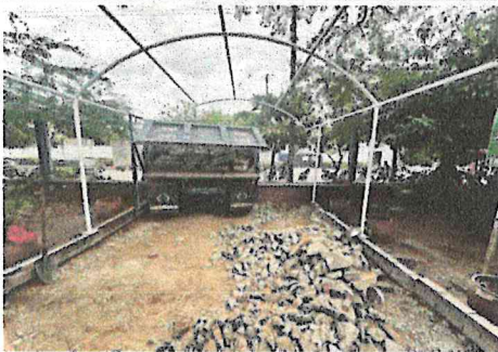
Demolicion placas macizas de e< 0.10 m, incluye retiro
