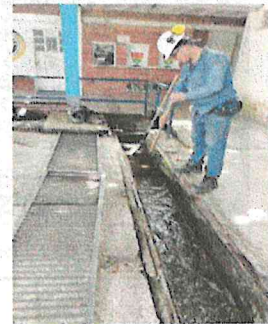
Limpieza de cunetas (con retiro max. 2 km)
