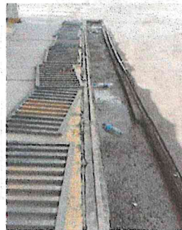
Limpieza de cunetas (con retiro max. 2 km)
