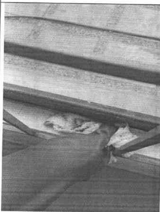
Ilustración 7. Limpieza de ventanería.
