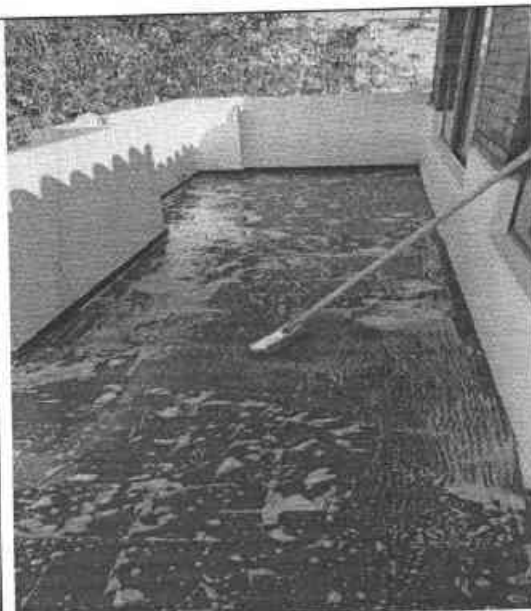
Ilustración 2. Actividad de limpieza en terraza.
