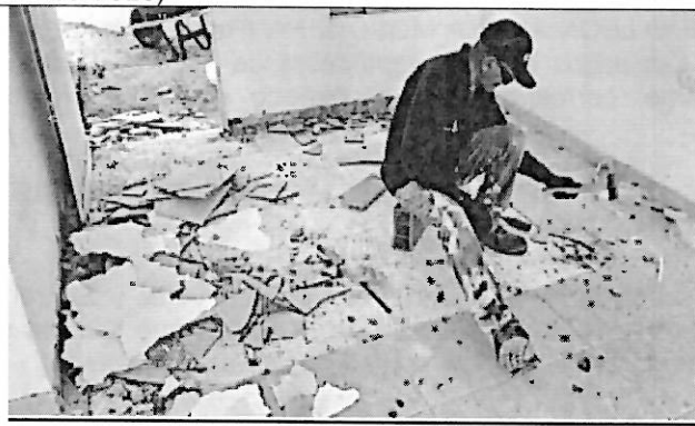
Fotografía 5. Demolición de piso existente ( Reporte 24-09-2025)
