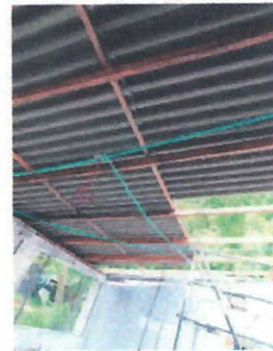
Instalación de cubierta en lámina ondulada fibrocemento
