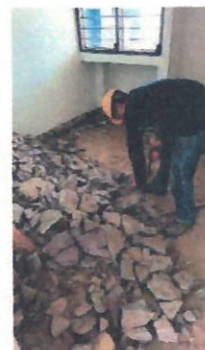
Demolición de plantilla
