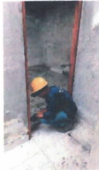
Desmonte puertas, sanitarios
