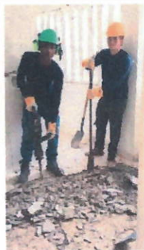
Demolición de enchape
