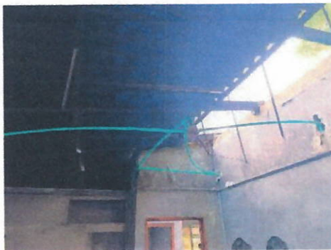
Instalación de acometida eléctrico
