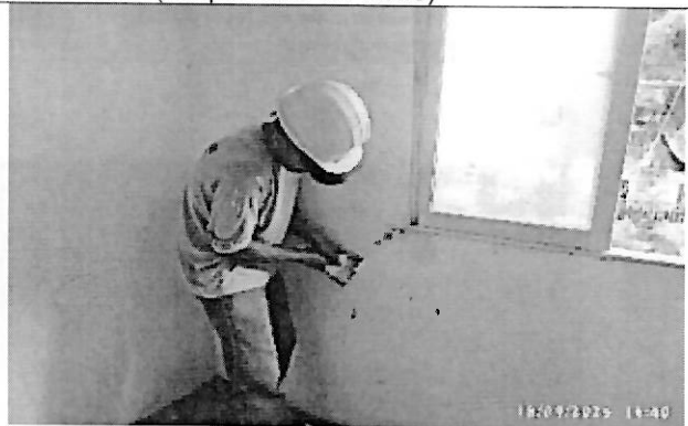
Fotografía 8. Escarificación de pintura ( Reporte 24-09-2025)
