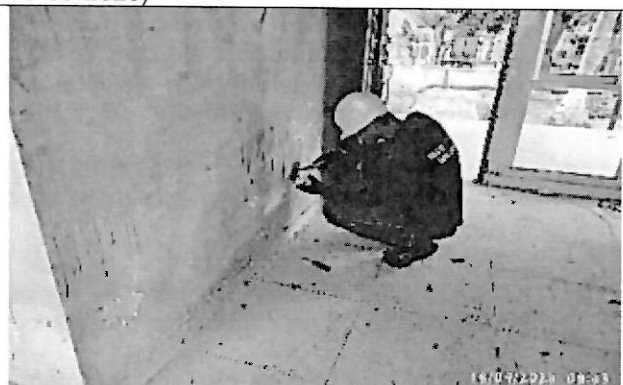
Fotografía 6. Desmonte de cable eléctrico y accesorios ( Reporte 24-09-2025)
