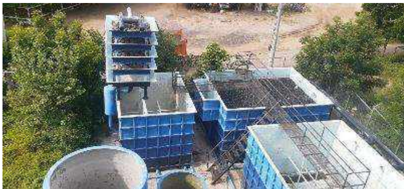
Planta de tratamiento sin funcionamiento
