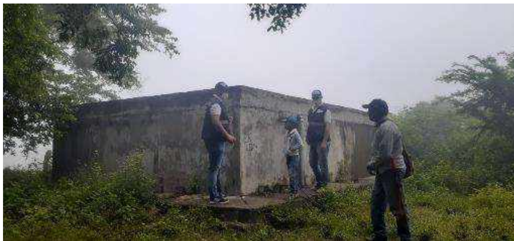
Tanque de almacenamiento comunitario Lagunita
