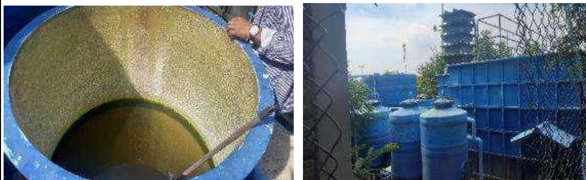
Planta de tratamiento sin funcionamiento
