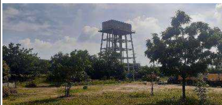
Planta de tratamiento sin funcionamiento
