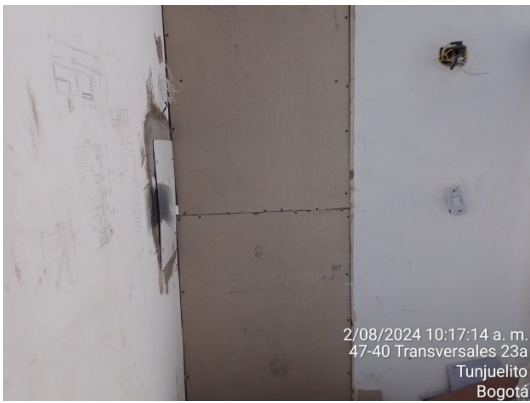
Zona Sur Apto 413 – Instalación de tapa en superboard para ducto
