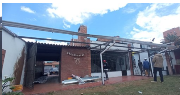
Zona Norte Casa Tunjitas -Cambio de cubierta
