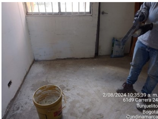
Zona Sur Apto 114 – Aplicación de estuco a muros
