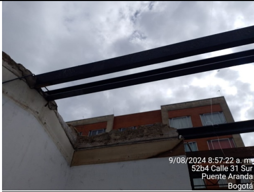
Zona Sur Casa el tejlar (52b-20) – Desmonte de teja existente
