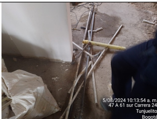
Zona Sur Apto 114 – Retiro de red hidráulica
