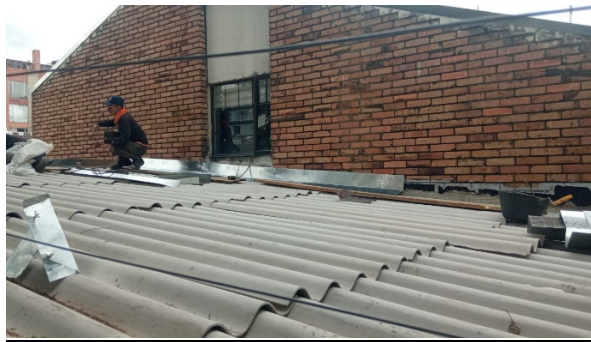
Zona Norte- Cambio de cubierta e instalación de flanches
