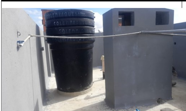
Zona norte Edificio Roda- Impermeabilización de cubierta
