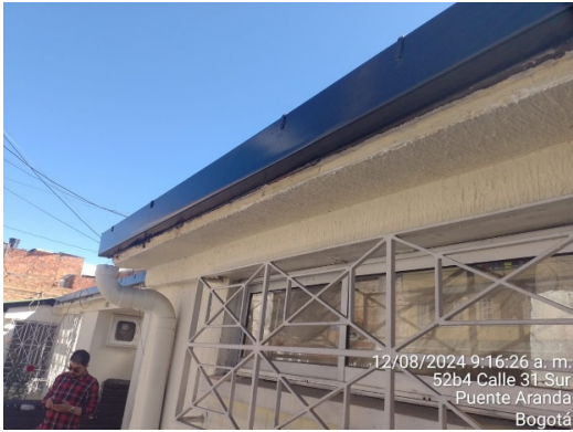
Zona Sur Casa el tejlar (52b-20) – Instalación de canal SEMANA No. 8– DEL 14 AL 21 DE AGOSTO DE 2024
