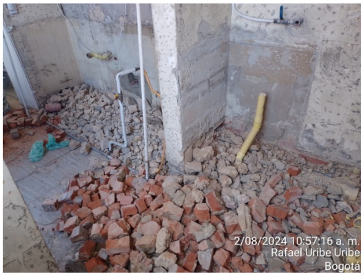
Zona Sur Apto 412 – Demolición de pollos existente en cocina
