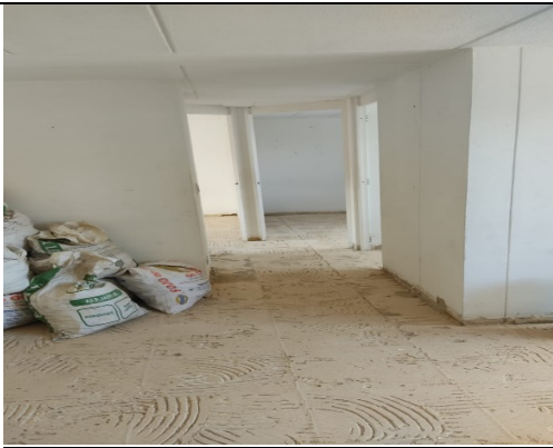
Zona Sur Apto 412 – Demolición de enchape de pisos
