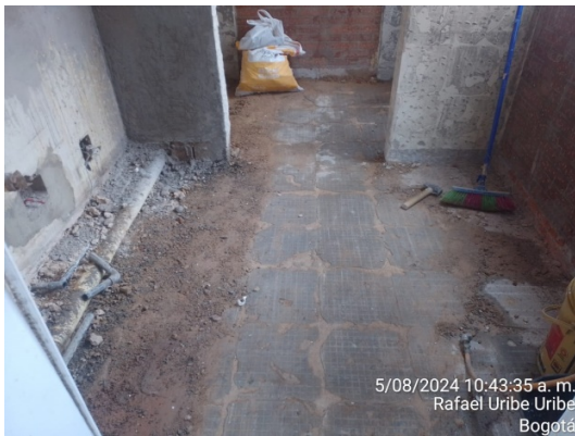
Zona Sur Apto 412 – Demolición de enchape en pisos
