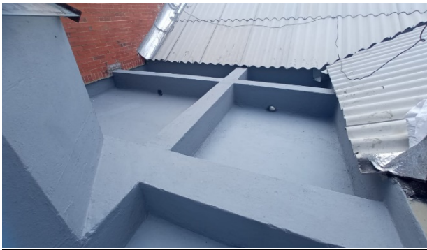
Zona Norte – Impermeabilización de cubierta
