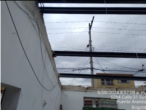
Zona Sur Casa el tejlar (52b-20) – Montaje de estructura en perfil tipo C
