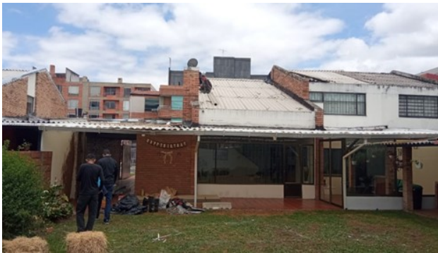
Zona Norte – Cambio de cubierta Casas Tunjitas
