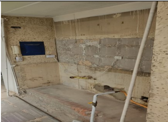
Zona Sur Apto 412- Demolición de enchape en pisos y muro de cocina
