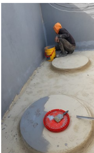
Zona norte Edificio Roda- Impermeabilización de cubierta
