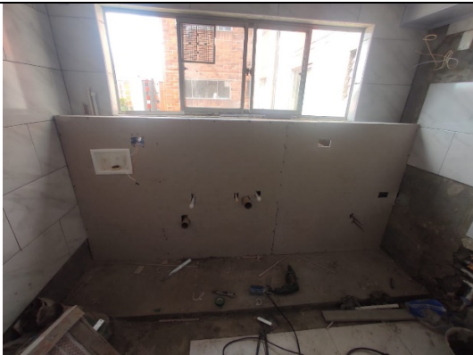
Zona Sur Apto 413 – Instalación de muro en Superboard para zona de cocina
