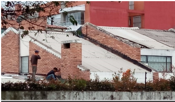
Zona Norte – Cambio de cubierta Casas Tunjitas
