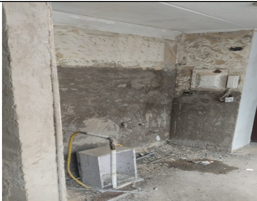
Zona Sur Apto 114 – Resane de muros
