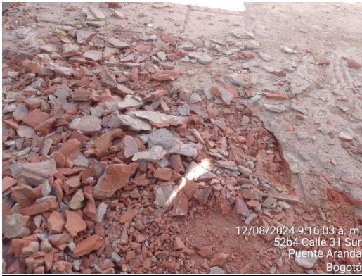
Zona Sur Casa el tejlar (52b-20) – Picado de piso
