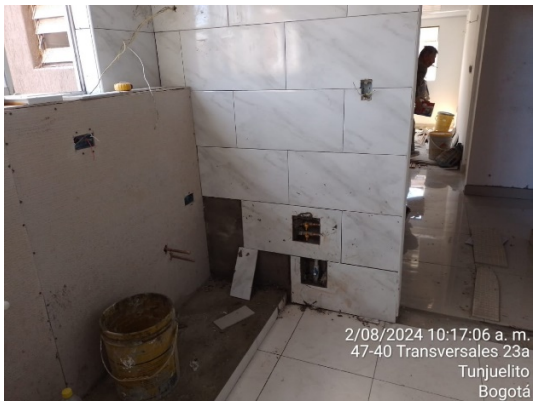
Zona Sur Apto 413 – Instalación de enchape en zona de cocina
