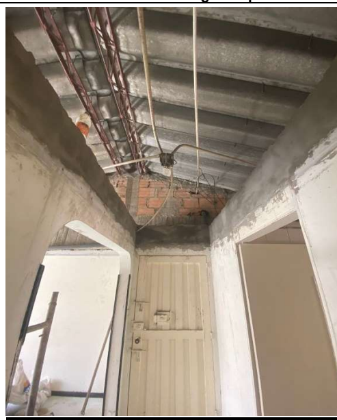
Zona Centro Edificio Vigía– Pañete de hilada de bloques de mampostería
