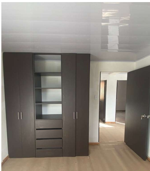
Zona Centro Casa Acapulco 71-35 (Instalación de closet)
