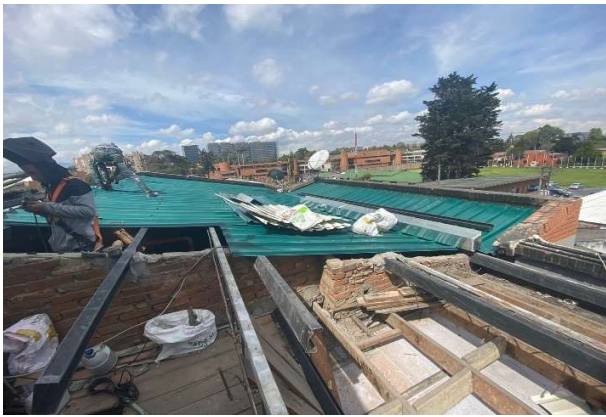
Zona Centro Cámara de Suboficiales – Instalación de caballete y cubierta
