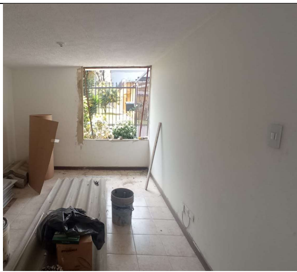
Zona Centro Casa Acapulco 71-21 – Resane vanos ventanas
