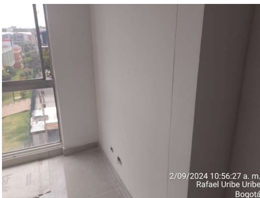
Zona Sur Apto 412 – Estuco a paredes de área social
