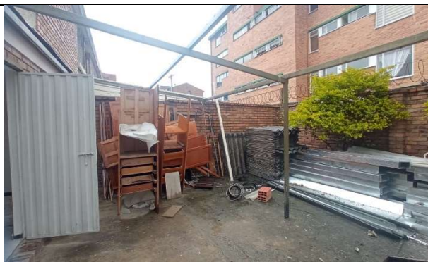
Zona Centro Casa Acapulco 71-17 (Desmonte de teja traslucida de la zona de cubierta del patio)
