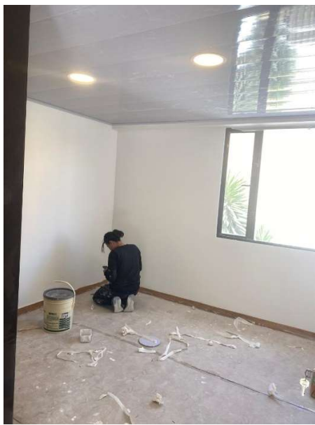
Zona Centro Casa Acapulco 71-35 – Instalación luminaria led
