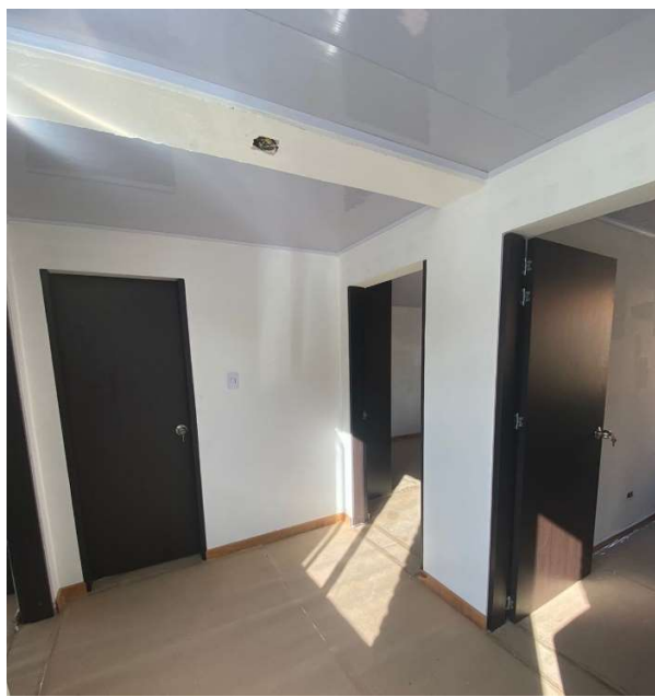
Zona Centro Casa Acapulco 71-35 (Instalación de puertas de habitaciones)
