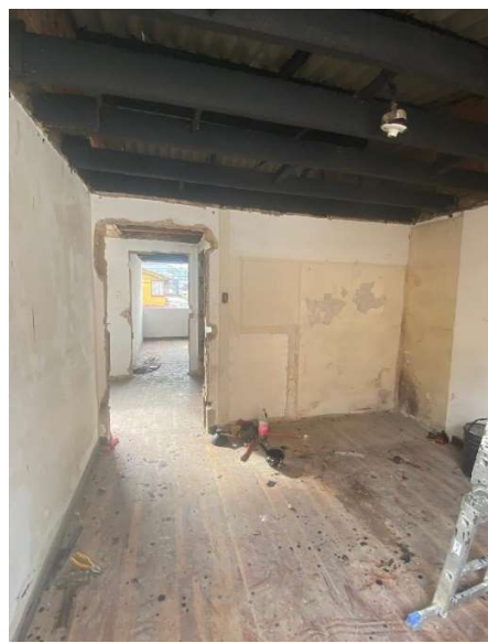
Zona Centro Casas Acapulco (71- 07) Desmonte de closet en habitaciones y muros en closet
