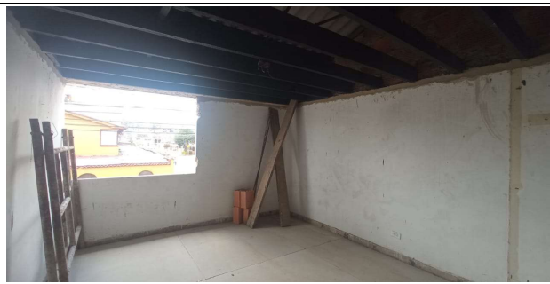
Zona Centro Casa Acapulco 71-07– Resane con mortero en puertas y ventanas
