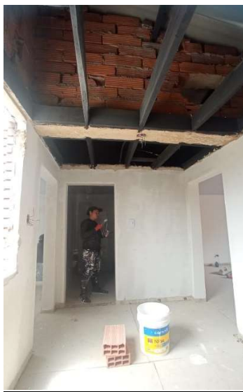
Zona Centro Casa Acapulco 71-17 – Instalación de cielo raso
