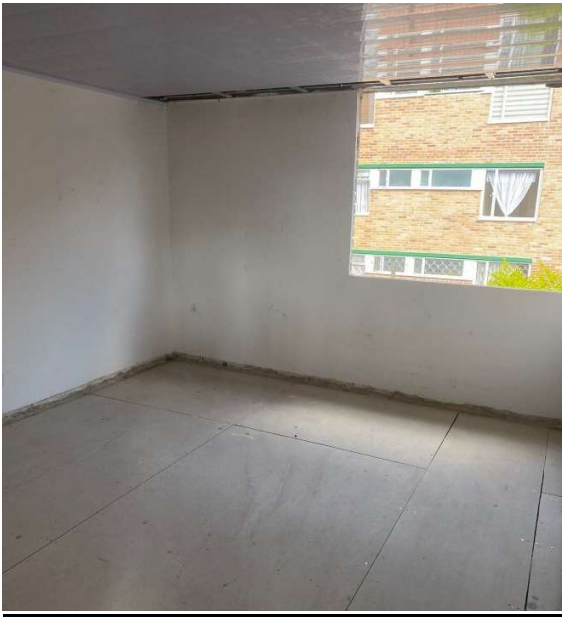
Zona Centro Casa Acapulco 71-17 (Instalación de piso en Superboard)
