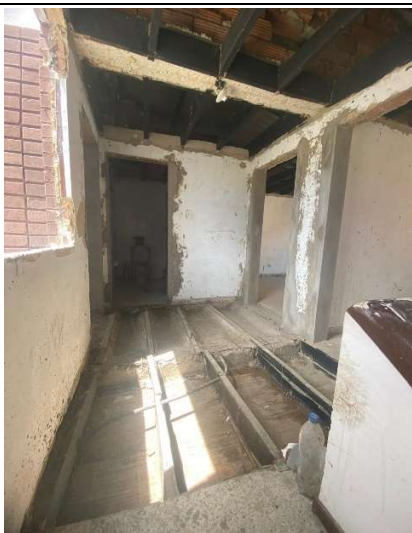
Zona Centro Casa Acapulco 71-07– Resane con mortero en puertas y ventanas
