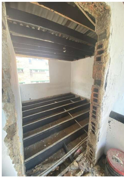
Zona Centro Casa Acapulco 71-25– Desmonte de puertas y ventanas primer y segundo piso
