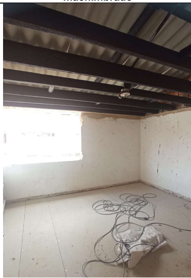
Zona Centro Casas Acapulco (71- 07) Resane de borde de ventanas
