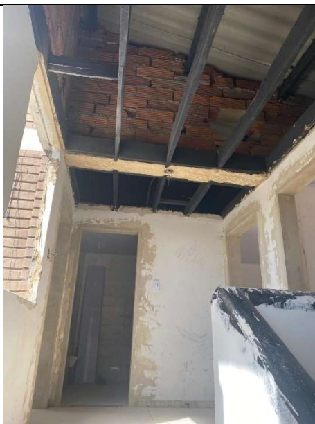
Zona Centro Casa Acapulco 71-17 – Desmonte de ventanas en primer y segundo piso
