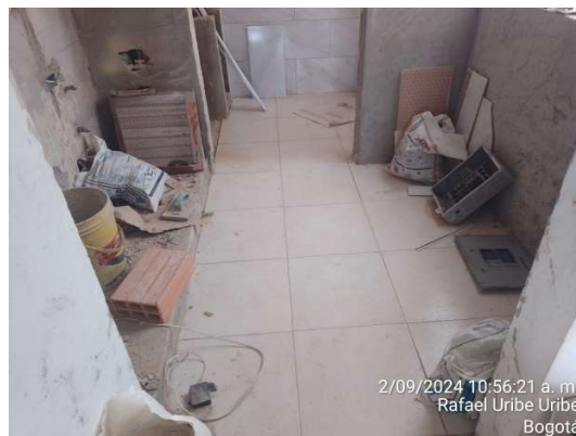
Zona Sur Apto 412- Enchape de piso
