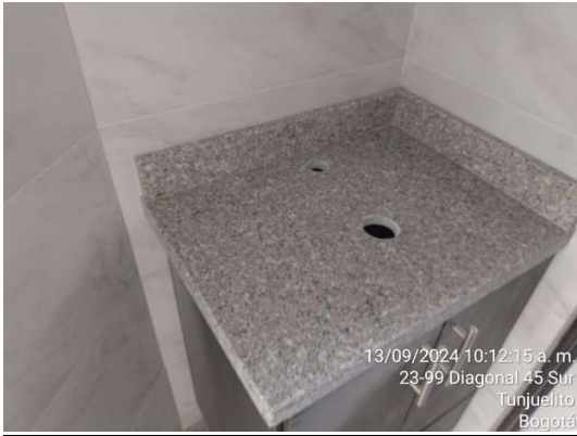
Zona Sur Apto 413 – Instalación de acabados de equipos de cocina y baño
