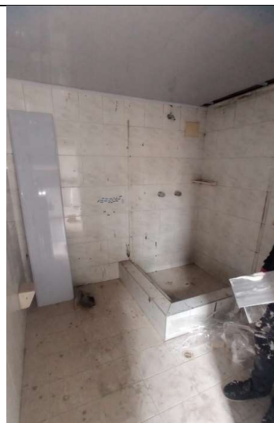
Zona Centro Casa Acapulco 71-17 Instalación de cielo raso en zona de baños
