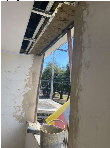
Zona Centro Casa Acapulco 71-21 – Filos con mortero
