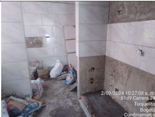
Zona Sur Apto 114 – Enchape de muros de cocina
