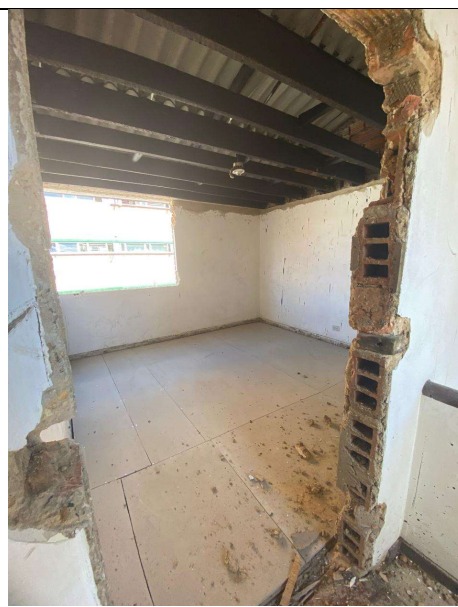
Zona Centro Casas Acapulco (71- 07) Instalación de piso en Superboard
