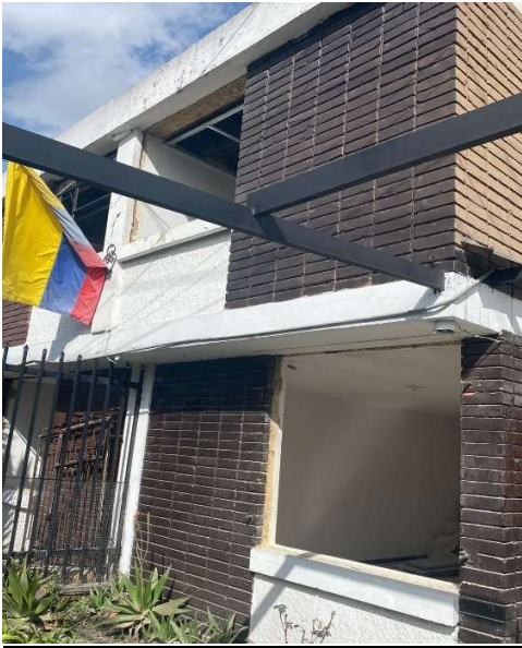
Zona Centro Casa Acapulco 71-17 (Desmonte de teja translúcida en zona de garaje)
