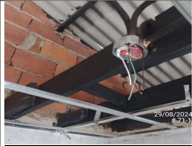
Zona Centro Casa Acapulco 71-17 (Suministro de cableado y puntos eléctricos)
