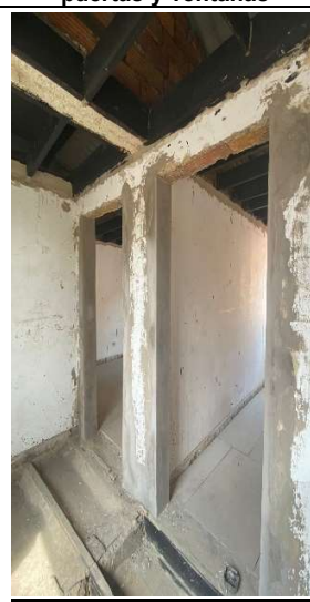
Zona Centro Casa Acapulco 71-07 Inmunización perfiles de madera cubierta segundo piso
