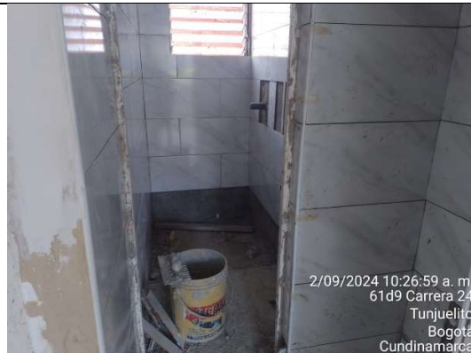
Zona Sur Apto 114 – Enchape de muros de baño
