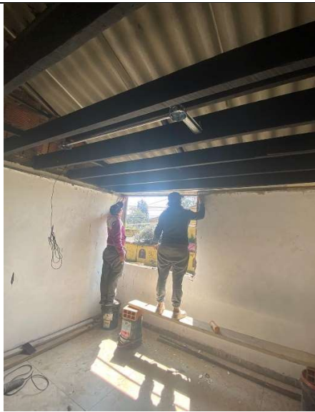
Zona Centro Casa Acapulco 71-07– Montaje de estructura para cielo raso
