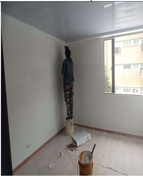
Zona Centro Casa Acapulco 71-35 (Resanes y estuco de muros en el piso 2)
