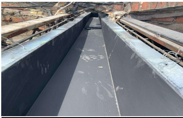
Zona Centro Cámara de Suboficiales – Instalación de estructura metálica
