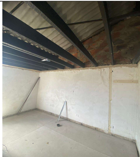
Zona Centro Casa Acapulco 71-07– Instalación de cableado y puntos eléctricos
