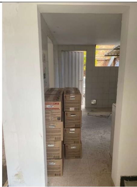
Zona Centro Casa Acapulco 71-17 Llegada de material para enchape
