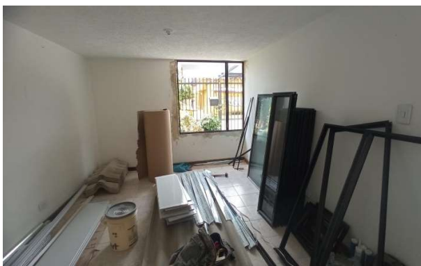
Zona Centro Casa Acapulco 71-21– Instalación de perfilera metálica
