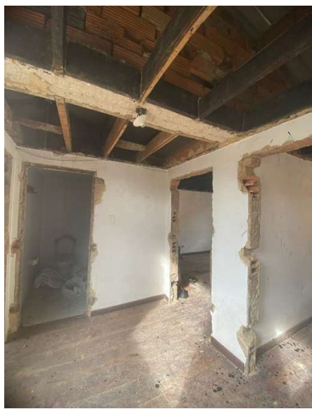
Zona Centro Casas Acapulco (71- 07) Desmonte de puertas segundo piso
