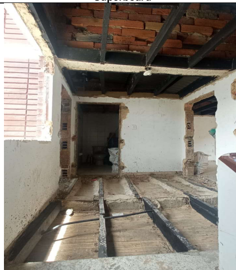
Zona Centro Casas Acapulco (71- 07) Desmonte de piso machimbrado en zona de pasillo
