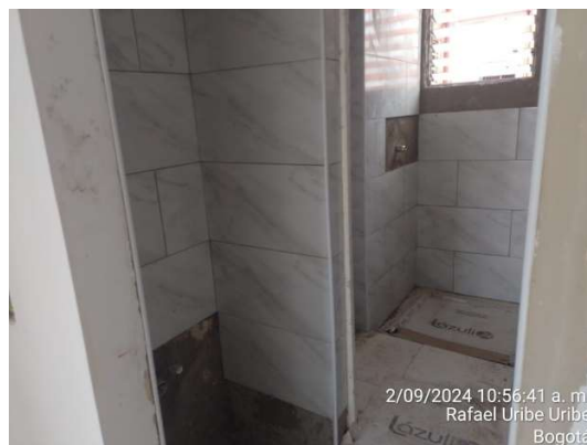
Zona Sur Apto 412- Enchape a muros de baño
