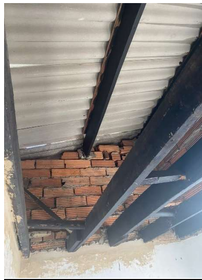
Zona Centro Casa Acapulco 71-07 Inmunización perfiles de madera cubierta segundo piso
