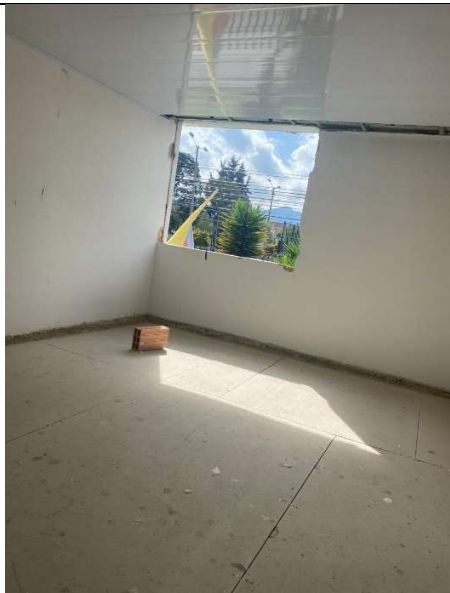
Zona Centro Casa Acapulco 71-21 – Desmonte de ventanas en primer y segundo piso
