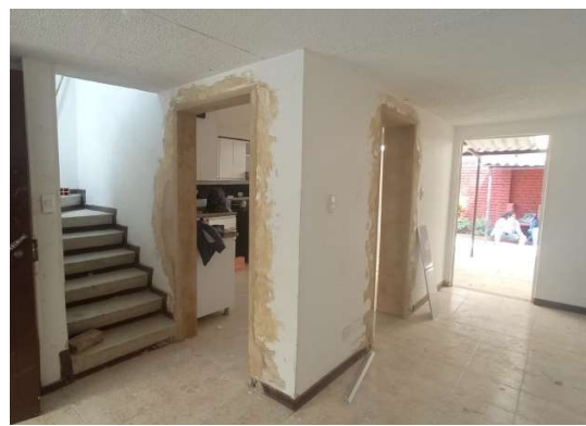
Zona Centro Casa Acapulco 71-21 (Resane a boca de 1er y 2do piso)
