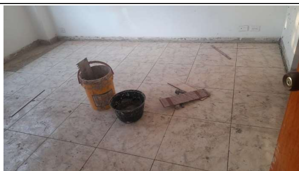
Zona Norte – Instalación enchape apartamento 102 (Edificio Roda)
