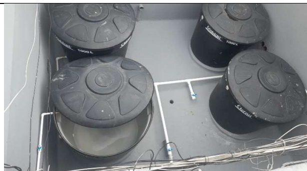
Zona Norte – Instalación tanques y accesorios (Edificio Quilla)
