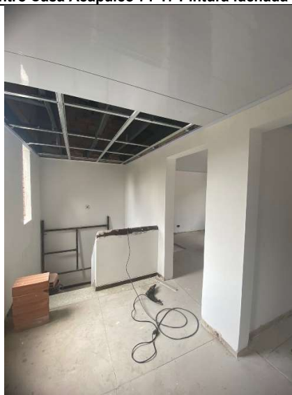
Zona Centro Casa Acapulco 71-21 Instalación de cielo raso
