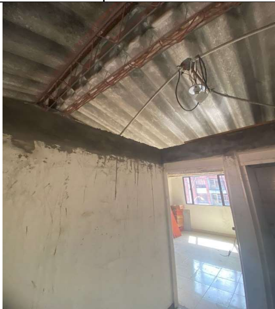
Zona Centro Edificio Vigía– Pañete de hilada de bloques de mampostería
