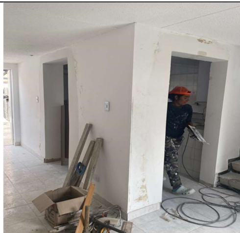
Zona Centro Casa Acapulco 71-35 Detalle de fillos de puertas interiores primer y segundo piso
