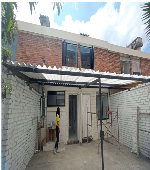
Zona Centro Casa Acapulco 71-35 – Instalación de cubierta en zona de patio
