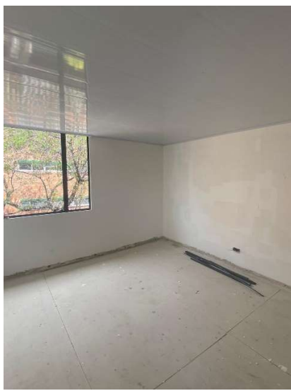
Zona Centro Casa Acapulco 71-21– Estuco a habitaciones
