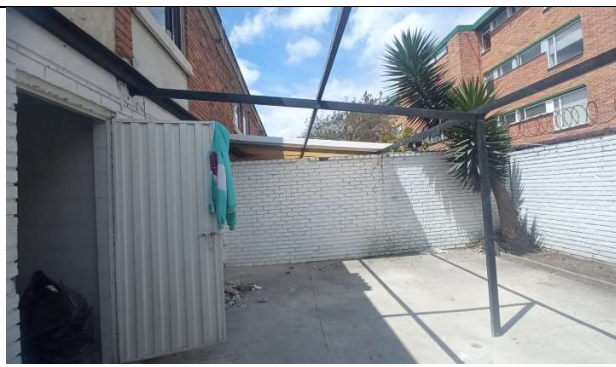
Zona Centro Casa Acapulco 71-35 – Instalación de teja translúcida en zona de patio
