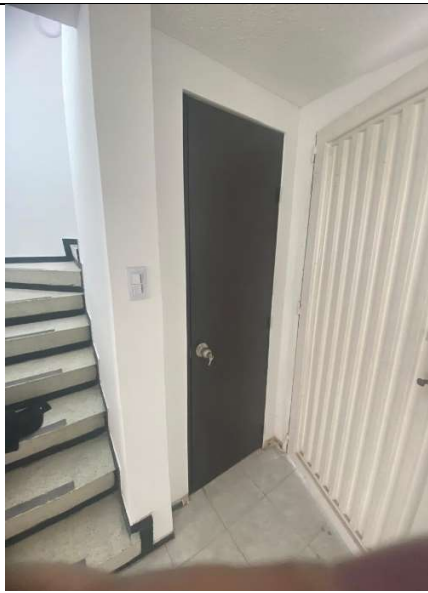
Zona Centro Casa Acapulco 71-35 – Instalación de puerta en baño social
