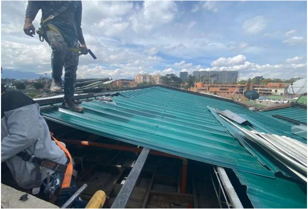
Zona Centro Cámara de Suboficiales – Instalación de caballete y cubierta
