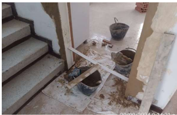
Zona Centro Casa Acapulco 71-21 (Resane a boca de 1er y 2do piso)
