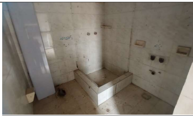
Zona Centro Casa Acapulco 71-17 (Desmonte de división de baño)
