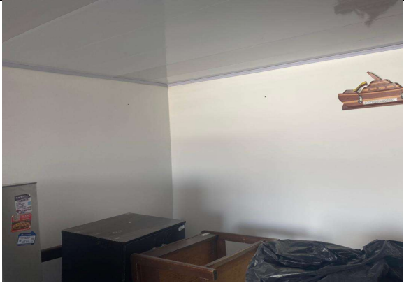
Zona Centro Cámara de Suboficiales – Pintura vinilo tipo 1 en paredes y filos
