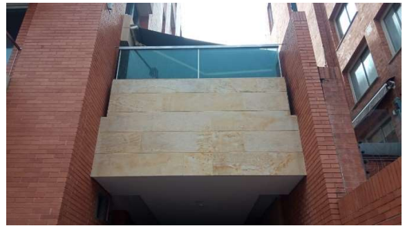
Zona Norte – Edificio Insignia (Limpieza de fachadas y canales)
