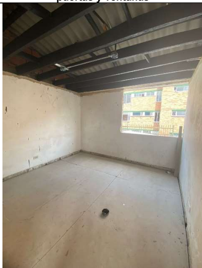
Zona Centro Casa Acapulco 71-07– Instalación de piso en Superboard
