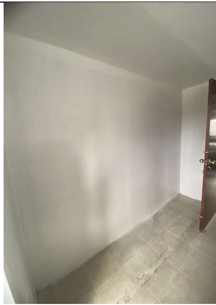
Zona Centro Cámara de Suboficiales – Desmonte de closet y resanes con estuco camarote 303
