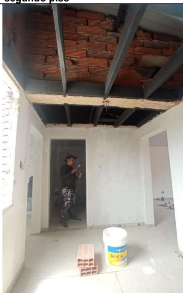
Zona Centro Casa Acapulco 71-17 – Estuco de paredes de segundo piso
