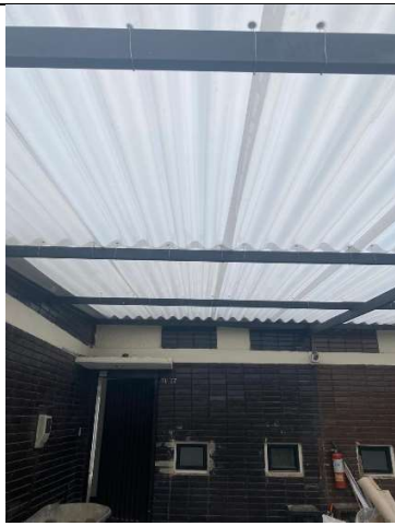
Zona Centro Casa Acapulco 71-17 (Instalación de teja en zona de garaje)
