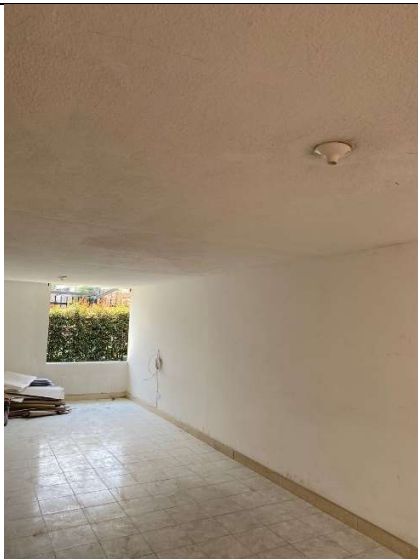
Zona Centro Casas Acapulco (71- 07) Aplicación de estuco en paredes
