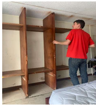
Cámara de suboficiales – Desmonte de closet camarote 301
