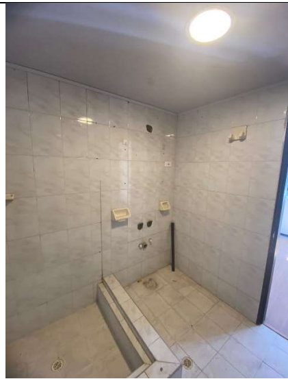
Zona Centro Casa Acapulco 71-17 Terminación de actividades en baño
