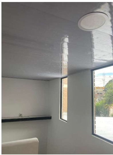
Zona Centro Casa Acapulco 71-17 – Instalación de luminaria y cielo raso
