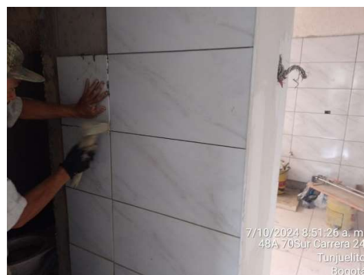
Zona Sur Apto 338 – Enchape a piso y paredes
