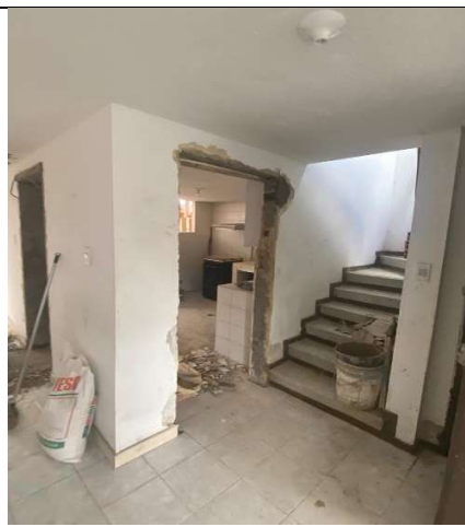
Zona Centro Casa Acapulco 71-07 (Instalación de estructura de cielo raso)
