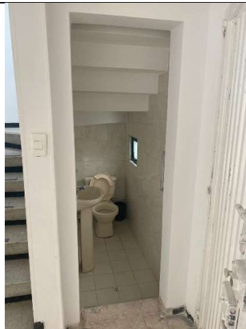
Zona Centro Casa Acapulco 71-17 (Realización de detalles en marcos de puertas)
