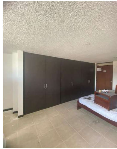
Zona Centro Cámara de Suboficiales – Instalación de closet en camarote 301
