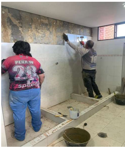
Zona Centro Cámara de Suboficiales – Continúan actividades en baños comunales en el lado oeste del tercer piso.
