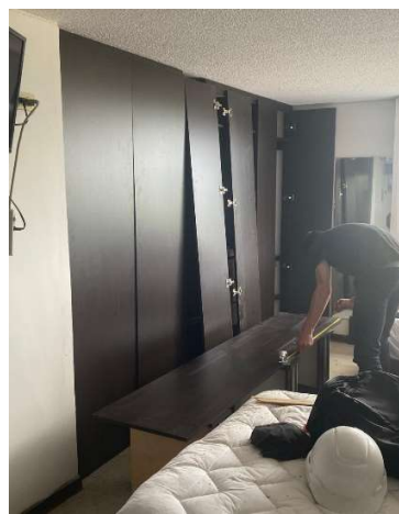
Cámara de suboficiales – Instalación de puertas de clóset en los camarotes
