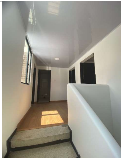
Zona Centro Casa Acapulco 71-17 – Instalación de luminarias y cielo raso
