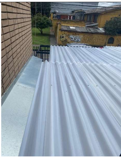
Zona Centro Casa Acapulco 71-21 (Instalación de teja traslúcida en zona de garaje)
