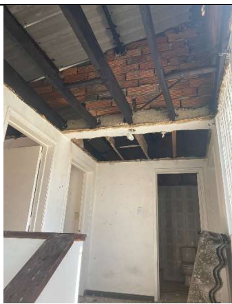
Zona Centro Casa Acapulco 71-29 – Inmunización de la estructura de madera del techo y cielo raso
