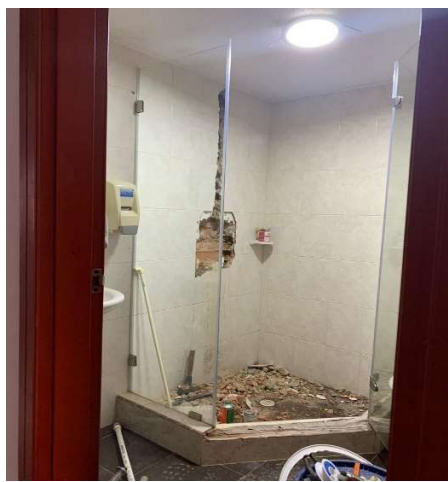
Cámara de suboficiales – Demolición de baños privados tercer piso
