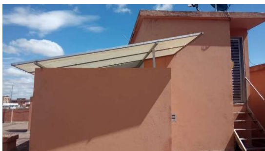
Estado de las tejas en policarbonato alveolar a cambiar
