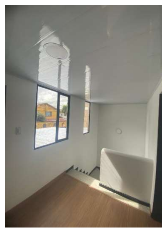
Zona Centro Casa Acapulco 71-21 (Instalación de luminarias)
