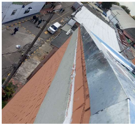
Cámara de suboficiales – Subsanación de flanches en cubierta
