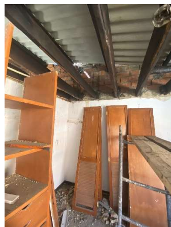
Zona Centro Casa Acapulco 71-29 Desinstalación de teja eternit
