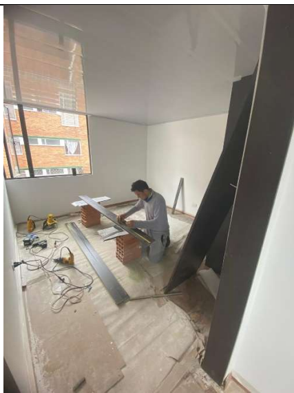
Zona Centro Casa Acapulco 71-11 (Instalación de closet en habitaciones del segundo piso)
