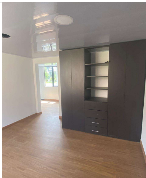
Zona Centro Casa Acapulco 71-17 (Instalación de piso en vinilo y zócalos)
