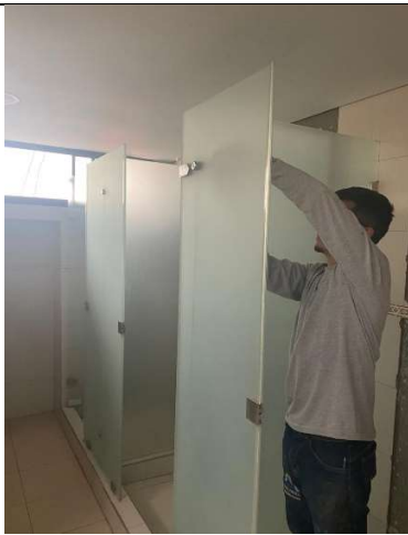
Cámara de suboficiales – Desinstalación divisiones de los baños
