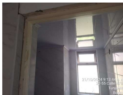
Zona Sur Caldas Apto 112 – Instalación de PVC en área de baño
