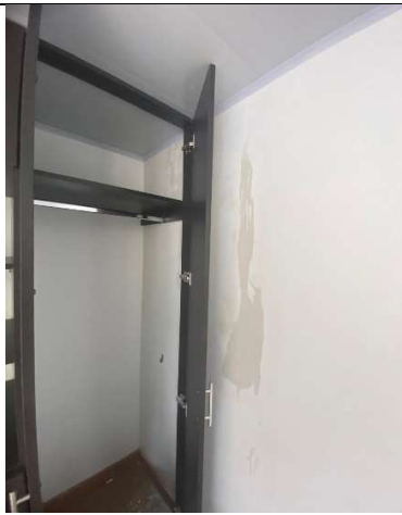
Zona Centro Casa Acapulco 71-21 (Instalación de closet)
