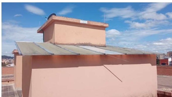
Estado de las tejas en policarbonato alveolar a cambiar
