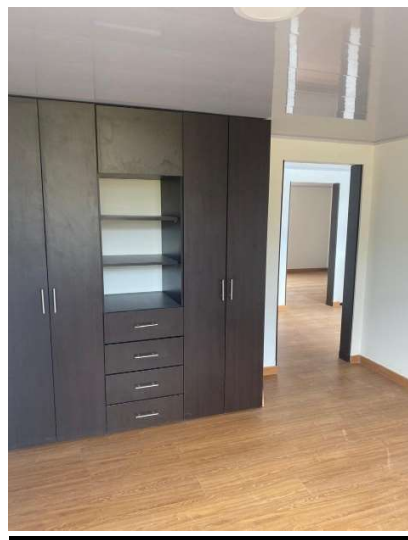
Zona Centro Casa Acapulco 71-17 Instalación de closet en las 3 habitaciones
