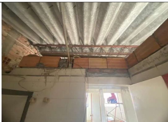
Zona Centro Edificio Vigía – Instalación de caballete y cubierta
