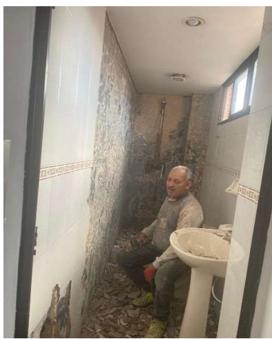
Cámara de suboficiales – Instalación de cerámica en baño social del tercer piso
