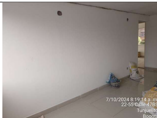
Zona Sur Caldas Apto 112 – Estuco a muros sobre frisado
