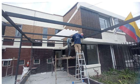
Zona Centro Casa Acapulco 71-17 (Instalación de Tejas traslucidas en zona de garaje)
