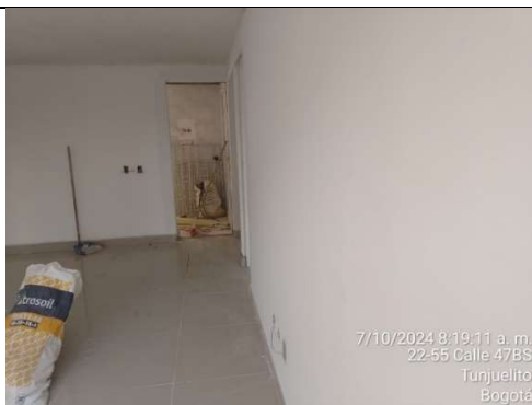
Zona Sur Caldas Apto 112 – Estuco a muros sobre frisado
