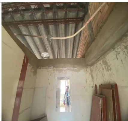
Zona Centro Edificio Vigía – Instalación de bloques en ladrillo para nivelar muros
