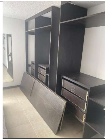
Cámara de suboficiales –Instalación de puertas y closet en camarote 305
