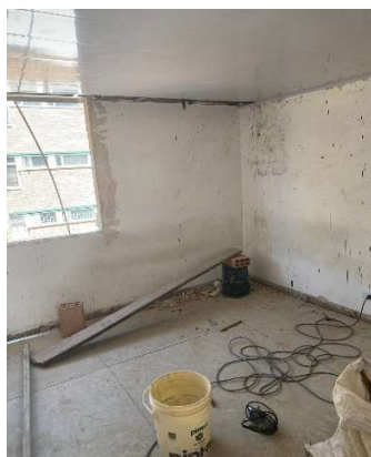
Zona Centro Casa Acapulco 71-25 – Continúan con detalles en filos de puertas y ventanas
