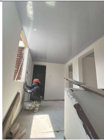
Zona Centro Casas Acapulco (71- 07) Alistado de marcos de puertas y ventanas
