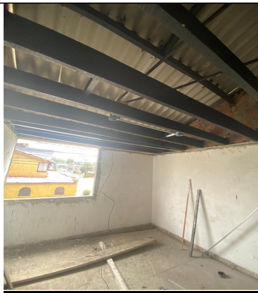
Zona Centro Casa Acapulco 71-07 (Instalación de estructura de cielo raso)
