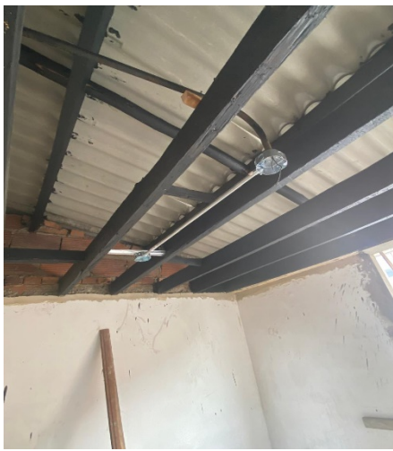
Zona Centro Casa Acapulco 71-07 (Instalación de puntos eléctricos en habitaciones)
