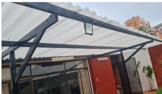
Estructura existente en la zona del patio
