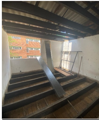
Zona Centro Casa Acapulco 71-25 (Se remota instalación de cubierta y flanches)
