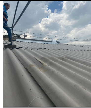
Zona Centro Casa Acapulco 71-25 (Instalación de flanches)
