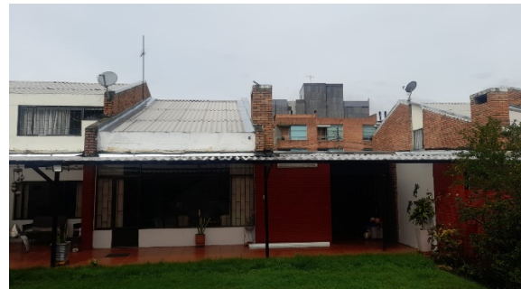
Instalación de tejado en policarbonato para la zona del patio
