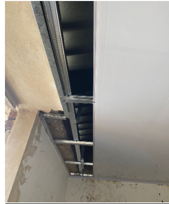
Zona Centro Casa Acapulco 71-25 Instalación de cielo raso en PVC
