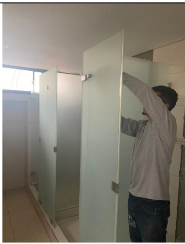
Cámara de suboficiales – Desinstalación divisiones de los baños
