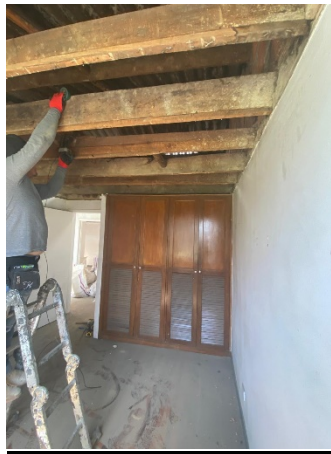
Zona Centro Casa Acapulco 71-29 – Se inician actividades de desinstalación de cielo raso
