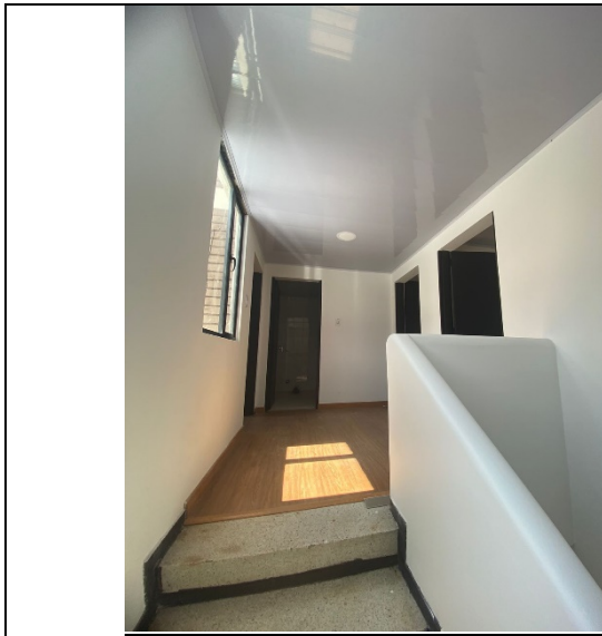
Zona Centro Casa Acapulco 71-17 – Instalación de luminarias y cielo raso
