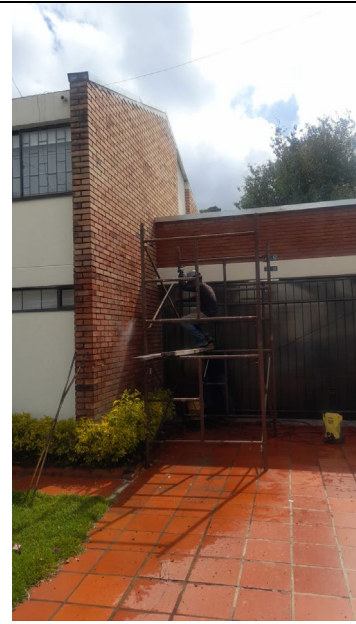
Zona Norte – Lavado e impermeabilización de fachadas (Casas Tunjitas)
