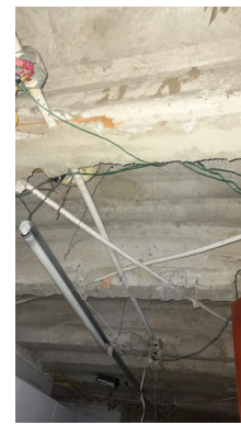
Zona Norte – Apartamento 102 (Desinstalación cielo raso existente zona de cocina)
