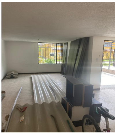
Zona Centro Casa Acapulco 71-21 (Se evidencia material para instalación de marcos y closet de madera)
