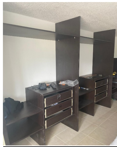
Cámara de suboficiales – Instalación de closet faltando actividades de pintura en camarote 301
