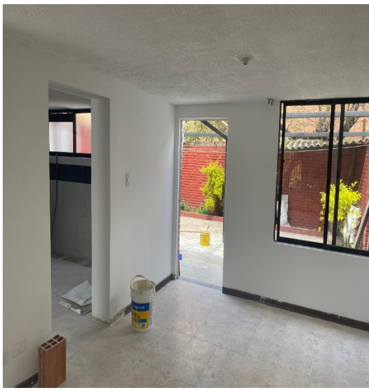
Zona Centro Casa Acapulco 71-21 (Finalización de pintura en primer piso y detalles de zócalos)
