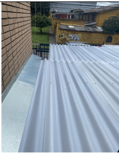
Zona Centro Casa Acapulco 71-21 (Instalación de teja traslucida en zona de garaje)
