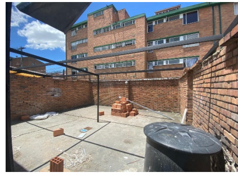
Zona Centro Casa Acapulco 71-11 Instalación de cubierta en lamina ondulada en zona de patio
