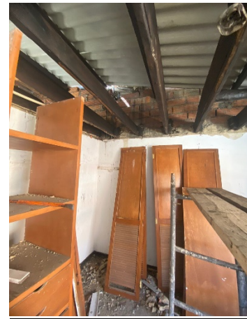
Zona Centro Casa Acapulco 71-29 Desinstalación de teja eternit
