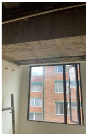
Edificio El Vigía – Aplicación de pañete a zona de aumento de altura
