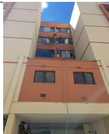
Zona Edificio Cedral 1 – Resane de muro
