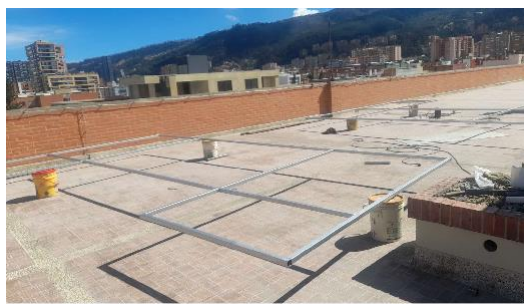
Estructura de cubierta nueva e instalada para las edificaciones con cubierta presentes en la terraza del edificio
