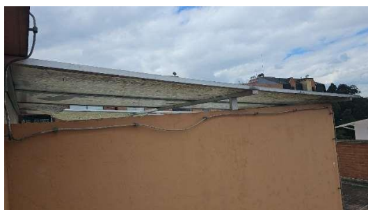
Estructura de cubierta antes de las intervenciones
