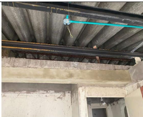
Edificio El Vigía – Aplicación de pañete a zona de aumento de altura
