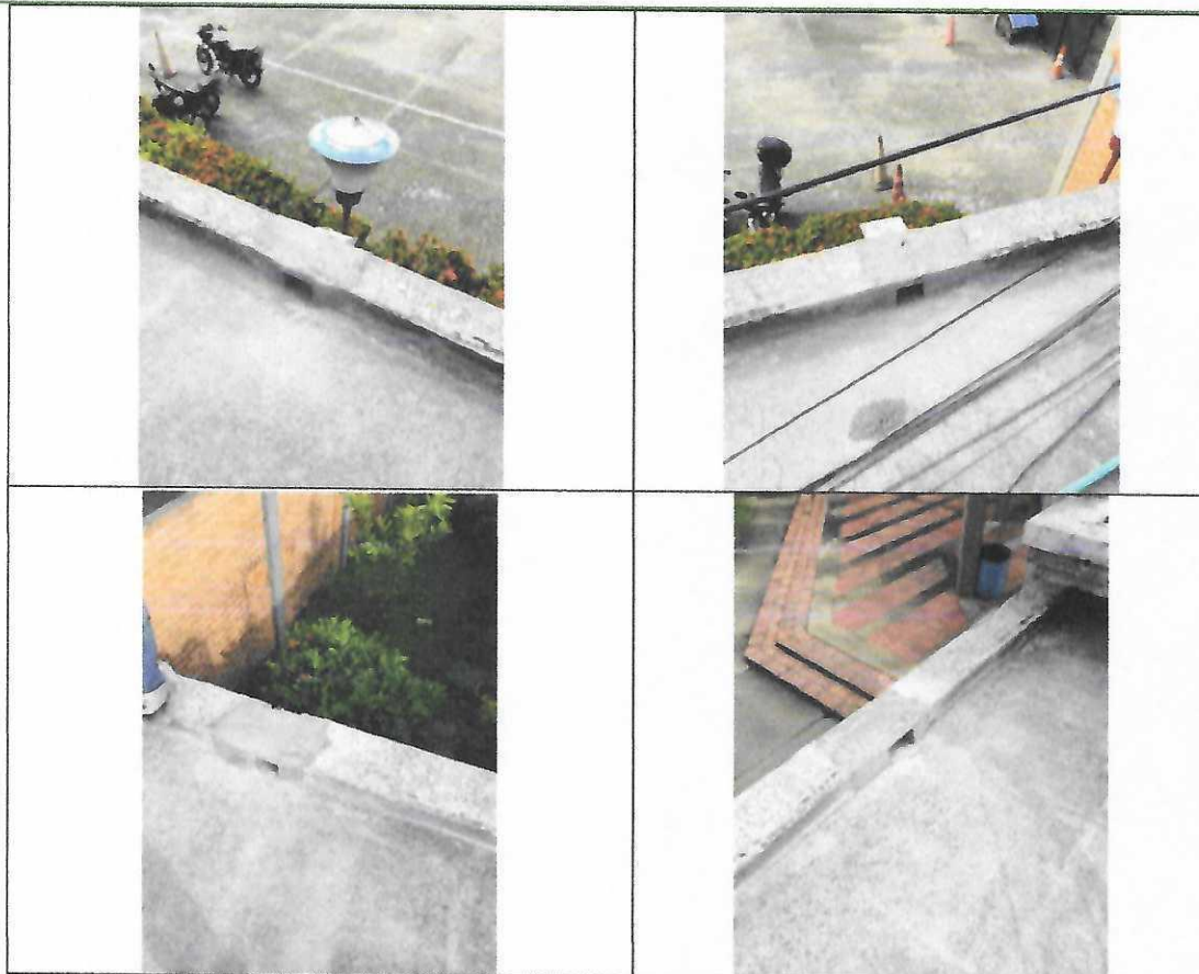
ACTIVIDADES DE MANTENIMIENTO E IMPERMEABILIZACION DE CUBIERTA AREA DE PORTERIA
