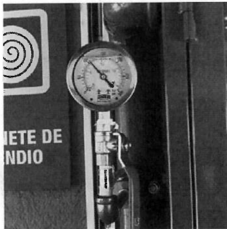
Ilustración 1 Manómetro instalado
