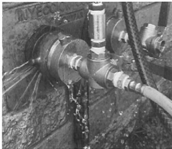
Ilustración 3 Fuga en siamesa
