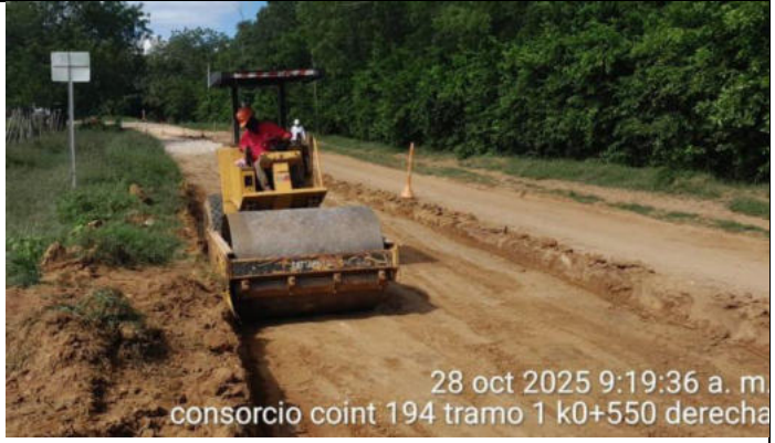
Extensión y compactación de material de mejoramiento
