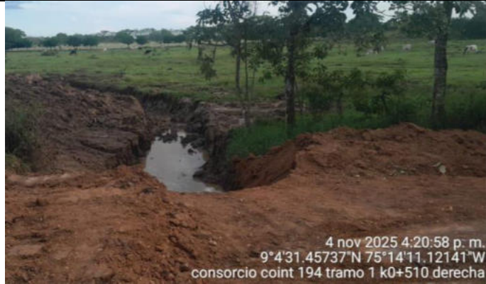
Excavación para drenaje de aguas originadas por lago aledaño a la vía.
